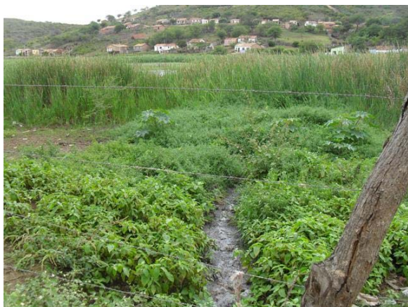
Foto 1: Área da extravasão do tanque da Estação Elevatória.
