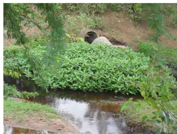
Foto 12: Tubulação com DN800 – lançamento de esgotos do hospital e parte da cidade no Rio Bananeira.
