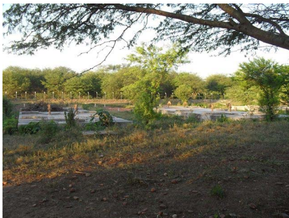
Foto 1: ETE 1 - povoado de Pedras Altas – implantada para esgotamento da Bacia A, é constituída por 6 conjuntos de tanque séptico e vala de filtração.
