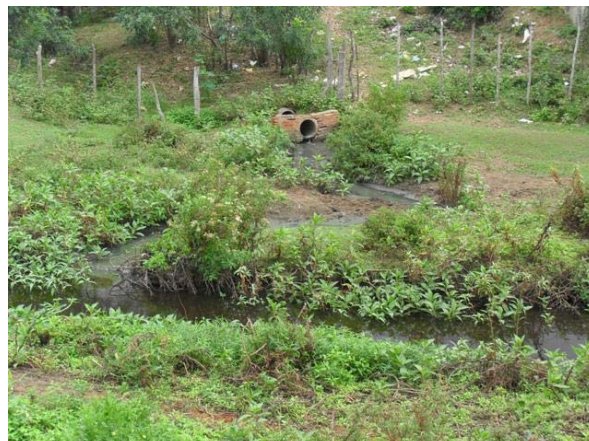
Foto 14: Tubulação com DN500 - lançamento pontual de esgotos no Rio Bananeira.
