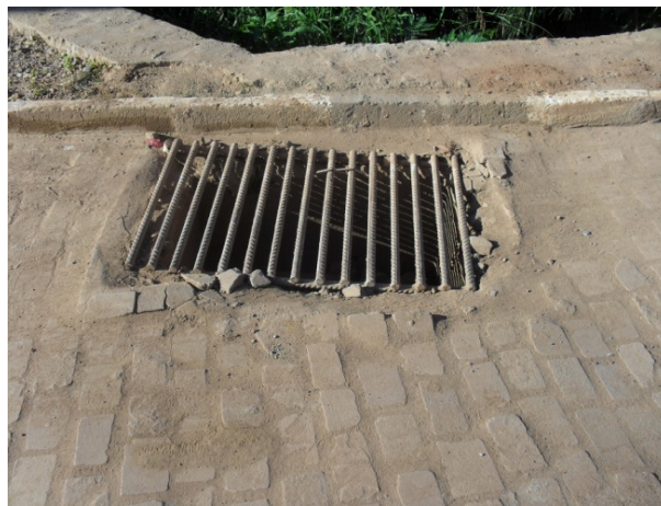
Foto 2: Ponto de lançamento de esgotos sanitários e águas pluviais no canal natural. Tubulação de concreto de DN 300mm de diâmetro.
