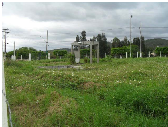
Foto 2: Estação Elevatória - obras não concluídas
