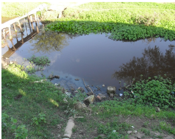
Foto 5: Ponto de lançamento de esgoto do Bairro Nazaré no Rio Itapicuru Mirim
