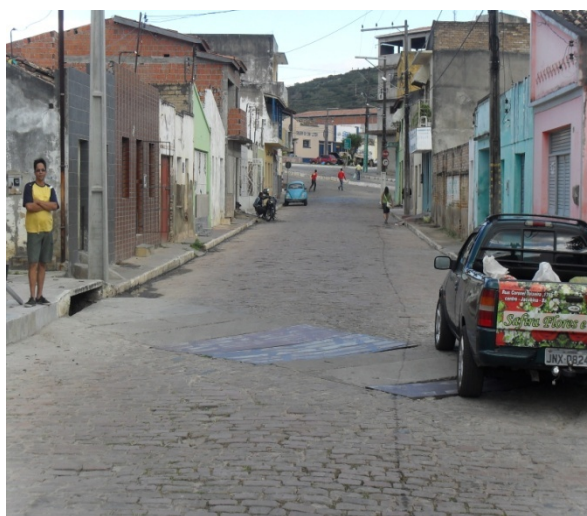
Foto 18: Canal de macrodrenagem que atravessa a Rua Duque de Caxias possui seção insuficiente para escoar as águas de chuva que escoam pela rua.
