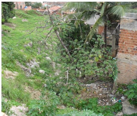
Foto 2: Área de deságüe do canal da Rua Santa Terezinha no muro da Rua Karder Ribeiro.
