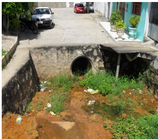
Foto 2: 1ª Travessa João Batista. Início da galeria com seção de DN1200mm que recebe contribuição de esgotos sanitários e águas pluviais da Vila Feliz.
