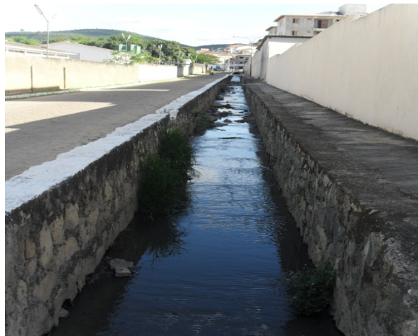
Foto 26: Trecho descoberto do canal de macrodrenagem que se inicia no Bairro Mundo Novo.
