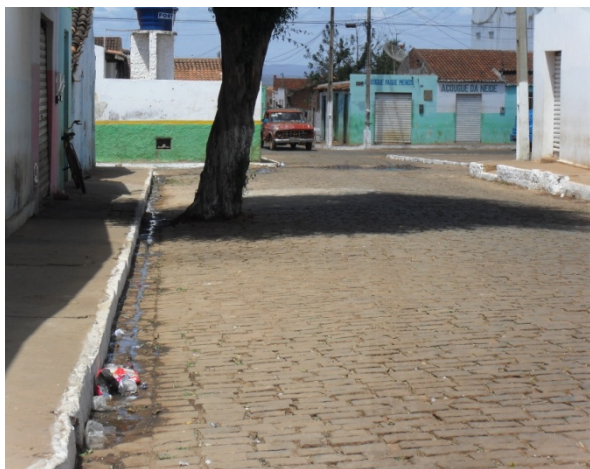
Foto 1: Esgoto secundário correndo pelas sarjetas, a céu aberto, em uma rua transversal a Avenida Severino Ribeiro Granja.
