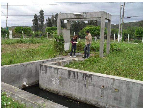
Foto 3: Estação Elevatória - obras não concluídas
