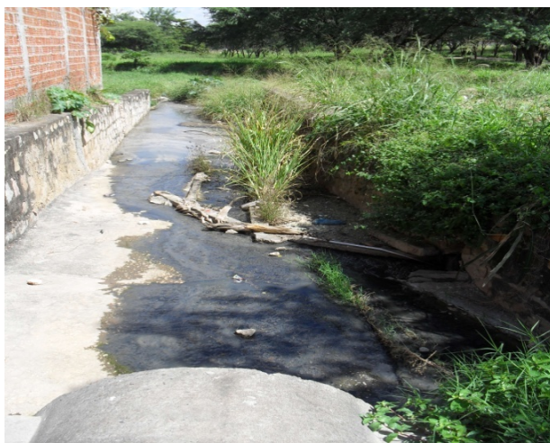
Foto 3: Lançamento de esgotos sanitários e águas pluviais da Vila Feliz e outros bairros na Praça da Juventude
