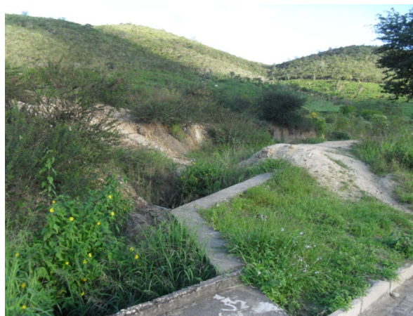
Foto 28: Início do canal de macrodrenagem no bairro Jacobina III e segue pelo Bairro Jacobina IV.
