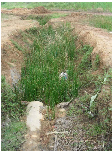
Foto 9: Drenagem com 2 tubos de DN 400mm – ponto de lançamento em córrego seco.
