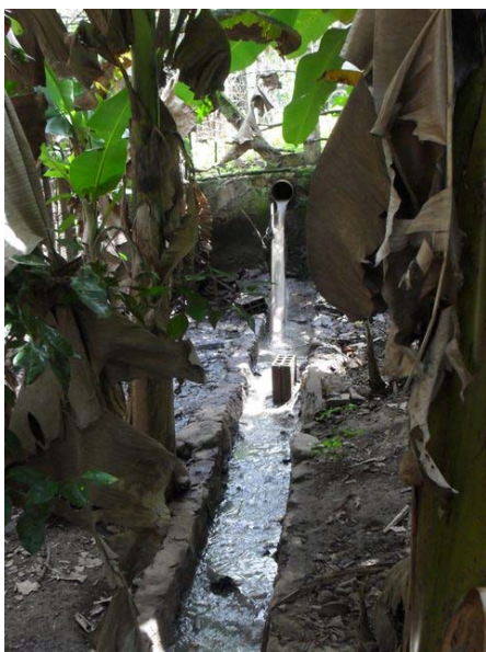
Foto 3: Ponto de lançamento de águas pluviais.
