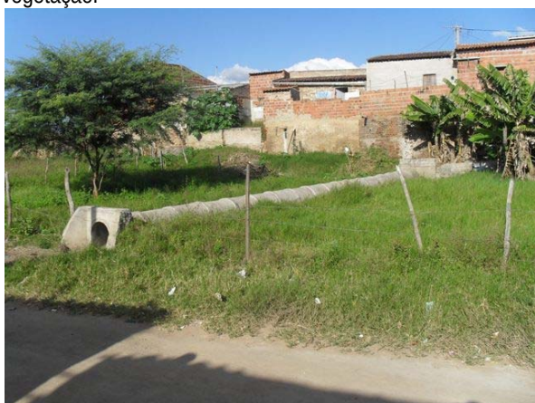
Foto 11: Tubo de concreto de DN600 – dispositivo de drenagem transportando esgotos.
