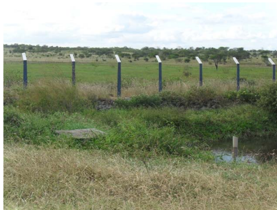
Foto 8: ETE 2 - povoado de Piabas – vala de filtração recoberta por mato e sem escoamento dos esgotos.
