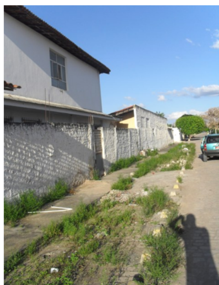
Foto 4: Fossas do hospital construídas ao longo da Rua Getúlio Vargas (transbordam com frequência).
