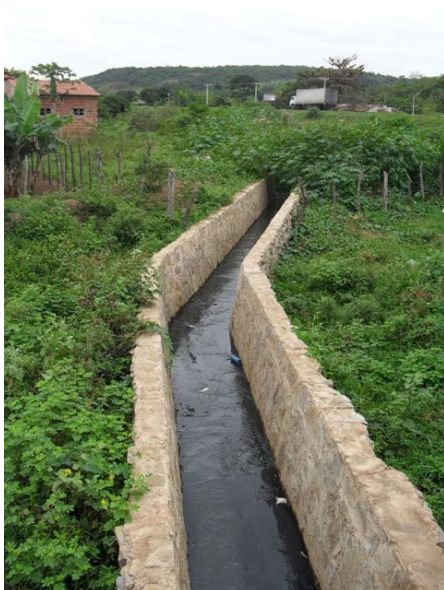
Foto 13: Vista do canal em alvenaria de pedra.
