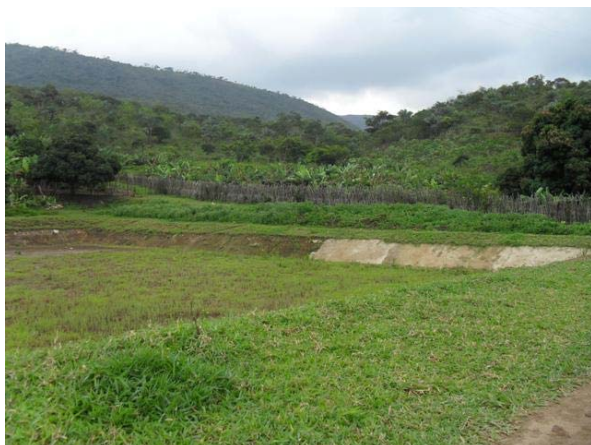
Foto 1: Lagoa de tratamento de esgoto – abandonada por falta de equipamentos para bombeamento.
