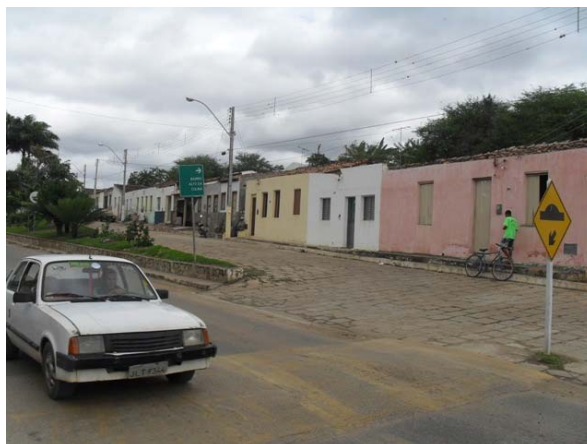
Foto 2: Área crítica 2 – Av. Luis Eduardo Magalhães
