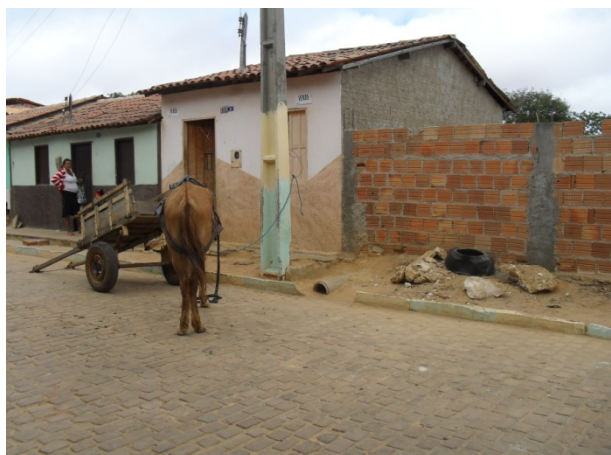
Foto 3: Ponto de deságüe das águas pluviais na Praça Fernando Daltro. Tubo de concreto de DN 300 mm de diâmetro.
