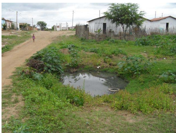
Foto 9: Ponto de lançamento de esgoto do Bairro Casas Populares.
