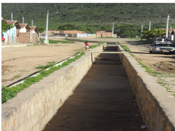
Foto 23: Canal de macrodrenagem revestido em alvenaria de pedra. Seção 1,8m X 1,2m e extensão aproximada de 250m. Bairro Novo Amanhecer.
