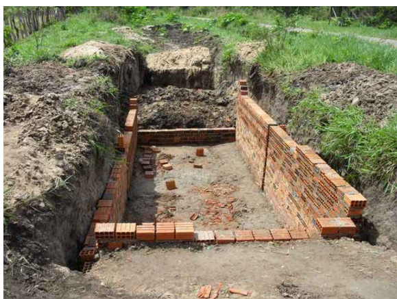
Foto 5: Fossa seca em implantação – resolverá o problema de aproximadamente 20 casas.
