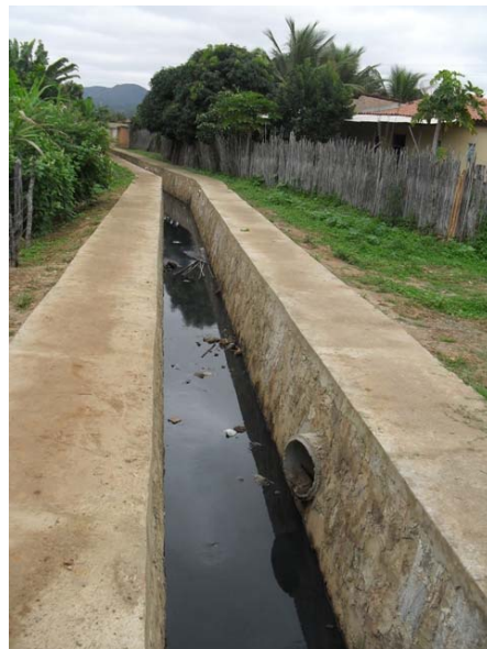
Foto 14: Vista do canal em alvenaria de pedra.
