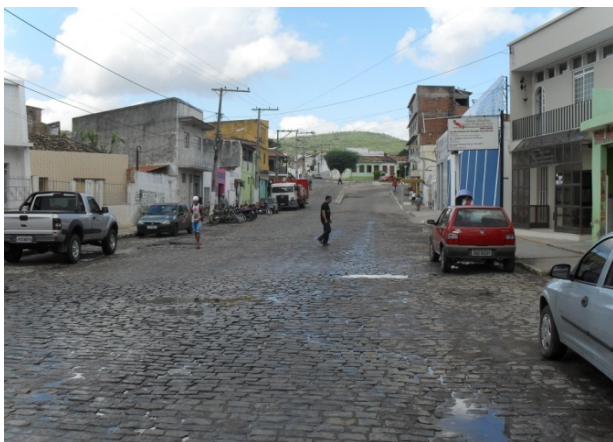
Foto 15: Área crítica 2 - Rua Francisco Rocha Pires. Área crítica por conta das chuvas de enxurrada.
