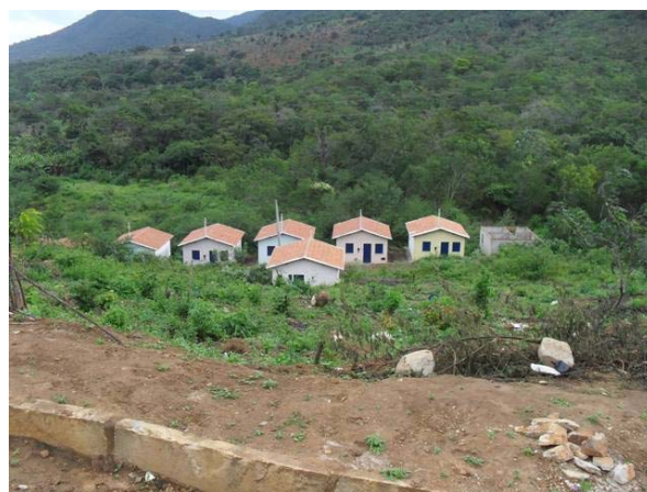
Foto 8: Casas populares ainda sem infraestrutura – ponto de baixada próximo ao Rio da Mangueira.
