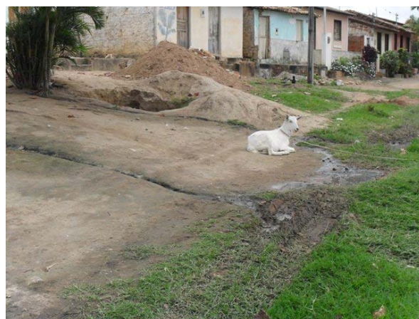
Foto 16: Esgotos correndo a céu aberto em vias não pavimentadas.
