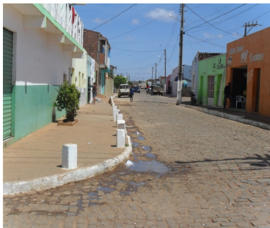
Foto 2: Esgoto secundário correndo pelas sarjetas, a céu aberto, no Bairro Centro.
