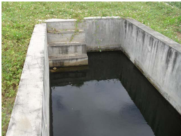
Foto 7: Estação Elevatória - obras não concluídas.
