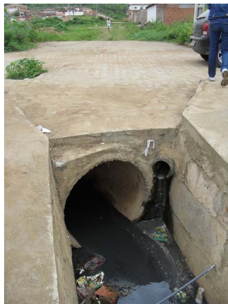
Foto 8: Início do canal de alvenaria de pedra com lançamento de esgotos dos bairros próximos.
