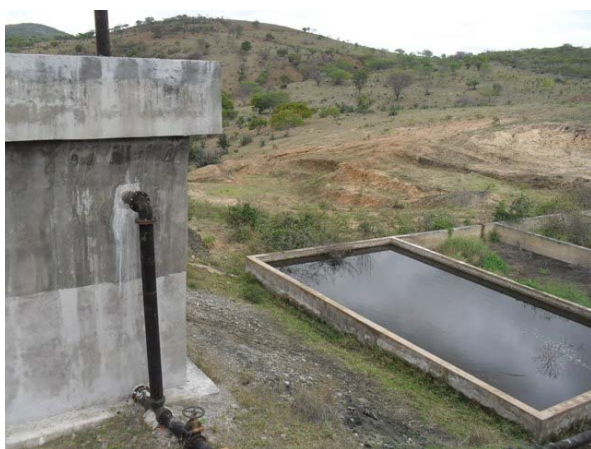
Foto 5: Vista do digestor anaeróbio de fluxo ascendente – DAFA e dos leitos de secagem - obras não concluídas
