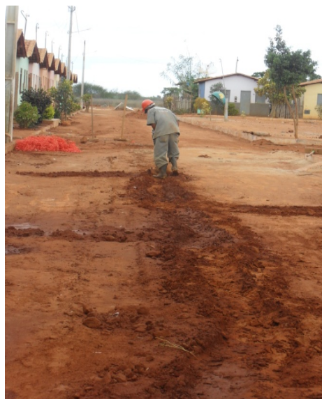
Foto 4: Obras de esgotamento sanitário em implantação pela Codevasf. Rua já com rede e ligações domiciliares executadas
