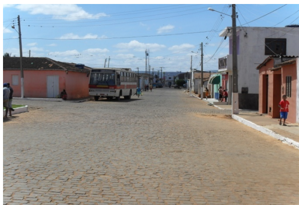
Foto 3: Ruas pavimentadas, com caimento suave, mas bem definido.
