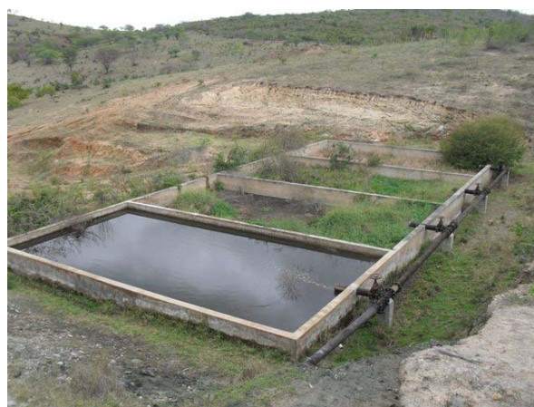
Foto 6: Vista dos leitos de secagem - obras não concluídas
