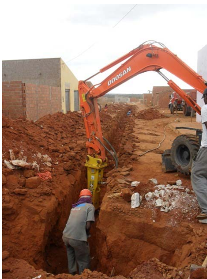
Foto 3: Obras de esgotamento sanitário em implantação pela Codevasf. Fase de abertura de valas e assentamento da tubulação.
