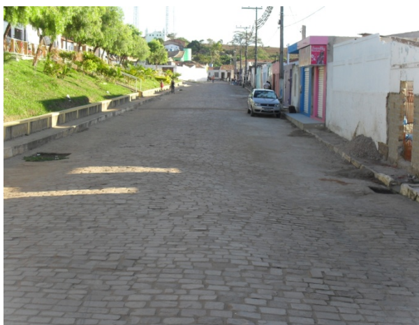
Foto 3: Dispositivos de drenagem da Rua Manoel Novaes.
