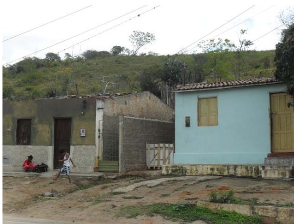
Foto 3: Área Crítica 2 – casas no pé do morro que recebem águas de enxurrada pelo fundo.
