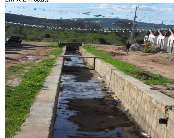
Foto 24: Trecho final do canal de alvenaria de pedra do Bairro Novo Amanhecer.
