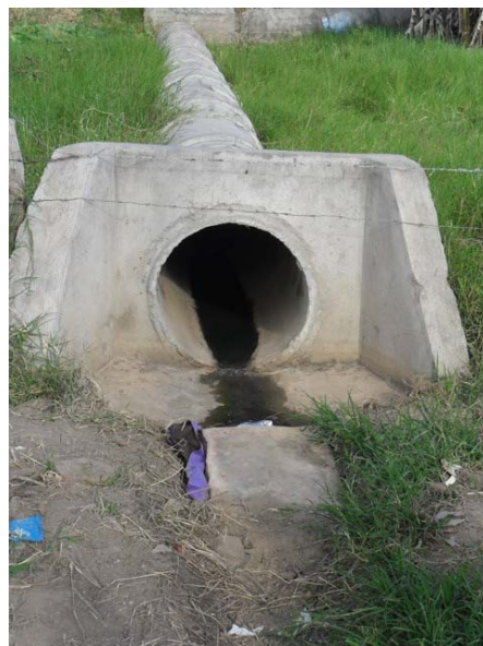
Foto 6: Tubo de concreto de DN600 – dispositivo de drenagem transportando esgotos.
