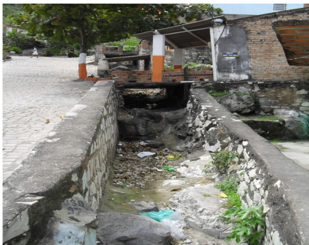
Foto 1: Canal de alvenaria de pedra da Rua Santa Terezinha. Bairro Leader. Seção 1,20m X 1,80m.
