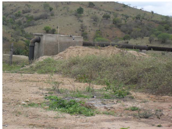
Foto 8: Estação Elevatória - obras não concluídas
