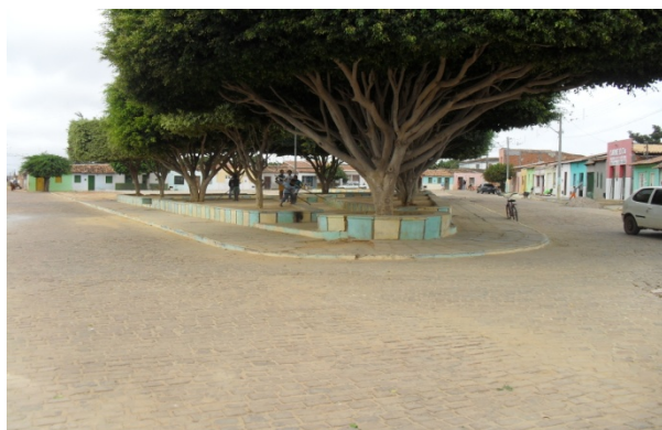
Foto 5: Área crítica 2 - Praça Fernando Daltro e Rua Fernando Daltro. Área crítica por conta das chuvas de enxurrada.
