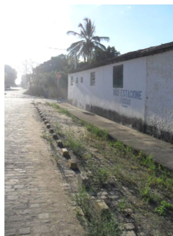
Foto 6: Fossas do hospital construídas ao longo da Rua Getúlio Vargas (transbordam com frequência).
