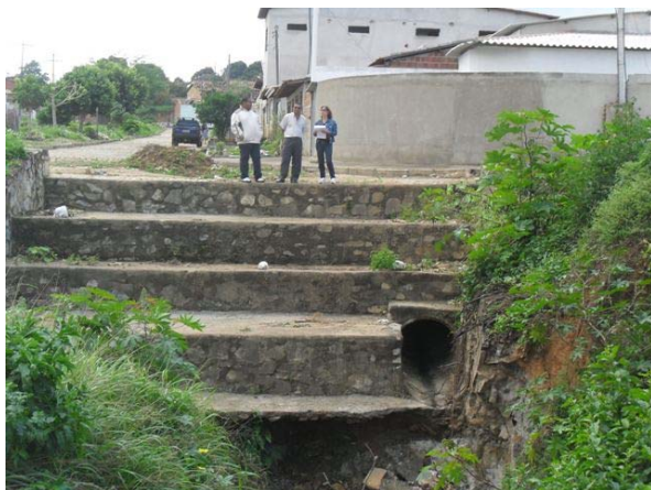
Foto 5: Escadaria para amortecer a força das águas. Observa-se tubulação na lateral da estrutura com DN 1000mm.
