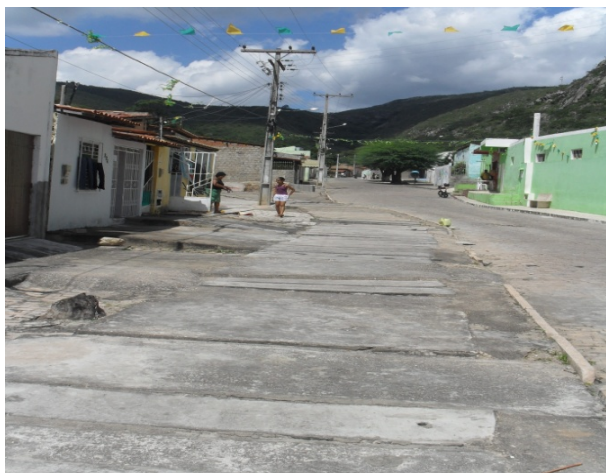
Foto 21: Trecho enterrado do canal existente no bairro da Grotinha.
