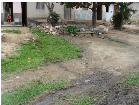
Foto 15: Esgotos correndo a céu aberto em vias não pavimentadas.
