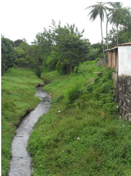
Foto 7: Ponto de lançamento direto de esgoto secundário vindo de residências a beira do córrego.
