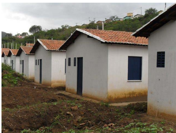
Foto 7: Casas populares ainda sem infraestrutura – ponto de baixada próximo ao Rio da Mangueira.
