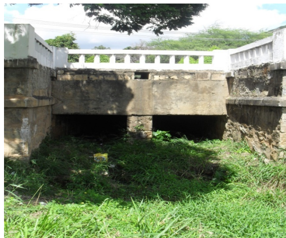
Foto 22: Ponto de lançamento final do canal do bairro da Grotinha no Rio Itapicuru Mirim. Saída dupla de seção 2m X 2m cada.
