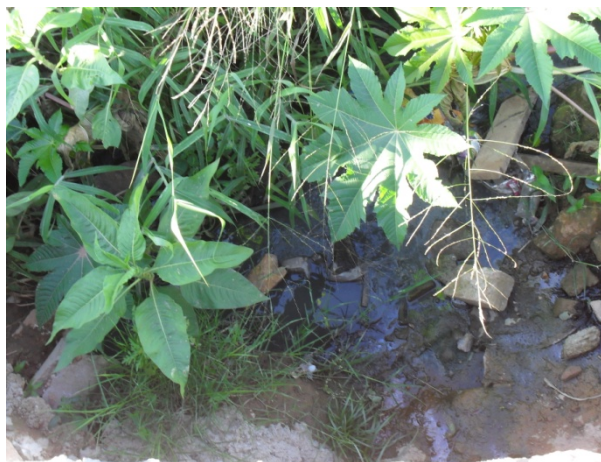
Foto 1: Ponto de lançamento de esgotos sanitários e águas pluviais em canal natural. Tubulação de concreto de DN 300mm.
