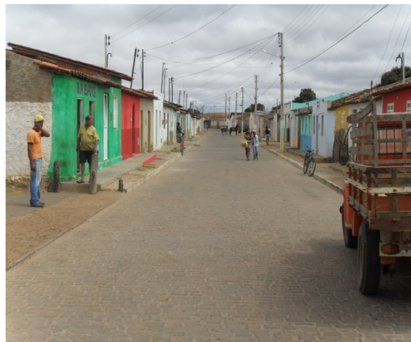
Foto 2: Área crítica 1 - Área mais afetada por alagamento da Rua José Pedro.
