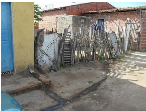
Foto 9: Esgoto sanitário correndo a céu aberto em via não pavimentada
