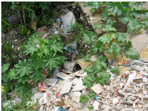
Foto 3: Ponto de lançamento de esgoto e drenagem, através de tubo DN1000mm, da Rua Campo Sales – presença de muito lixo.
