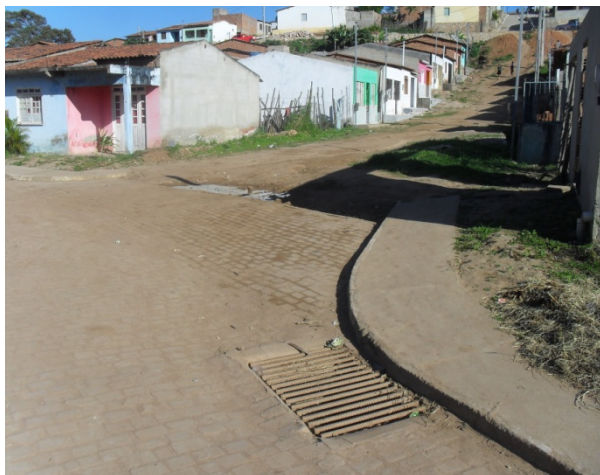
Foto 1: Dispositivos de drenagem do Alto da Santa Cruz
