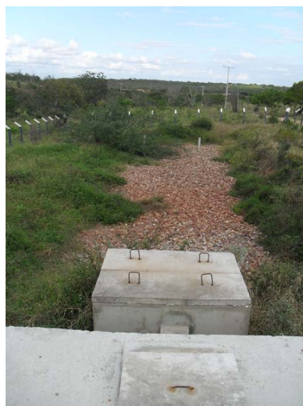
Foto 4: ETE 1 - povoado de Piabas – vista da vala de filtração
