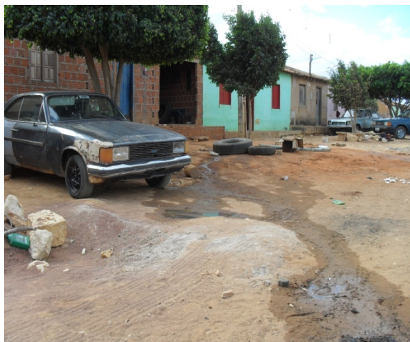
Foto 1: Esgotos sanitários correndo a céu aberto no Bairro das Umburanas.
