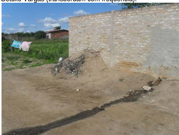
Foto 7: Esgoto sanitário correndo a céu aberto em via não pavimentada
