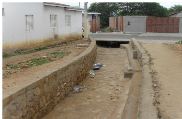
Foto 6: Canal de alvenaria de pedra. Seção 2,20m X 1,15m e com extensão aproximada de 1km.
