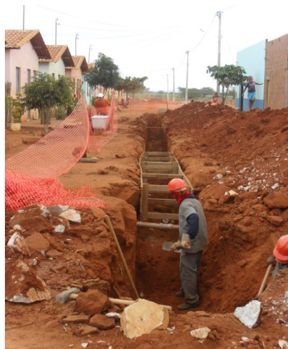
Foto 2: Obras de esgotamento sanitário em implantação pela Codevasf. Fase de abertura de valas e assentamento da tubulação.
