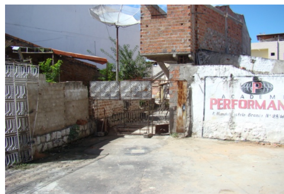
Foto 6: Rua Antônio Emídio da Costa – final do canal de macro drenagem com ocupação da população.
