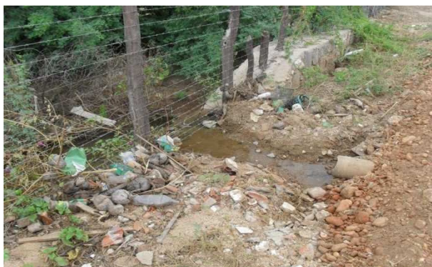
Foto 5: Córrego de Malan. Ponto de lançamento de esgoto
