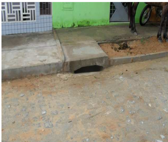
Foto 7: Rua Natanael, detalhe da boca de lobo.
