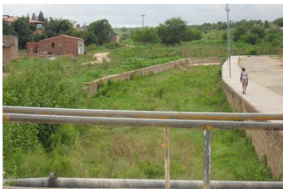
Foto 5: Canal natural com muro de alvenaria nas laterais. Travessa ACM.
