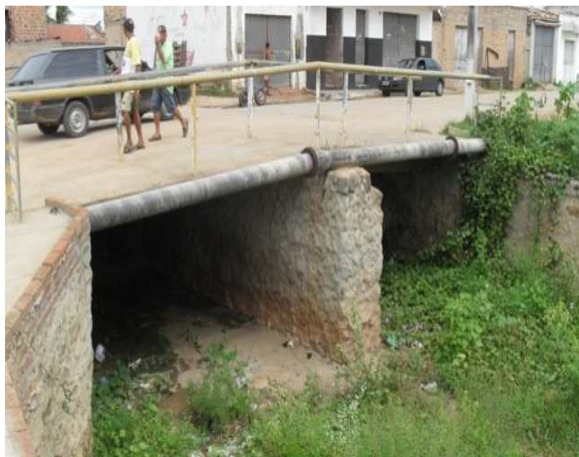
Foto 7: Canal próximo da Avenida ACM.
