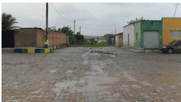
Foto 5: Área de alagamento, trecho de cruzamento da Av. Nossa Senhora de Fátima com a Rua 7 de Setembro.
