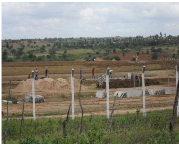
Foto 7: Área de ampliação e construção da Estação de Tratamento de Água da Embasa. Próximo da BR116
