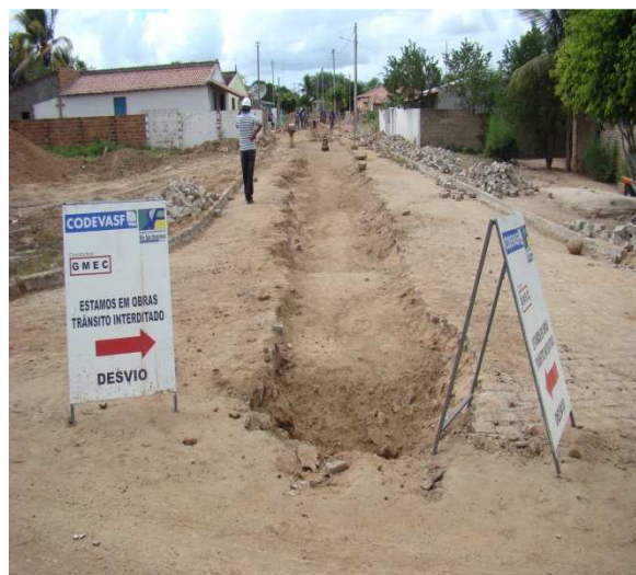
Foto 2: Rua Odair Pereira – Obra de esgotamento sanitário coordenada pela CODEVASF.
