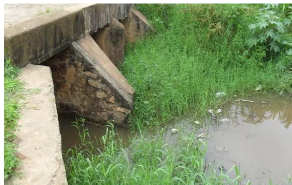
Foto 6: Bueiro situado na Av. Guarujá, passagem do escoamento de água para a Lagoa José do Carmo (lado direito).
