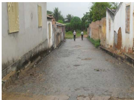
Foto 6: Final da Rua Cícero Dantas. Ponto de lançamento e escoamento das águas pluviais para o brejo. Sistema misto.
