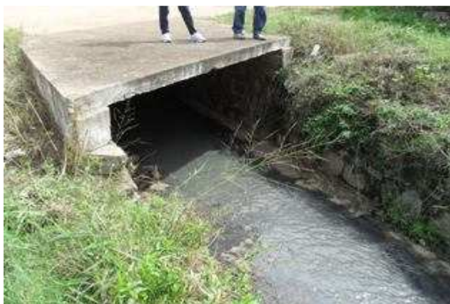
Foto 3: Canal revestido em alvenaria de pedra
