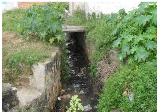
Foto 8: Canal aberto de alvenaria.
