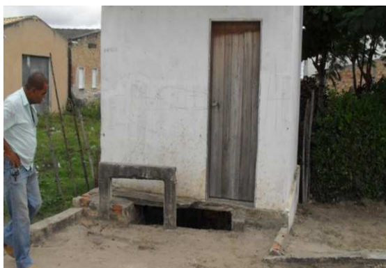
Foto 11: Drenagem da Águas Pluviais que passa por baixo da casa.
