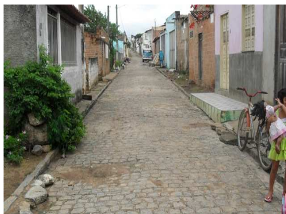
Foto 4: Rua São Rafael, casa nº 65, lançamento de esgoto a céu aberto.
