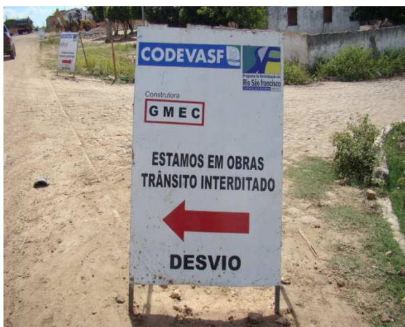
Foto 3 - Rua Odair Pereira – Obra de esgotamento sanitário coordenada pela CODEVASF.
