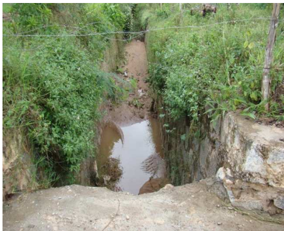
Foto 1: Final da galeria enterrada. Avenida Paulo Souto com Av. Jeremoabo.
