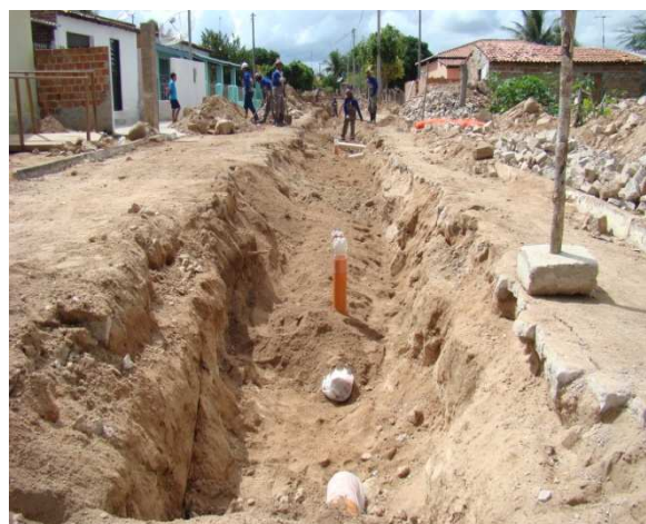
Foto 4: Rua Odair Pereira – Obra de esgotamento sanitário coordenada pela CODEVASF.
