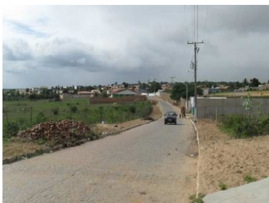
Foto 5: Área crítica 3, caracterizada por freqüentes alagamentos - Avenida Francisco de Matos.
