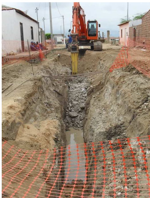
Foto 7: Obras do sistema de esgotamento sanitário
