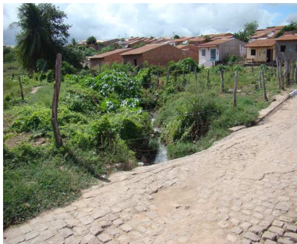
Foto 1: Talvegue de macrodrenagem. Final da Rua dos Romeiros.
