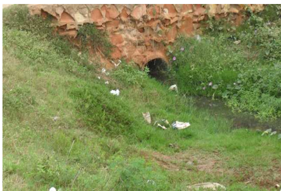
Foto 3: Lançamento de esgoto manilha de 400, sob a BR-110
