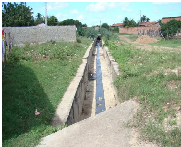
Foto 4: Canal rede coletora.
