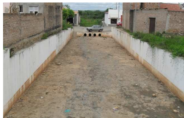
Foto 6: Canal de alvenaria com quatro manilhas de 400.
