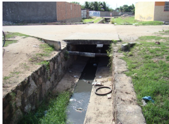
Foto 2: Canal 1 – Passagem pela Rua Frei Damião.
