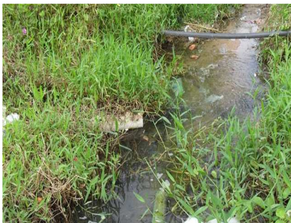
Foto 3: Lançamento AP/Esgoto, próximo da localidade de Tio Chico.
