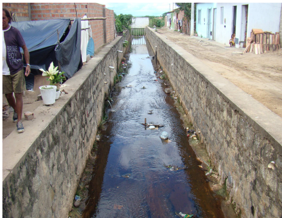
Foto 2: Lançamento esgoto direto no canal.
