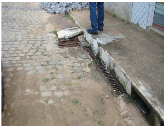
Foto 1: Início da rede de Macro Drenagem – Rua Abdias Rodrigues.
