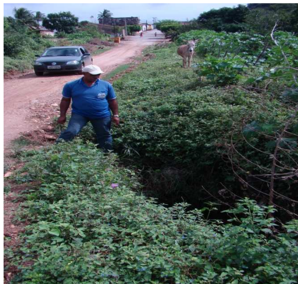
Foto 2: Saída de esgoto – Rua Dantas Junior.
