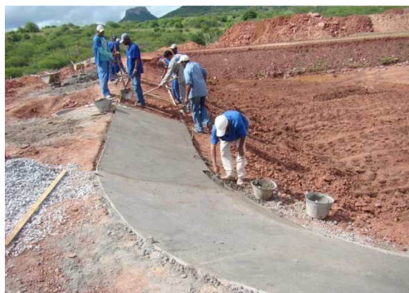
Foto 2: Construção da estação de tratamento de esgoto.
