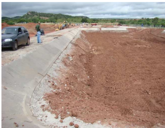
Foto 3: Estação de tratamento de esgoto em construção.
