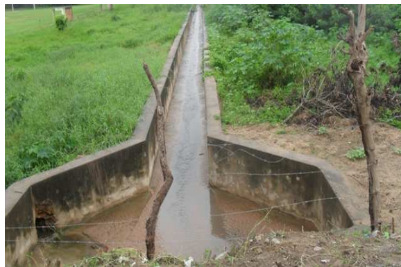
Foto 3: Canal a céu aberto de águas pluviais. Atravessa a BA 220 e segue em direção ao Tanque São Paulo Velho.
