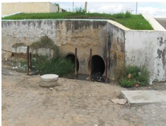
Foto 11: Bueiro Próximo da BR-116.
