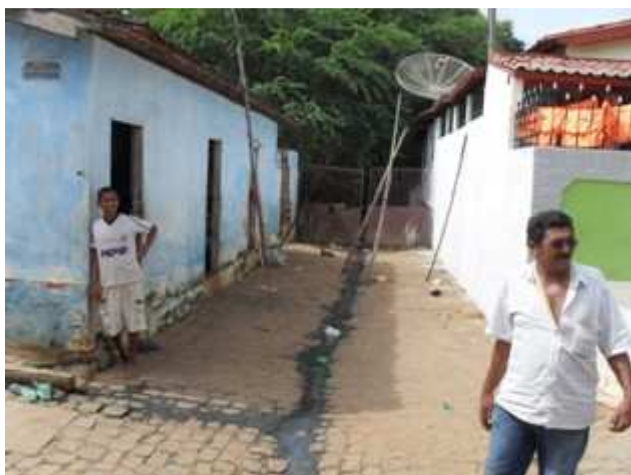
Foto 3: Esgoto correndo a céu aberto
