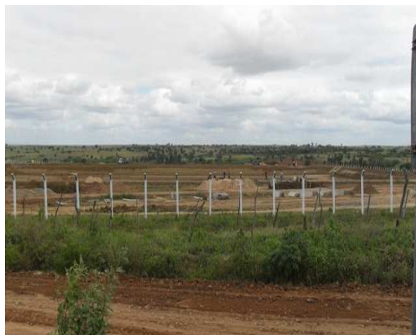
Foto 8: Área de ampliação e construção da Estação de Tratamento de Água da Embasa. Próximo da BR116.
