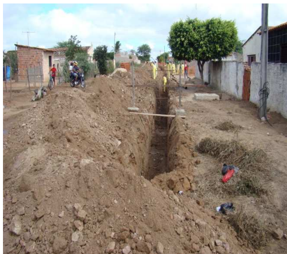
Foto 3: Construção do canal de esgoto.
