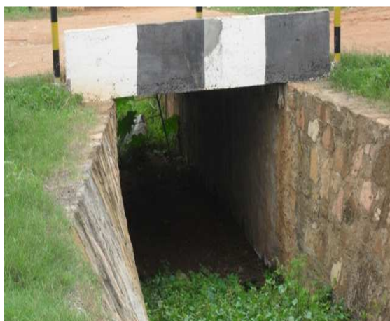
Foto 4: Ponte sobre o canal próximo da BR-110.
