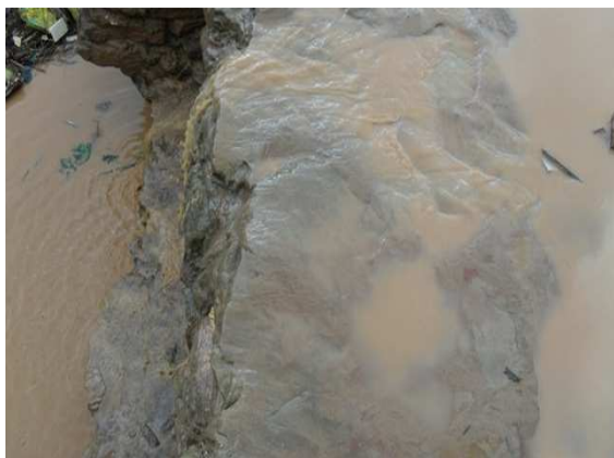
Foto 5: Ponto de águas pluviais e esgoto, Rua dos Missionários.
