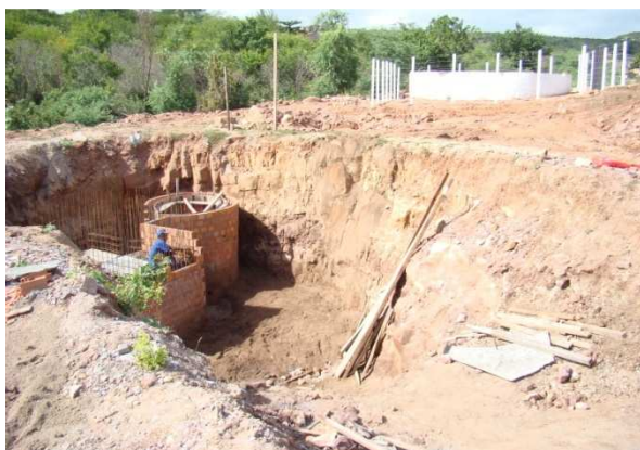
Foto 1: DAFA e estação de bombeamento em construção.
