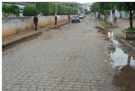
Foto 6: Rua Benicio Tomas, esgoto a céu aberto.
