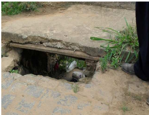
Foto 1: Rua Maestri Fiel, vista da caixa coletora.
