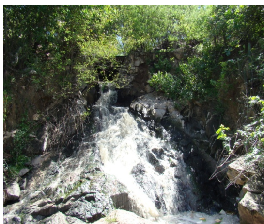
Foto 4: Av. dos Encantos – último trecho coberto da galeria de macro drenagem – saída da água.
