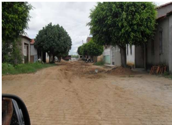
Foto 2: Área Crítica 1, caracterizada por freqüentes alagamentos. Final da Rua São Felix.
