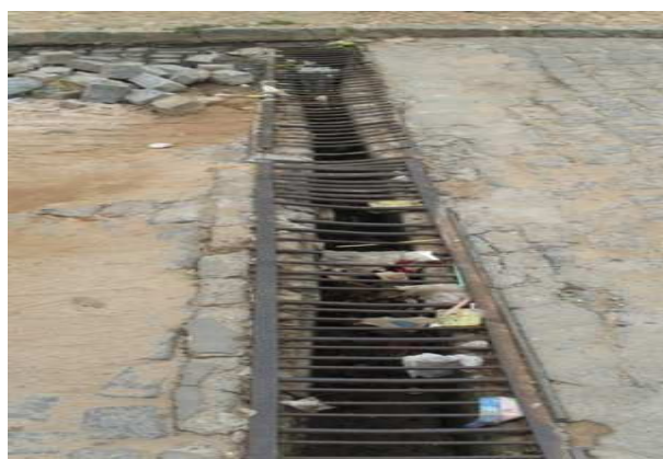
Foto 4: Travessa do Campo. Drenagem com grelha horizontal.
