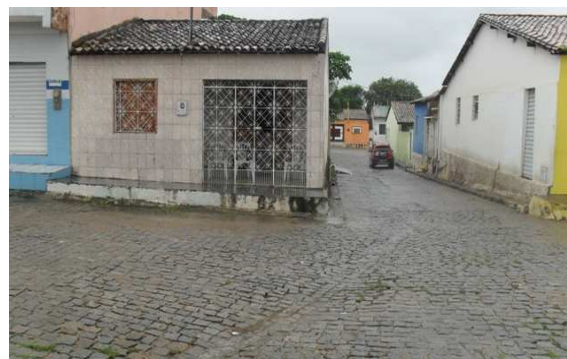
Foto 8: Trecho de alagamento Avenida Nossa Senhora de Fátima, área crítica 1. Declividade acentuada.
