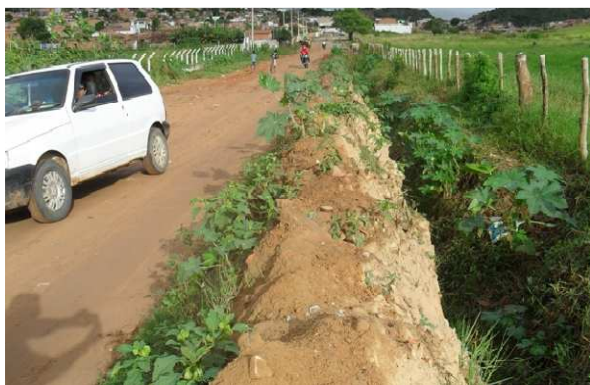
Foto 5: Estrada São João da Fortaleza. Canal natural que contém esgoto a céu aberto
