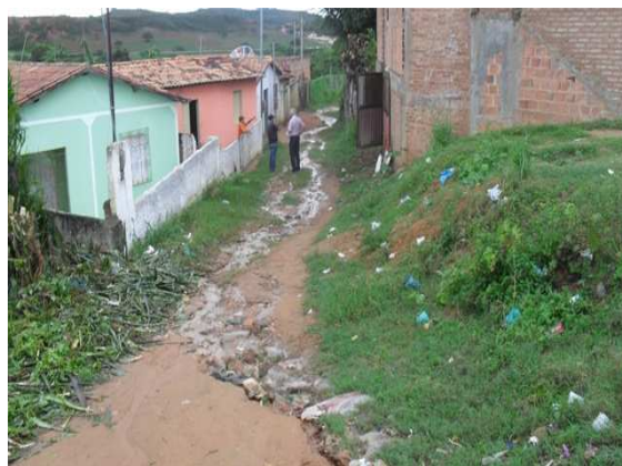
Foto 6: Área de lançamento de águas pluviais e esgoto. Próximo de Rua dos Missionários.
