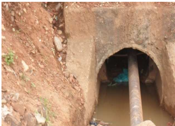
Foto 1: Bueiro, próximo da BR-110.
