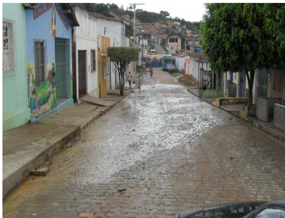
Foto 1: Avenida ACM, drenagem superficial com declividade acentuada.
