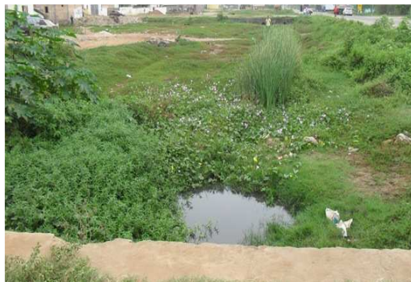
Foto 2: Bueiro sob a rodovia para Itapicuru com lançamento de esgoto.
