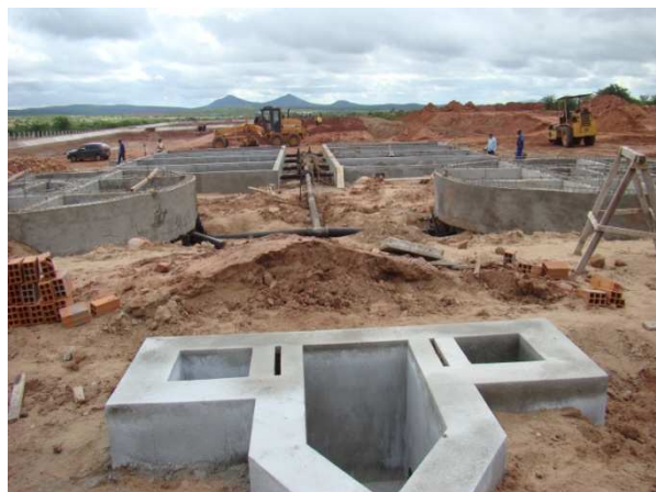
Foto 4: Estação de tratamento de esgoto em construção.
