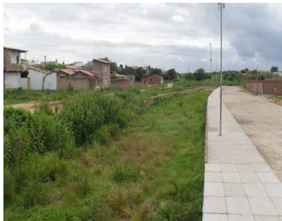
Foto 8: Canal próximo da Travessa ACM.
