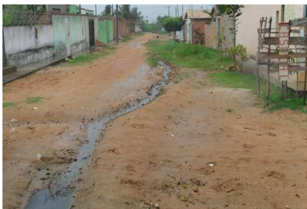
Foto 5: Bairro da Mangabeira, ocupação chamada Iraque. Rua 1º Travessa da Mangabeira, área de lançamento de esgoto a céu aberto.
