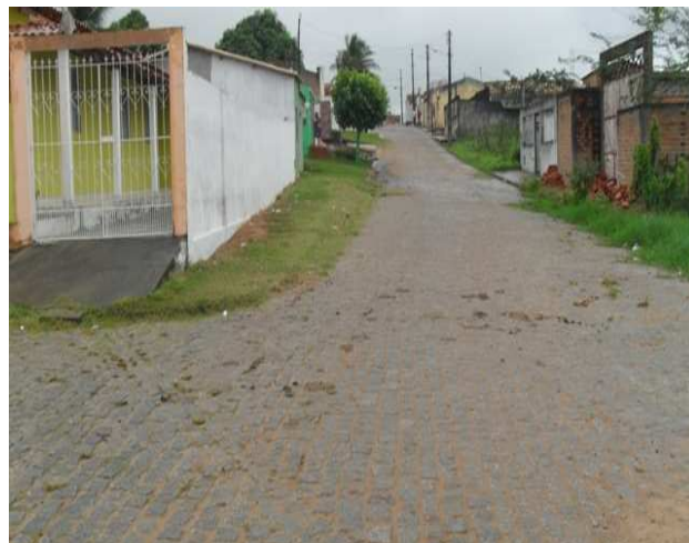
Foto 2: Cruzamento da Rua Isabel Ribeiro com a Rua Regis Pacheco, apresentando acentuada declividade.
