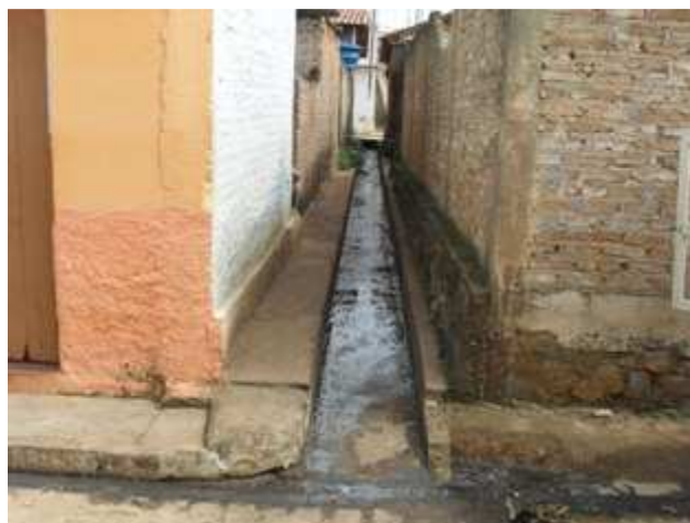
Foto 4: Esgoto correndo por canaletas entre casas
