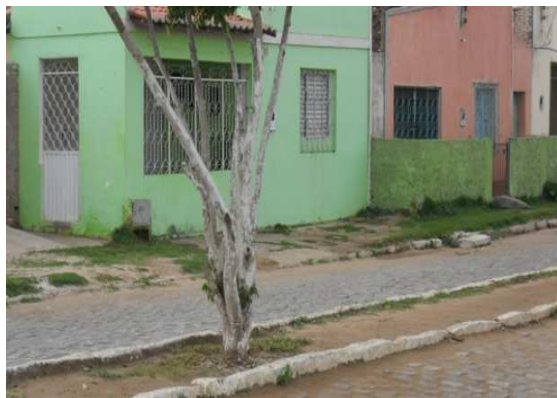
Foto 2: Área de alagamento Rua João Costa Pinto
