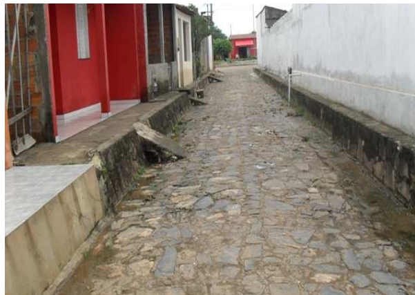
Foto 2: Rua José Ribeiro, canal a céu aberto ao longo das residências.
