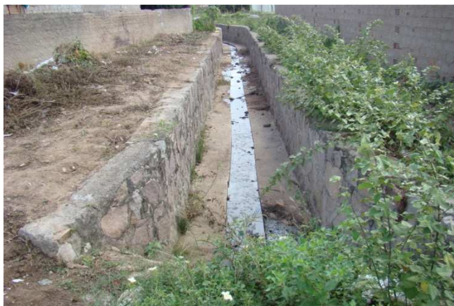
Foto 2: Rede coletora – Rua do Canal 2 – Bairro Tancredo Neves, 2.3
