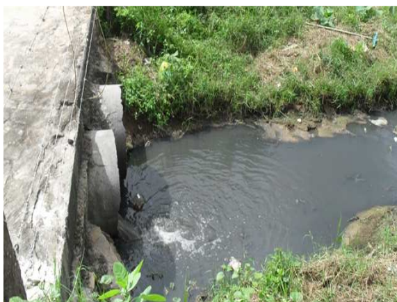
Foto 3: Ponto de lançamento de esgoto. Próximo da Av. Luis Viana Filho.
