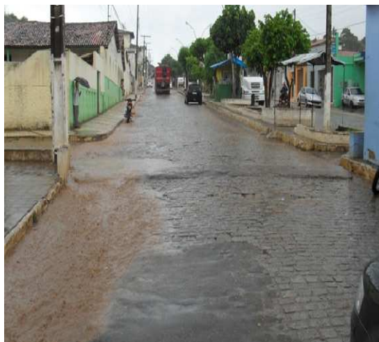
Foto 8: Praça Raimundo Borges, área de alagamento e escoamento de águas pluviais.
