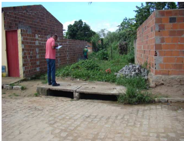
Foto 3: Rua Demócreto Pereira de Andrade – início da galeria de Macro Drenagem.
