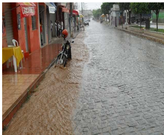
Foto 10: Av. ACM. Drenagem superficial longitudinal, com declividade suave.
