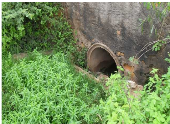
Foto 1: Bueiro próximo a rodovia para Itapicuru.
