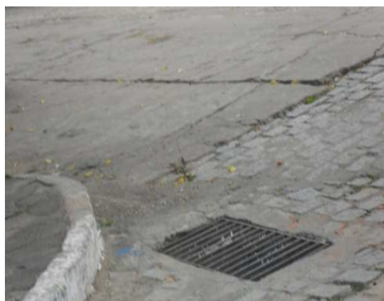
Foto 6: Estrutura de micro drenagem. Praça Frei Sarafim. Drenagem de Grelha horizontal.
