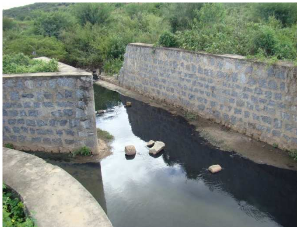
Foto 1: Entrada de emissário de esgoto no Canal de Pedra.
