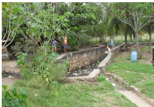
Foto 4: Início do canal de alvenaria central aberto.
