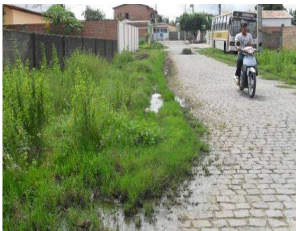
Foto 3: Esgoto a céu aberto.
