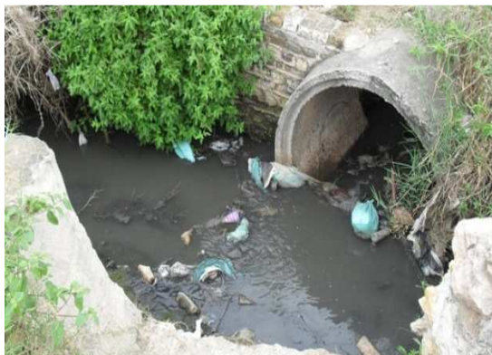
Foto 7: Saída do canal apresentando assoreamento. Manilha de diâmetro 400mm.
