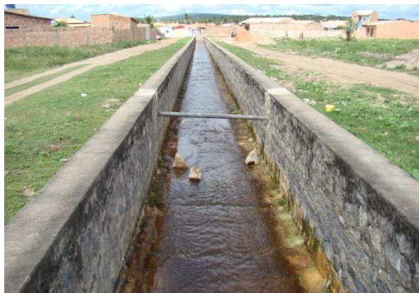
Foto 2: Canal de Pedra – Rua Floripes Cavalcante.
