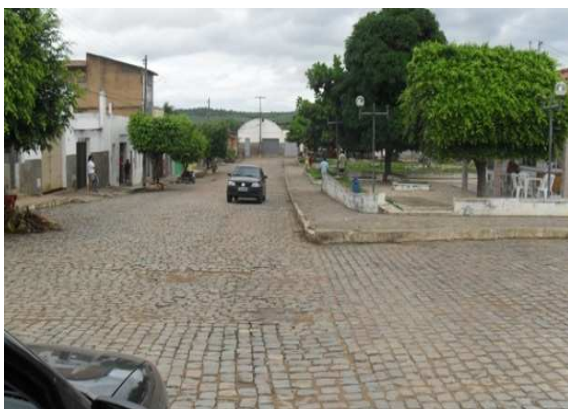
Foto 3: Praça Ruy Barbosa. Ponto de escoamento de água pluvial e esgoto para o canal da Rua José Ribeiro.
