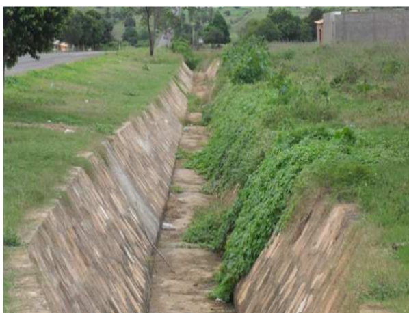
Foto 3: Canal de alvenaria de pedra.
