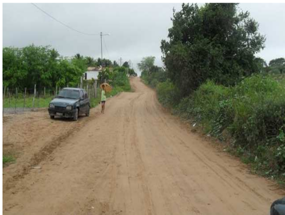
Foto 7: Área de lançamento de esgoto a céu aberto próxima da propriedade do Sr José Maria dos Santos.
