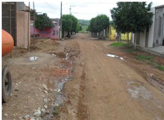
Foto 7: Rua Acrésio Romão. Área não-pavimentada apresentando sinais de erosão.
