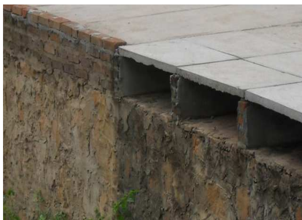
Foto 4: Sistema de microdrenagem, Avenida ACM.
