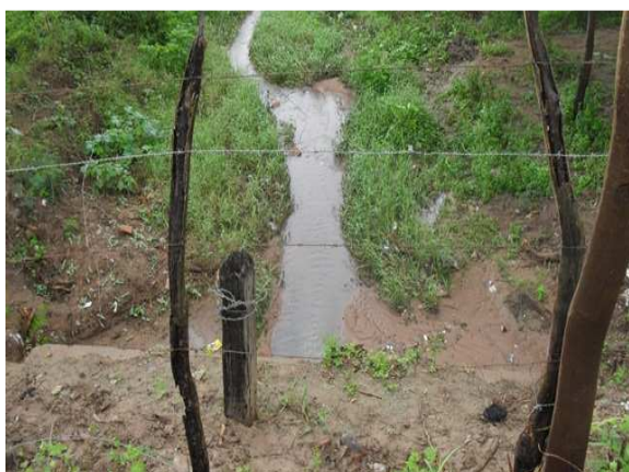
Foto 3: Ponto de lançamento águas pluviais - Esgoto que chega da Av. Nossa Senhora de Fátima e atravessa a BA 220.
