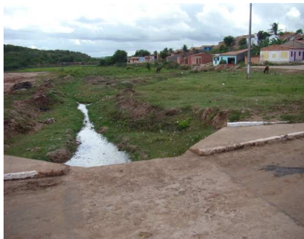
Foto 2: Talvegue de macro drenagem. Final da Rua dos Romeiros.
