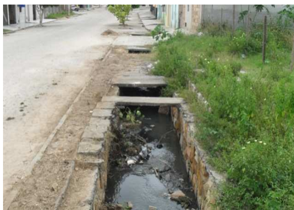
Foto 10: Canal aberto de alvenaria - Rua Princesa Isabel.
