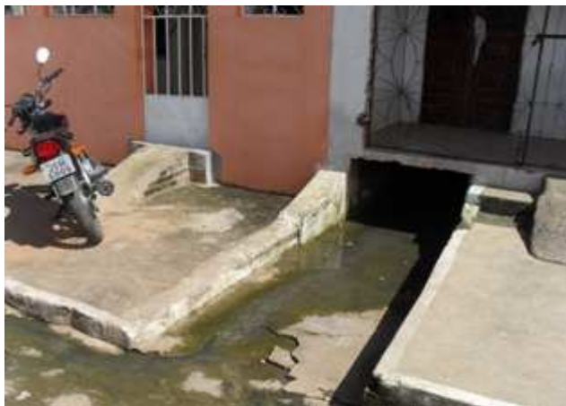
Foto 1: Boca-de-lobo sob edificação.
