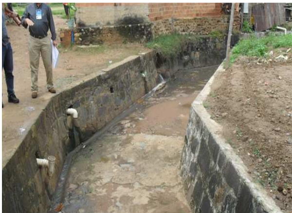
Foto 1: Rua José Ribeiro, final do canal. Observa-se ponto de lançamento de água de uso para o canal que desemboca para a Lagoa do Carmo.
