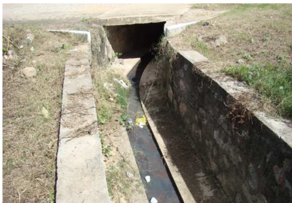
Foto 1: Descarte de esgoto – Bacia do rio Francisco – Bairro Tancredo Neves 1.
