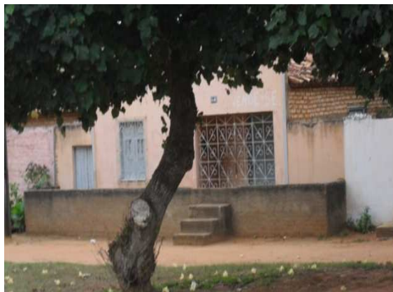
Foto 2: Área de alagamento. Casa com proteção para evitar alagamento.
