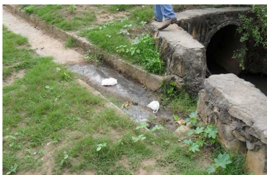
Foto 5: Final do canal de alvenaria fechado ao lado uma canaleta de alvenaria. Sistema misto.
