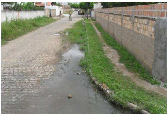
Foto 5: Lançamento de esgoto a céu aberto.
