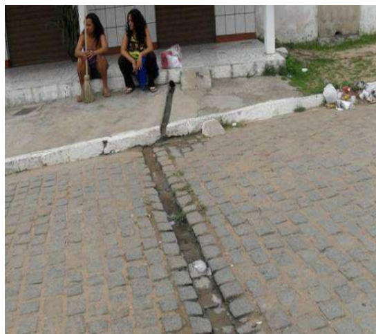
Foto 4: Valeta na pavimentação para veicular águas pluviais e esgoto secundário.
