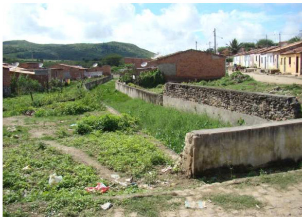
Foto 3: Rua dos Barreiros – início do canal de macrodrenagem.
