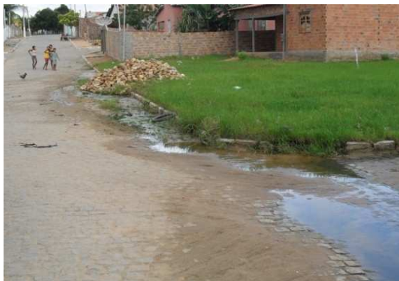
Foto 1: Área de alagamento.
