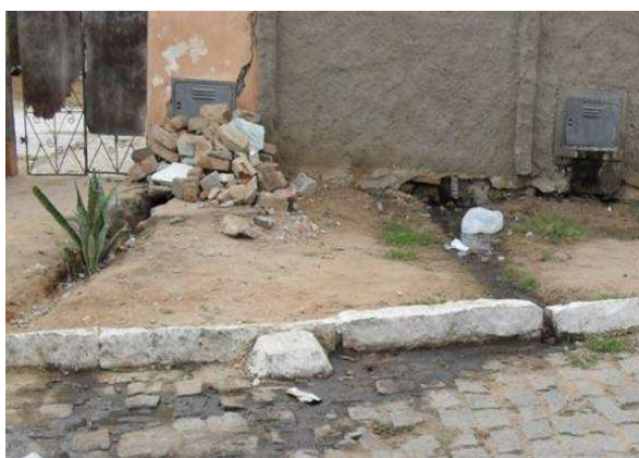
Foto 9: Lançamento de esgoto secundário na rua.
