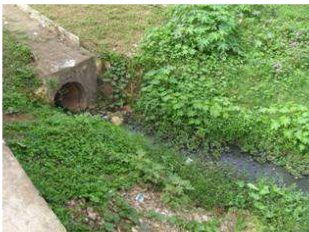
Foto 5: Ponto de lançamento de esgoto
