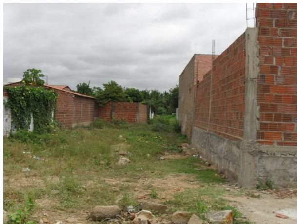
Foto 2: Área Crítica 1, Rua do Campo, caracterizada por freqüentes enxurradas.
