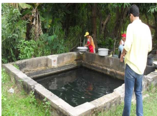
Foto 5: Caixa de concreto próxima antiga estação elevatória. Av. Genival Lucas. Local nascente de rio.
