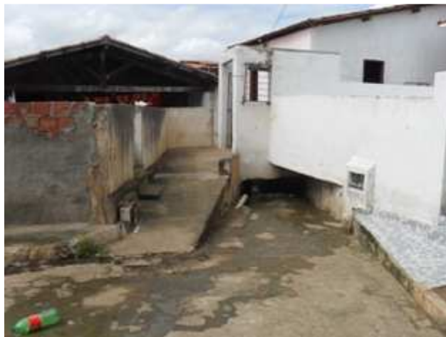
Foto 2: Esgoto secundário lançado em canal de drenagem
