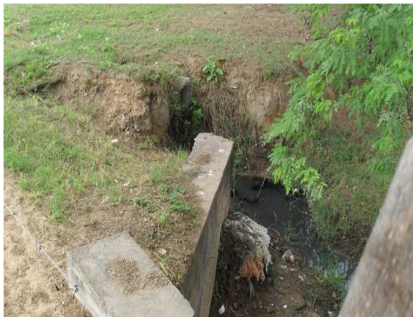
Foto 1: Ponto de chegada de esgoto próximo a BR116.
