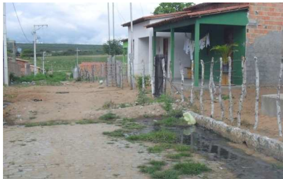
Foto 2: Rua Ovídio Rodrigues de Matos. Esgoto a céu aberto.
