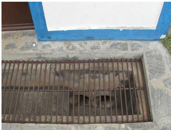
Foto 7: Sistema de micro-drenagem. Caixa com grelha horizontal.
