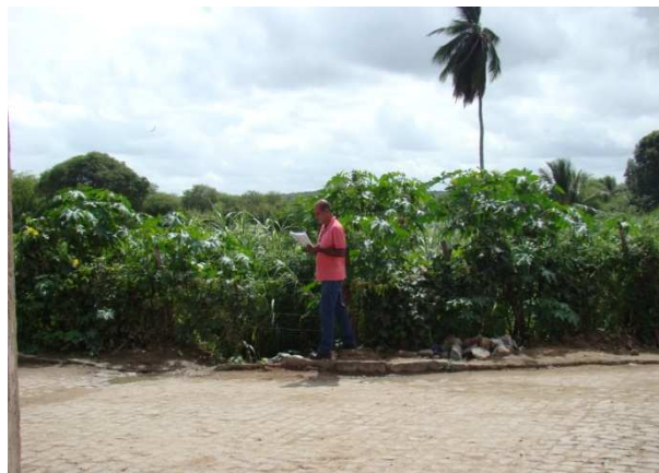
Foto 2: Final da galeria de Macro Drenagem – Rua Beira Rio.
