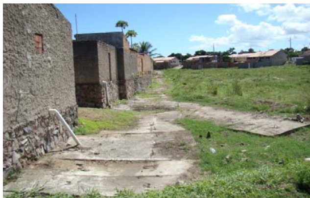
Foto 5: Trecho coberto da galeria de macro drenagem com ligações da população.
