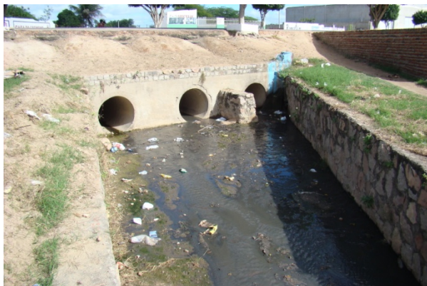
Foto 1: Rua Canal 3 – Bueiro – passagem BA-210.
