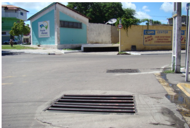
Foto 7: Galeria coberta; canal de macro drenagem – Rua das Palmeiras.
