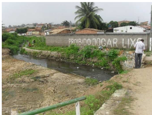
Foto 12: Área crítica no Conjunto Feira X.
