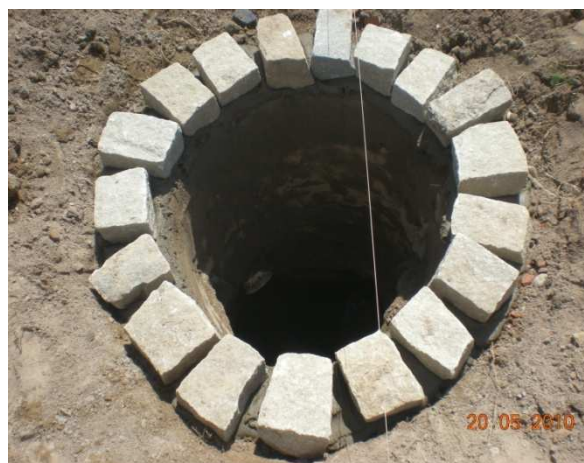
Foto 4: 2 caixas de passagens [PVs], Rua 13 de Julho – 1 caixa de DN 500 mm, cruza com a Rua Isadora Magnavita – 1 caixa no início da Rua 13 de junho. Área de alagamento.
