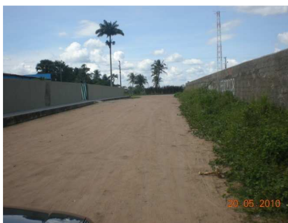
Foto 10: Área de alagamento – Rua Zulmira Chagas, Rua do Hospital cruzam com a Rua Antônio Nunes.
