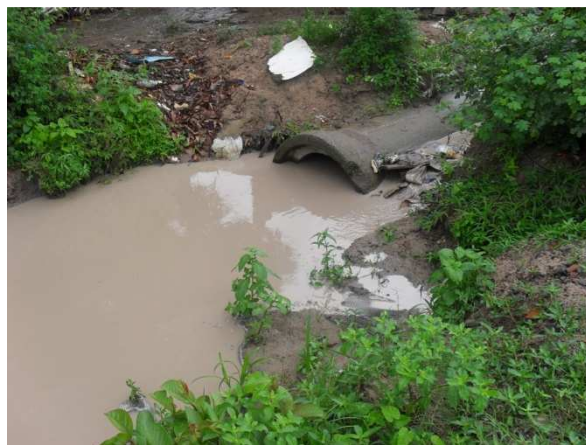
Foto 4: Bueiro no acesso para o Aviário.
