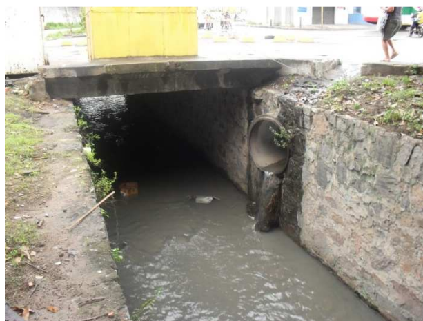
Foto 8: Canal paralelo à Rua José de Anchieta, em área crítica.
