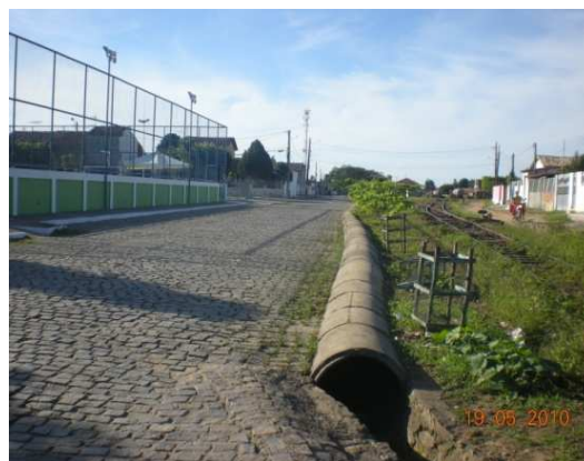
Foto 8: Início da tubulação DN 1000mm, prolongamento da Rua Duque de Caxias.
