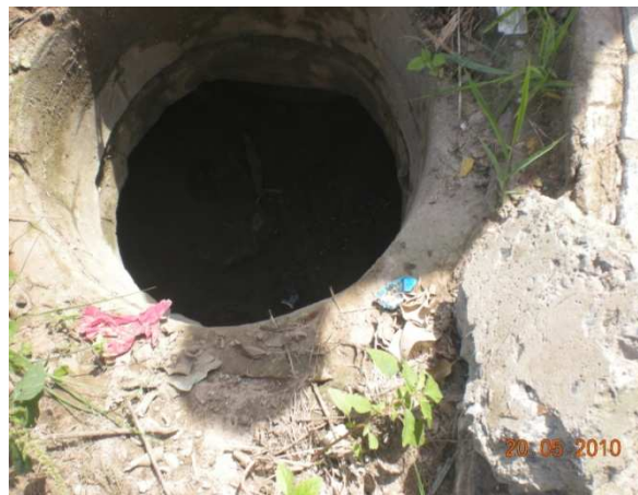
Foto 2: 2 caixas de passagens (PVs), Rua 13 de Julho – 1 caixa de DN 500 mm, cruza com a Rua Isadora Magnavita – 1 caixa no início da Rua 13 de Junho. Área de alagamento.
