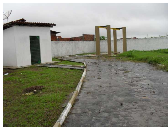
Foto 22: Estação elevatória do Bairro George Américo
