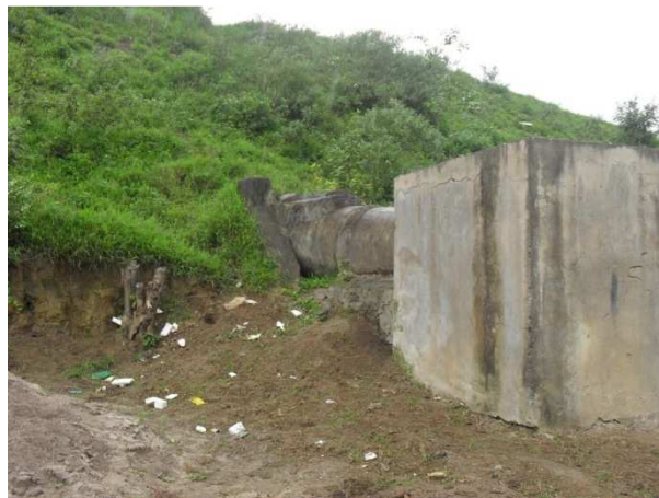
Foto 32: Bueiro sob anel rodoviário no Sobradinho.
