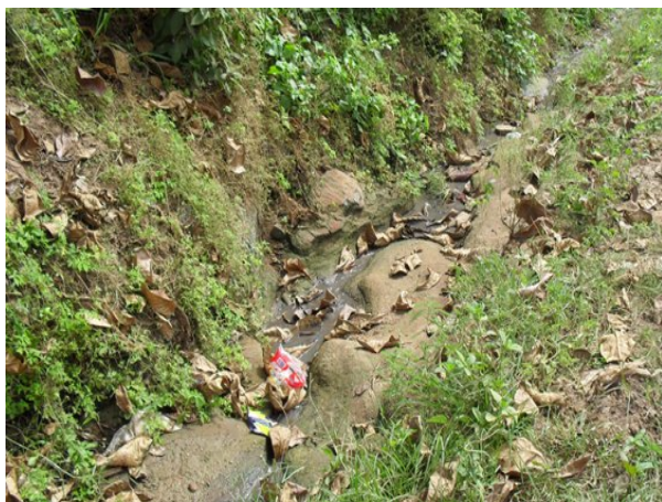
Foto 3: Ponto de escoamento de águas pluviais para o Rio Camarugipe.
