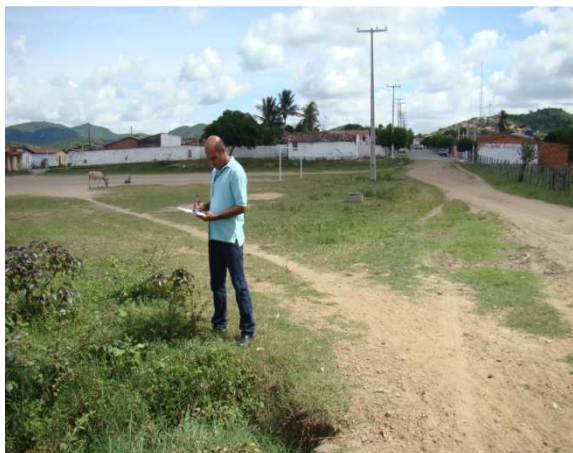
Foto 1: Saída de esgoto próxima do campo de futebol
