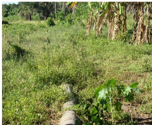
Foto 2: Rede de drenagem.
