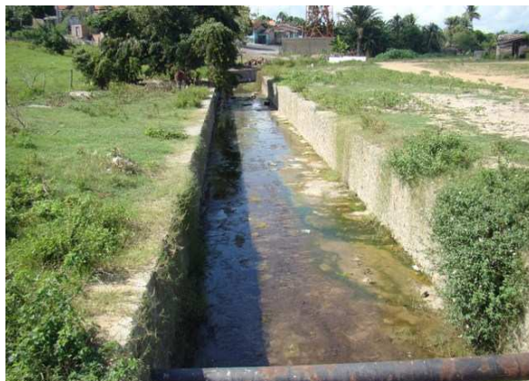
Foto 2: Canal de macrodrenagem revestido
