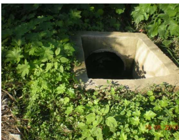
Foto 11: Chegada da tubulação DN 1000mm que vem da Av. Castro Alves até a Rua Duque de Caxias.
