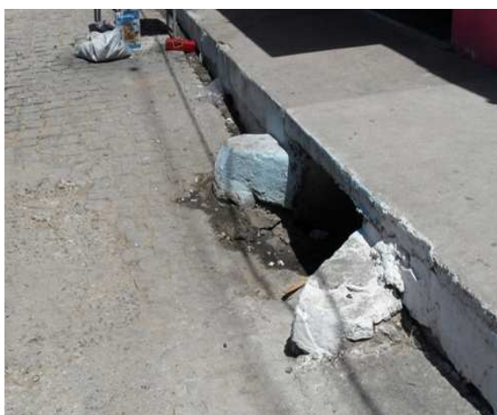
Foto 21: Boca de lobo.
