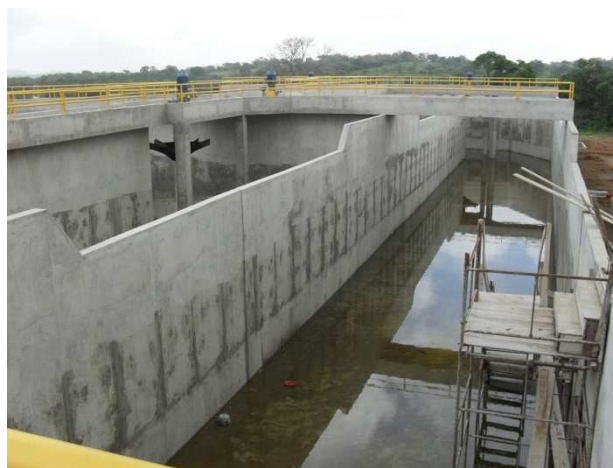
Foto 6: Valo de oxidação em construção na nova ETE da Bacia do Jacuípe
