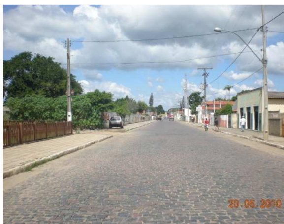
Foto 7: Área crítica – Rua Antônio Muniz, Rua dos Estudantes, Rua Oscar da Purificação cruzam com a Rua Modesto Ribeiro, Rua Artur Magalhães.
