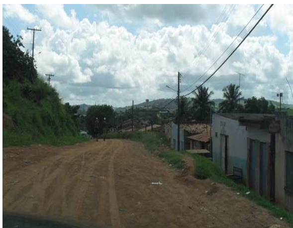
Foto 5: Final da Rua 7 de abril. Área de alagamento.
