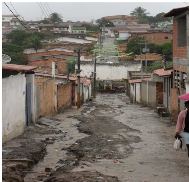
Foto 30: Obras de implantação de esgotamento sanitário no Bairro Feira X
