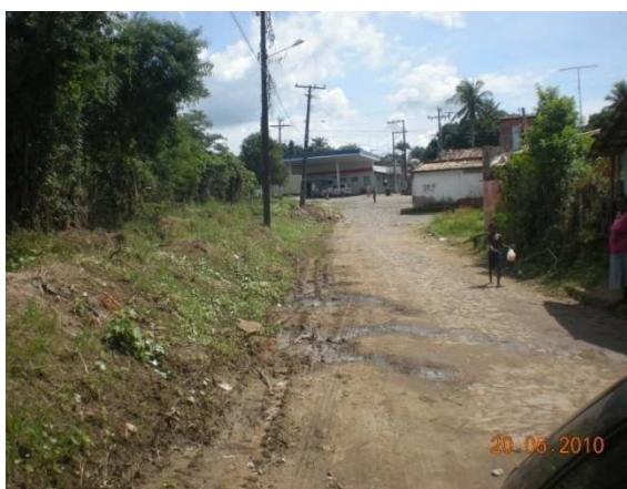
Foto 19: Área de Baixada: Recebe toda drenagem da Av. Artur Magalhães e Av. Antônio Dalto. Rua 8 de dezembro.
