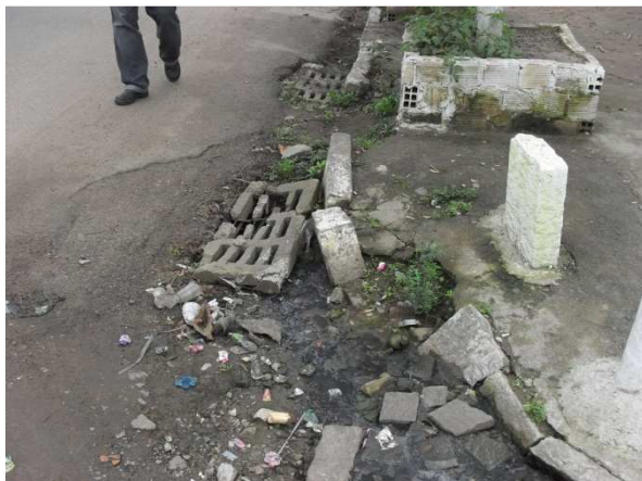
Foto 31: Dispositivos de microdrenagem danificados no Sobradinho.
