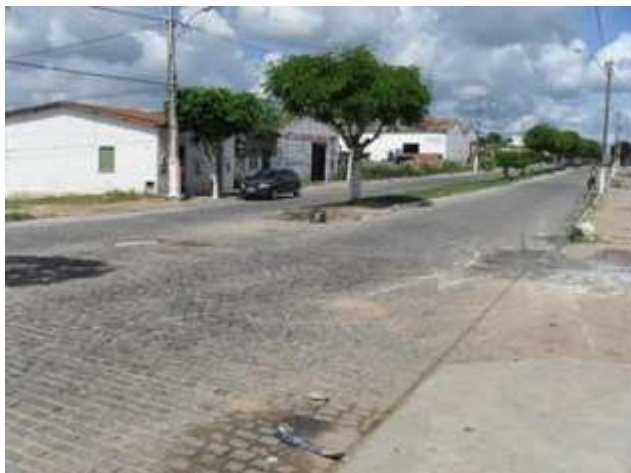
Foto 1: Av. Elísio Santana – Alagamento e enxurrada.
