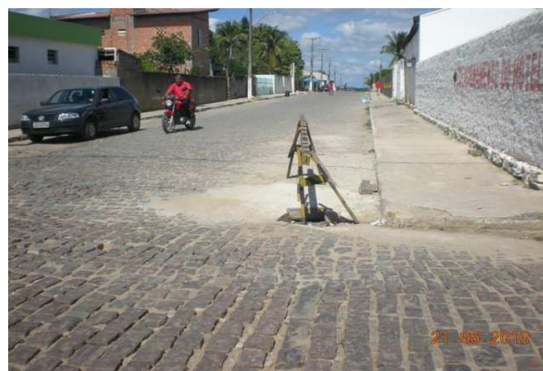
Foto 4: Rua ACM, com drenagem no início na Praça Nossa Senhora da Conceição.
