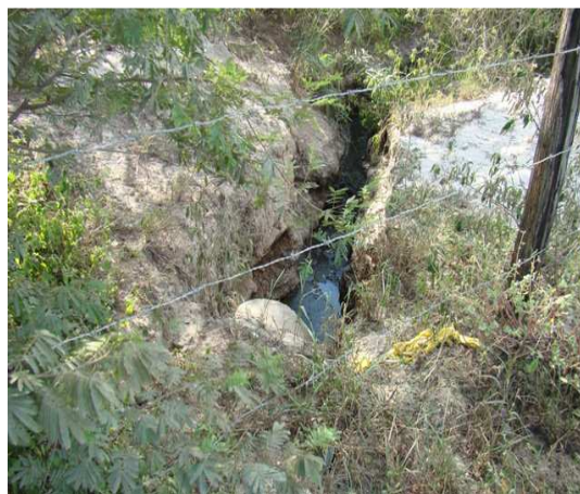
Foto 4: Final da rede de drenagem.
