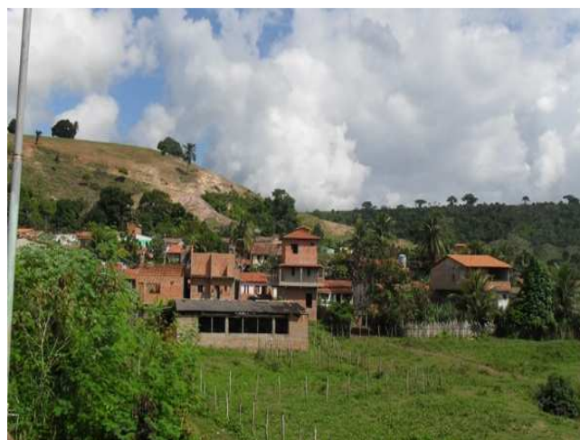
Foto 4: Área de lançamento de esgoto das casas para o Rio Camarugipe.
