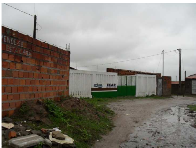
Foto 21: Estação elevatória do Bairro George Américo
