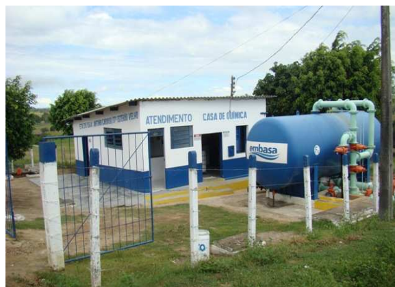
Foto 2: Estação de tratamento de água
