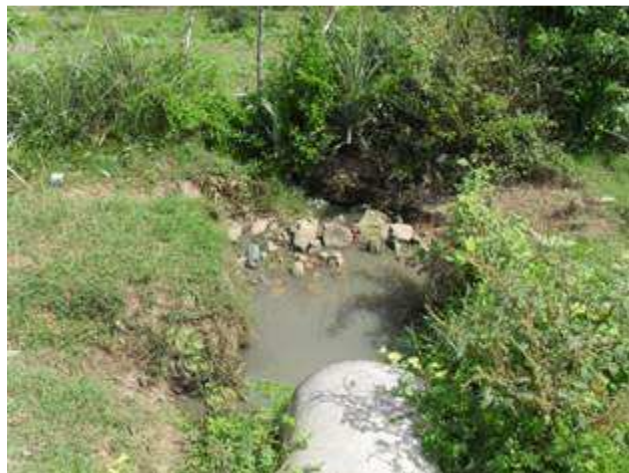
Foto 2: Ponto de lançamento da rede de drenagem
