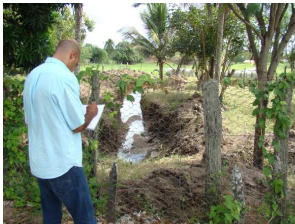
Foto 1: Saída final da Vala Geraldino Carmo.
