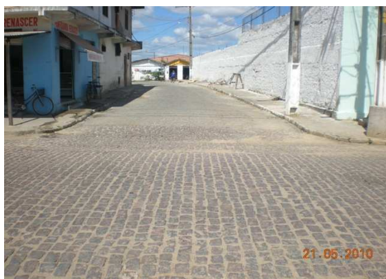
Foto 3: Início da Rua João Augusto Ribeiro, área de alagamento. Próximo da Escola Proteção a Juventude drenagem para Rua Maria Quitéria.
