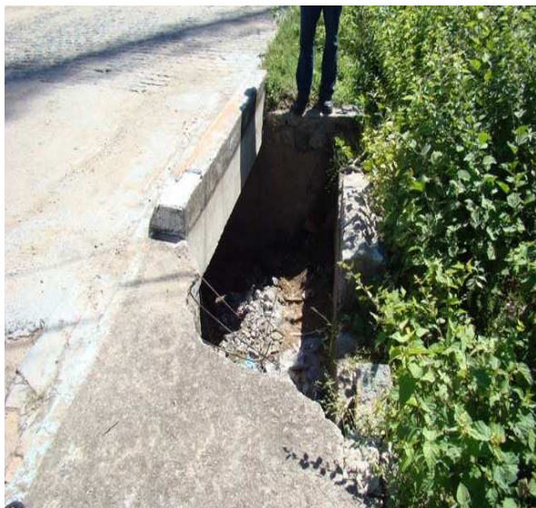
Foto 1: Início da galeria de macrodrenagem
