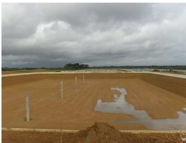
Foto 13: Lagoas de aerção e maturação em construção na ETE da Bacia do Subaé
