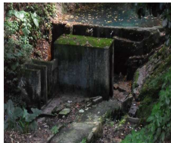
Foto 6: Sistema de drenagem próximo à BR-324.
