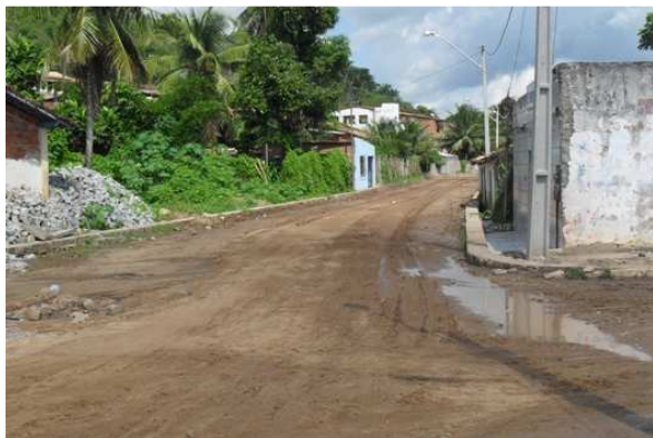
Foto 7: Área de escoamento de águas pluviais.
