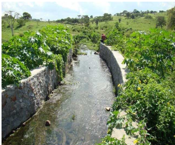
Foto 3: Canal de macrodrenagem revestido
