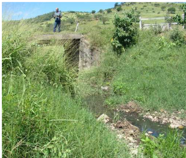
Foto 4: Fim da galeria de macrodrenagem
