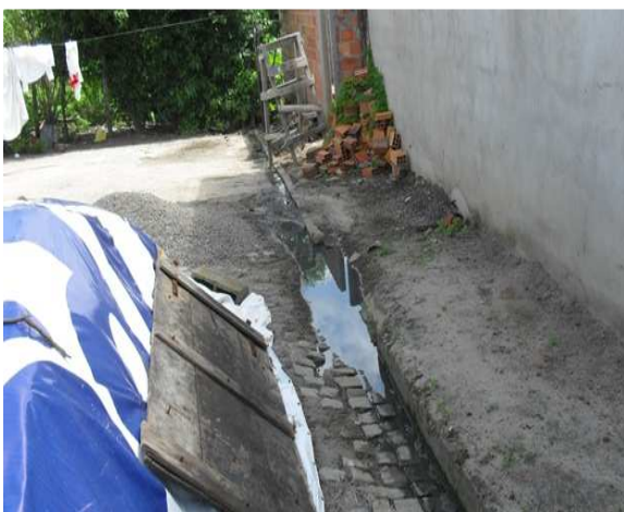
Foto 6: Lançamento de esgoto - Vila Nova.
