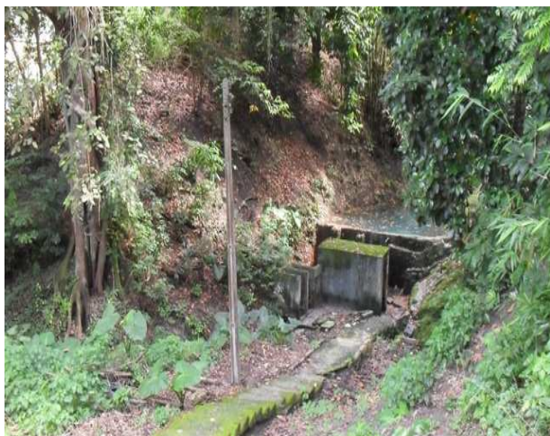
Foto 7: Sistema de drenagem próximo à BR-324.
