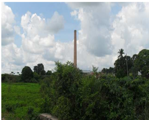
Foto 3: Propriedade da Usina Aliança. Área de lançamento de esgoto.
