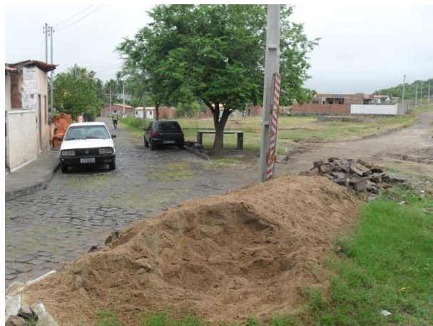
Foto 2: Área crítica – Rua Inácio Teles
