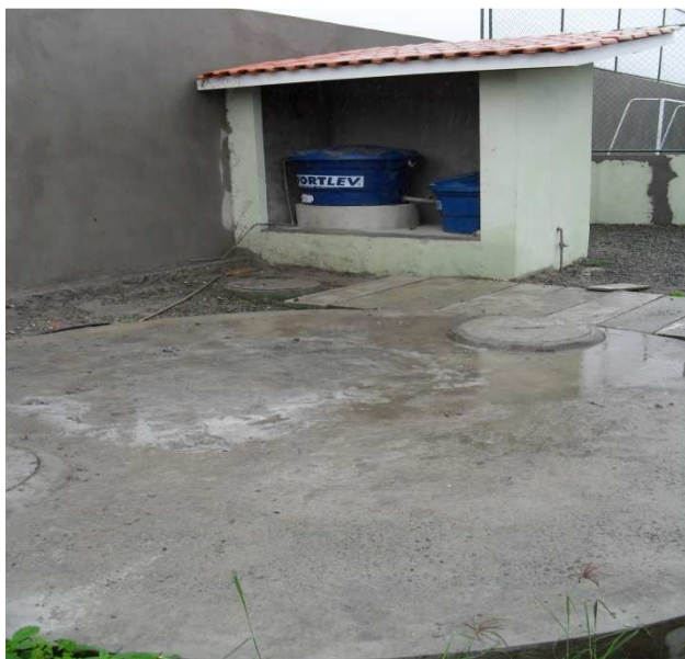
Foto 29: Sistema de cloração – ETE do Condomínio Parque das Azaléias
