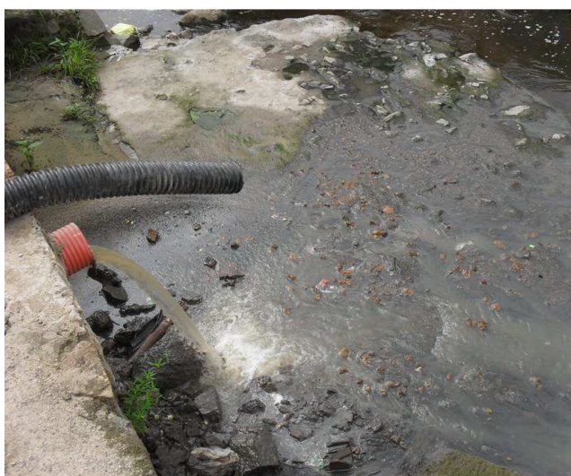
Foto 15: Ponto de lançamento de esgoto em canal no Bairro Feira X
