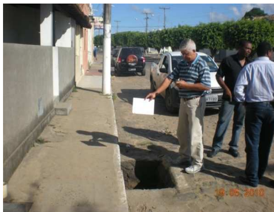
Foto 1: Rua: Castro Alves, caixa de passagem que joga águas pluviais na rua Duque de Caxias.
