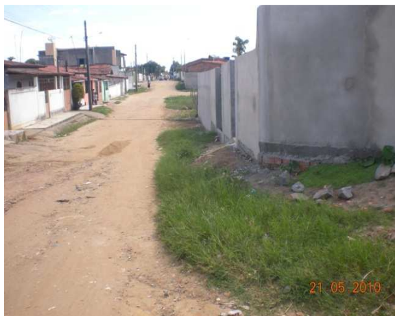
Foto 11: Área de alagamento - final da Rua S. José.
