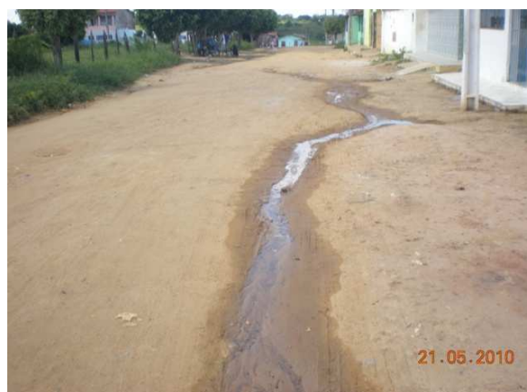
Foto 10: Área de alagamento - Esgoto a céu aberto, Rua João Pimentel.
