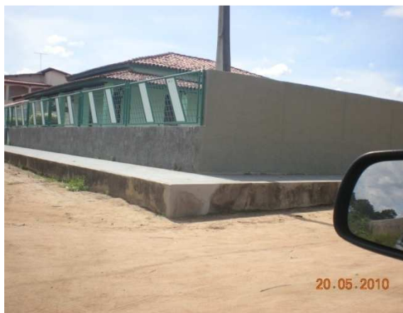
Foto 11: Área de alagamento – Rua Zulmira Chagas, Rua do Hospital cruzam com Rua Antônio Nunes.
