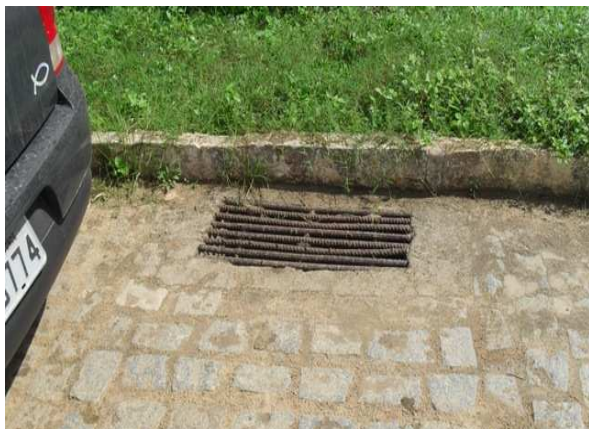
Foto 1: Rua Otavio Araújo. Drenagem com grelha horizontal.
