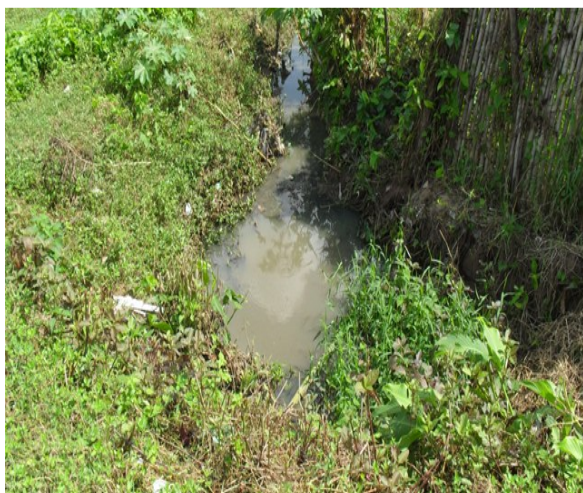
Foto 7: Ponto de lançamento de esgoto
