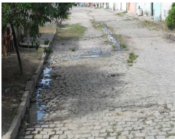
Foto 5: Área de lançamento a céu aberto.
