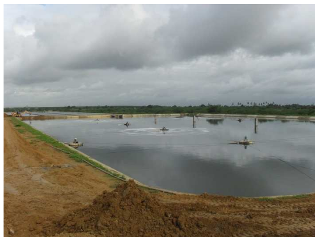
Foto 10: Lagoa de aeração na ETE da Bacia do Subaé
