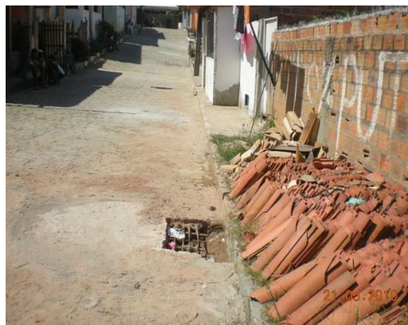
Foto 6: Rua das Angélicas - área de alagamento com grelha horizontal.
