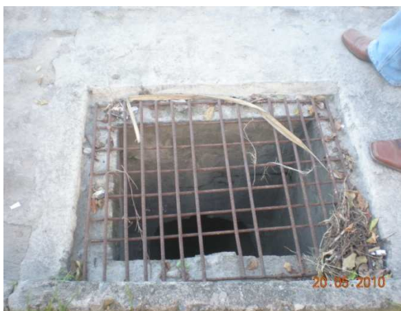
Foto 37: Entrada d'água da rede de DN 300 mm desce toda rua da área de alagamento da José Sarney.
