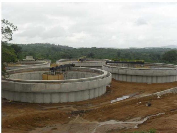
Foto 7: Decantadores em construção na nova ETE do Jacuípe
