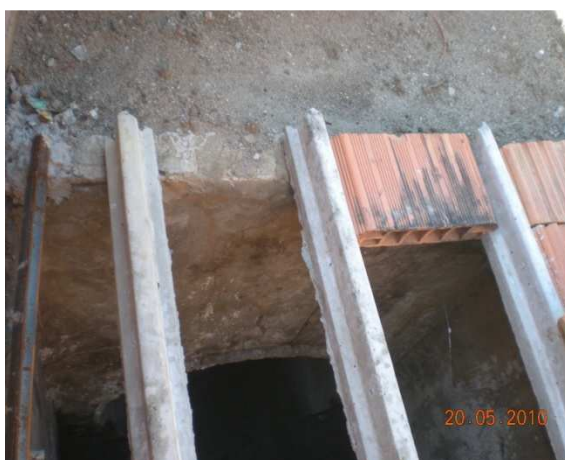
Foto 27: Linha DN 1000 mm, vem do centro e atravessa a Rua Tancredo Neves e passa pelo
