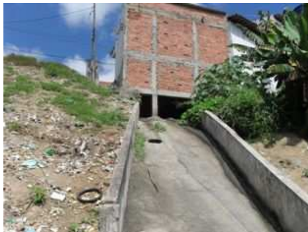
Foto 2: Trecho final de canal de drenagem com contribuição de esgoto.
