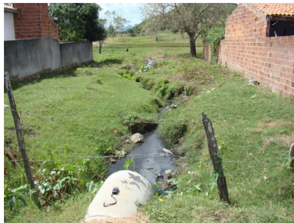
Foto 2: Final da galeria de drenagem
