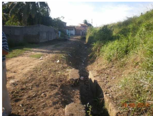
Foto 19: Trecho a céu aberto que recebe as águas da Av. Castro Alves chegando a Rua Duque de Caxias, próximo da Leste.
