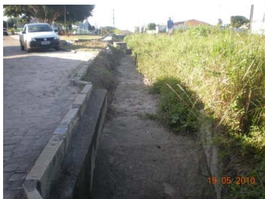
Foto 16: Trecho do canal a céu aberto
