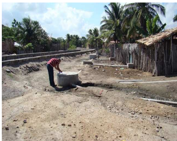
Foto 1: Rede de esgotamento sanitário
