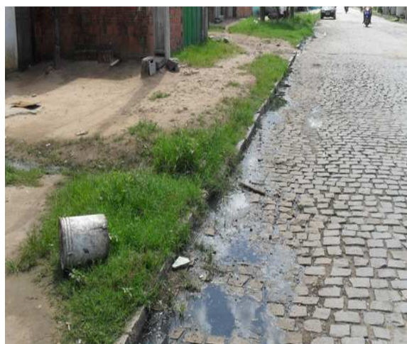
Foto 4: Ponto de lançamento de esgotos na sarjeta – lançamento a céu aberto.
