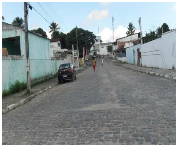
Foto 2: Av. Costa e Silva - Área de alagamento com ligeira declividade.
