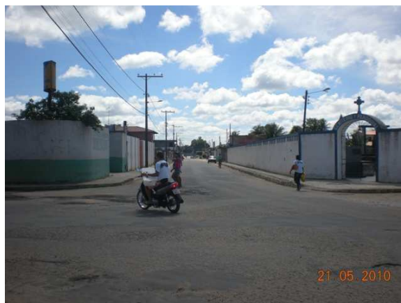
Foto 16: Área de alagamento próxima do cemitério. Cruzamento com Av. Getulio Vargas com a Rua Sergio Cardoso. Drenagem de DN600mm.
