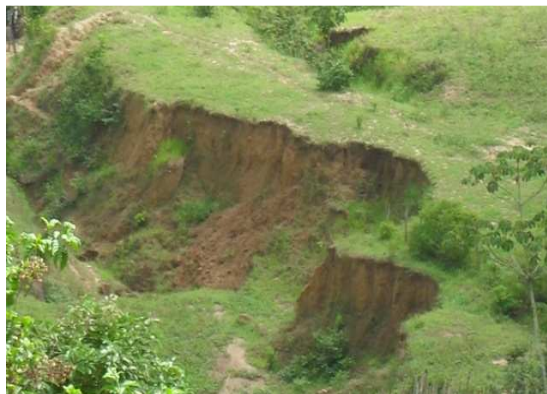
Foto 8: Detalhe da área em processo de erosão, próxima da Rua Airton Senna.
