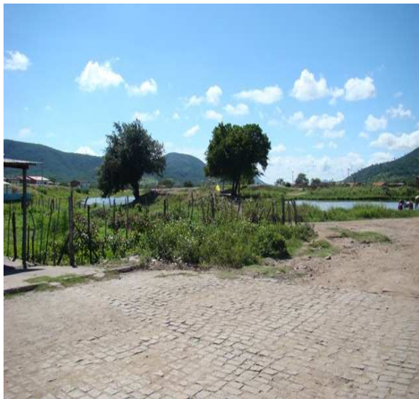
Foto 1: Local de lançamento de esgotos
