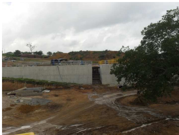
Foto 8: DAFAs em construção na nova ETE do Jacuípe
