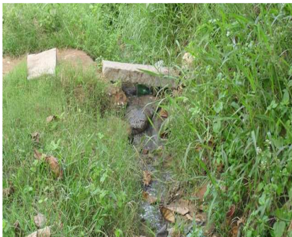
Foto 1: Área de lançamento de esgoto para o Rio Camarugipe.
