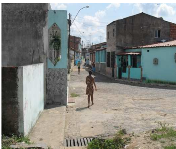
Foto 17: Área de alagamento - Caixa de drenagem.
