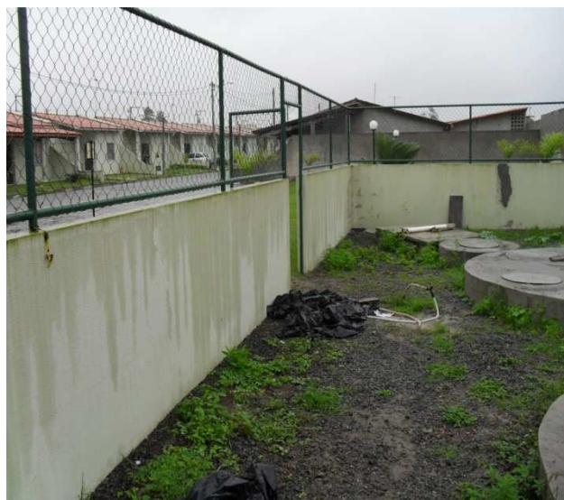
Foto 28: Vista do padrão urbano do Condomínio Parque das Azaléias.
