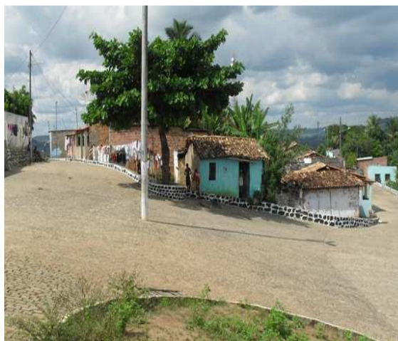
Foto 20: Ponto de escoamento em rua pavimentada.
