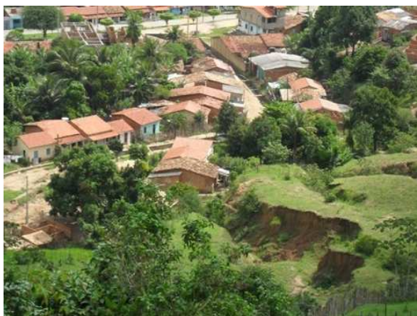
Foto 9: Área de erosão, próxima da Rua Airton Senna.
