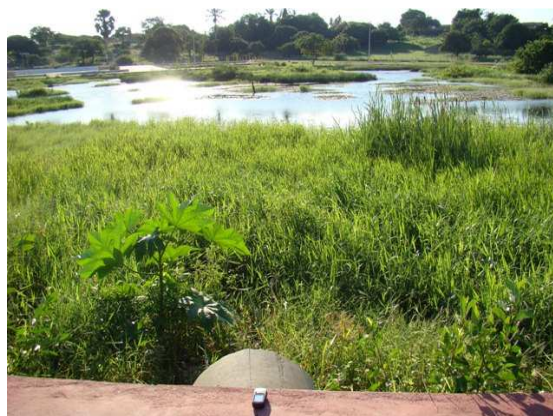
Foto 6: Final da rede de drenagem na lagoa.
