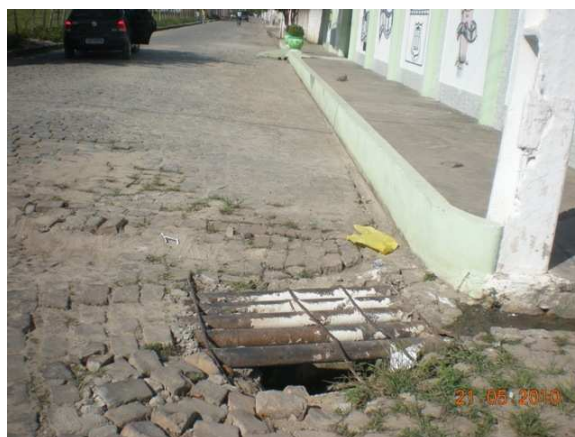
Foto 18: Rua ACM - Início da rede de drenagem início próximo da Escola de Proteção à Juventude.
