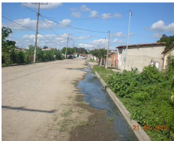
Foto 7: Rua João Pimentel - lançamento a céu aberto.
