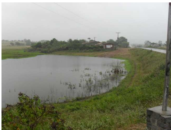
Foto 3: Açude que recebe contribuição de esgotos
