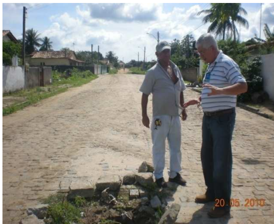
Foto 1: 2 caixas de passagens (PVs), Rua 13 de Julho – 1 caixa de DN 500mm, cruza com a Rua Isadora Magnavita – 1 caixa no início da Rua 13 de Junho - Área de alagamento.
