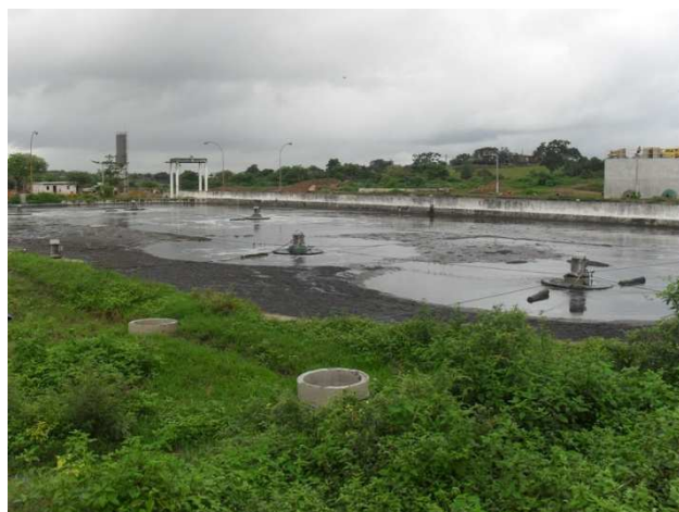
Foto 3: Lagoa aerada na ETE da Bacia do Jacuípe
