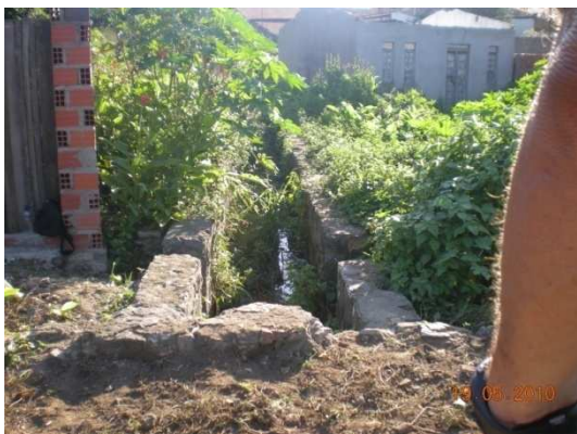
Foto 20: Trecho a céu aberto do canal que recebe as águas da Av. Castro Alves chegando a Rua Duque de Caxias, próximo da Leste.
