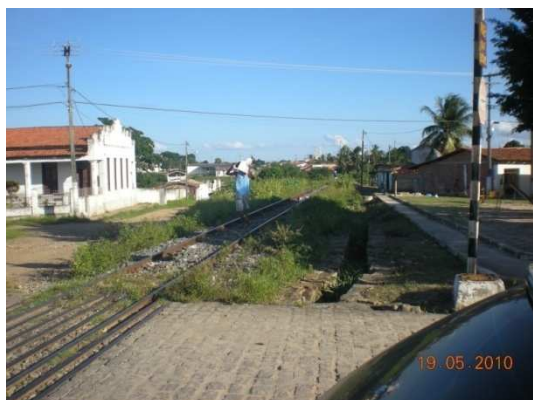
Foto 14: Trecho do canal a céu aberto que vem da Av. Castro Alves e chega a Rua Duque de Caxias.
