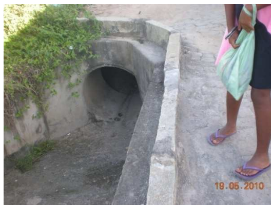
Foto 15: Bueiro da Leste com câmera de compensação.
