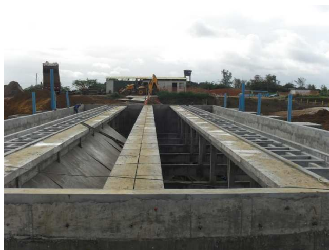
Foto 14: DAFA em construção na ETE da Bacia do Subaé
