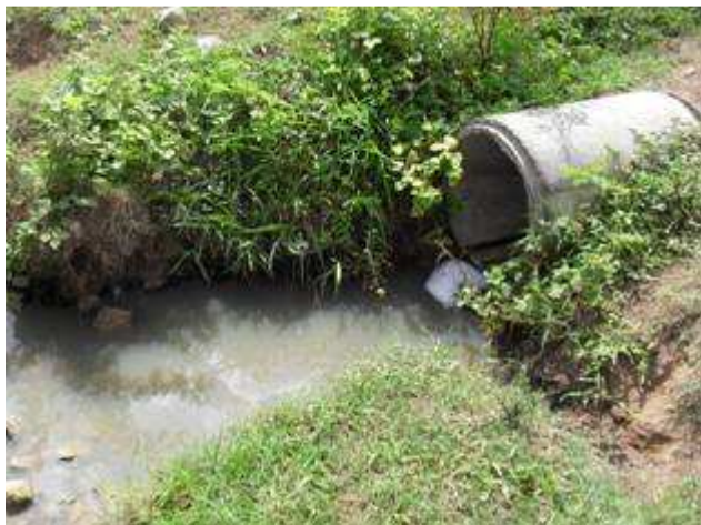
Foto 1: Ponto de lançamento da rede de drenagem próximo à rodoviária
