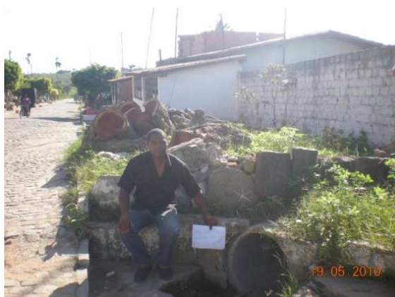
Foto 5: Rua Padre Mato Grosso. Linha de drenagem DN 800mm.
