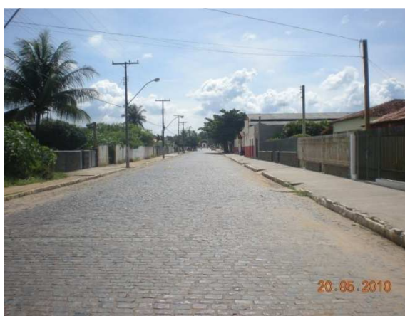
Foto 9: Área de alagamento – Rua Zulmira Chagas, Rua do Hospital cruzam com a Rua Antônio Nunes.
