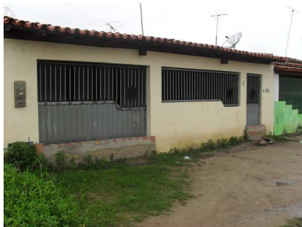
Foto 20: Área crítica em Aviários. Proteção nos portões contra invasão da água.
