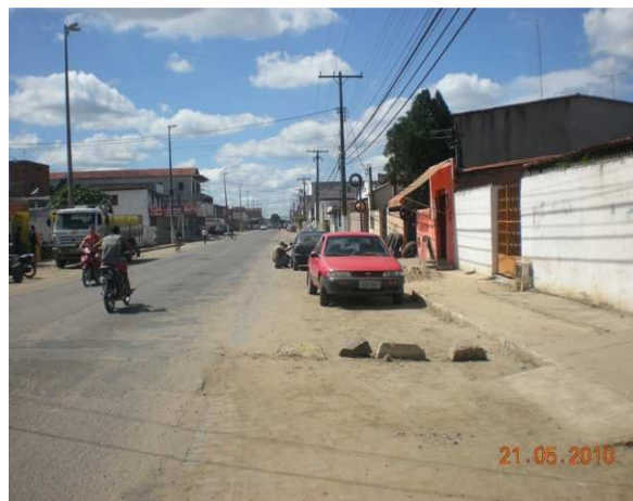
Foto 12: Área de alagamento - Próxima do Colégio Atenas.
