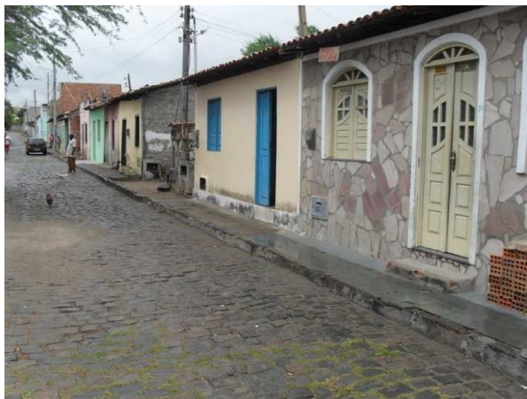
Foto 1: Área crítica - Rua Inácio Teles
