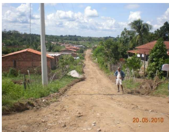
Foto 15: Vila Elsa, transversal a Rua Artur Magalhães. Área de alagamento.
