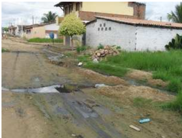
Foto 1: Bairro Terra Santa – esgotos a céu aberto sendo lançados em lagoa na margem da BR 116
