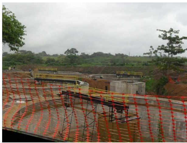
Foto 4: Decantadores em construção na ETE da Bacia do Jacuípe
