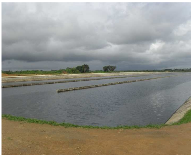
Foto 11: Lagoa de polimento na ETE da Bacia do Subaé
