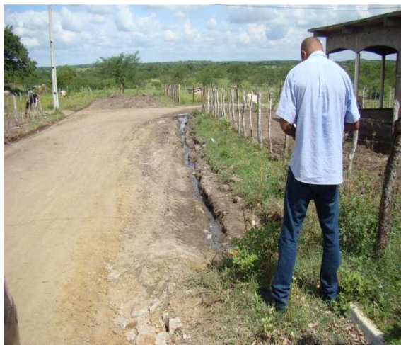
Foto 1: Rua Manoel Gonzaga de Souza – saída de esgoto a céu aberto.
