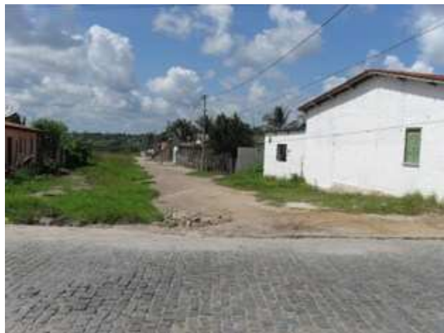
Foto 2: Av. Elísio Santana – Alagamento e enxurrada.
