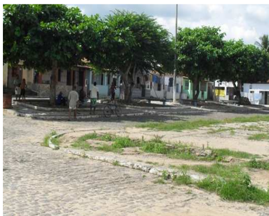
Foto 10: Largo José Américo. Área de escoamento com declividade acentuada.
