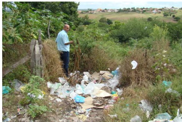
Foto 2: Saída de esgoto em terreno natural com acúmulo de lixo.
