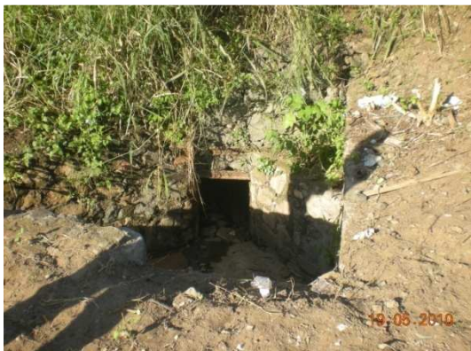
Foto 18: Trecho a céu aberto que recebe as águas da Av. Castro Alves chegando a Rua Duque de Caxias, próximo da Leste.
