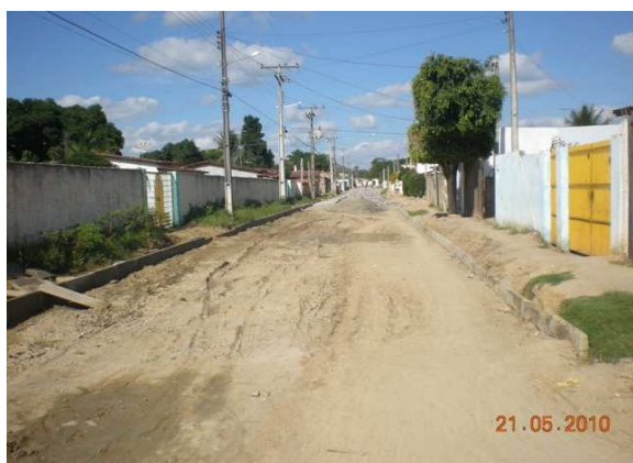
Foto 13: Área de alagamento - Av. Berimbau, trecho de alagamento rede de drenagem construída pela Caixa Econômica.
