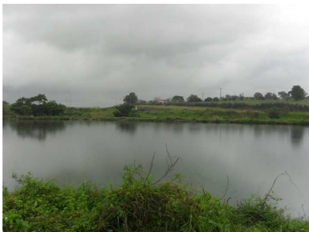
Foto 5: Lagoa de maturação na ETE da Bacia do Jacuípe
