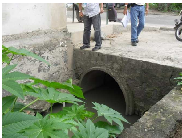
Foto 29: Bueiro no canal da Chácara da Mangabeira.
