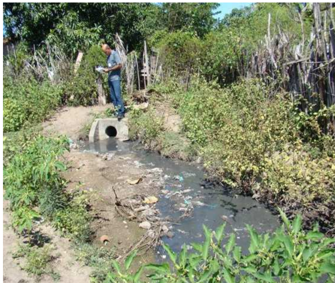
Foto 2: Ponto de lançamento de esgoto secundário
