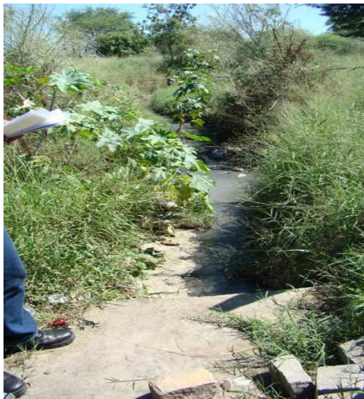
Foto 1: Ponto de descarga de esgoto e drenagem
