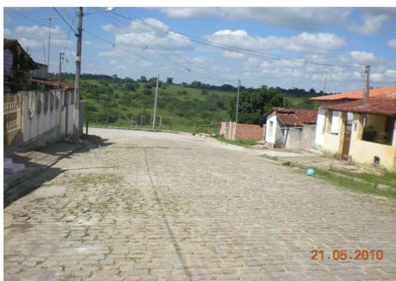
Foto 7: Rede de drenagem com início na Rua José Azevedo da Silva. Vai para o brejo.
