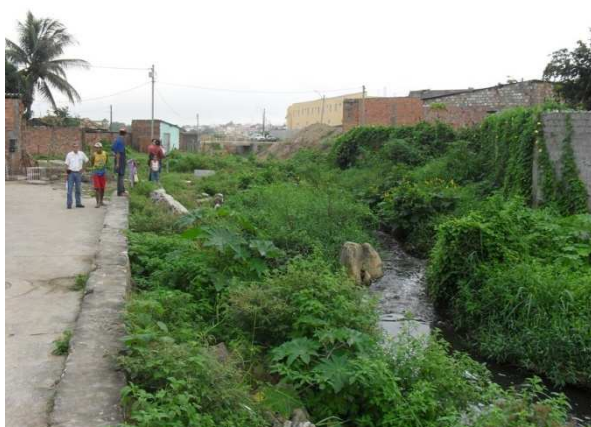
Foto 17: Área crítica no Conjunto Feira X.
