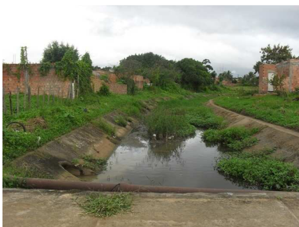
Foto 23: Canal na área crítica dos Aviários.
