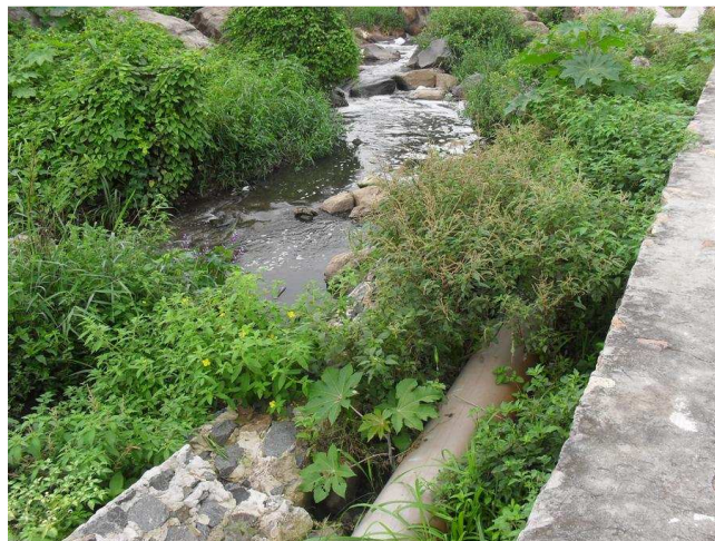
Foto 18: Interceptor de esgoto margeando canal no Bairro Feira X
