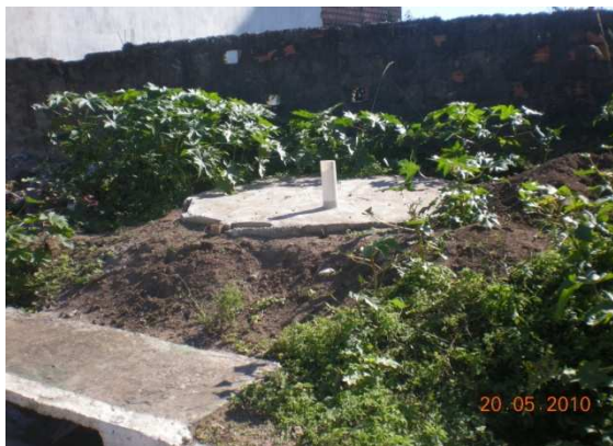
Foto 29: Linha DN 1000 mm, vem do centro e atravessa a Rua Tancredo Neves
