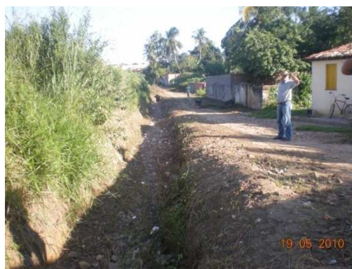
Foto 17: Trecho do canal próximo a rua da leste.
