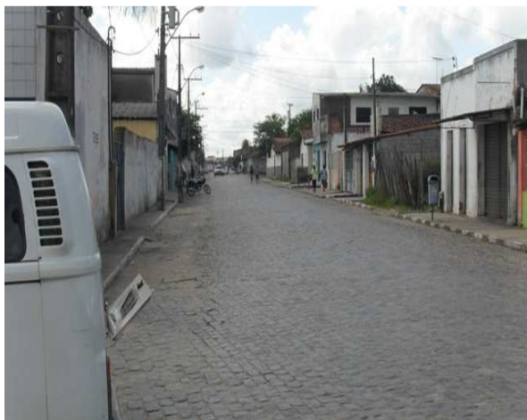
Foto 1: Av. Costa e Silva - Área de alagamento.
