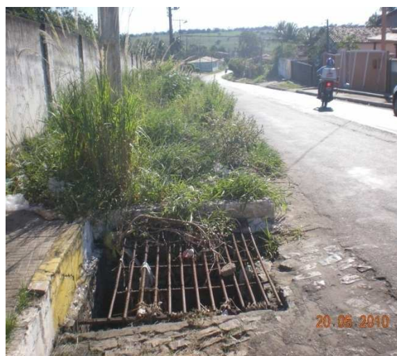
Foto 34: Caixa de drenagem - Rua Vigário Galdino.
