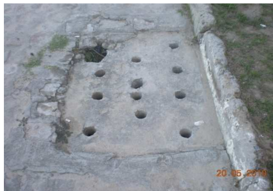
Foto 32: Detalhe da caixa de drenagem de concreto da Rua José Sarney.
