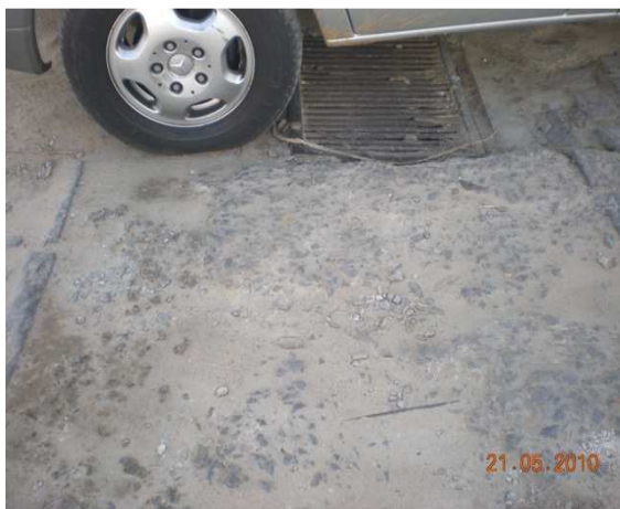
Foto 5: Praça das Palmeiras - grelha horizontal
