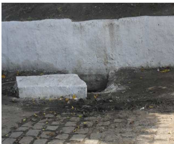
Foto 3: Bueiro. Passagem sob a BR-324 - próximo ao Rei da Pamonha.
