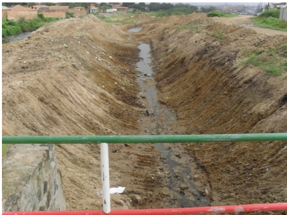
Foto 19: Canal escavado recentemente paralelo ao curso d'água existente como tentativa de solucionar os alagamentos no Feira X
