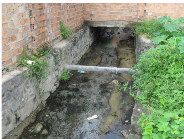
Foto 15: Canal no Feira X com construções sobre ele
