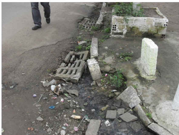
Foto 31: Dispositivos de microdrenagem danificados no Sobradinho
