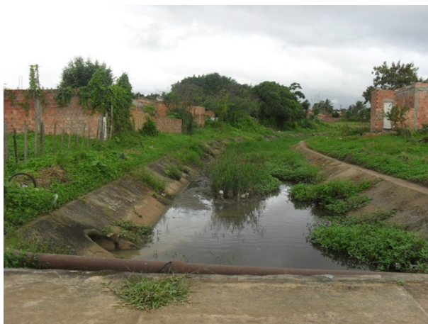
Foto 23: Canal na área crítica dos Aviários
