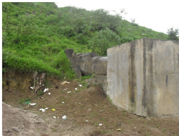
Foto 32: Bueiro sob anel rodoviário no Sobradinho
