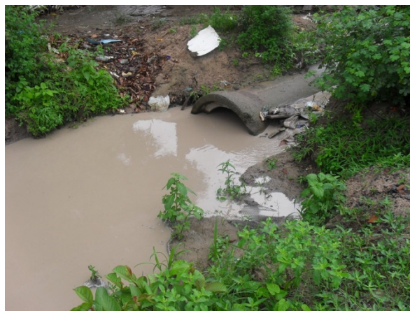
Foto 4: Bueiro no acesso para o Aviário
