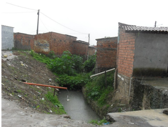
Foto 7: Canal no Feira VII com lançamento difuso e casas construídas na beira do canal em área crítica
