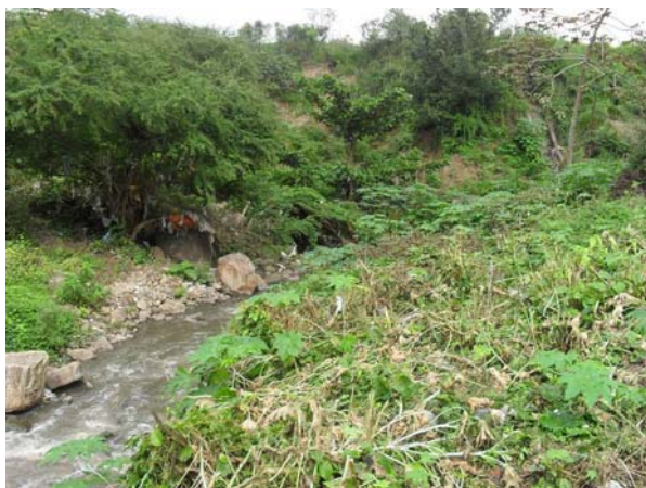
Foto 37: Trecho sem revestimento do canal do Feira X
