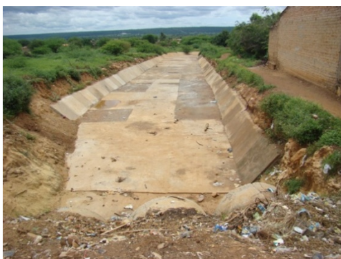
Foto 5: Vista do Canal. (Registro fotográfico F em planta)
