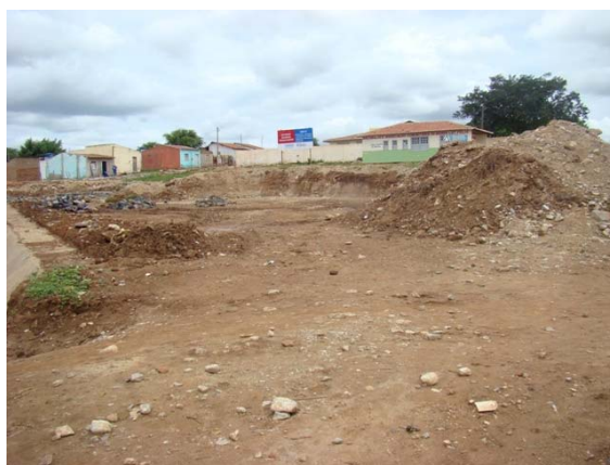
Foto 10: Praça em construção e fundo da Escola Felix.
