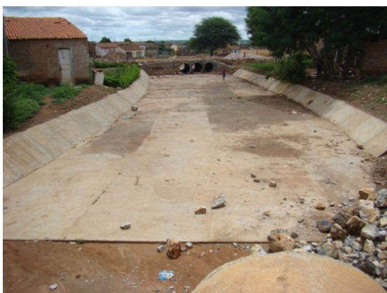
Foto 11: Saída do último conjunto de manilhas e final do Canal de Drenagem. (Registro fotográfico B em planta)
