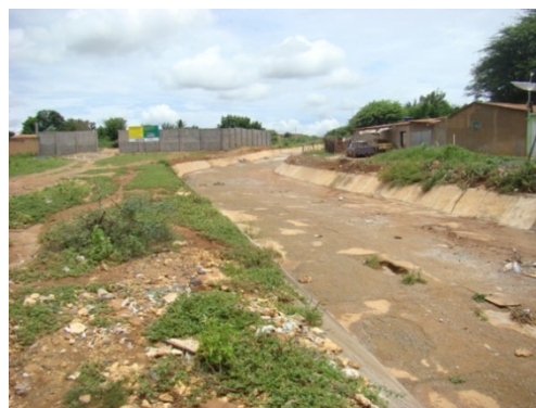
Foto 4: Vista do Canal.. (Registro fotográfico G em planta)
