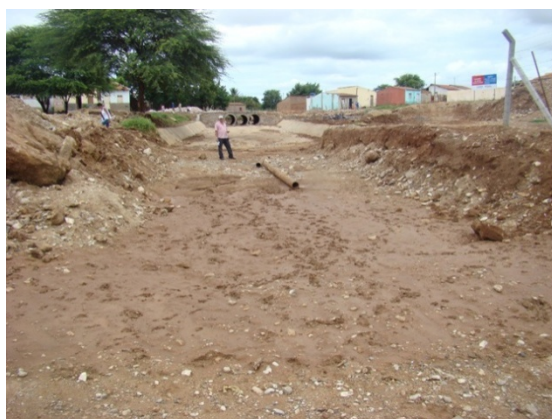
Foto 12: Vista do Canal ao fundo da Escola Felix. (Registro fotográfico D em planta)
