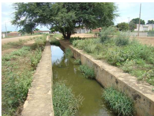
Foto 7: Canal de macrodrenagem
