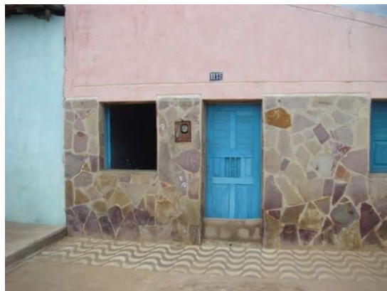
Foto 2: Área de alagamento – Bairro Ponta da Ilha
