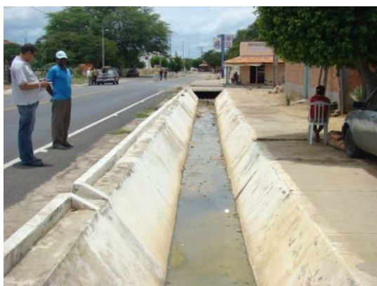
Foto 5: Canal de macrodrenagem
