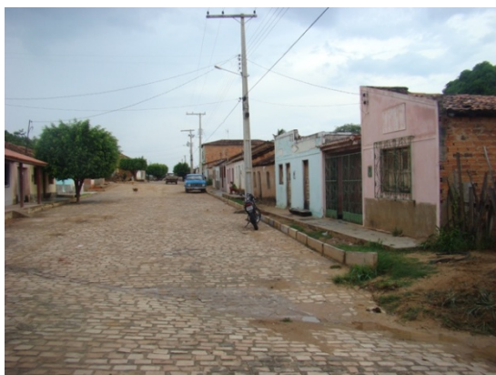
Foto 3: Rua pavimentada com material carreado.
