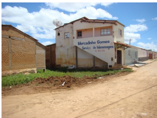
Foto 5: Marca da inundação ocorrida antes do pontilhão da Rua Nelson Damasceno.
