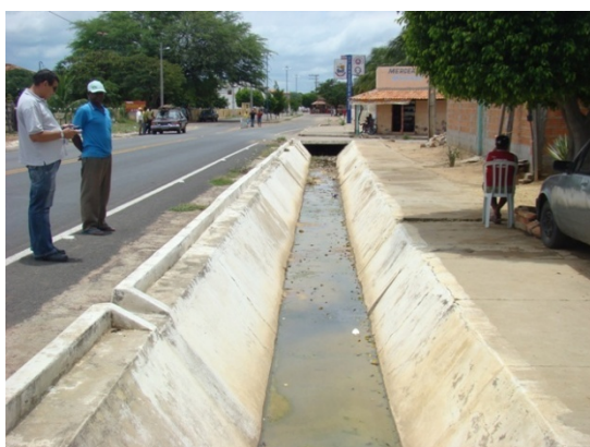
Foto 5: Canal de macrodrenagem
