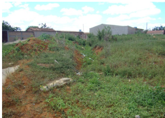
Foto 2: Vala de escoamento na Lagoa de Lucemar.
