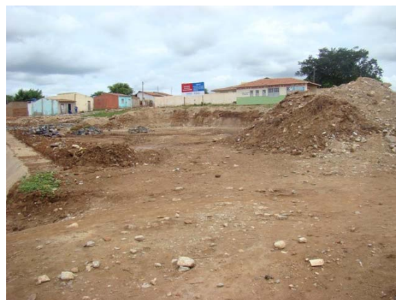
Foto 10: Praça em construção e fundo da Escola Felix.
