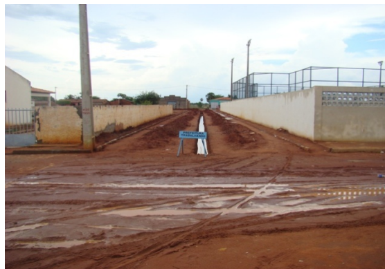
Foto 2: Obra de tubulação de drenagem pluvial
