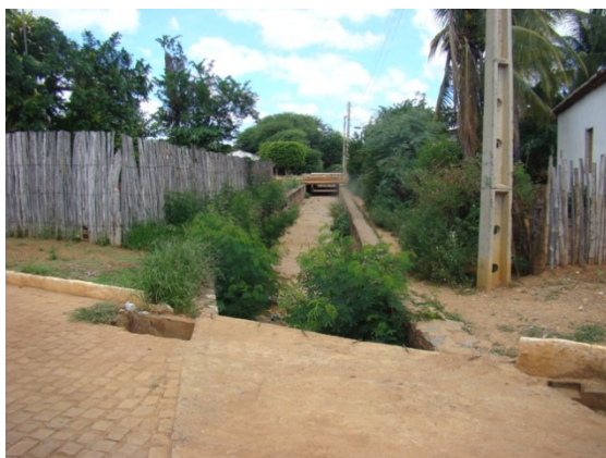
Foto 3: Ponto de descarga na Baixão Rua da União – 2ª macro drenagem.
