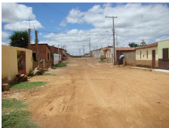
Foto 5: Rua sem pavimentação.
