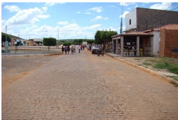
Foto 7: Vista da Praça Teotônio M. Dourado.
