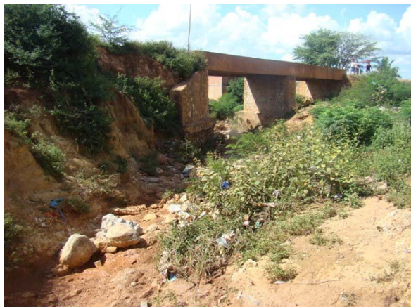
Foto 1: Vista da drenagem a montante da ponte na BA Canarana / Barro Alto.
