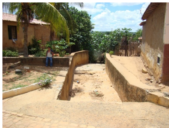
Foto 4: Ponto de descarga na Baixão Rua da União – 2ª macro drenagem.
