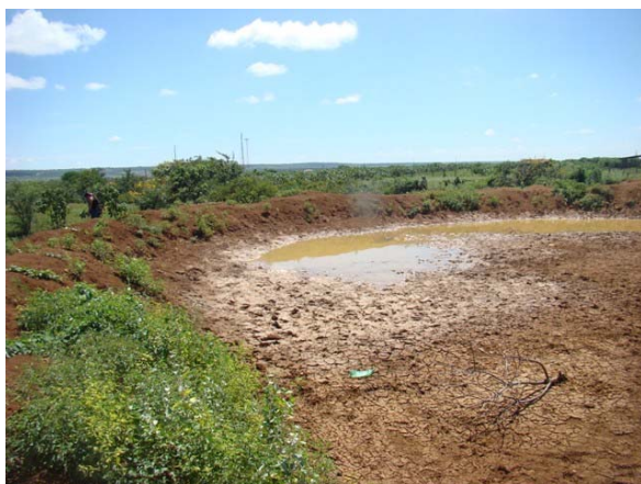
Foto 7: Lagoa de contenção executada pela Prefeitura.
