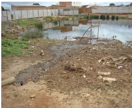
Foto: Vista de pasto com chegada de microdrenagem e esgoto a céu aberto.
