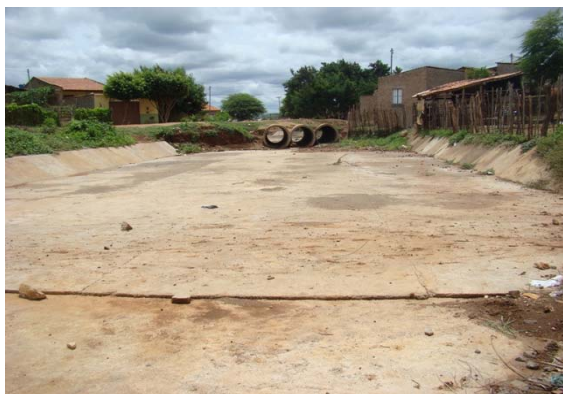
Fotos 13: Vista do Canal.
