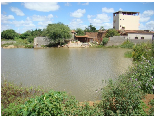
Foto 3: Muro destruído na Lagoa de Ferreira.
