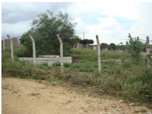
Foto: Estação de tratamento de esgotos (DAFA)
