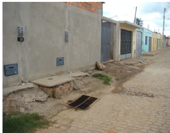
Foto 2: Reservatório 5 na Rua Vital Silva Dourado.
