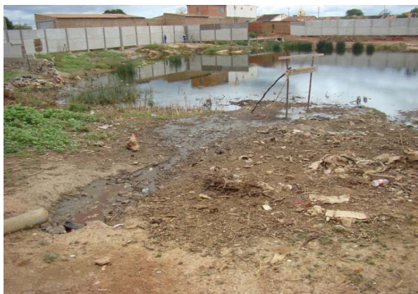
Foto 9: Vista do Reservatório 2 com chegada de esgoto.
