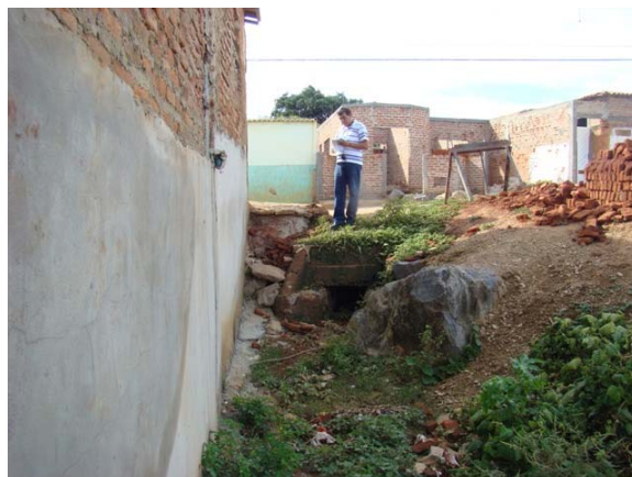
Foto 4: Vista do bueiro.
