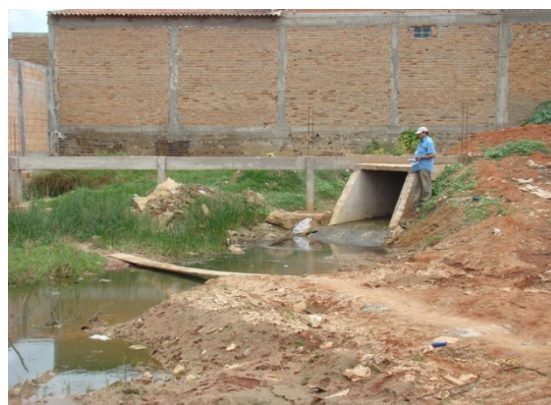
Foto 6: Vista da chegada da galeria no Reservatório 2.
