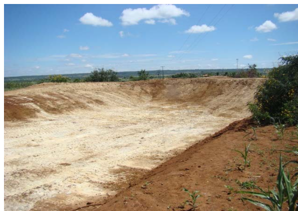
Foto 6: Lagoa de contenção executada pela Prefeitura.
