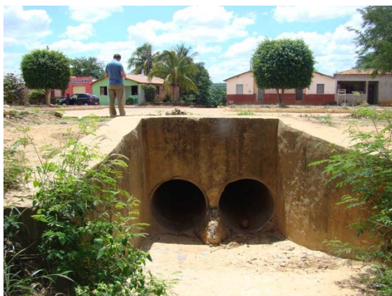
Foto 5: Início da 1ª macro drenagem na Rua Jonas Pereira.
