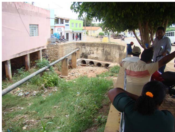
Foto 2: Drenagem por baixo das casas – rua entrada da cidade.
