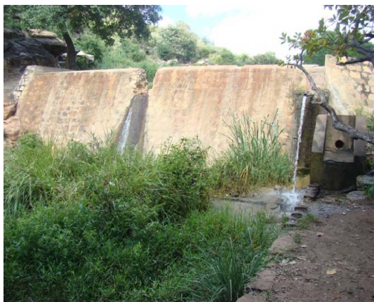
Foto 5: Barragem acima do Balneário.
