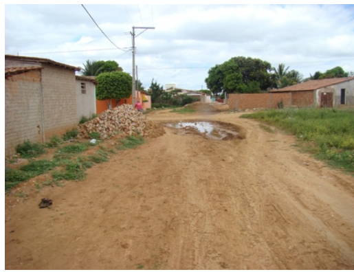
Foto 4: Rua sem pavimentação com ponto de alagamento.
