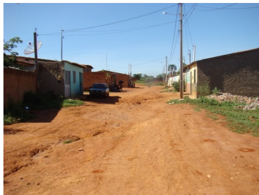
Foto 2: Rua sem pavimento
