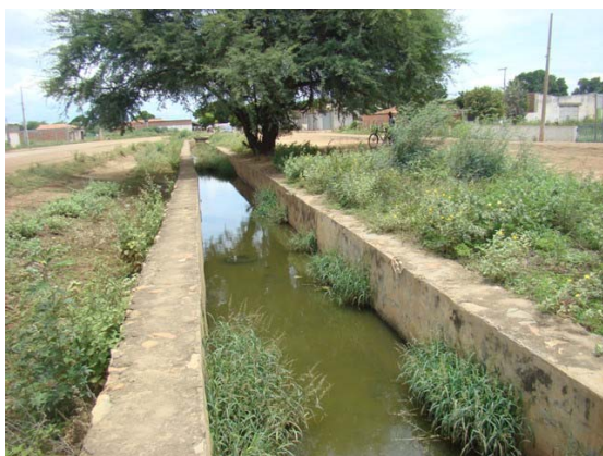
Foto 7: Canal de macrodrenagem
