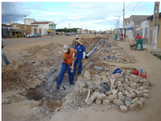
Foto 1: Vala aberta com linha de recalque em assentamento.
