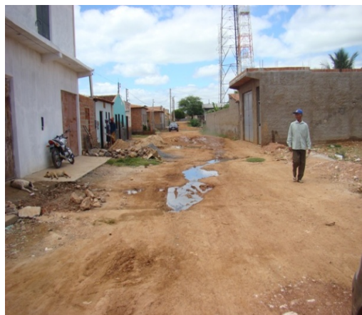
Foto 8: Rua com ponto de alagamento.
