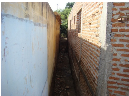
Foto 3: passagem de água vindo do Lago do Bembá entre as casas.
