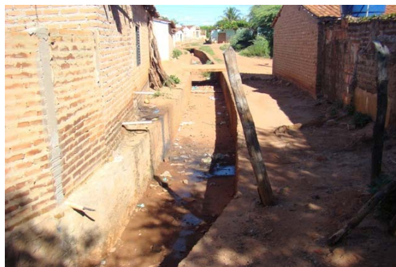
Foto 2: Canal 2 – Vista da rua montante.
