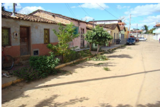
Foto 9: Rua do Poço - Área Crítica
