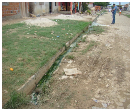
Foto 2: Esgoto secundário escoando pela sarjeta
