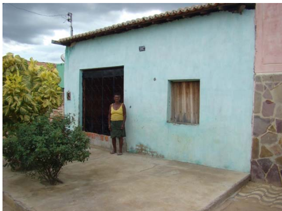
Foto 1: Área de alagamento – Bairro Ponta da Ilha
