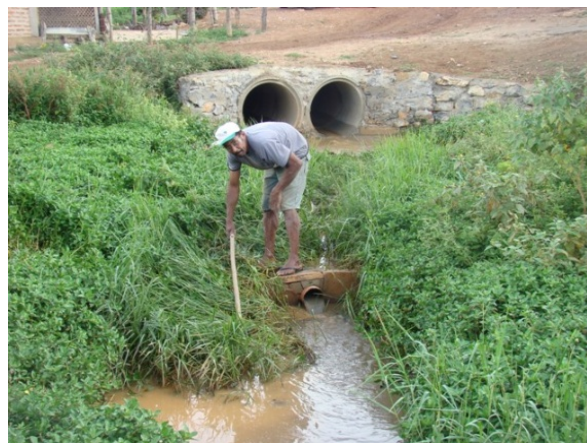
Foto 2: Tubo com 150 mm - saída do DAFA no Bairro Lagoa do Tió.
