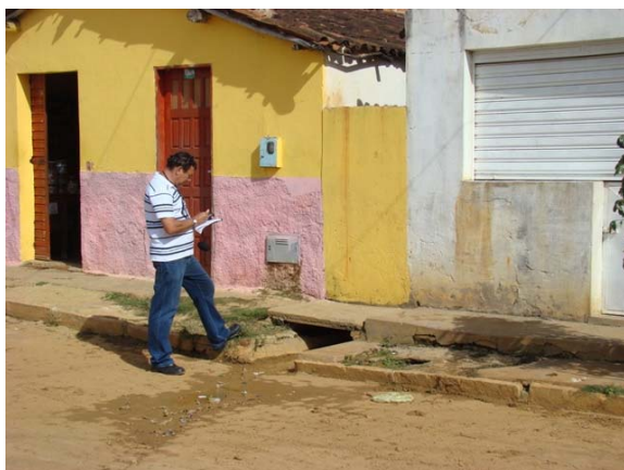
Foto 5: Bueiro de ligação entre a rua e a passagem entre as casas.
