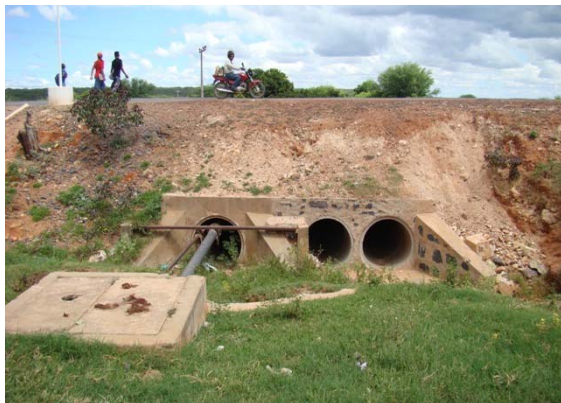
Foto 1: Vista do bueiro que cruza a BA-052 no Bairro Nova América - passagem das águas da Área Crítica 2 em direção ao Rio Romão Gramacho.
