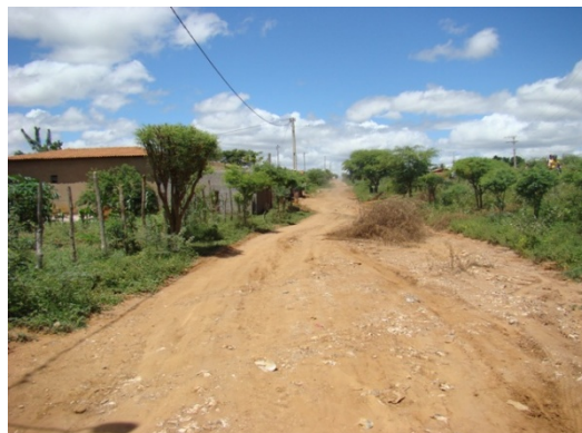
Foto 4: Rua a ser calçada com micro drenagem. Paralela a estrada de acesso a Mirodos.
