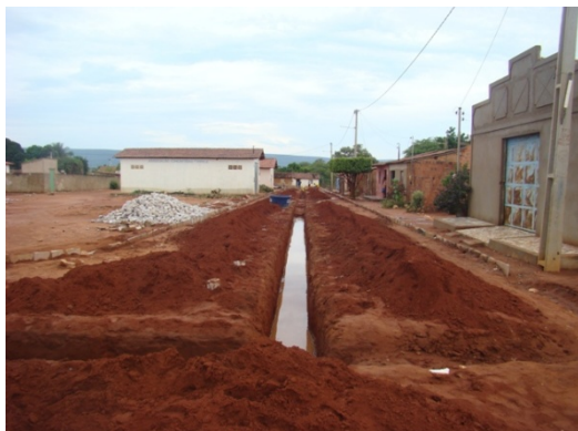
Foto 1: Obra de tubulação de drenagem pluvial
