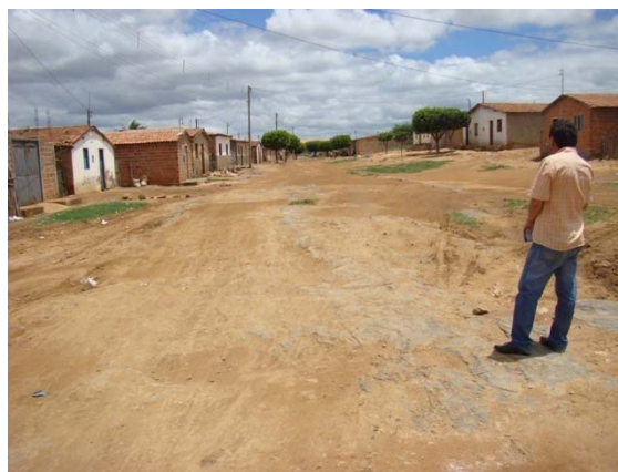
Foto 6: Rua com afloramento de rocha.
