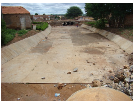
Foto 11: Saída do último conjunto de manilhas e final do Canal de Drenagem.
