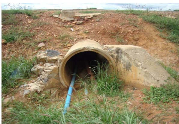
Foto 1: Vala aberta com linha de recalque em assentamento.
