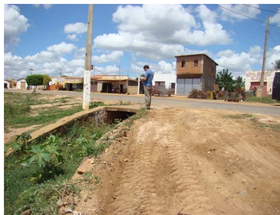
Foto 8: Início da 3ª macro drenagem na Rua Olívio Alegria.
