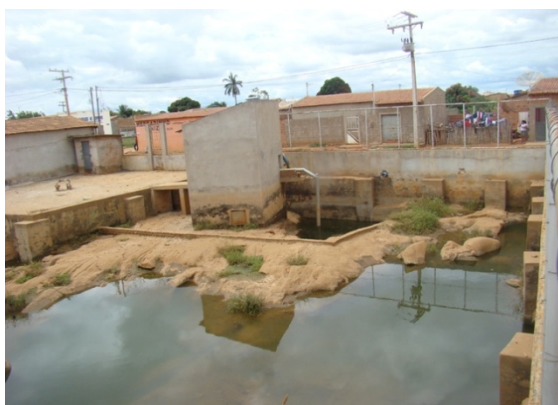
Foto 5: Vista do Reservatório 3 na esquina da Rua União com a Rua Canaã.
