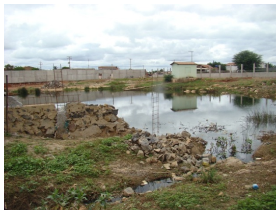
Foto 8: Vista do Reservatório 2 com casa de bomba.
