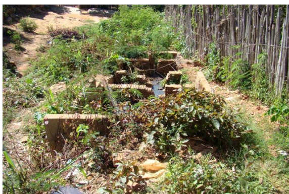
Foto 3: Vista da caixa de esgoto na Rua Almerindo Portugal.
