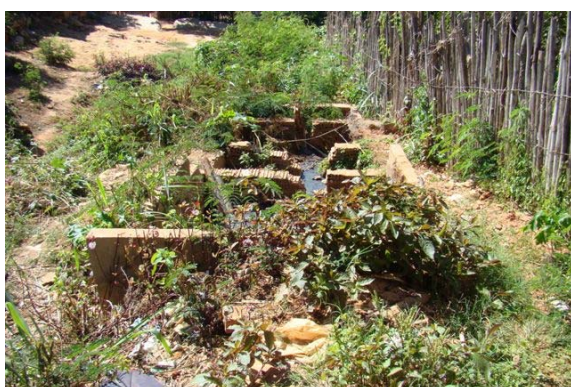
Foto 5: Vista da caixa de esgoto na Rua Almerindo Portugal.
