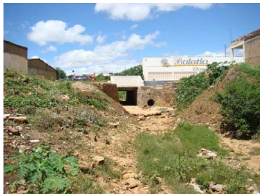
Foto 2: Pontilhão sobre o Riacho do Corte na Rua Nelson Damasceno.
