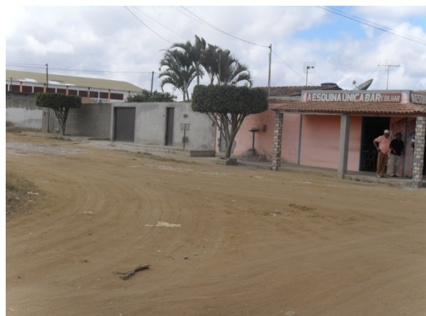
Foto 14: Travessa Senhor do Bonfim, trecho próximo ao campo de futebol. Área crítica por conta da ocorrência de alagamento. Área crítica 1.
