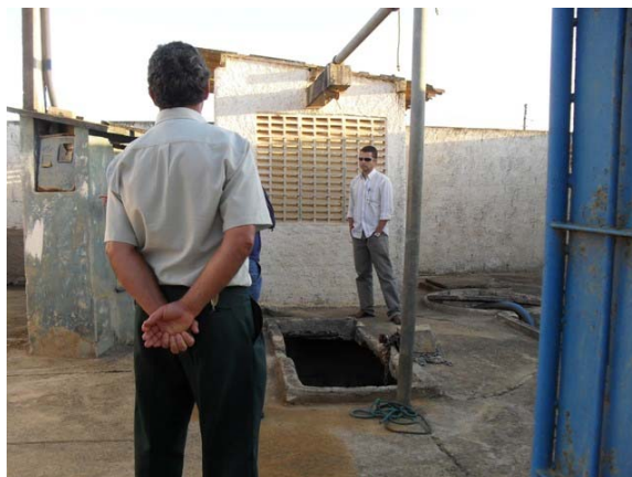
Foto 2: Estação Elevatória de Esgoto Urbis 6 que será desativada após o término das obras em curso.
