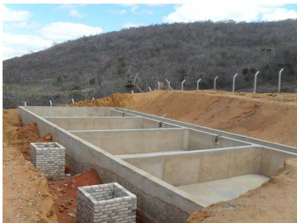
Foto 3: ETE EMBASA – em construção.
