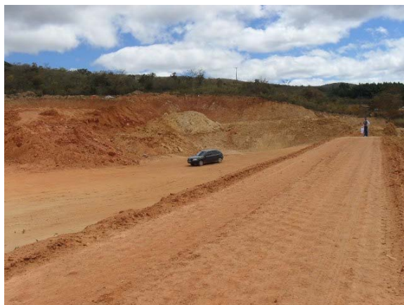
Foto 2: Estação de tratamento de esgotos em construção
