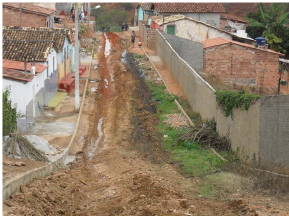
Foto 1: Rua Cassimiro Lima – obra de implantação da rede de drenagem.
