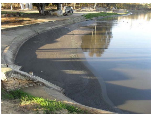
Foto 15: Lagoa Facultativa da Estação de Tratamento de Esgoto.
