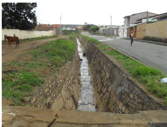
Foto 16: Canal 4 – Continuação do trecho em canal aberto revestido em alvenaria de pedra.
