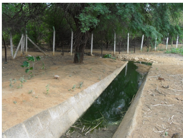
Foto 3: Trecho final do canal de macrodrenagem que passa dentro da área da ETE recebe o efluente tratado.
