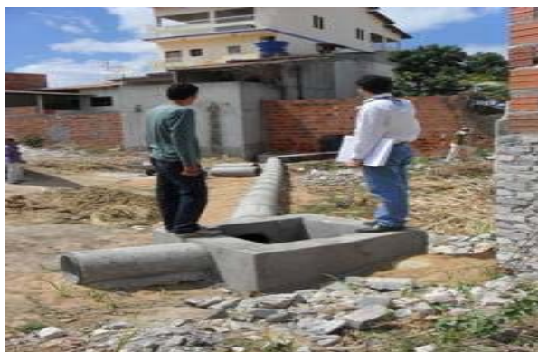
Foto 6: Rede de microdrenagem em construção que termina no baixio
