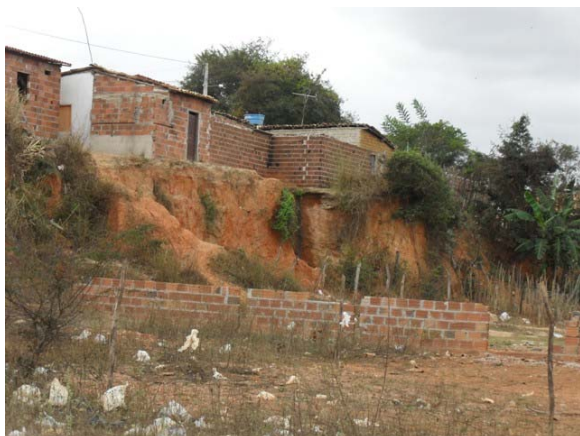
Foto 7: Conjunto Habitacional – Fossa com sumidouro (100%).
