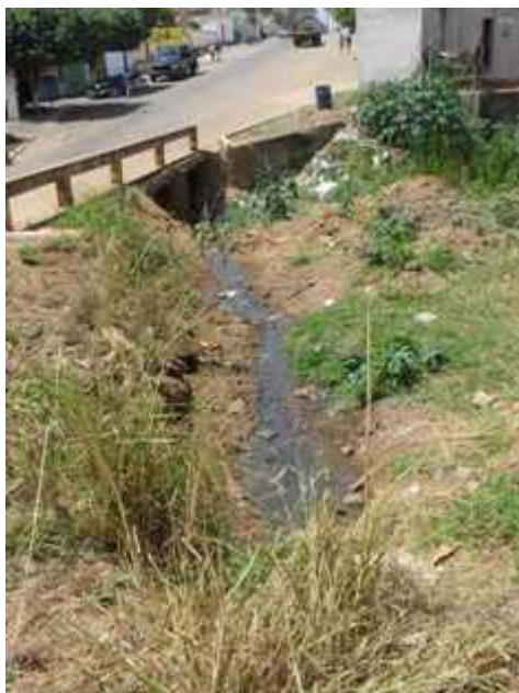
Foto 5: Lançamento de esgoto no córrego do sangradouro da barragem
