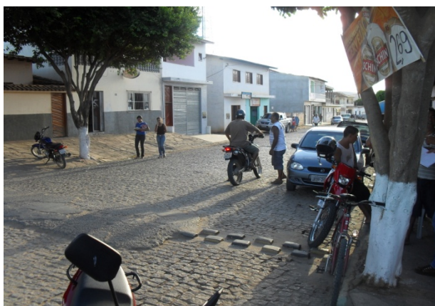
Foto 3: Cruzamento da rua Professora Lúcia com a Avenida Oliveira Brito. Área crítica por conta da ocorrência de alagamento provocado pela enxurrada. Área crítica 1.
