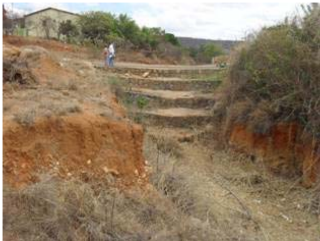
Foto 5: Vertedouro da barragem do Zé Ferrugem
