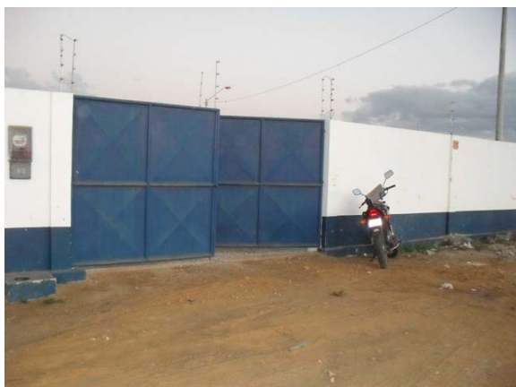
Foto 11: Entrada da Estação Elevatória de Esgoto Santa Cruz operada pela Embasa.
