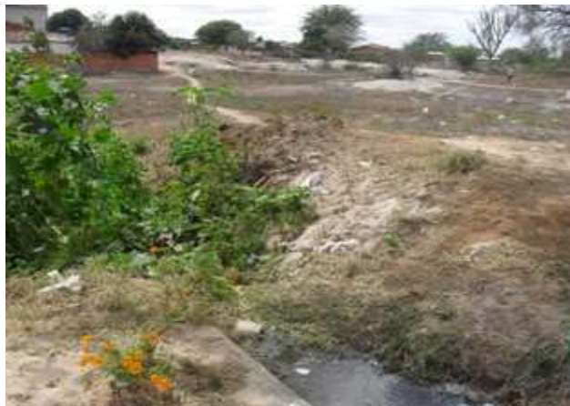
Foto 2: Local de extravazamento da lagoa
