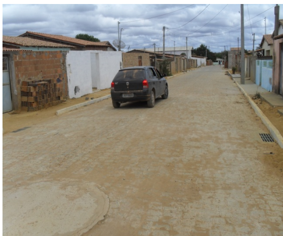
Foto 3: Rua Noruega. Drenagem superficial e galerias enterradas recentemente implantadas.
