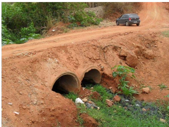
Foto 7: Córrego Parque Vaquejada – bueiro sob estrada.
