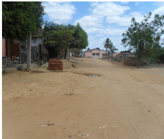
Foto 2: Rua Naomar Alcantara. Rua sem pavimentação que recebe grande contribuição superficial e apresenta problemas com erosão.
