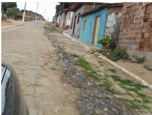
Foto 3: Lançamento de esgoto a céu aberto.
