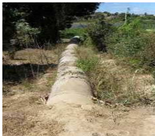
Foto 6: Galeria que termina na lagoa
