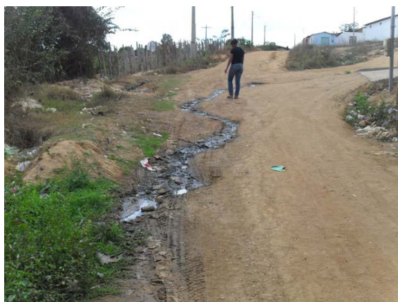
Foto 6: Bairro Casinhas Populares – lançamento de esgoto a céu aberto.
