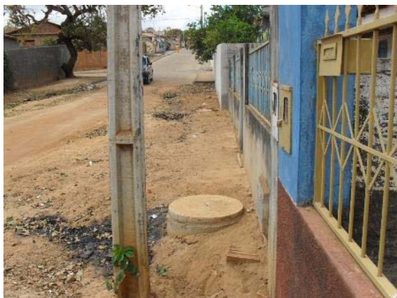
Foto 1: Rua com rede de esgoto construída. Vista da caixa de ligação domiciliar
