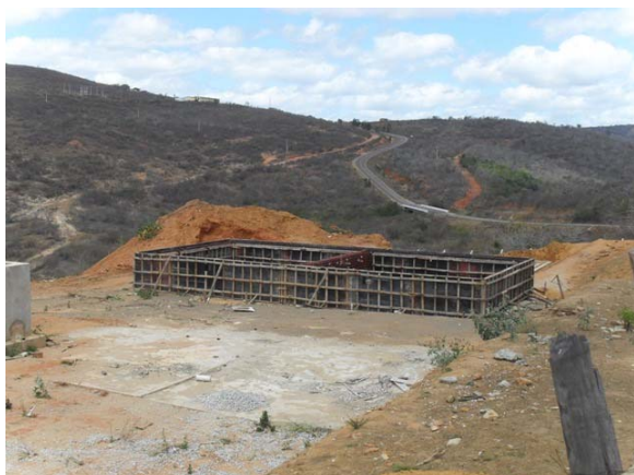
Foto 1: ETE EMBASA – em construção.
