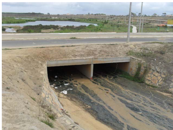
Foto 8: Canal 3 - Final do canal aberto revestido em alvenaria de pedra com deságüe na Lagoa das Bateias.
