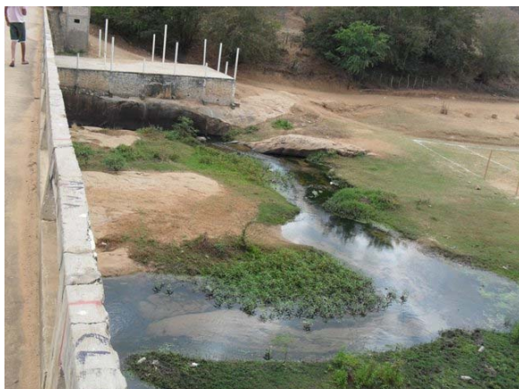
Foto 7: Unidade de tratamento com funcionamento precário – ponte velha do Rio Gavião.
