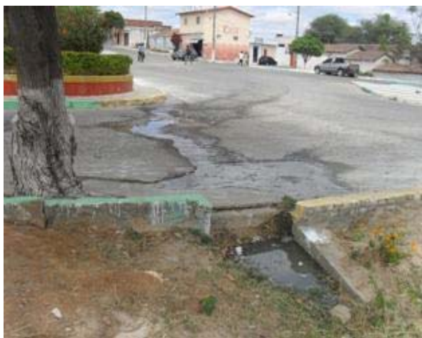
Foto 3: Esgoto secundário lançado a céu aberto correndo pelas sarjetas
