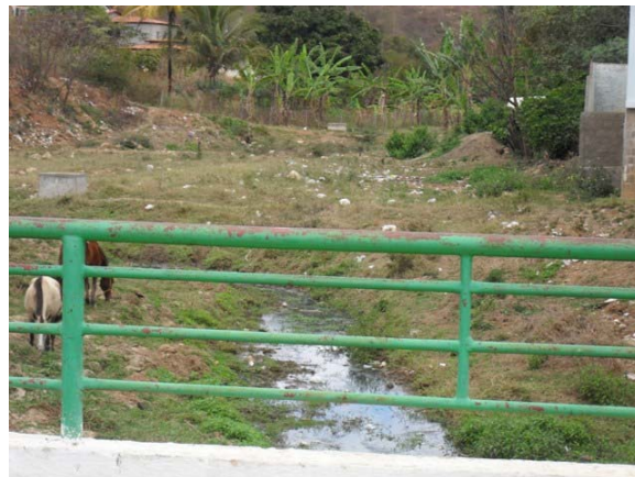
Foto 2: Rua Coronel Raimundo Cordeiro – ponte sobre o Riacho Água Preta.
