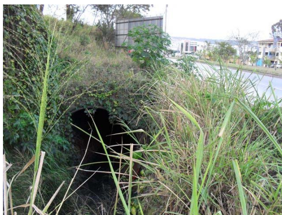
Foto 34: Canal 11 – Travessia em armco sob a Avenida Bartolomeu Gusmão.
