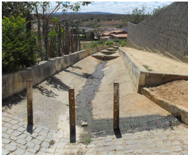
Foto 1: Rua Manaus. Início do canal de macrodrenagem de seção retangular aproximada de 3 m X 0,6 m.
