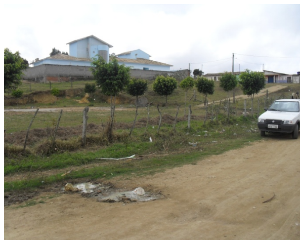
Foto 8: Rua Poções. Rua sem pavimento sem uma definição de greide favorece o acúmulo de água na região devido à falta de condição natural de escoamento.
