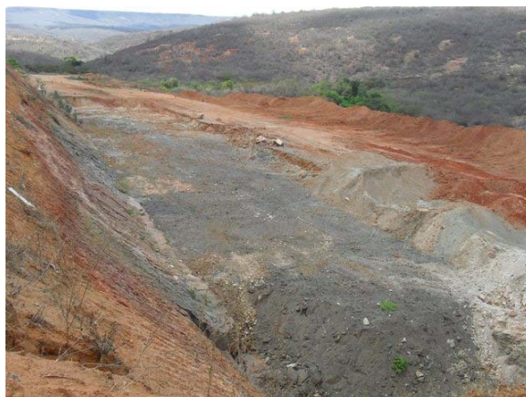
Foto 2: ETE EMBASA – em construção.
