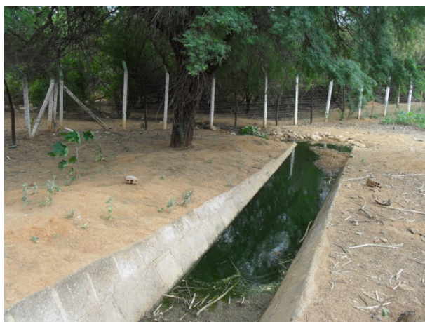
Foto 7: Aspecto final do efluente após a realização do tratamento. Efluente que sai da lagoa facultativa é lançado no canal de drenagem que protege a ETE.
