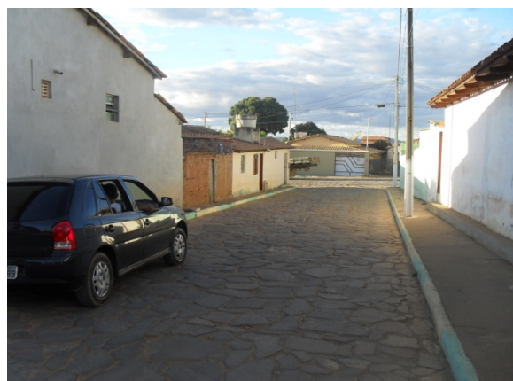
Foto 4: Vista da rua Zé Vermelho. As águas pluviais escoam que escoam livremente pelas ruas provocam problemas do cruzamento da rua Professora Lúcia com a Avenida Oliveira Brito até esta rua. Algumas residências colocaram batente na entrada de suas casas para conter a invasão das águas pluviais.
