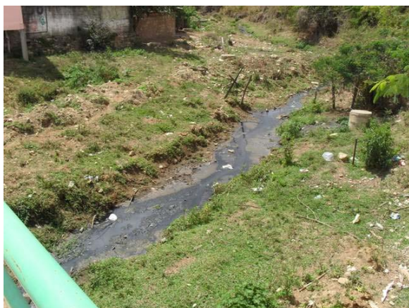
Foto 3: Rua Coronel Raimundo Cordeiro – ponte sobre o Riacho Água Preta.
