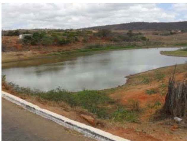
Foto 3: Barragem do Zé Ferrugem, para onde escoam parte das águas pluviais da cidade
