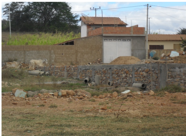
Foto 1: Bairro Horizonte Azul. Bairro novo onde está iniciando uma obra pequena obra de drenagem.
