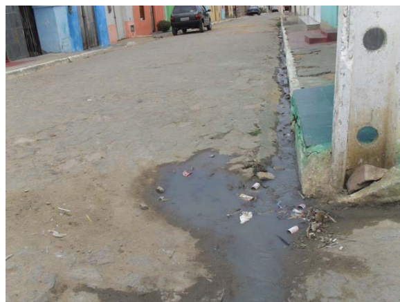
Foto 4: Lançamento de esgoto a céu aberto.
