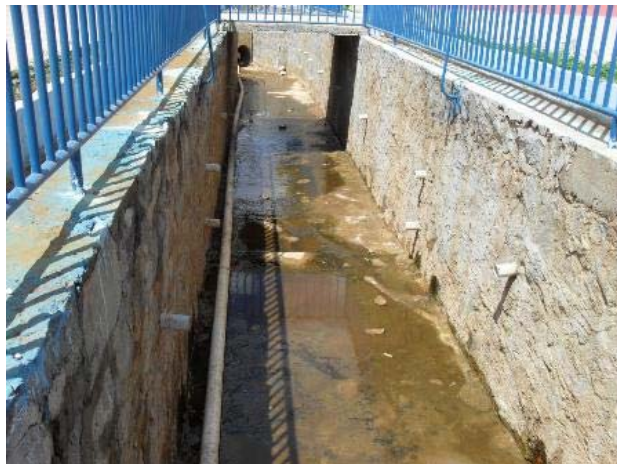
Foto 2: Canal revestido que recebe contribuição de esgotos
