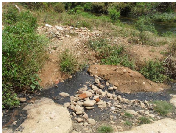
Foto 10: Rua da Fonte - lançamento direto de esgoto em direção ao Rio Gavião.
