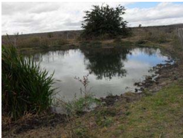
Foto 3: Lagoa de estabilização. Trata o esgoto de uma pequena porção da cidade
