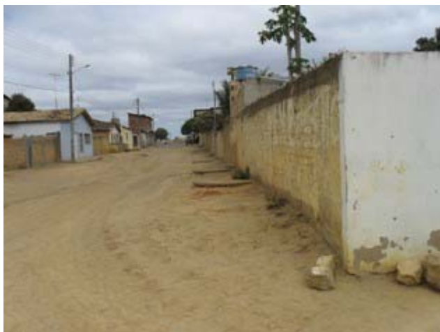
Foto 1: Fossas absorventes nas ruas. Prática comum na cidade
