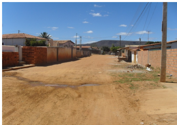
Foto 4: Rua XV de Novembro. Área crítica por conta da ocorrência de chuvas de enxurrada. Área crítica 1.
