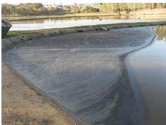
Foto 17: Lagoa de maturação da Estação de Tratamento de Esgoto.
