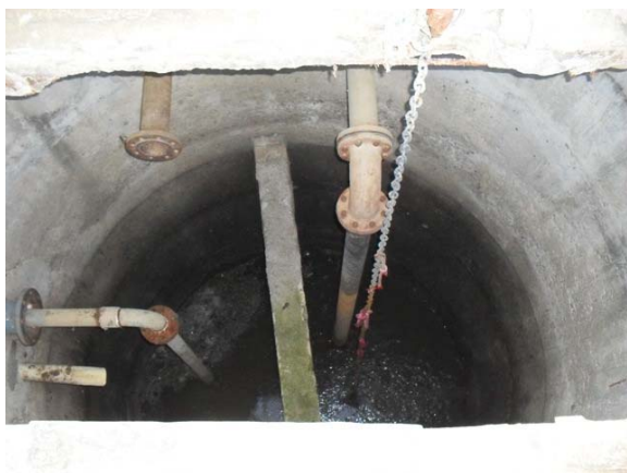
Foto 3: Poço de sucção da Estação Elevatória de Esgoto Urbis 6 com elevada profundidade.
