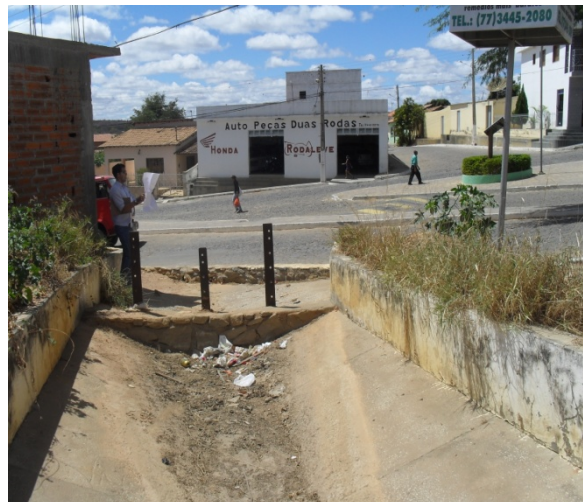
Foto 2: Final do canal de macrodrenagem de revestimento de concreto que se inicia na rua Amazonas e desemboca em frente a praça Nossa Senhora Aparecida.
