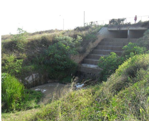
Foto 41: Canal 16 - Final do trecho aberto revestido em concreto com deságüe na Lagoa da Bateia.
