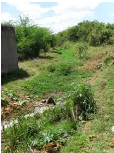
Foto 3: Córrego transportando esgotos
