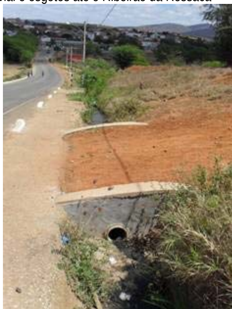
Foto 11: Valeta que transporta águas pluviais e esgotos secundários ao Ribeirão da Ressaca
