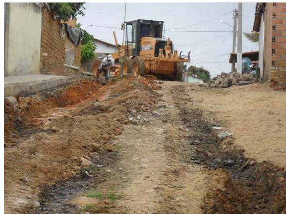
Foto 2: Rua Cassimiro Lima – obra de implantação da rede de drenagem.
