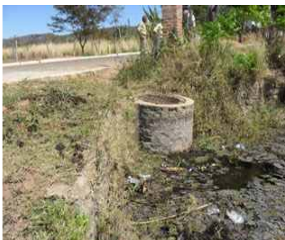
Foto 3: Extravasor da lagoa
