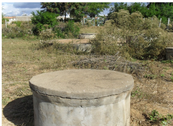
Foto 3: Visão geral da estação de tratamento de esgoto construída em 1997 e atualmente abandonada.
