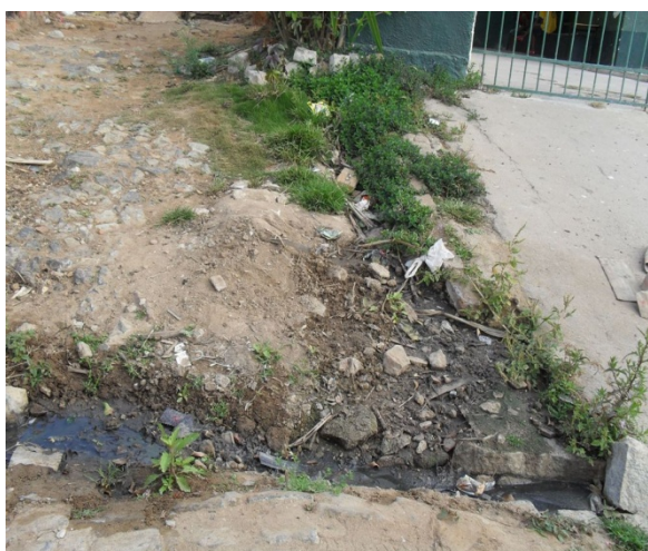
Foto 3: Lançamento de esgoto a céu aberto.
