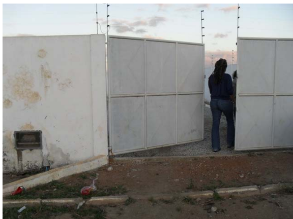
Foto 7: Entrada da Estação Elevatória de Esgoto Alegria operada pela Embasa.
