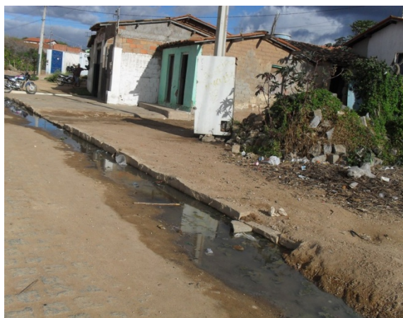
Foto 6: Lançamento de esgoto a céu aberto.
