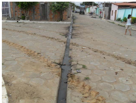
Foto 2: Travessa Aclamação – canaleta de esgoto.
