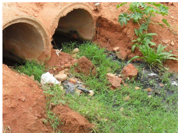
Foto 8: Córrego Parque Vaquejada – bueiro sob estrada.
