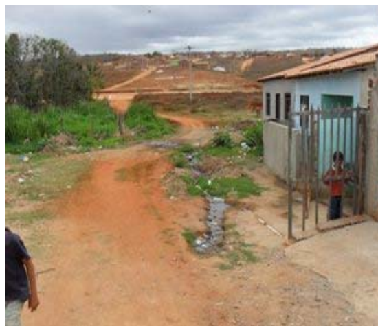
Foto 4: Esgoto correndo a céu aberto em direção a Riacho devido a problemas na rede
