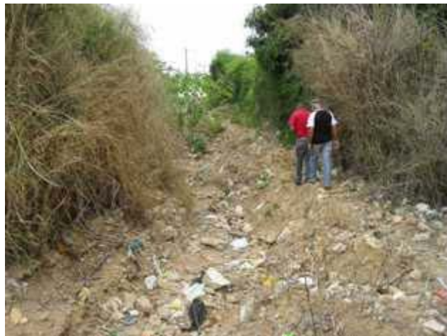
Foto 2: Área crítica 1, erosão no final da rua Lauro Flores
