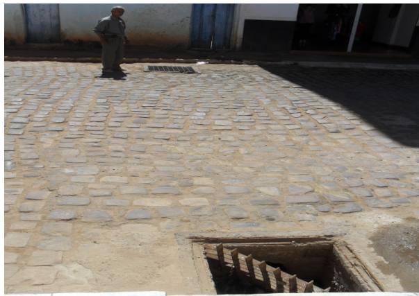
Foto 1: Rua Cleriston Andrade. Dispositivos de drenagem existentes do pequeno trecho de rede de microdrenagem existente
