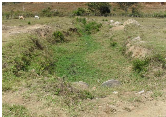
Foto 6: Final da Av. Orlando Fontes – ponto de lançamento de água pluvial.
