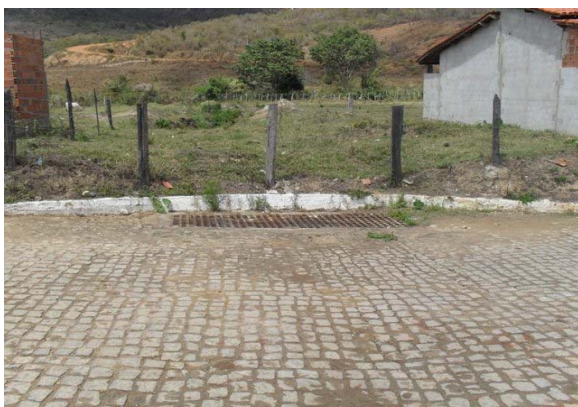
Foto 5: Final da Av. Orlando Fontes – ponto de lançamento de água pluvial
