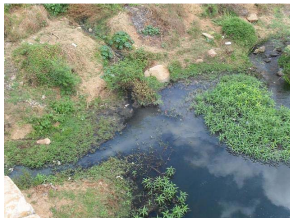
Foto 8: Unidade de tratamento com funcionamento precário – ponte velha do Rio Gavião.
