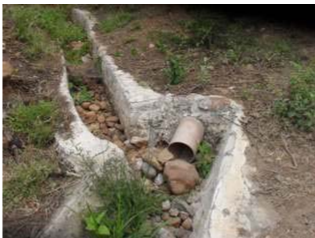
Foto 7: Ponto de lançamento do efluente da ETE
