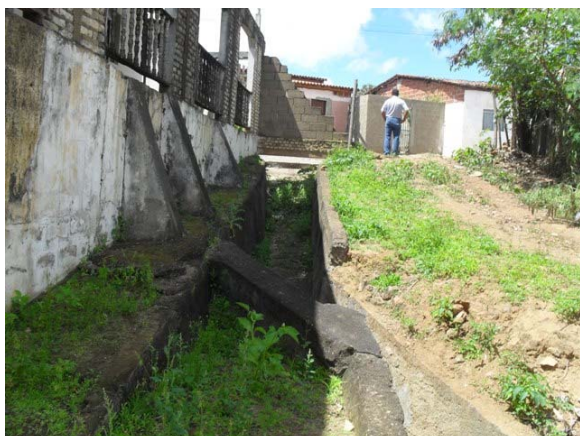
Foto 5: Av. Vitória da Conquista – acesso à drenagem.
