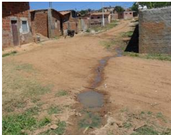
Foto 2: Área crítica 1, com esgoto escoando a céu aberto
