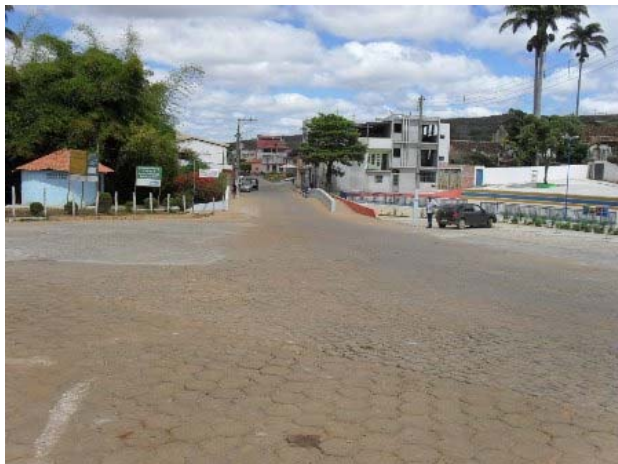
Foto 1: Área crítica 1. Enxurrada na Rua Santos Drummond
