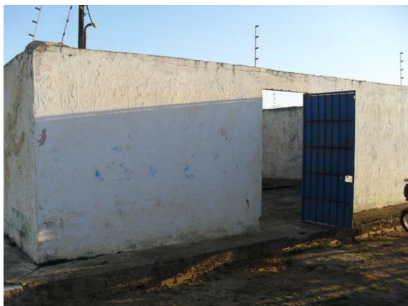
Foto 1: Entrada da Estação Elevatória de Esgoto Urbis 6 operada pela Embasa.
