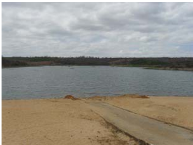
Foto 1: Lagoa formada pela barragem do Rio Gavião, destino final de grande parte das águas pluviais da cidade
