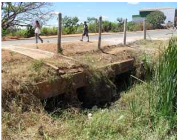
Foto 3: Pontilhão sobre o Rio do Barreiro.
