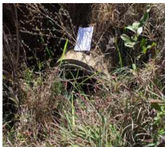
Foto 4: Ponto final do extravasor da lagoa
