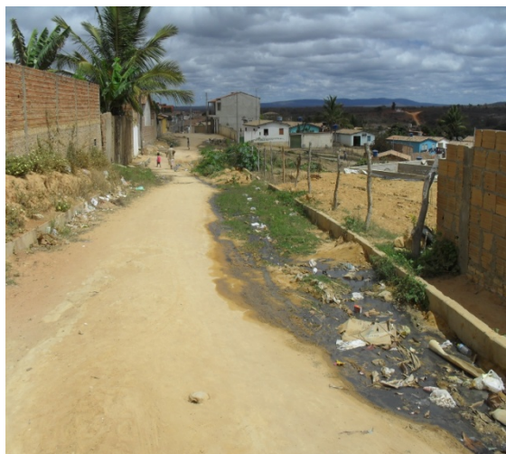
Foto 2: Ponto de lançamento da rede de esgoto com rede de drenagem implantada na Rua Vaticano próximo a Praça Vinícius de Moraes.
