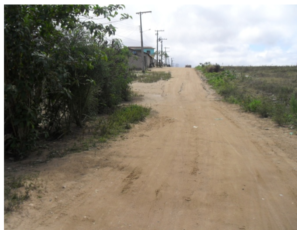
Foto 10: Vista de outro ângulo da rua Atalaia. O aterro da BR – 116 cria um obstáculo ao escoamento das águas pluviais que ficam acumuladas na região.
