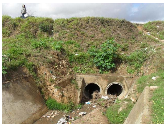
Foto 12: Canal 4 – Fim do trecho em manilha e início do trecho em canal aberto revestido em concreto.
