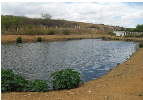
Foto 5: Detalhe da Lagoa facultativa. Vegetação inadequada crescendo nos taludes.
