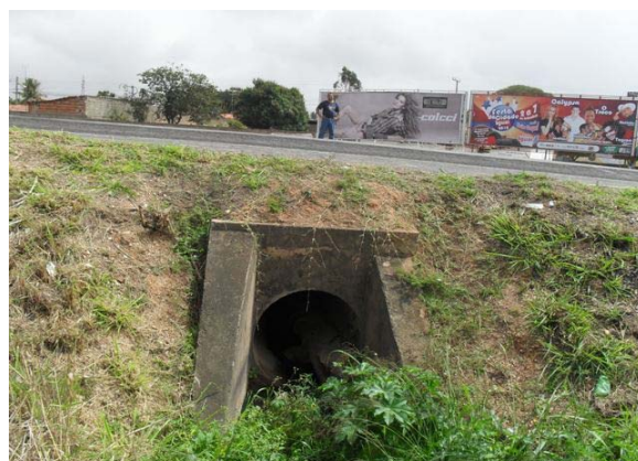
Foto 6: Bueiro sob a BR-116.
