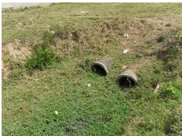
Foto 7: Final da Av. Orlando Fontes – ponto de lançamento de água pluvial.
