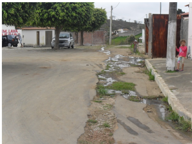
Foto 1: Rua Castro Alves. Algumas residências que não ligaram seus esgotos sanitários na rede de microdrenagem próxima estão lançando esgoto secundário a céu aberto.
