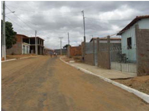
Foto 1: Local atendido pelo SES. Caixa de ligação domiciliar no centro da foto
