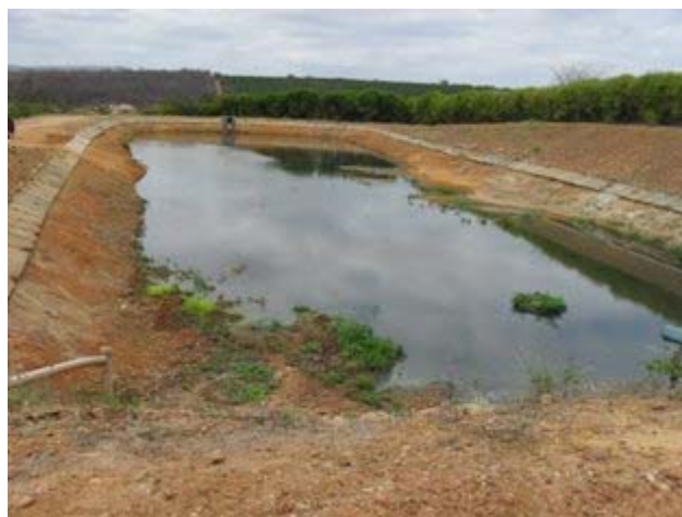
Foto 4: Lagoa de estabilização
