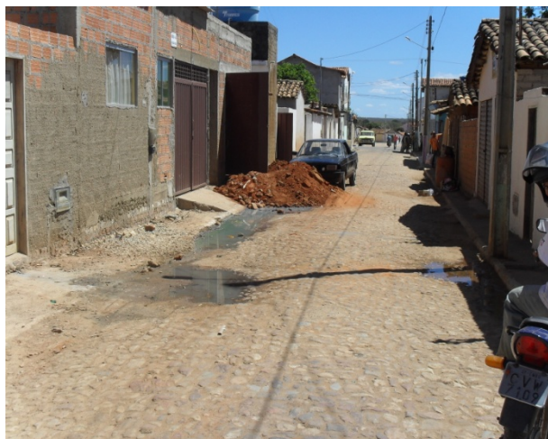
Foto 1: Rua 28 de Dezembro. Principal rua da cidade onde pode ser observado o lançamento direto de esgoto secundário na sarjeta da via.
