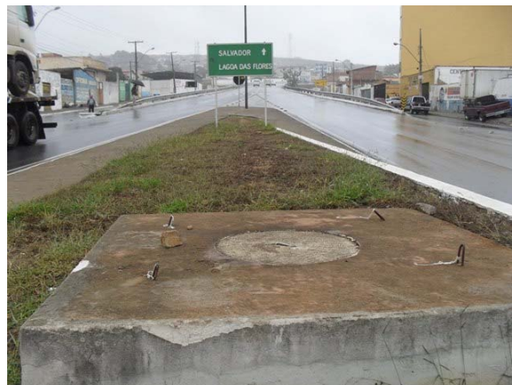
Foto 28: Canal 7 – Início do canal com trecho em manilhas de 1,5m de diâmetro no canteiro central da BR-116.
