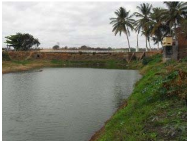
Foto 6: Pequena barragem cujo vertedouro leva ao lago da barragem do Rio Gavião
