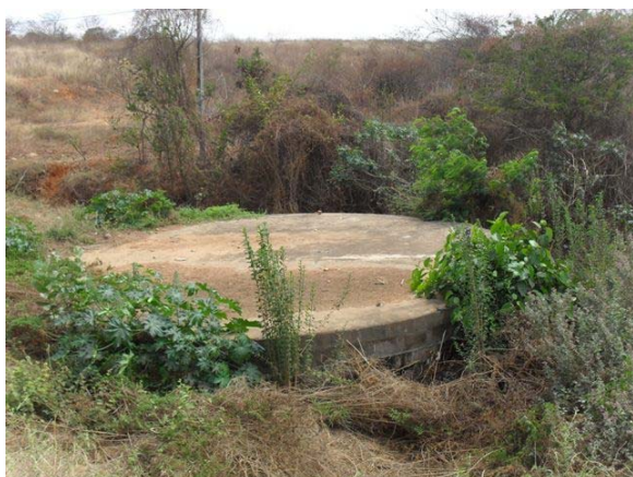
Foto 3: Unidade de tratamento com funcionamento precário – lança no Rio de Zaia.
