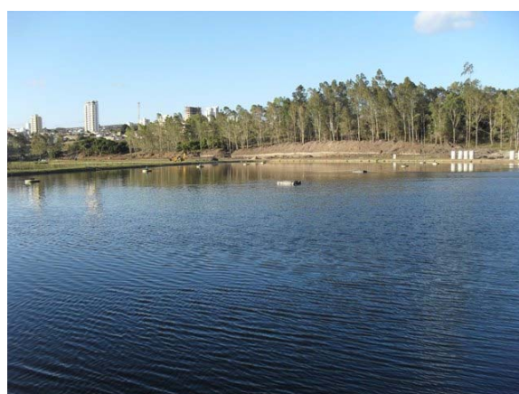
Foto 16: Lagoa Aerada da Estação de Tratamento de Esgoto.
