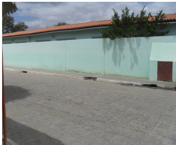
Foto 2: Rua Otaviano Souza. Detalhe das caixas coletoras com abertura na guia da galeria retangular de águas pluviais.
