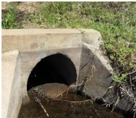
Foto 2: Final da rede de drenagem que deságua na lagoa
