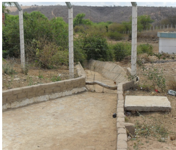
Foto 2: Início do Canal de macrodrenagem situado ao lado da estação de tratamento de esgoto. Dispositivo construído para proteger a ETE da cheia da Lagoa de Ananias situada em frente.
