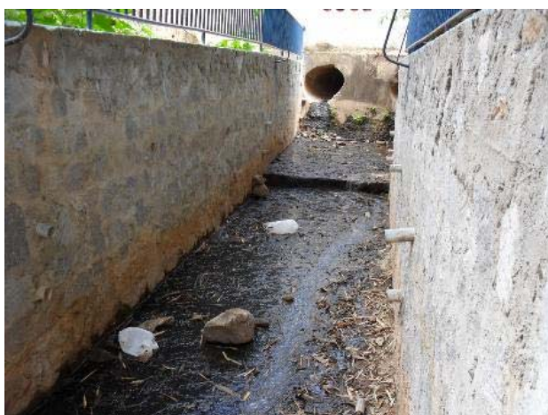
Foto 3: Canal revestido com vista de bueiro
