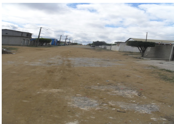
Foto 15: Travessa Senhor do Bonfim. Vista das ruas que contribuem para a ocorrência de alagamento na área crítica 1.
