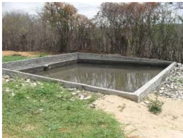
Foto 6: Leito de secagem do lodo
