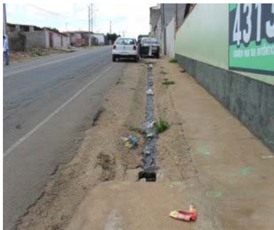
Foto 1: Canaleta transportando água servida
