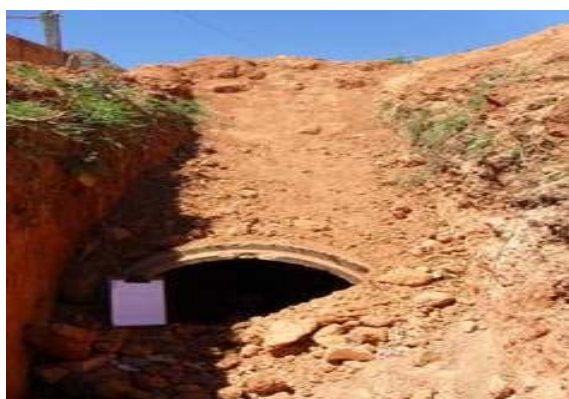
Foto 9: Ponto final de rede de drenagem em construção
