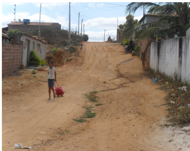
Foto 1: Esgoto secundário escoando a céu aberto nas ruas. Realidade de aproximadamente 5% da cidade.
