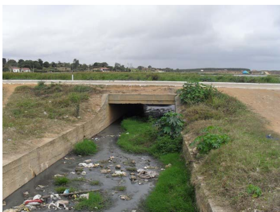
Foto 5: Canal 2 - Final do trecho em canal aberto revestido em concreto na Rua 9 no Bairro Santa Cruz com deságüe na Lagoa das Bateias.
