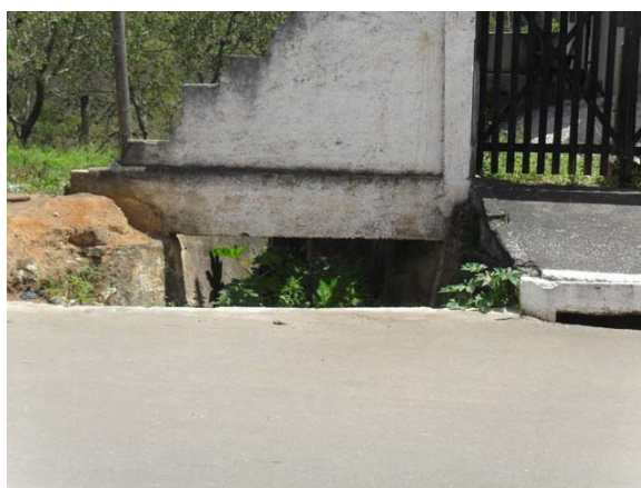
Foto 4: Av. Vitória da Conquista – acesso à drenagem.
