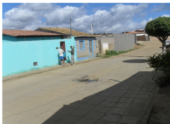
Foto 16: Rua Eliezer Andrade. Área crítica por conta da ocorrência de alagamento. Área crítica 8.
