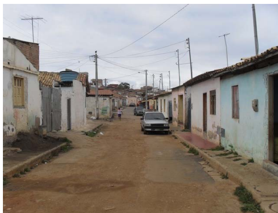
Foto 46: Área Crítica 4 – Alagamento – Bairro Santa Cruz – Rua 4 entre as ruas 8 e 11 – Baixa declividade longitudinal e deficiência no sistema de microdrenagem.
