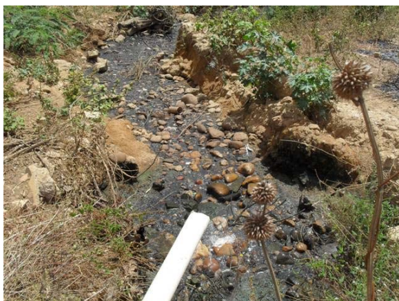
Foto 9: Rua da Fonte - lançamento direto de esgoto em direção ao Rio Gavião.
