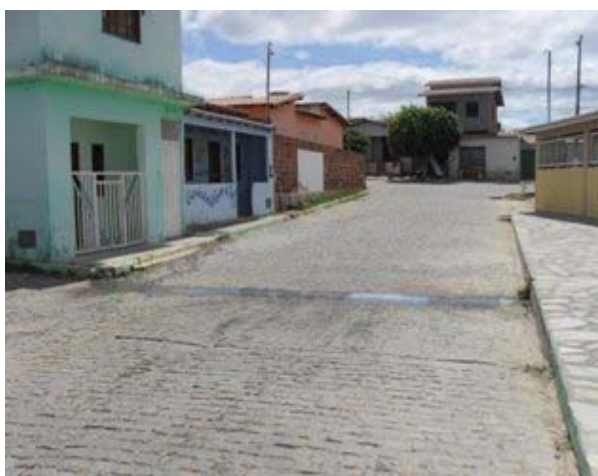
Foto 5: Esgoto secundário a céu aberto
