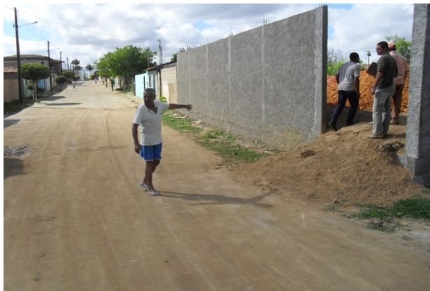
Foto 17: Rua Eliezer Andrade. Construções mais recentes estão sendo feitas com patamar mais elevado para evitar que as águas pluviais invadam o local no momento que ocorre o alagamento na via.
