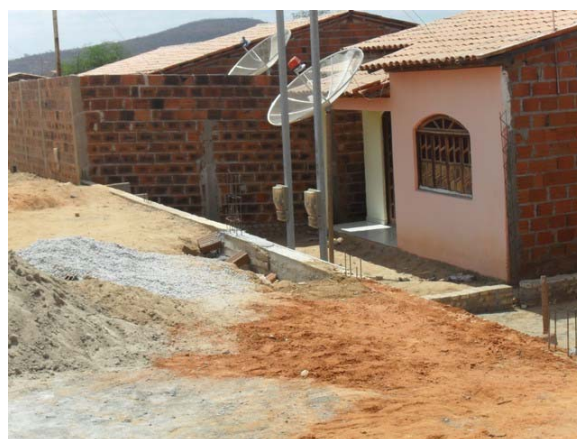
Foto 4: Área de alagamento.
