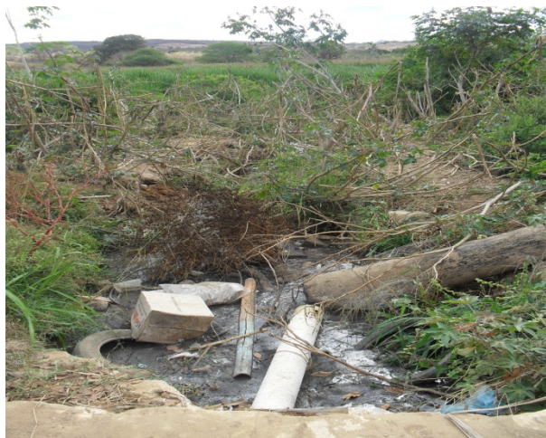
Foto 1: Ponto de lançamento de esgoto secundário da rede coletora de esgoto na Lagoa de Dadá. Tubulação de PVC de 150 mm de diâmetro.
