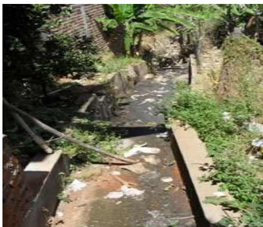
Foto 5: Rede de drenagem terminando na lagoa
