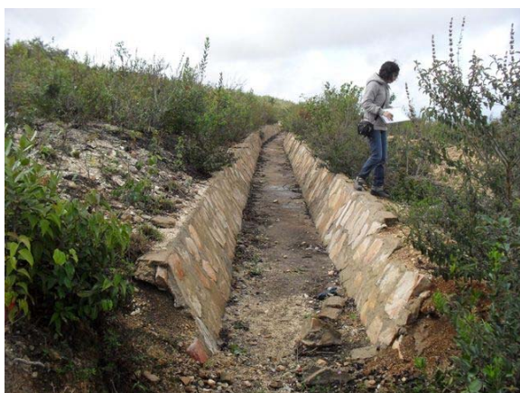
Foto 9: Canal 4 - Início do canal aberto revestido em alvenaria de pedra na serra.
