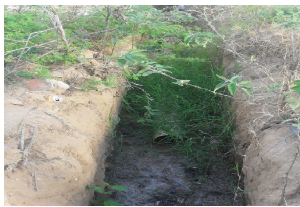
Foto 6: 2ª Travessa Osvaldo Cruz. Esgoto secundário
