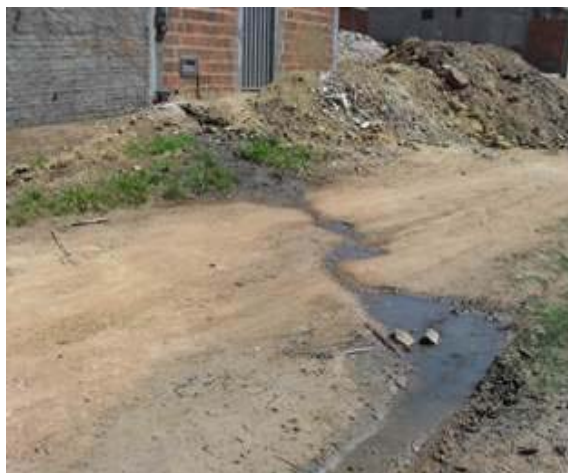
Foto 2: Lançamento de esgoto a céu aberto
