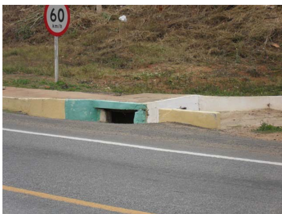
Foto 11: Drenagem lateral da BR-116.
