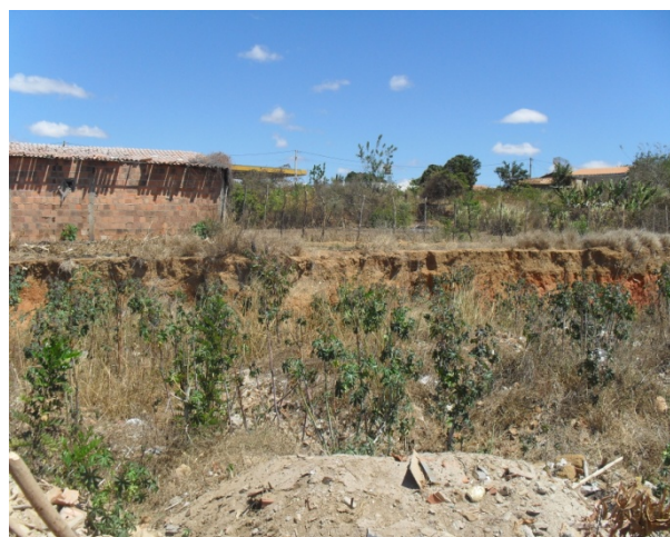
Foto 4: Processo erosivo em estágio de voçoroca localizado atrás do Posto de gasolina Cajueiro.
