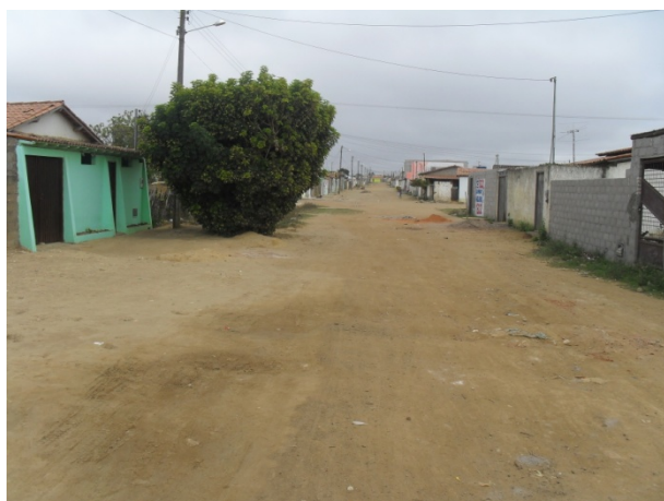
Foto 3: Rua 2 de Julho. Área crítica por conta da ocorrência de alagamento. Área crítica 5.
