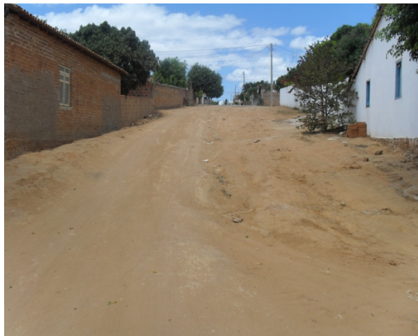
Foto 1: Rua Clemente Soares. Rua sem pavimentação que apresenta processo erosivo no trecho final.
