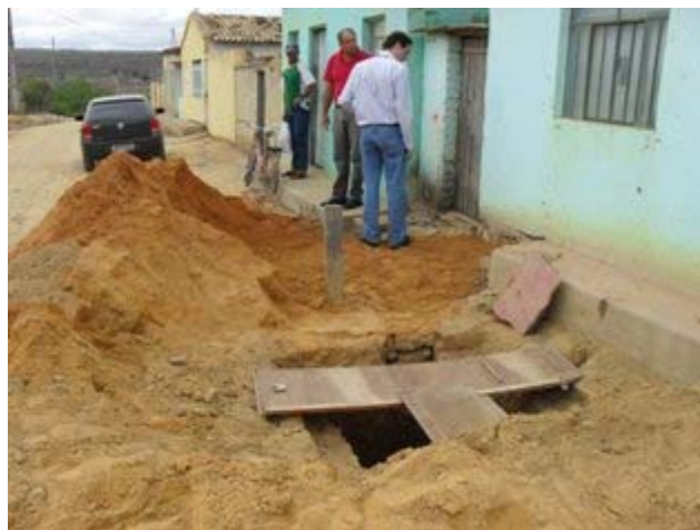
Foto 2: Construção de fossa absorvente ao lado de uma que estava cheia
