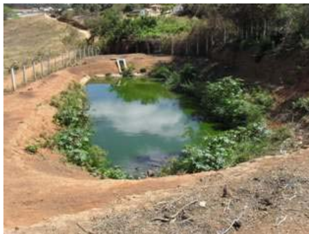
Foto 2: Lagoa de estabilização
