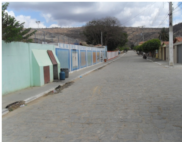
Foto 1: Rua Otaviano Souza. Única rua da cidade que possui dispositivos de drenagem de águas pluviais.
