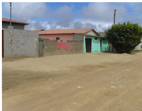
Foto 4: Rua 2 de Julho. Rua com declividade transversal inadequada e sem possibilidade de escoamento natural das águas devido à ocupação intensa.
