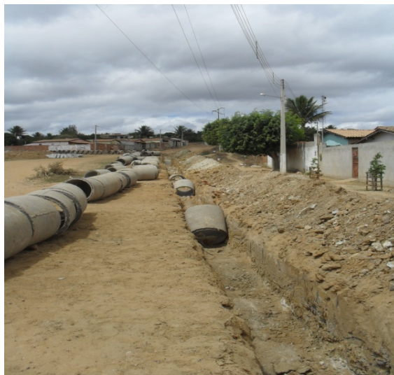
Foto 2: Obra da Praça Olímpica. Tubulação no local pronta para ser assentada na vala.
