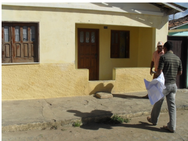
Foto 19: Rua J. J. Seabra. Moradores constroem muretas nas entradas das casas para evitar que as águas pluviais invadam suas residências.
