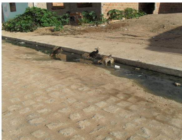
Foto 5: Lançamento de esgoto a céu aberto.
