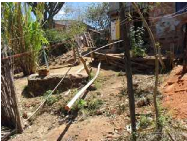
Foto 3: Fossa absorvente nos fundos de uma residência. Prática comum na cidade
