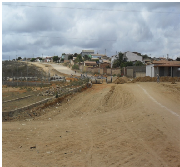
Foto 1: Praça Olímpica. Obra de pavimentação e drenagem de águas pluviais em andamento.
