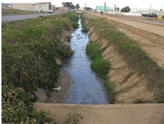
Foto 39: Canal 16 - Trecho do canal aberto revestido em concreto na Avenida Brumado.
