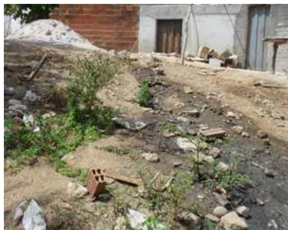
Foto 4: Esgoto lançado a céu aberto que escoar para a lagoa da cidade
