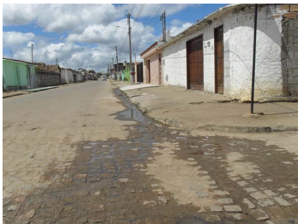
Foto 1: Av. Vitória da Conquista – esgoto a céu aberto.
