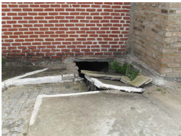
Foto 7: Passagem de água pluvial entre lotes.
