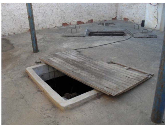
Foto 5: Estação Elevatória de Esgoto Coveima que será desativada após o término das obras em curso.
