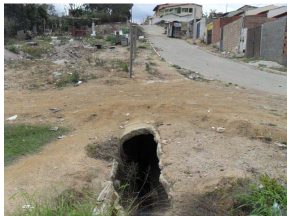
Foto 2: Canal 1 - Final da galeria circular enterrada na Rua 1 no Bairro Santa Cruz com deságüe na Lagoa das Bateias.
