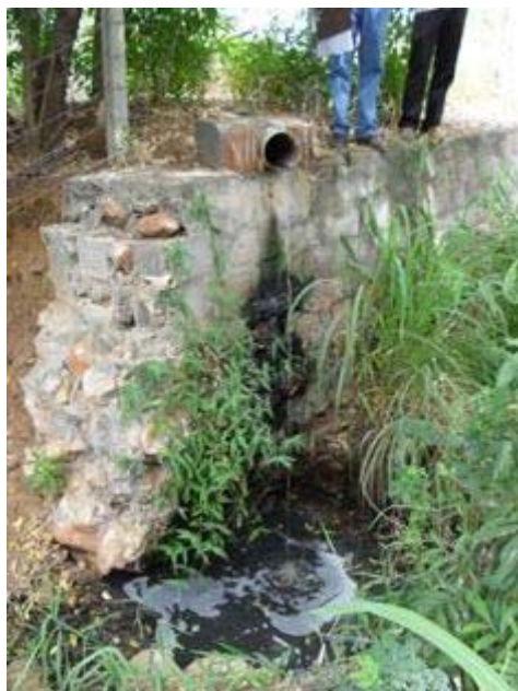
Foto 9: Ponto de lançamento do efluente da ETE no Riacho
