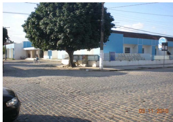
Foto 4: Área Crítica 2 – proximidades do hospital – área de alagamento.
