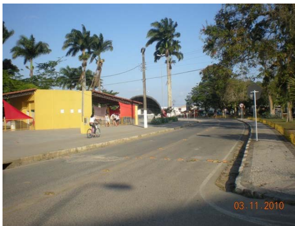
Foto 7: Área Crítica 3 – Av. Presidente Vargas – área de alagamento.
