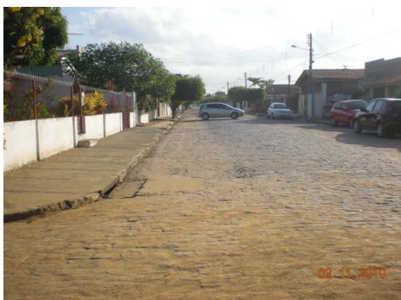
Foto 5: Área Crítica 2 – proximidades do hospital – área de alagamento.
