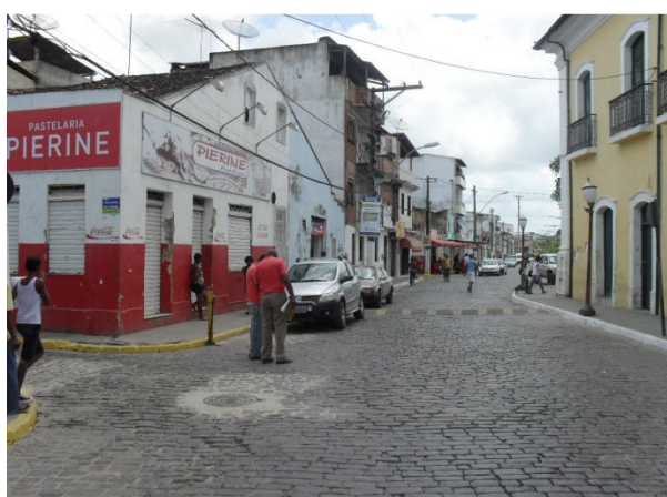
Foto 23: Praça da Purificação. Área crítica por conta da ocorrência de alagamento. Área crítica 11.
