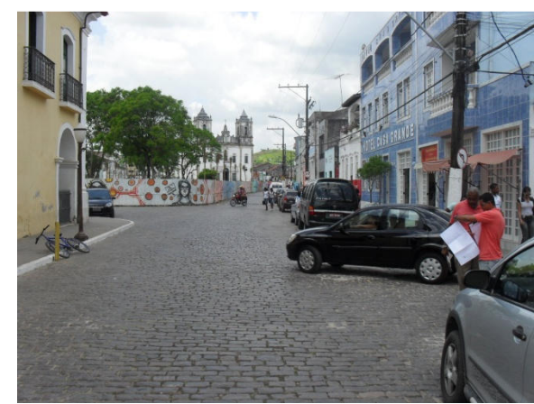
Foto 24: Praça da Purificação. Vista de outro ângulo da área crítica por conta de alagamento.
