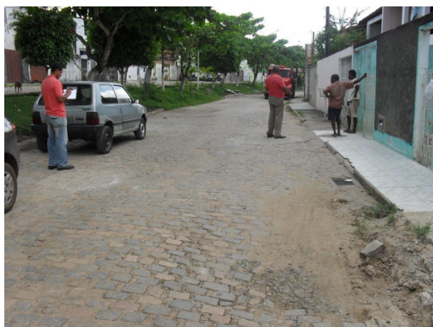
Foto 41: Rua B. área crítica por conta da ocorrência de alagamento. Área crítica 18.
