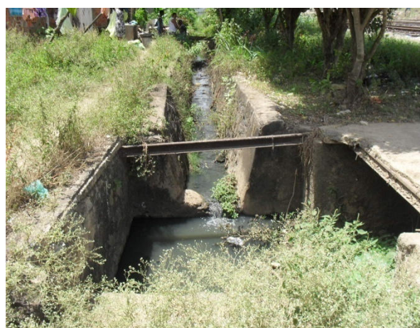
Foto 36: Córrego que beira a ferrovia que corta a rua 2 de Julho é drenado por um trecho em canal aberto e segue em galeria circular enterrada até o rio Subaé.
