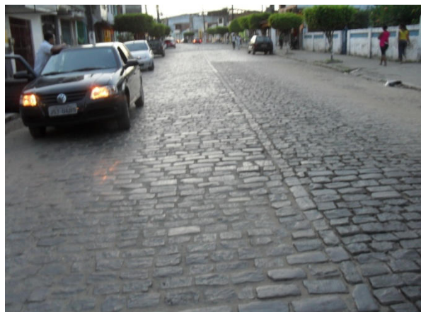
Foto 16: Rua Rui Barbosa (e Boa Sorte). Área crítica por conta da ocorrência de alagamento. Área crítica 8.
