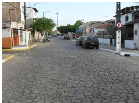
Foto 10: Avenida Ferreira Bandeira. Área crítica por conta da ocorrência de alagamento. Área crítica 5.
