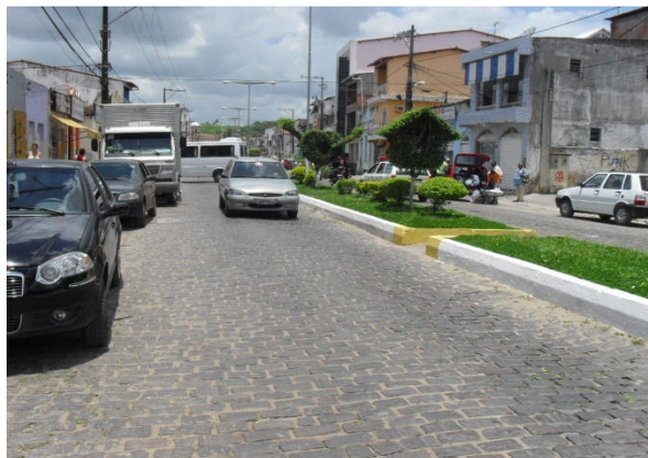
Foto 26: Avenida Viana Bandeira. Vista de outro ângulo da área crítica por conta de alagamento.
