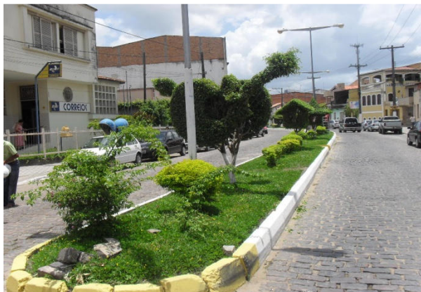
Foto 25: Avenida Viana Bandeira. Área crítica por conta da ocorrência de alagamento. Área crítica 12.
