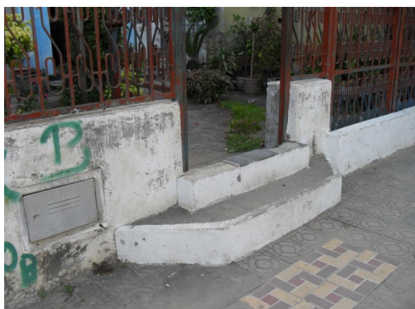
Foto 11: Avenida ferreira Bandeira. Moradores constroem batentes na entrada de suas residências para evitar a invasão das águas pluviais.
