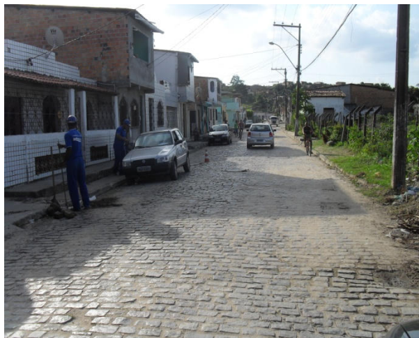
Foto 1: Rua João Soldado. Área crítica por conta da ocorrência de alagamento. Área crítica 1.
