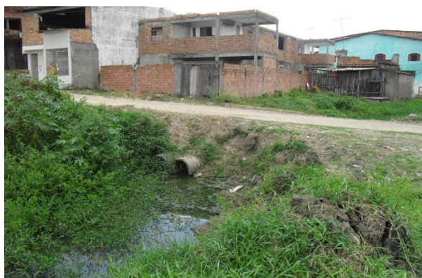
Foto 39: Loteamento Jardim Vale Verde. Detalhe do bueiro de travessia do córrego que corta a área crítica.
