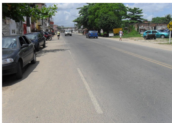
Foto 18: Avenida Garcia. Área crítica por conta da ocorrência de alagamento. Área crítica 9.
