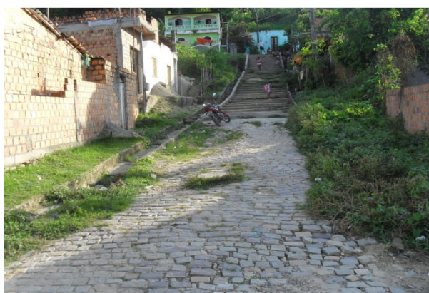
Foto 5: Escadaria com drenagem lateral da rua Alto do Riachuelo. A contribuição superficial transportada por esta estrutura potencializa os efeitos sobre a área crítica 2.
