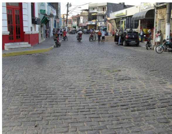
Foto 8: Praça do Rosário, em frente a Secretaria de Finanças. Área crítica por conta da ocorrência de alagamento. Área crítica 4.
