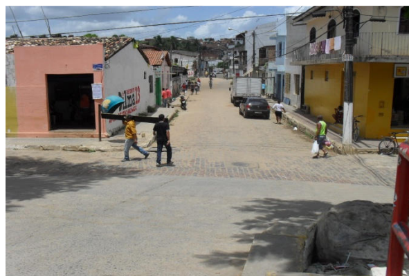
Foto 34: Rua 2 de Julho. Área crítica por conta da ocorrência de alagamento. Área crítica 16.
