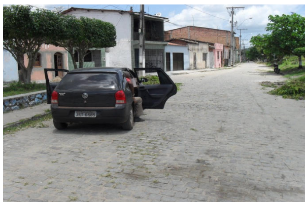
Foto 33: Rua Nestor de Oliveira, próximo ao DERBA. Vista de outro ângulo da área crítica de alagamento agravada pela insuficiência e obstrução do sistema de drenagem existente.
