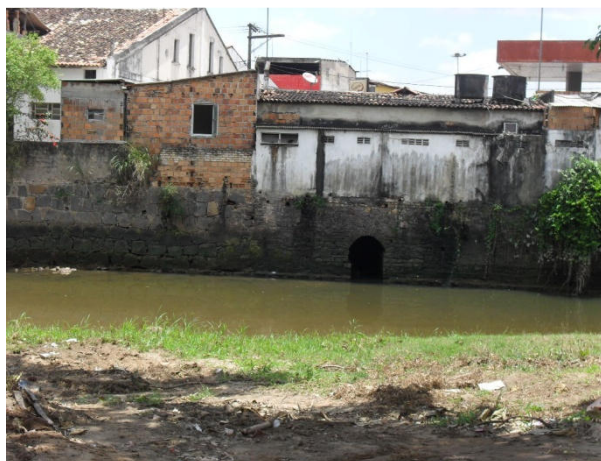
Foto 31: Rio Subaé. Detalhe da antiga galeria de drenagem que desemboca no rio.
