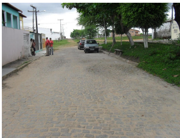
Foto 42: Rua B. Vista de outro ângulo da área crítica de alagamento agravado pela obstrução dispositivo de drenagem local.
