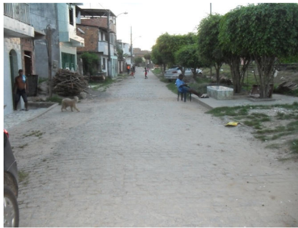
Foto 14: Rua Natalício Wanderley. Área crítica por conta da ocorrência de alagamento. Área crítica 7.
