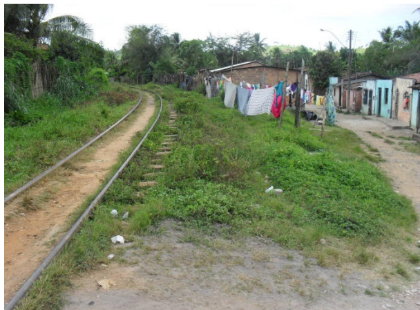
Foto 43: Rua do Pilar de Baixo. Área crítica por conta da ocorrência de alagamento. Área crítica 19.
