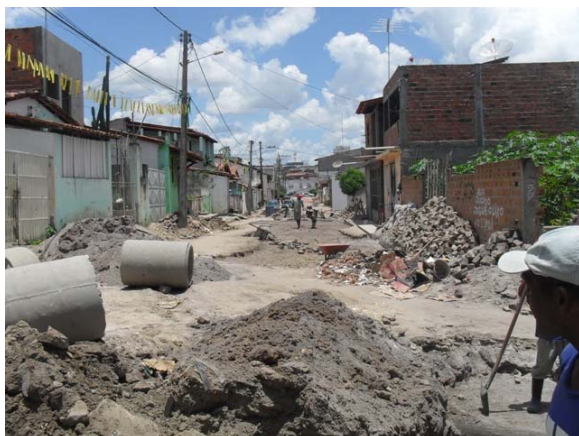
Foto 7: Rua João Delfino – implantação de rede de drenagem pela Prefeitura.
