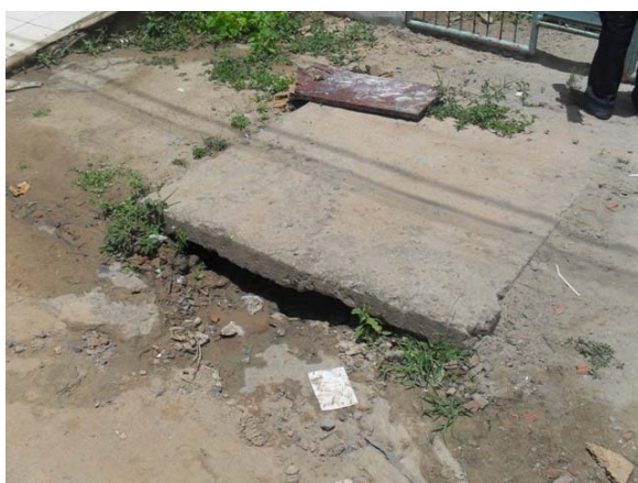
Foto 3: Caixa de passagem de águas pluviais.
