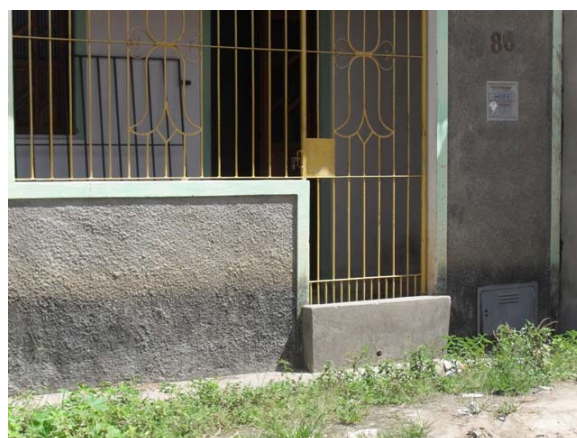
Foto 10: Mureta de proteção contra alagamento na área crítica 1 - Salgadeira.
