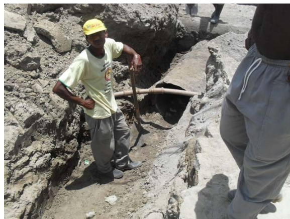
Foto 8: Rua João Delfino – implantação de rede de drenagem pela Prefeitura.
