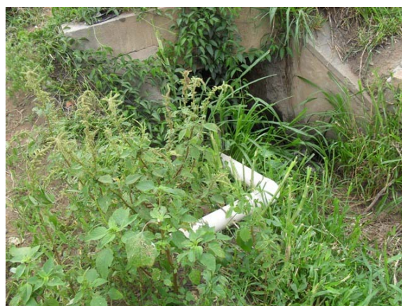
Foto 4: Bueiro sob a Rodovia BR-030 – Rua Padre Vicente Santinhami.
