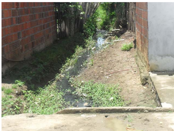
Foto 1: Rua José Domingos – pequeno córrego conduzindo esgoto.
