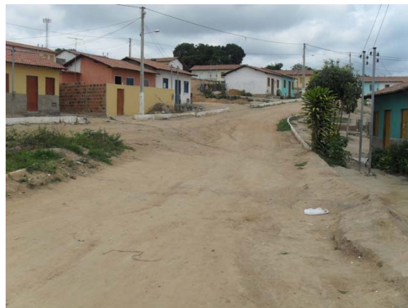
Foto 2: Área Crítica – Rua 1º de Maio – área de alagamento.
