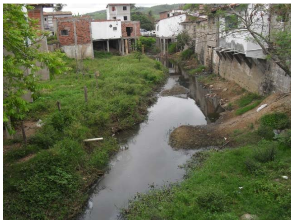
Foto 2: Rua Altamirando Monteiro – Riacho do Meio com lançamentos diretos de esgotos.
