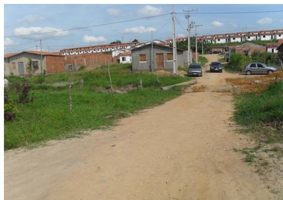
Foto 6: Área Crítica – Bairro Nova Esperança – área de alagamento.
