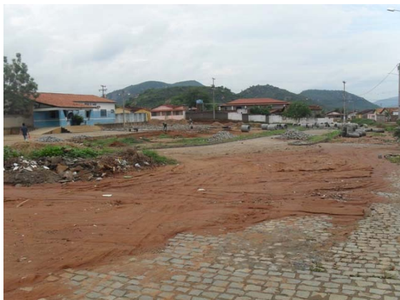
Foto 1: Av. Gabriel D. Novais – implantação de rede de drenagem pela Prefeitura.
