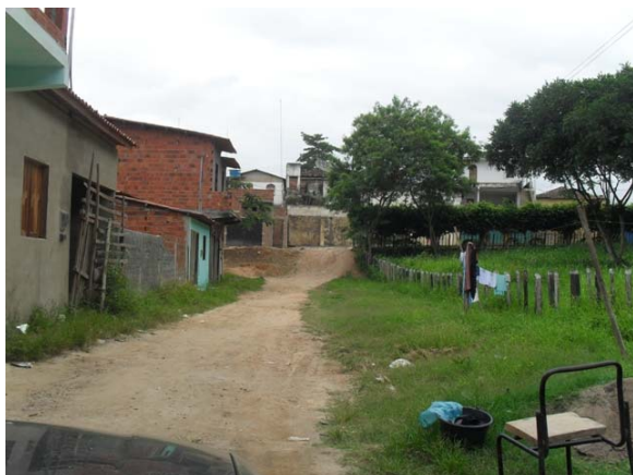
Foto 7: Área Crítica 1 – Rua Quintino Bastos – área de alagamento.
