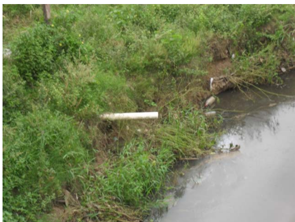
Foto 3: Rua Altamirando Monteiro – Riacho do Meio com lançamentos diretos de esgotos.
