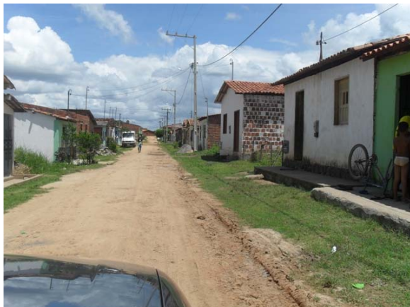
Foto 7: Área Crítica – Bairro Sítio Comunitário – área de alagamento.
