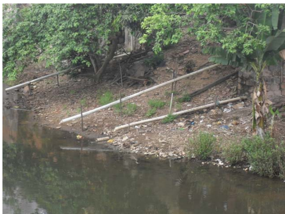
Foto 7: Rio de Contas – lançamento direto de esgotos pelas moradias existentes nas margens.
