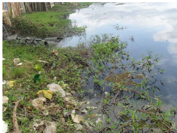
Foto 2: Lançamento a céu aberto – rede DN 400 mm – Creche.
