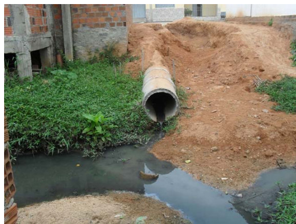
Foto 4: Rua 31 de Março com a Rua Antônio G. de Souza – final da rede mista DN 600 mm.
