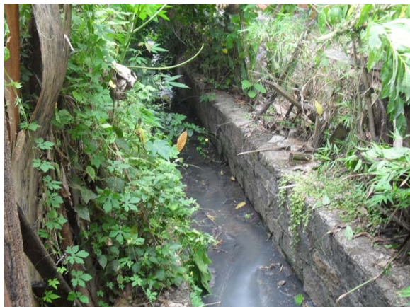
Foto 7: Canal aberto transportando águas pluviais e esgotos – Rua Francisco de Souza.
