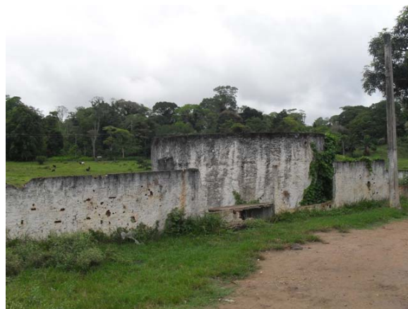
Foto 2: ETE executada pela CONDER – Rua Manoel Rosário.
