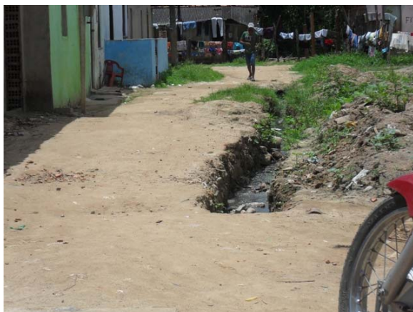
Foto 1: Valeta em via pública conduzindo esgoto secundário a céu aberto.
