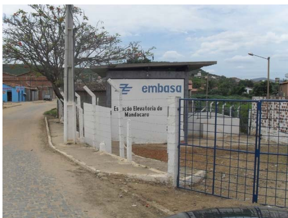
Foto 11: Estação Elevatória EMBASA – Bairro Mandacaru.
