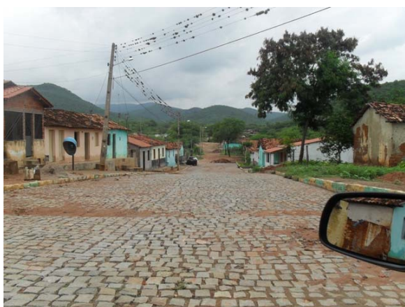
Foto 3: Rua da Cachoeirinha – erosão laminar.
