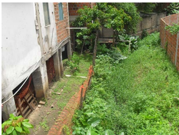
Foto 3: Rio Sapucaia – início do trecho canalizado – com lançamentos diretos de esgotos.
