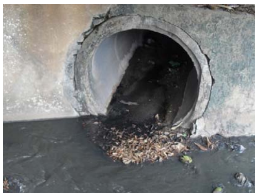
Foto 6- Canal do Distrito Industrial.
