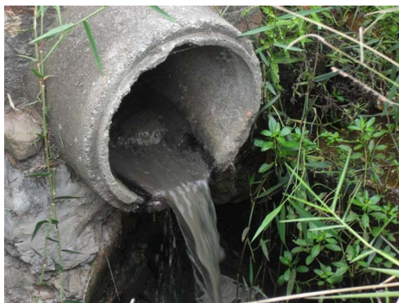
Foto 4: Caixa de reunião – próximo da represa.
