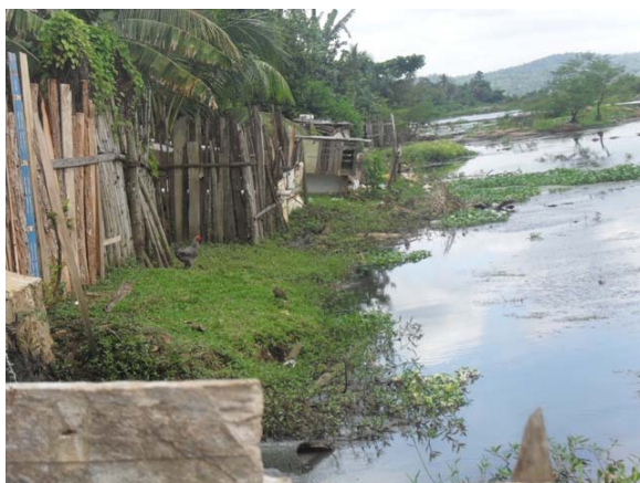
Foto 5: Rio de Contas – lançamento direto de esgotos pelas moradias existentes nas margens.
