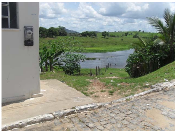
Foto 1: Lançamento da rede mista de DN 1000 mm no Rio de Contas – ponto próximo ao hospital.
