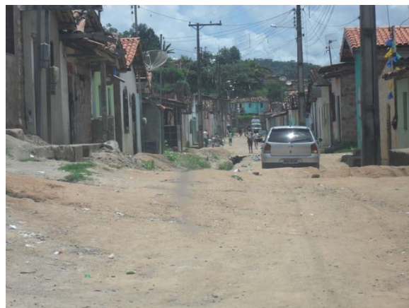
Foto 4: Área Crítica – entre a Rua 31 de Março e o Riacho Água Branca – área alagável.
