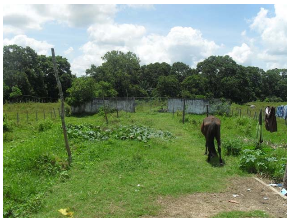
Foto 4: Bairro Firmo ferreira – ETE sem controle operacional.
