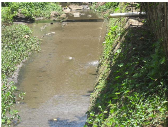
Foto 5: Trecho do Canal a céu aberto com lançamento diretos de esgotos.
