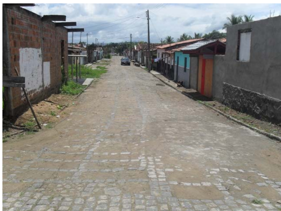
Foto 3: Área Crítica 1 – Rua Febrônio J. Moraes – área de alagamento.
