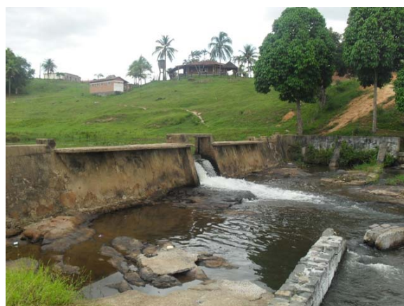
Foto 6: Barragem existente no Rio Preto do Costa.
