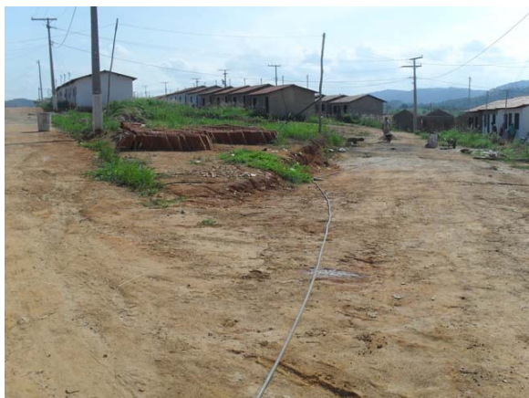
Foto 7: Loteamento Gilda Fonseca – processo erosivo do terreno.
