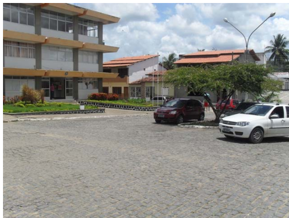
Foto 2: Área Crítica – proximidades do hospital – área de alagamento.
