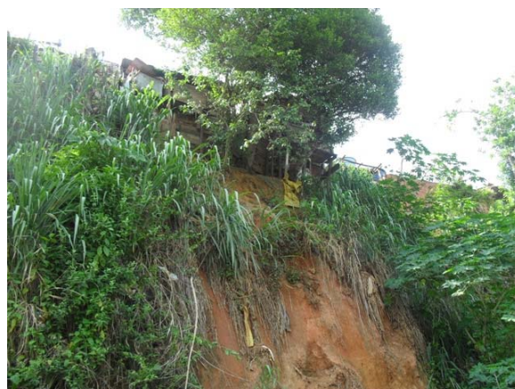
Foto 4: Área de risco de desabamento – fundos da Rua Castro Alves.
