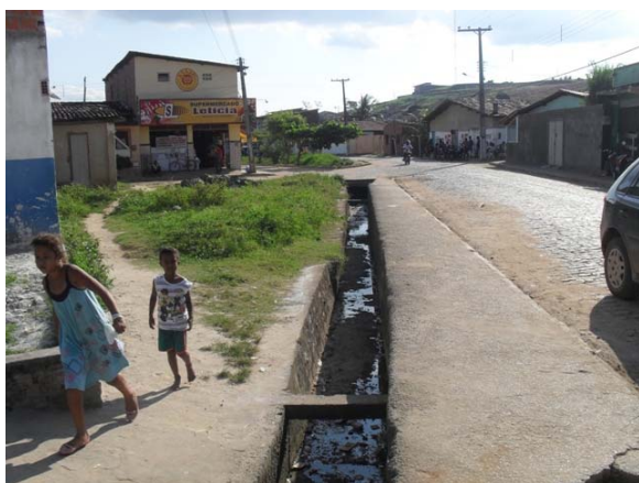
Foto 3: Canal do Conjunto ACM – trecho revestido e conduzindo águas pluviais e esgotos secundários.
