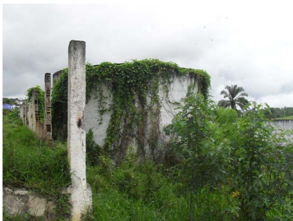
Foto 1: ETE executada pela CONDER – Rua Manoel Rosário.
