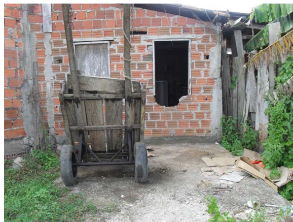
Foto 2: Casa construída sobre o Canal revestido e lançando seus esgotos nele.
