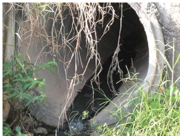
Foto 8: Lançamento de águas pluviais e esgotos no Rio de Contas.
