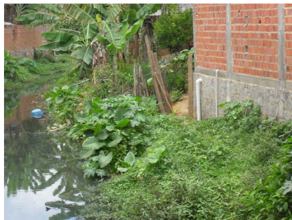
Foto 2: Loteamento O. Novais – Rio Penedo – recebe contribuição direta de esgotos.
