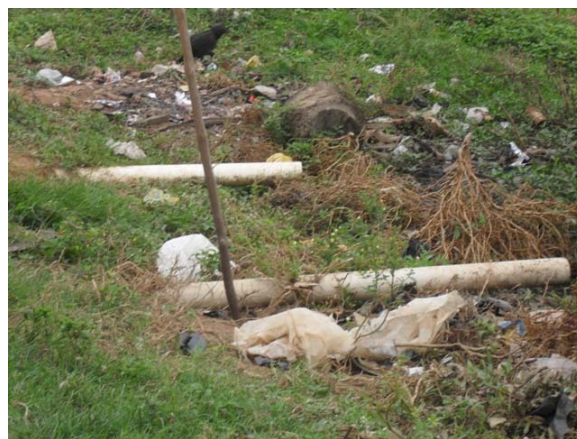
Foto 10: Diversos pontos de lançamento de esgotos a céu aberto.
