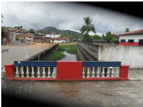
Foto 1: Início do trecho canalizado do Rio Formiga.
