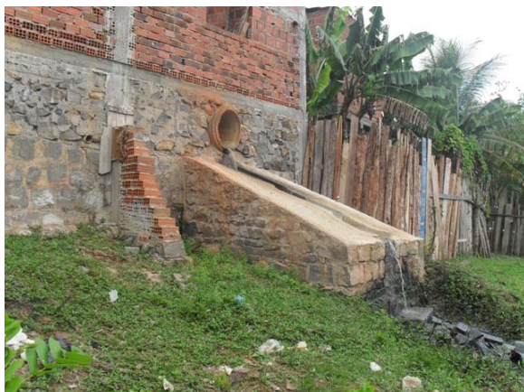
Foto 1: Lançamento a céu aberto – rede DN 400 mm – Creche.
