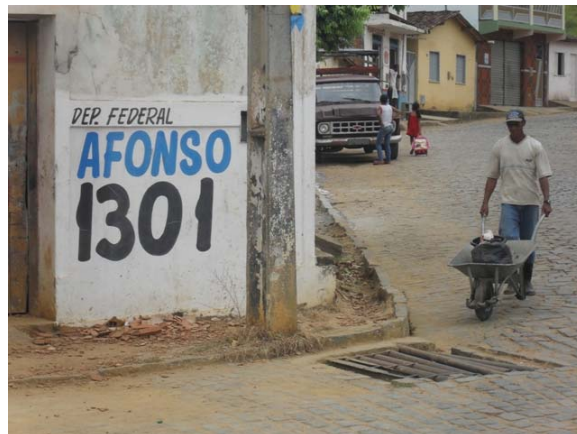
Foto 8: Área Crítica – Rua Dom Pedra II - caixa com grelha – área de alagamentos.
