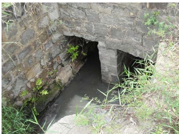
Foto 3: Caixa de reunião – próximo da represa.
