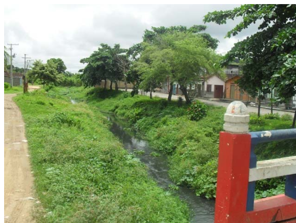
Foto 6: Final do trecho canalizado do Rio Sapucaia.
