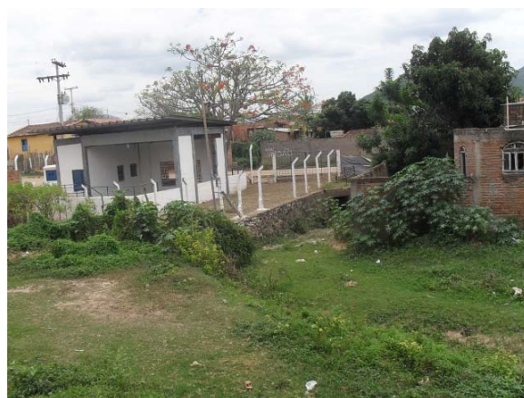
Foto 12: Estação Elevatória EMBASA – Bairro Mandacaru.
