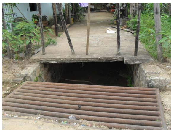
Foto 4: Canal fechado – Rua José Fonseca.
