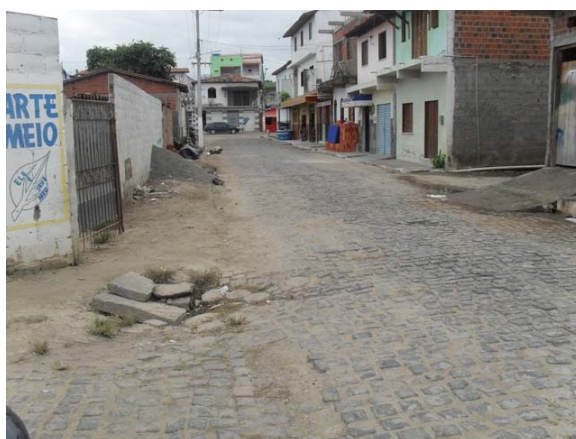
Foto 4: Área Crítica 1 – Rua Manoel Costa neto e adjacências – área de alagamento.
