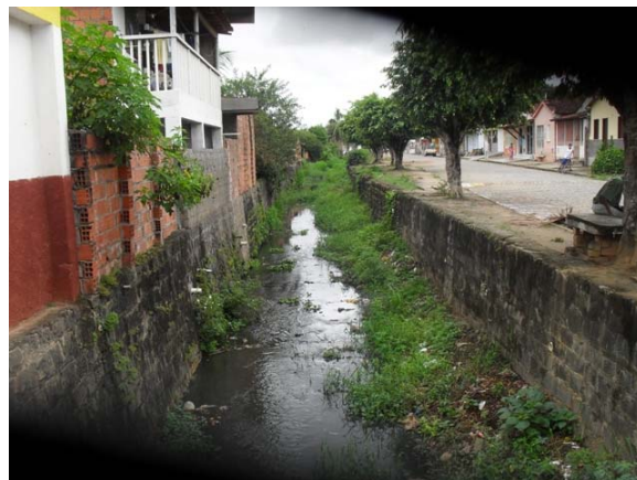
Foto 2: Início do trecho canalizado do Rio Formiga.
