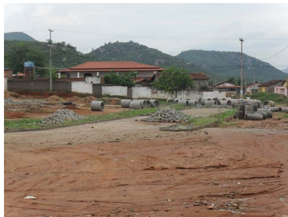
Foto 2: Av. Gabriel D. Novais – implantação de rede de drenagem pela Prefeitura.
