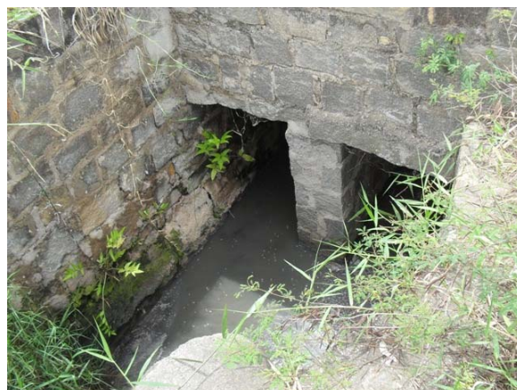
Foto 6: Caixa de reunião – próximo da represa.
