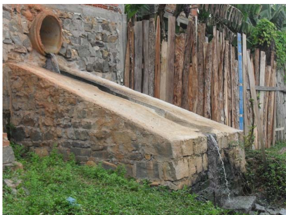
Foto 3: Lançamento a céu aberto – rede DN 400 mm – Creche.
