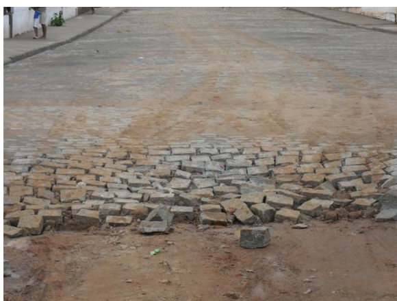
Foto 5: Área Crítica – Bairro Gameleira – área de alagamento - Prefeitura Municipal implantando rede de drenagem.
