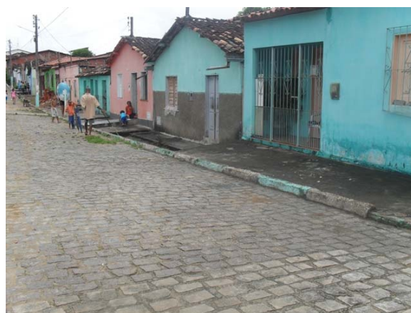
Foto 4: Área Crítica – Rua Maria Alexandrina – área de alagamento.
