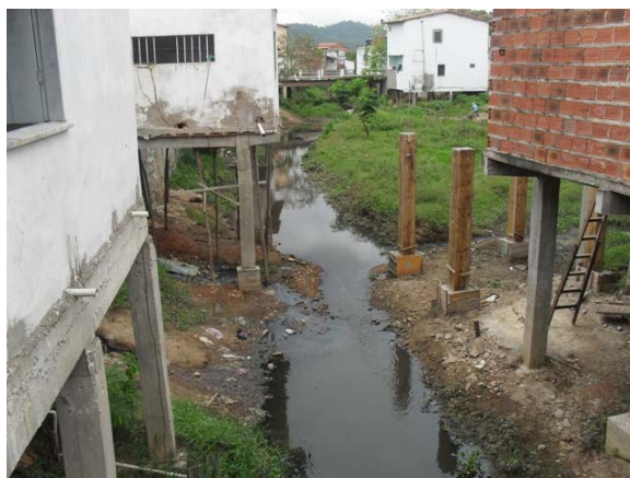
Foto 4: Rua José Dantas de Farias – Riacho do Meio com lançamentos diretos de esgotos.
