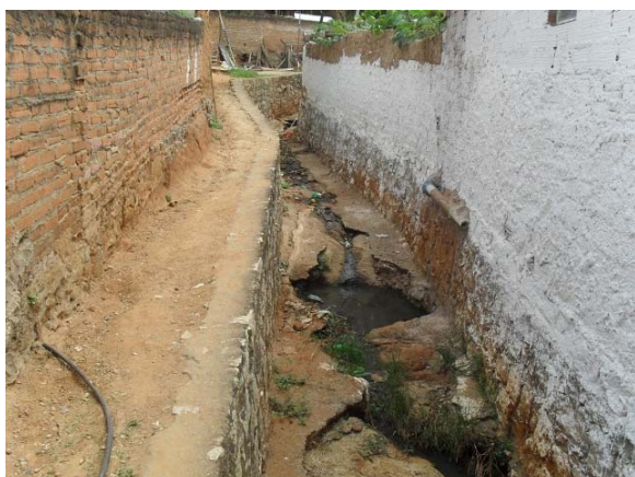
Foto 5: Canal revestido conduzindo águas pluviais e esgotos.
