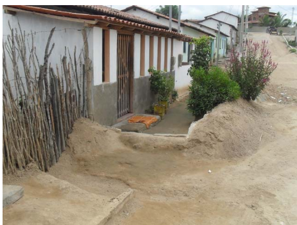
Foto 3: Área Crítica – Rua 1º de Maio – área de alagamento.
