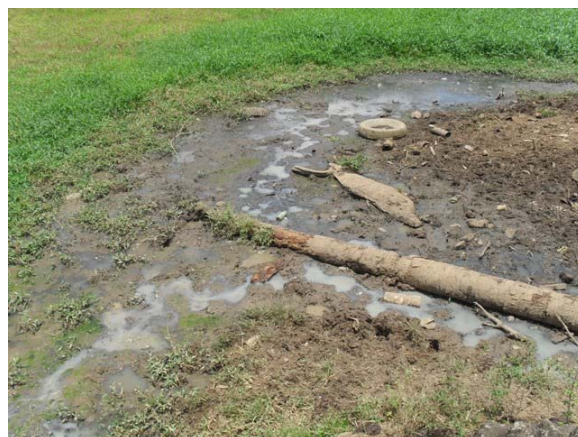
Foto 4: Final da Rua Emílio Nery – esgoto secundário disposto a céu aberto.
