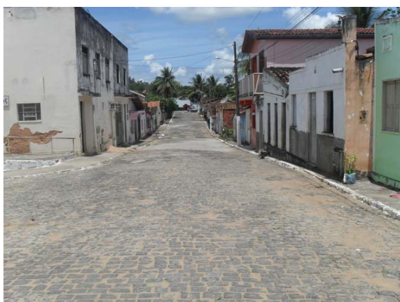
Foto 3: Área Crítica – proximidades do hospital – área de alagamento.
