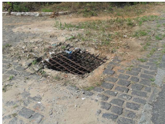
Foto 2: Rua castro Alves – caixa de coleta com grelha.
