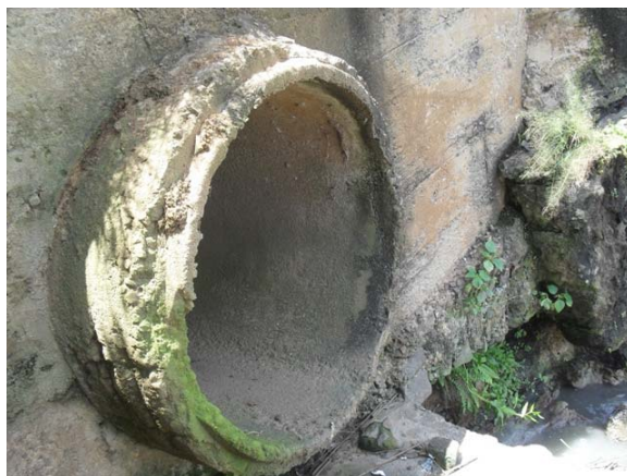
Foto 2: Lançamento da rede mista de DN 1000 mm no Rio de Contas – ponto próximo ao hospital.
