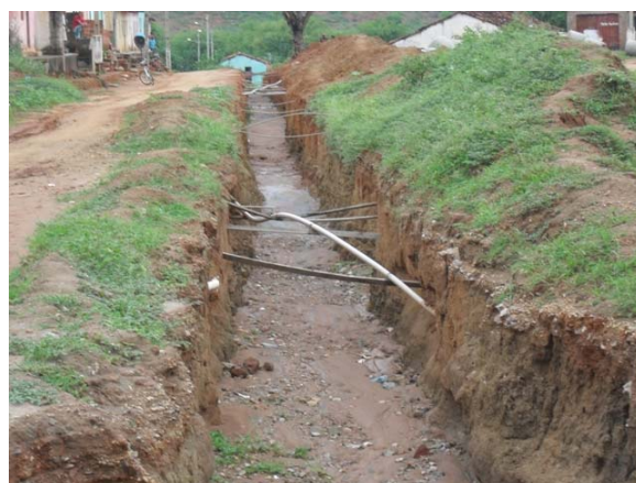
Foto 6: Área Crítica – Bairro Gameleira – área de alagamento - Prefeitura Municipal implantando rede de drenagem.
