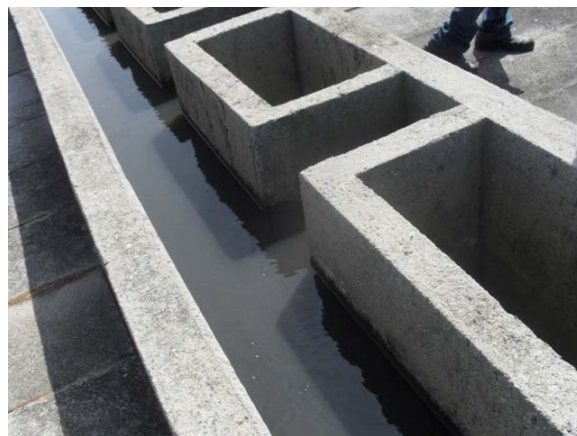
Foto 14: Vista geral do DAFA da ETE.
