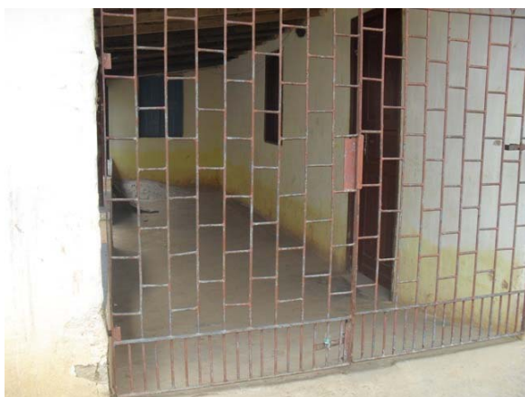
Foto 35: Área Crítica 6 – Rua do Asilo – área de alagamento.
