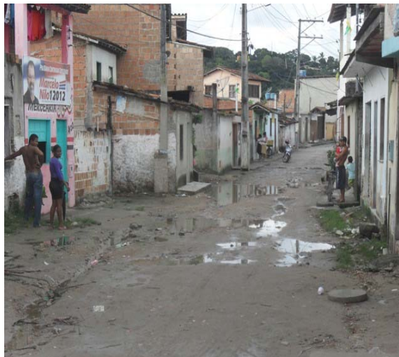
Foto 8: Área crítica 1, caracterizada pela ocorrência de freqüentes alagamentos.
