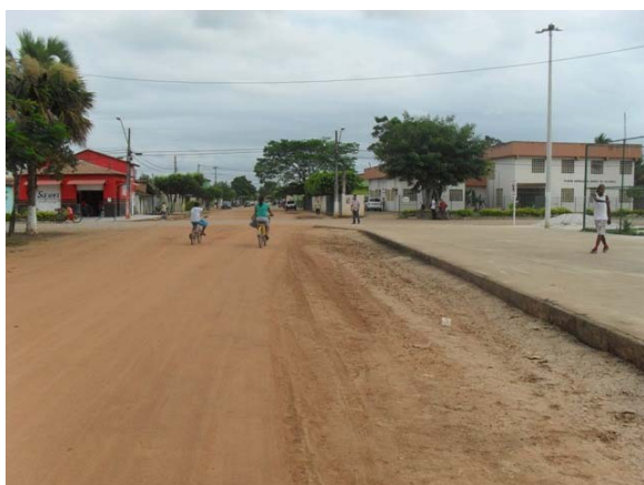
Foto 39: Área Crítica 7 – Praça do Fórum – área de alagamento.
