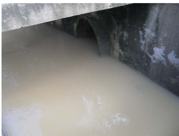
Foto 3: Manilha de microdrenagem chegando no Canal do Yayá.
