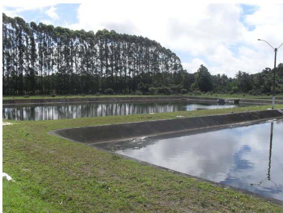
Foto 13: Lagoas de polimento da ETE.
