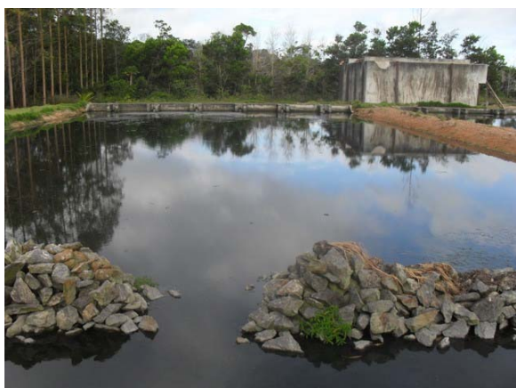
Foto 11: Lagoas de Macrófitas da ETE.
