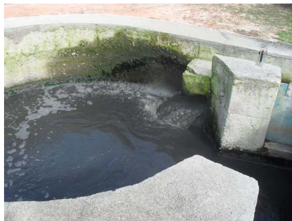
Foto 2: Aspecto geral do afluente da ETE.
