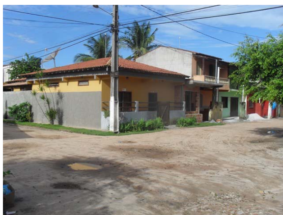
Foto 10: Área Crítica 2 – Av. Tancredo Neves – área de alagamento.
