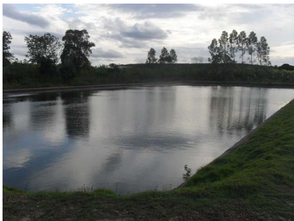
Foto 1: Aspecto geral das lagoas da ETE.
