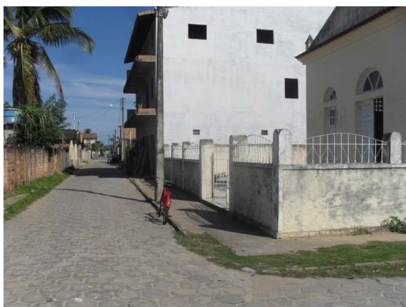
Foto 9: Área Crítica 1 – Rua General Osório – área de alagamento.
