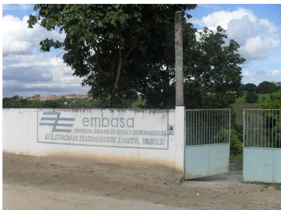
Foto 9: Entrada da Estação de Tratamento Urbis II.
