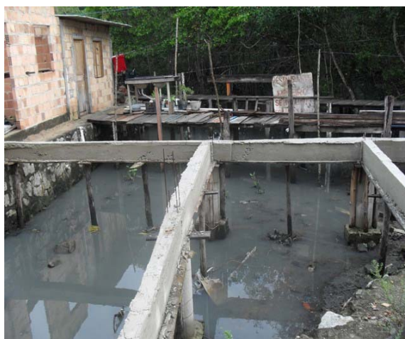
Foto 4: Final da galeria Rua do Padre Emílio.
