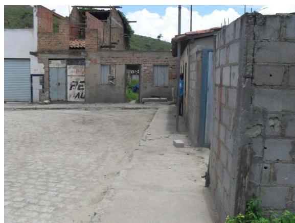
Foto 16: Área Crítica 2 – Rua Belmonte – área de inundação ribeirinha.
