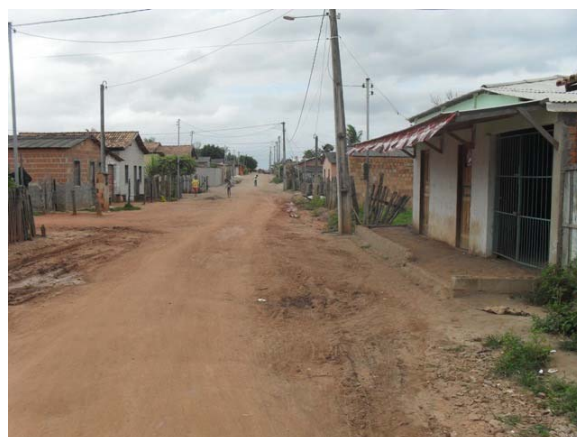
Foto 52: Área Crítica 12 – Rua C – área de alagamento.
