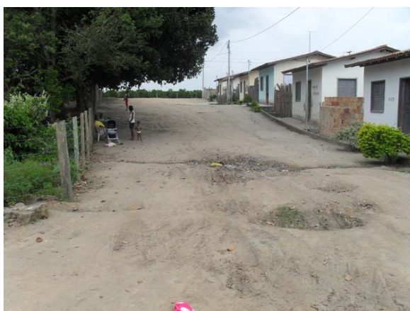
Foto 27: Área Crítica 4 – Rua Caminho 5 – área de alagamento.
