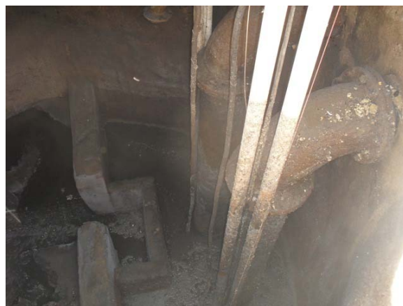
Foto 10: Poço de sucção da EE-06.
