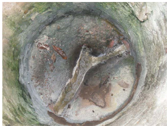
Foto 2: Aspecto geral do efluente da ETE Urbis III.
