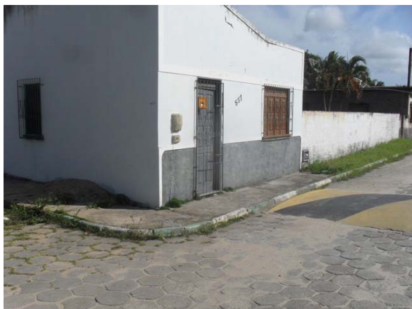
Foto 11: Área Crítica 2 – Rua C e D – área de alagamento.
