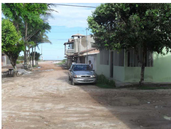
Foto 11: Área Crítica 2 – Av. Tancredo Neves – Área de alagamento.
