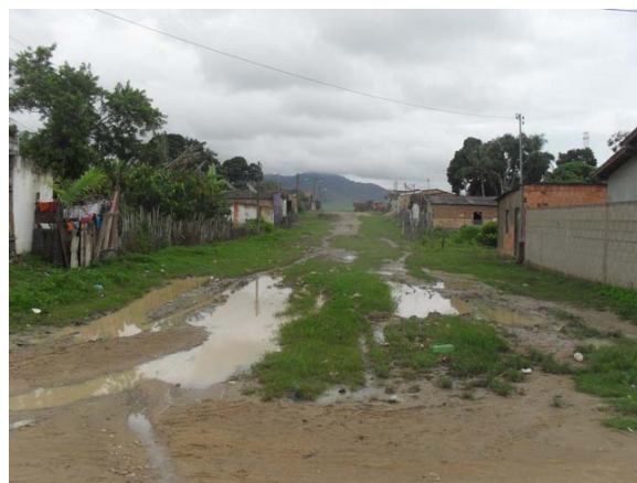
Foto 4: Área Crítica 2 – Rua Silvio Tosto Junior – área de alagamento.
