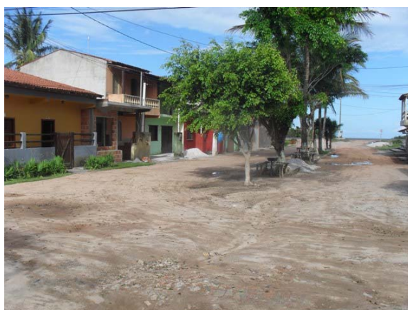
Foto 12: Área Crítica 2 – Av. Tancredo Neves – Área de alagamento.
