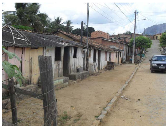
Foto 14: Área Crítica 4 – Rua Joeirana – área de inundação ribeirinha.
