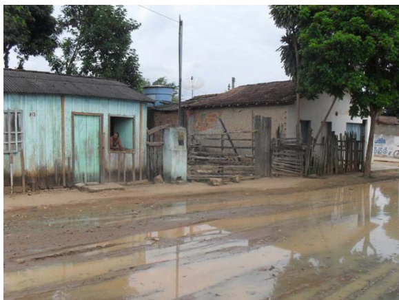
Foto 15: Área Crítica 2 – Rua Uruguaiana – área de alagamento.
