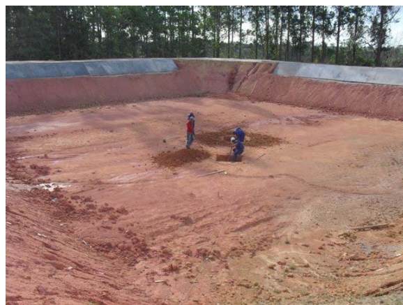
Foto 4: Nova lagoa aerada sendo construída.
