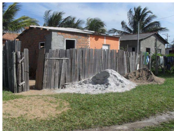
Foto 12: Área Crítica 2 – Rua C e D – área de alagamento.
