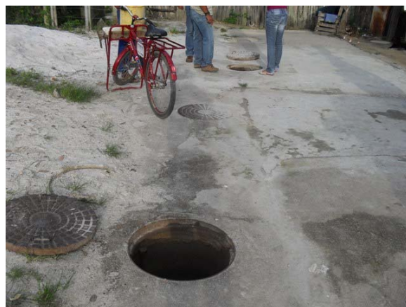
Foto 4: Aspecto geral de uma das elevatórias do SES.
