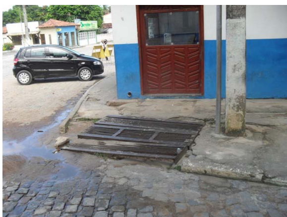
Foto 9: Área Crítica 1 – Rua Frei Henrique Coimbra – área de enxurrada.
