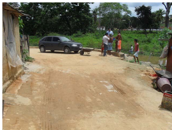
Foto 8: Área Crítica 2 – Rua Airton Senna – área de inundação ribeirinha.
