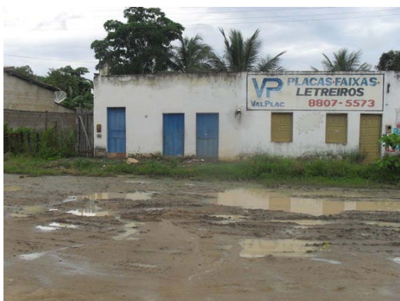
Foto 5: Área crítica 3 – Rua Valfrides Santana – área de alagamento.
