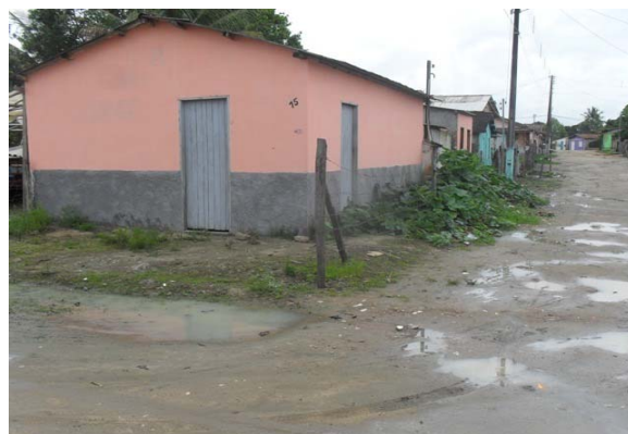
Foto 10: Área Crítica 4 – Rua 02 – área de alagamento (em frente a mercearia Leal).
