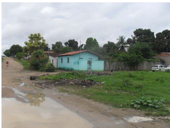
Foto 3: Área Crítica 1 – Rua Cipriano Carmona – área de alagamento.
