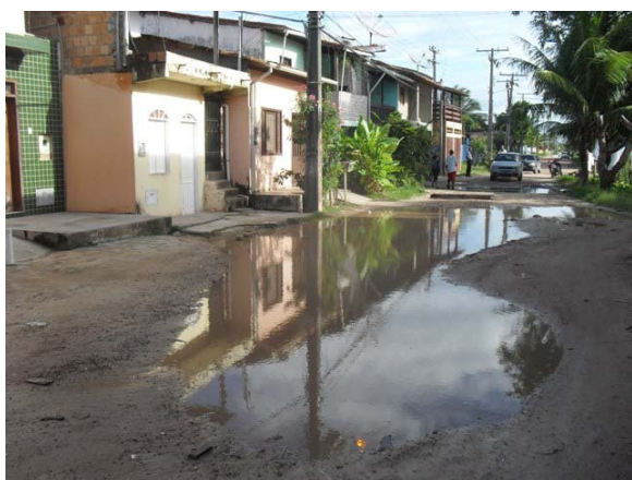
Foto 17: Área crítica 3 – Rua Paraju – área de alagamento.
