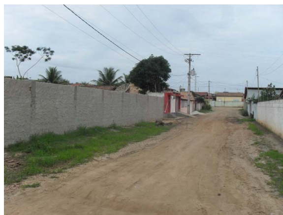
Foto 46: Área Crítica 10 – Rua E – área de alagamento.
