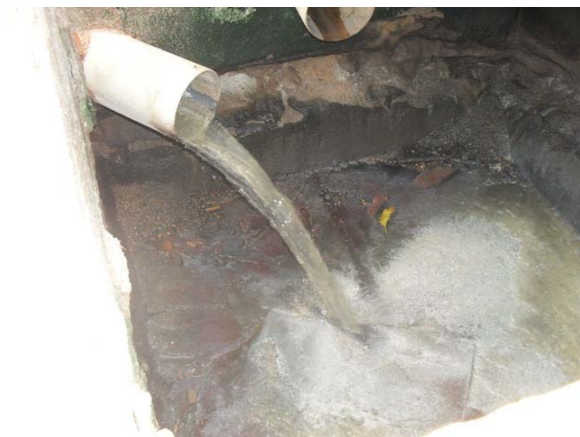
Foto 1: Aspecto geral do efluente da ETE Urbis II.
