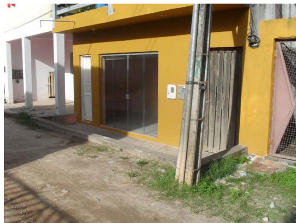
Foto 14: Área crítica 3 – Rua Paraju – área de alagamento.
