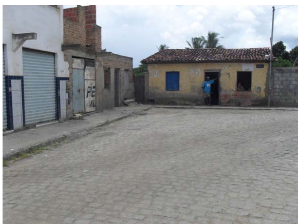
Foto 15: Área Crítica 2 – Rua Belmonte – área de inundação ribeirinha.
