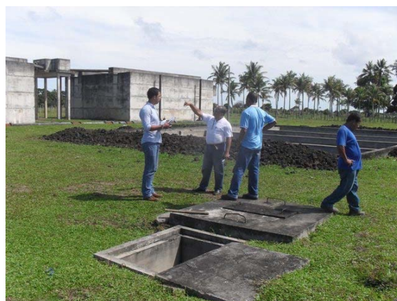
Foto 12: Vista geral do DAFA da ETE.
