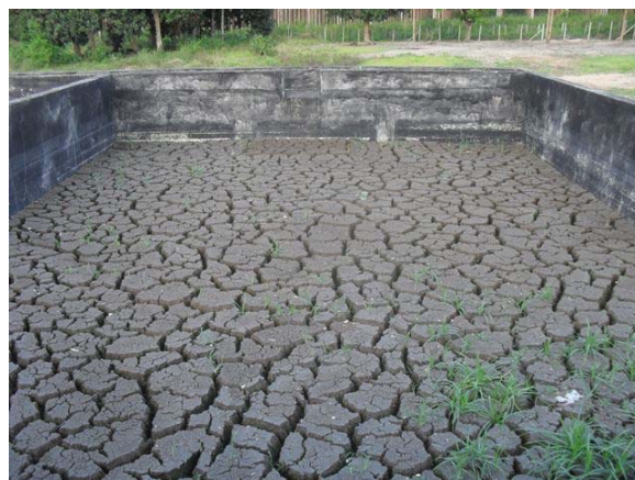
Foto 10: Leito de secagem usado no processo de tratamento de lodo.
