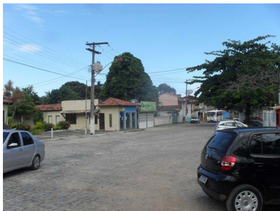
Foto 8: Área Crítica 1 – Rua Frei Henrique Coimbra – área de enxurrada.
