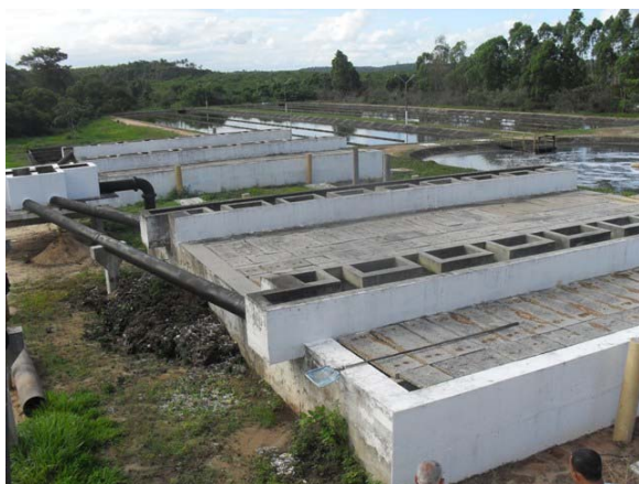
Foto 9: Visão geral da ETE.
