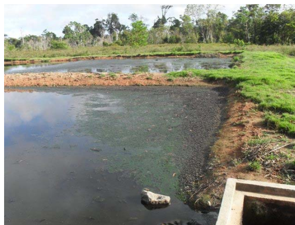
Foto 4: Aspecto geral das Lagoas de Macrófitas.
