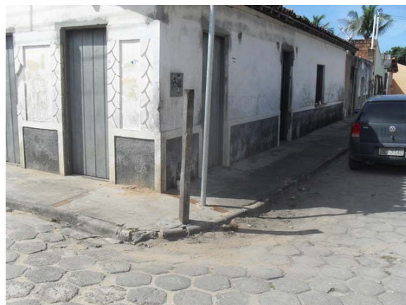
Foto 6: Área Crítica 1 – Rua General Osório – área de alagamento.
