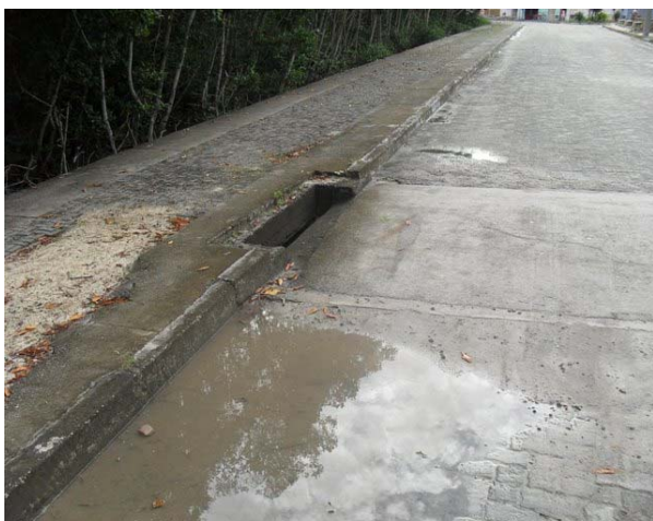
Foto 5: Final da galeria rua Norte Sul.
