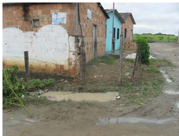
Foto 8: Área Crítica 4 – Rua 02 – área de alagamento.
