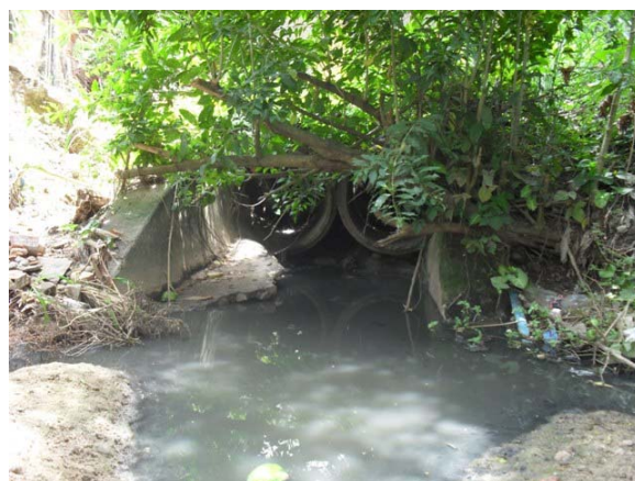
Foto 10: Final das manilhas de drenagem de DN 1000 mm.
