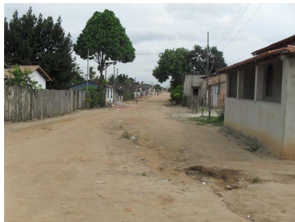
Foto 22: Área Crítica 3 – Rua do Bairro Bandeirante – área de alagamento.
