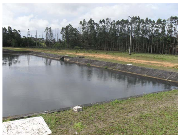
Foto 10: Lagoa aerada com aerador parado.
