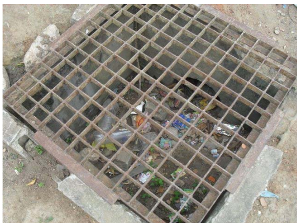
Foto 5: Grande quantidade de resíduos sólidos lançados na caixa coletora.
