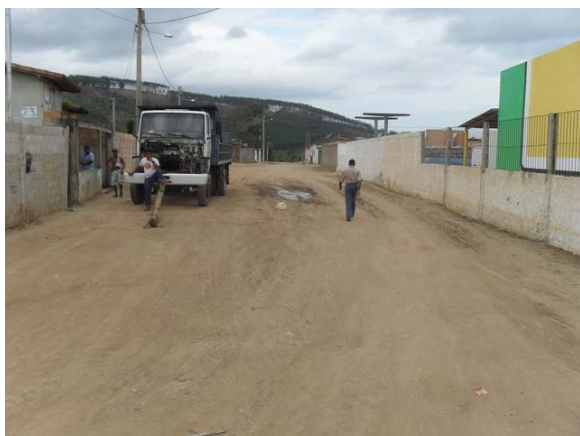
Foto 31: Área Crítica 5 – Rua Porto Seguro (Bairro do Pereirão) – área de alagamento.
