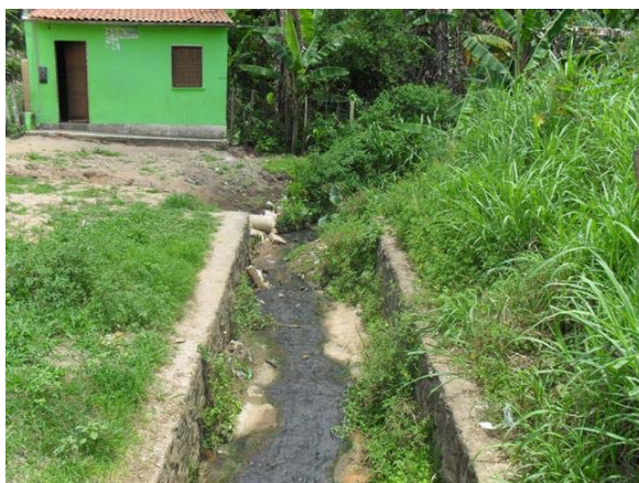
Foto 3: Canal da Rua Belmonte.
