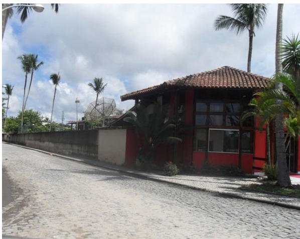
Foto 9: Área crítica 2, caracterizada pela ocorrência freqüentes alagamentos.
