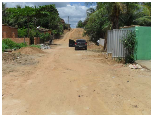
Foto 10: Área Crítica 3 – Rua Marcelino Senna – área de alagamento.
