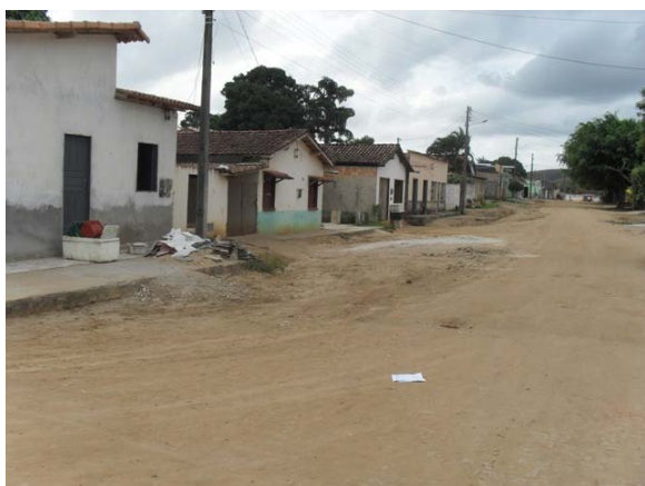
Foto 33: Área Crítica 6 – Rua do Asilo – área de alagamento.
