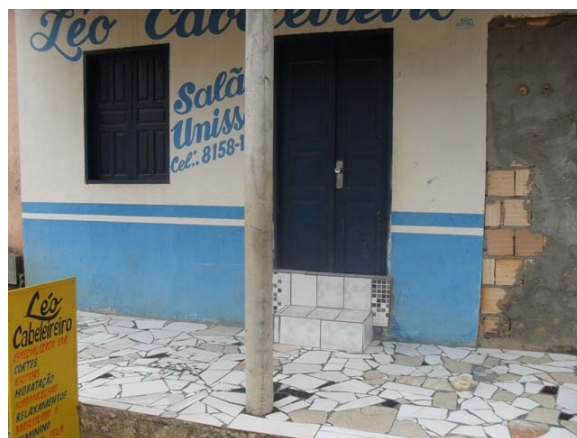
Foto 36: Área Crítica 6 – Rua do Asilo – área de alagamento.
