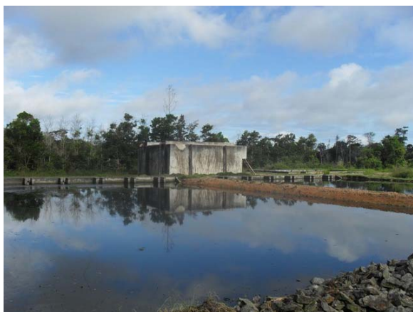
Foto 5: Aspecto geral das Lagoas de Macrófitas.
