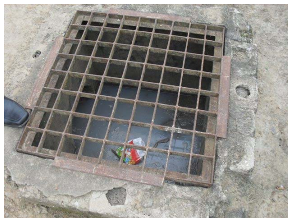
Foto 6: Grande quantidade de resíduos sólidos lançados na caixa coletora.
