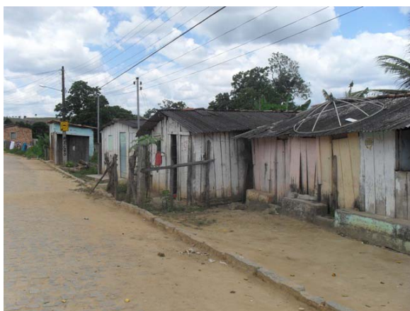
Foto 13: Área Crítica 4 – Rua Joeirana – área de inundação ribeirinha.
