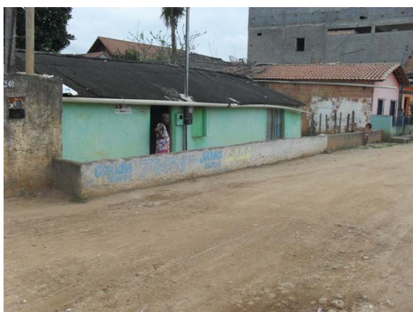
Foto 17: Área Crítica 3 – Rua do Bairro Bandeirante – área de alagamento.
