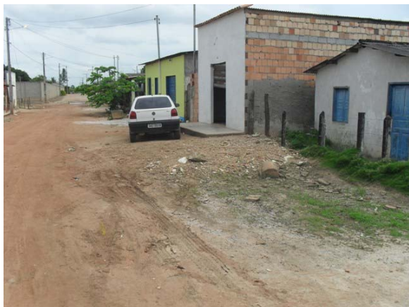
Foto 21: Área Crítica 3 – Rua do Bairro Bandeirante – área de alagamento.
