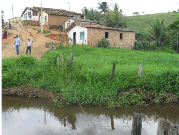
Foto 15: Área Crítica 5 – Rua Nabuco – área de inundação ribeirinha.
