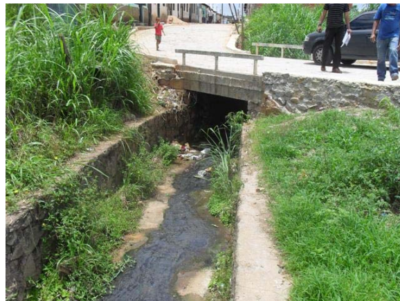
Foto 2: Canal da Rua Belmonte.
