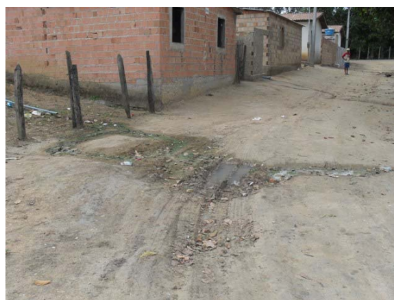
Foto 28: Área Crítica 4 – Rua Caminho 5 – área de alagamento (Bairro Dapezão).
