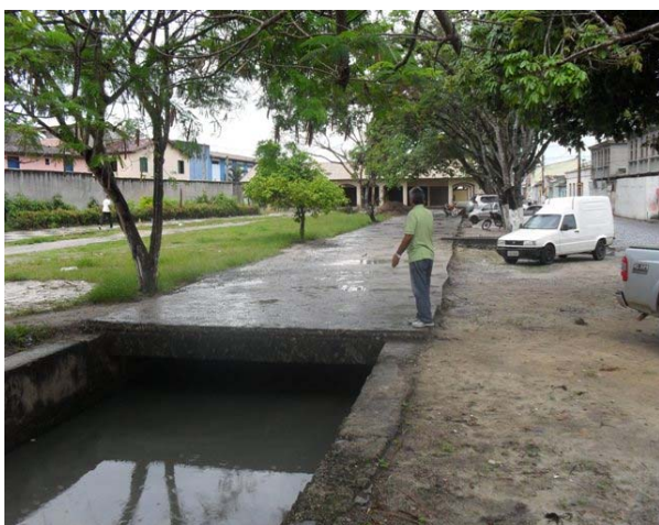
Foto 3: Trecho coberto do final da Rua da Vala.
