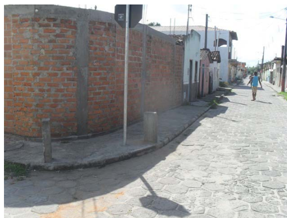
Foto 10: Área Crítica 1 – Rua General Osório – área de alagamento.
