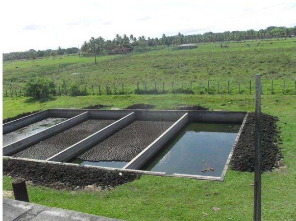
Foto 7: Leitos de secagem da ETE.
