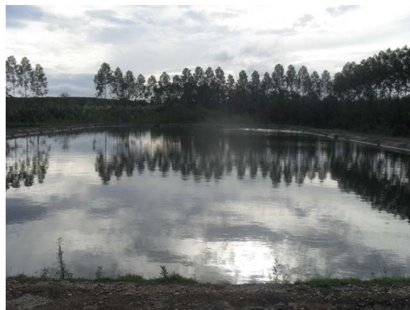
Foto 2: Aspecto geral das lagoas da ETE.
