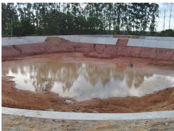
Foto 5: Nova lagoa aerada sendo construída.
