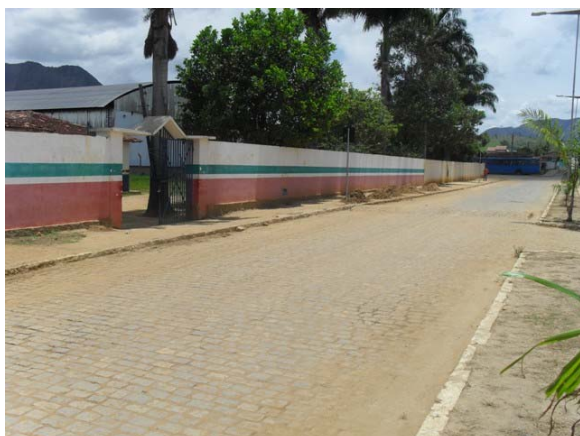
Foto 7: Área Crítica 1 – Av. Antônio Carlos Magalhães – área de alagamento.
