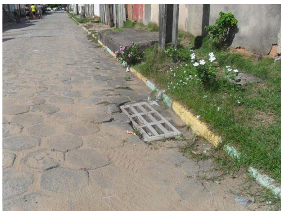
Foto 3: Estrutura de microdrenagem em bom estado de conservação.
