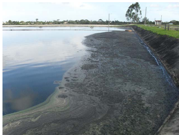
Foto 2: Aspecto geral da lagoa aerada de mistura parcial.
