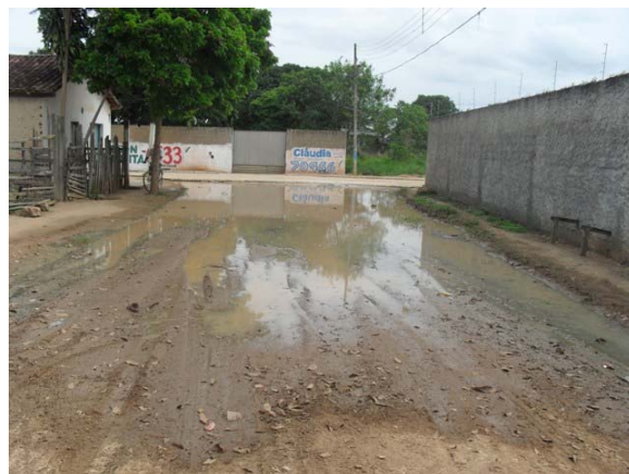
Foto 16: Área Crítica 2 – Rua Uruguaiana – área de alagamento.
