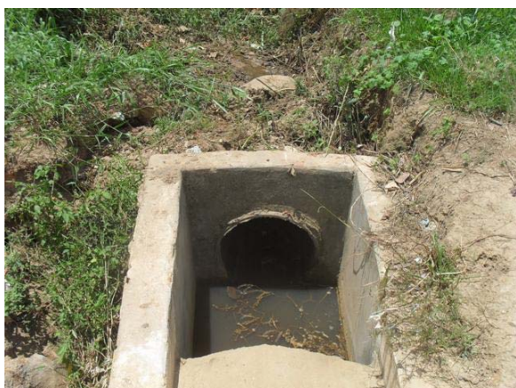
Foto 3: Bueiro situado na Av. Antônio Carlos Magalhães.
