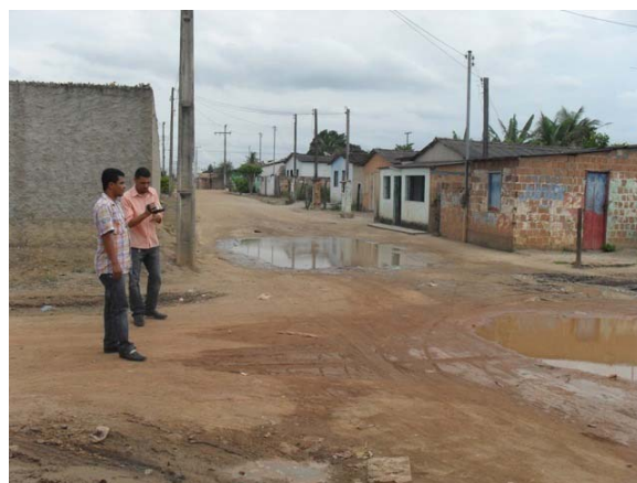
Foto 24: Área Crítica 3 – Rua do Bairro Bandeirante – área de alagamento.
