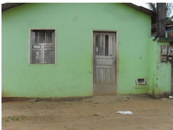
Foto 45: Área Crítica 9 – Rua da Felicidade – área de alagamento.
