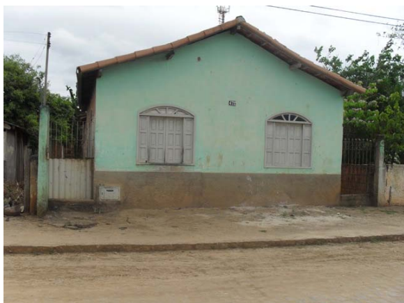
Foto 37: Área Crítica 6 – Rua do Asilo – área de alagamento.
