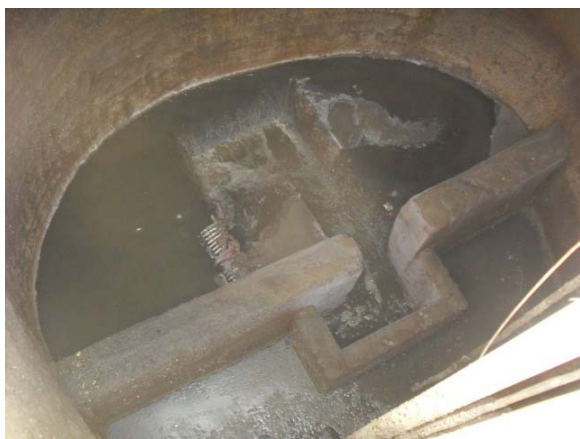
Foto 9: Poço de sucção da EE-06.
