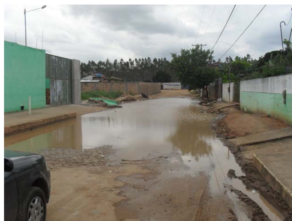
Foto 42: Área crítica 8 – Rua Antônio Carlos Magalhães – área de alagamento.
