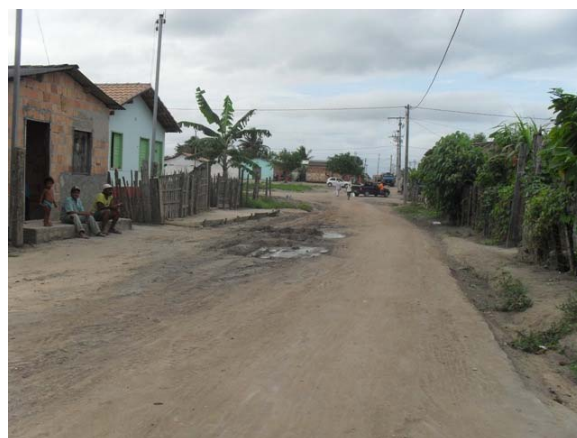
Foto 54: Área Crítica 12 – Rua C – área de alagamento.
