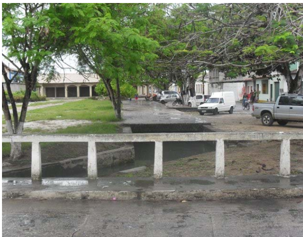
Foto 1: Canal rua da vala.
