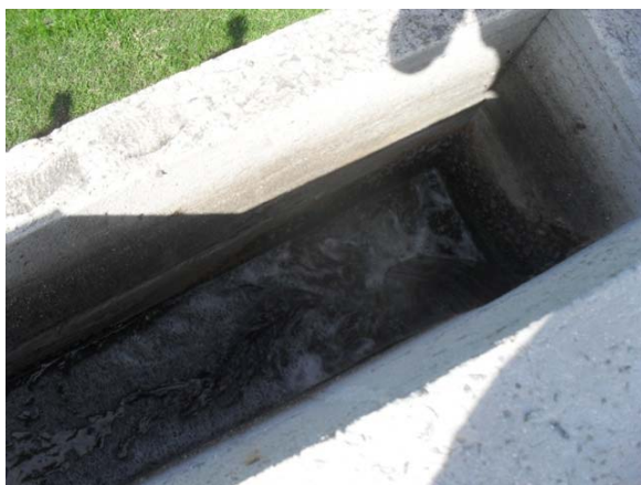
Foto 15: Vista geral do DAFA da ETE.
