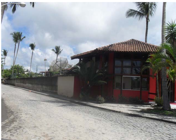
Foto 9: Área crítica 2, caracterizada pela ocorrência freqüentes alagamentos.
