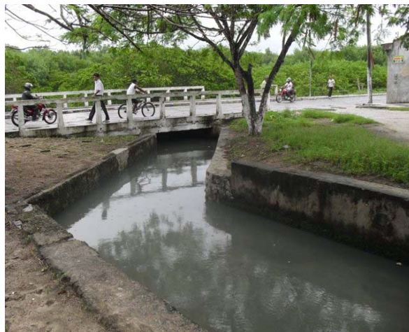
Foto 2: Estrangulamento no final da Rua da Vala.
