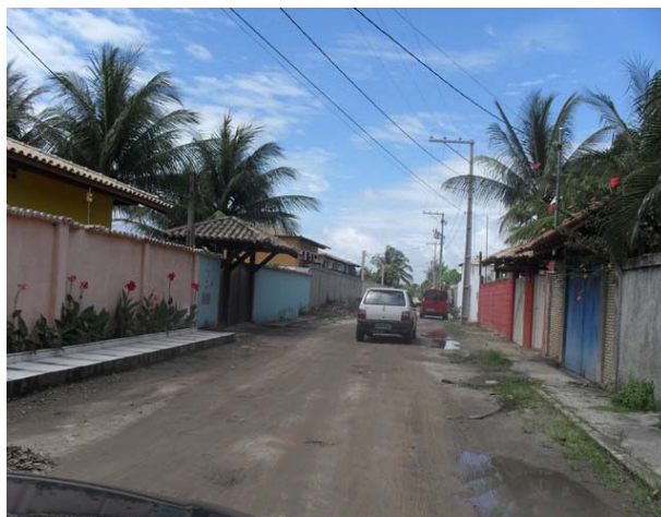
Foto 10: Área crítica 3, caracterizada pela ocorrência de freqüentes alagamentos.
