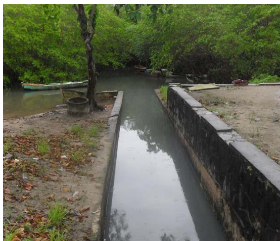
Foto 6: Final do Canal da Rua das Pitangueiras.
