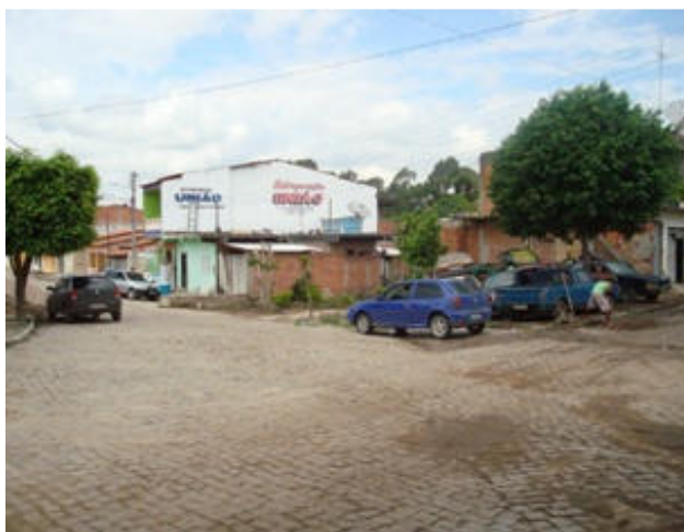
Foto 9: Vista Rua do Cromo, área Crítica 3, caracterizada por freqüentes enxurradas.
