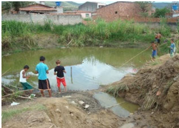
Foto 1: Área Crítica 1, atingida por freqüentes enxurradas.
