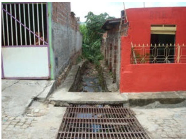
Foto 13: Vista canal sob Rua Renato Reis, área crítica 4, caracterizada por freqüentes enxurradas.
