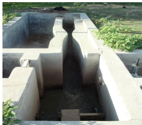
Foto: Estação de Tratamento de Esgotos de Pilar_2 Coord. N: 393376 Coord. E: 8905754
