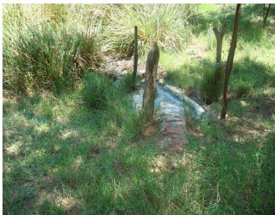
Foto 1: Unidade de tratamento inoperante.
