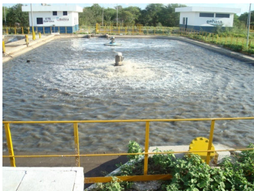
Foto: Estação de Tratamento de Esgotos de Pilar Coord. N: 393376 Coord. E: 8905754
