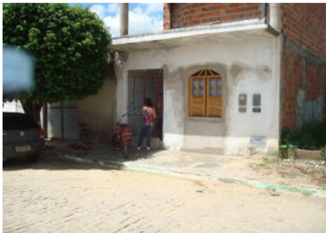
Foto 1: Praça Luiz Eduardo Magalhães , área crítica 1 , caracterizada por freqüentes alagamentos.
