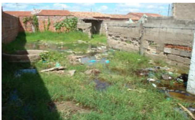
Foto 5: Rua João Bacelar área crítica 5 , caracterizada por freqüentes alagamentos.
