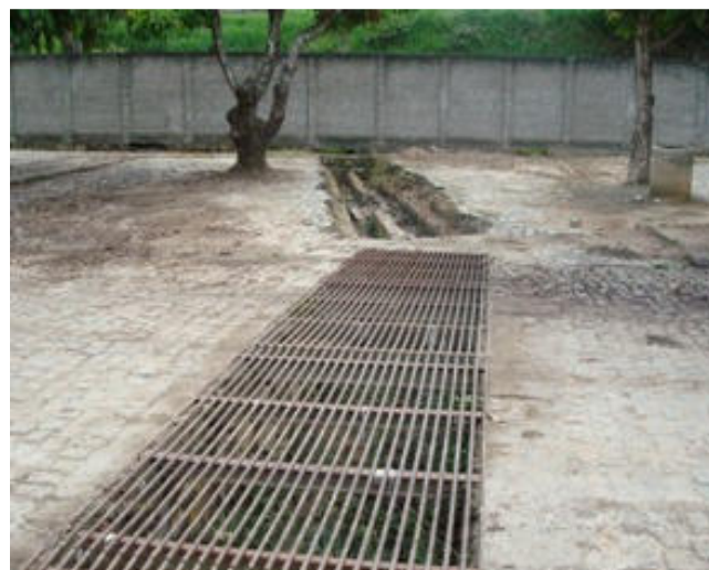
Foto 12: Vista canal sob Rua Renato Reis, área crítica 4, caracterizada por freqüentes enxurradas.
