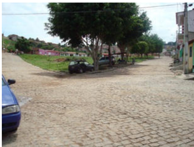
Foto 10: Vista Rua do Cromo, área Crítica 3, caracterizada por freqüentes enxurradas.
