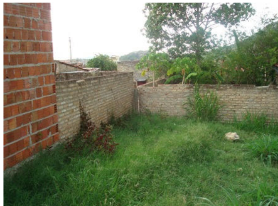
Foto 2: Rua Gilberto Gil – imóvel invadido em épocas de chuva - muro refeito.
