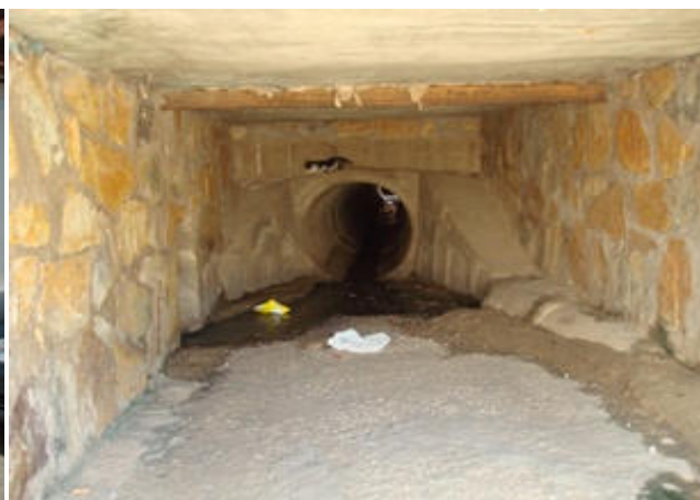
Foto 4: Vista do bueiro na Rua Princesa Izabel.
