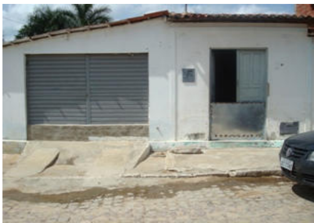
Foto 3: Vista das casas protegidas das águas.
