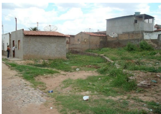
Foto 3: Rua Alto da Serra – início da galeria retangular passando por trás dos imóveis.
