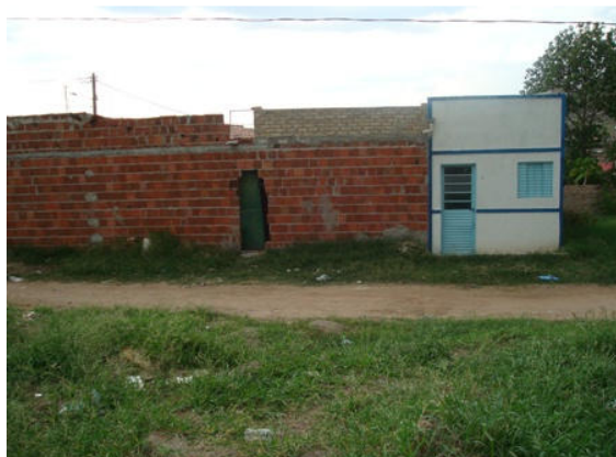
Foto 1: Rua Gilberto Gil – imóvel invadido em épocas de chuva – parede refeita.
