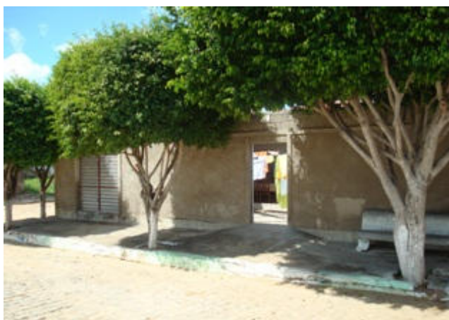
Foto 3: Praça Luiz Eduardo Magalhães, área crítica 1 , caracterizada por freqüentes alagamentos.
