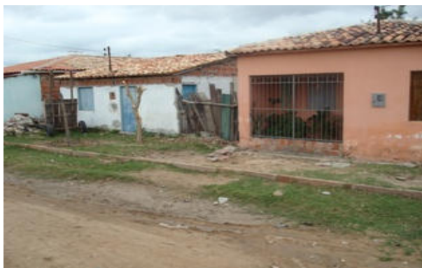
Foto 5: Área crítica 3, casas atingidas por enxurradas.
