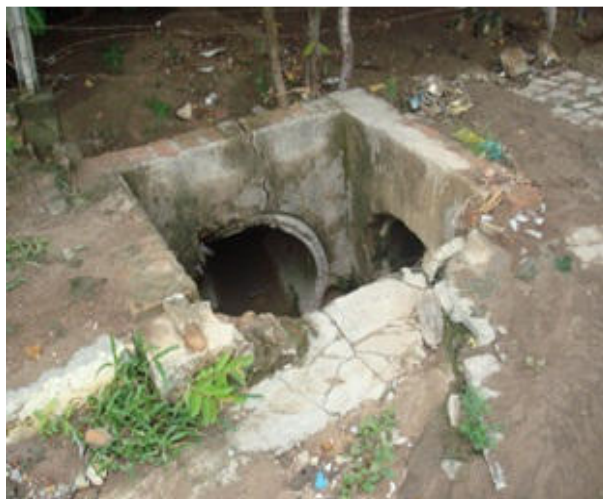
Foto 4: Vista da caixa de captação da Rua Cristal.
