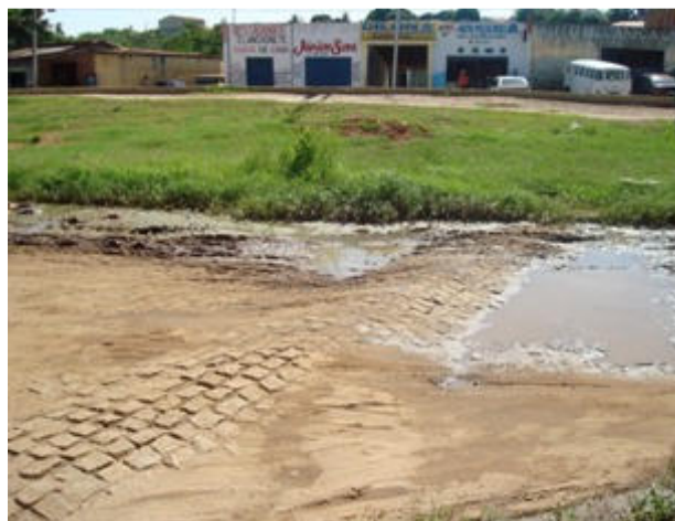
Foto 14: Vista Av Tancredo Neves, área crítica 5, caracterizada por freqüentes alagamentos.
