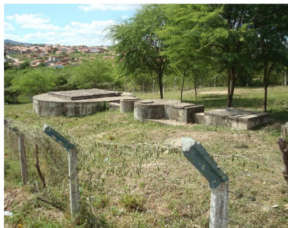
Foto: ETE abandonada – Bairro Barbosa Santos
