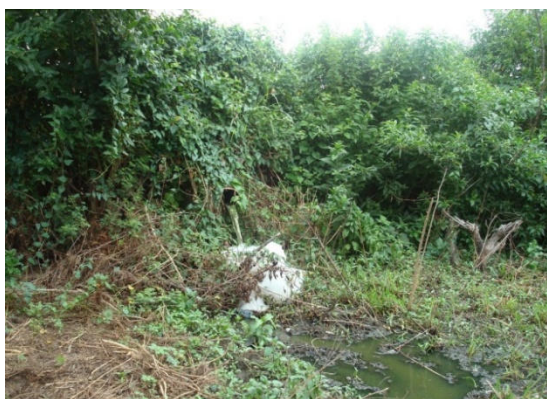
Foto 5: Lançamento do efluente da ETE em terreno natural.
