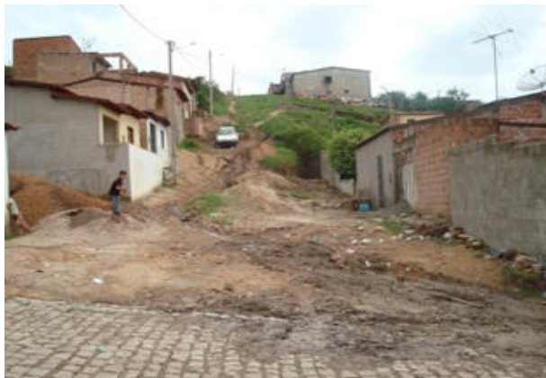
Foto 1: Vista da Rua Cristal, área crítica 1. Caracterizada por freqüentes enxurradas.
