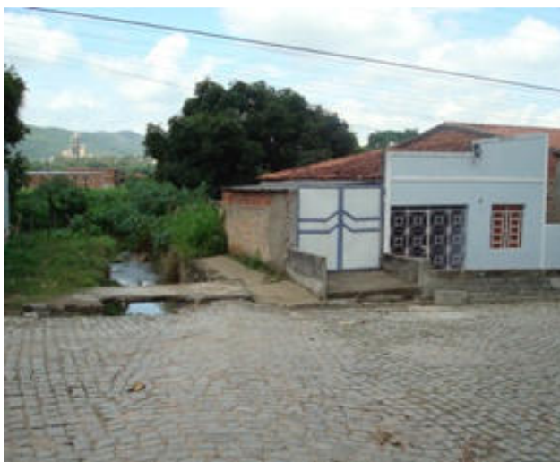
Foto 11: Vista canal sob Rua Renato Reis, área crítica 4, caracterizada por freqüentes enxurradas.
