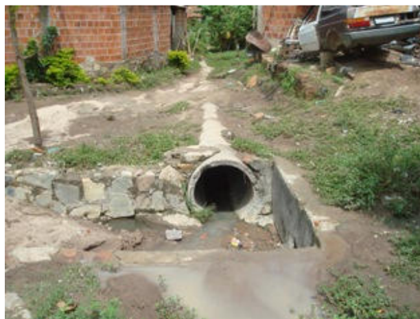
Foto 8 : Vista caixa captação Rua do Cromo. Área Crítica 3, caracterizada por freqüentes enxurradas.
