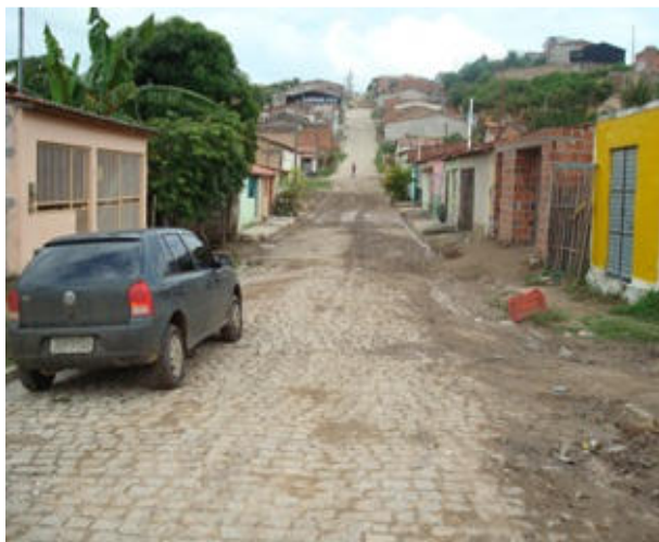
Foto 3: Vista da Rua Cristal, área crítica 1. Caracterizada por freqüentes enxurradas.
