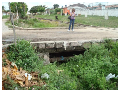
Foto 2: Canal natural sob a Av. Catuni – detalhe da rede de distribuição atravessando a seção do canal.
