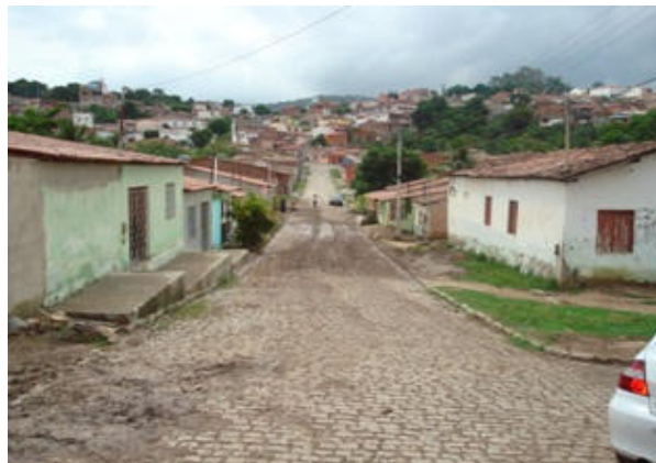
Foto 2: Vista da Rua Cristal, área crítica 1. Caracterizada por freqüentes enxurradas.
