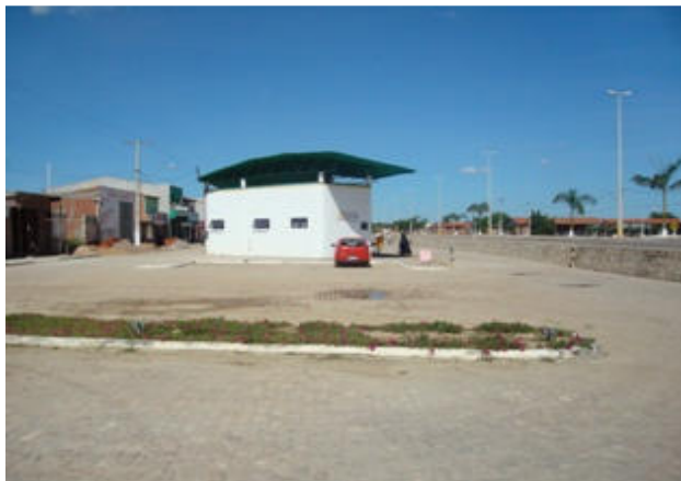
Foto 1: Área crítica 1, Estação Rodoviária , ponto de alagamento.
