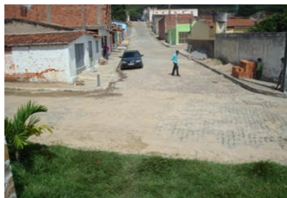
Foto 6: Vista do ponto baixo na Rua Princesa Izabel.
