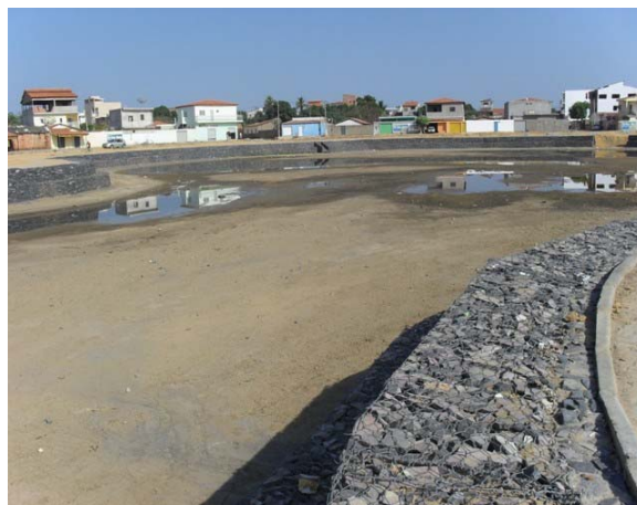
Foto 26: Lagoa de São Gotardo – obra de urbanização em andamento.
