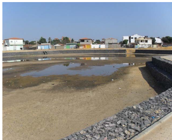
Foto 24: Lagoa de São Gotardo – obra de urbanização em andamento.
