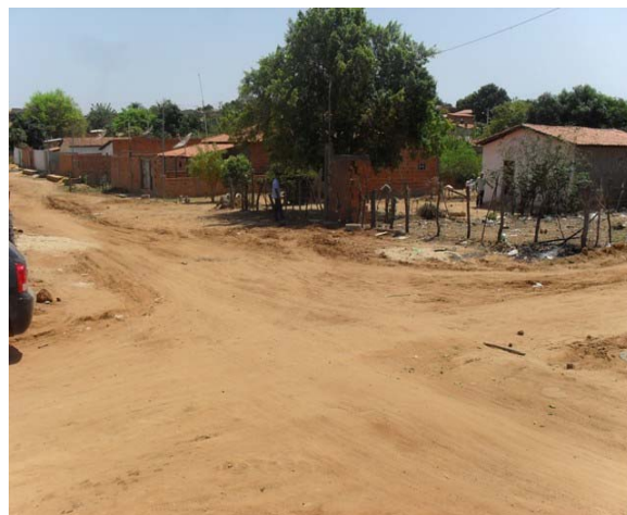
Foto 22: Área Crítica 5 – Bairro Parque Verde – Rua Pedro Américo – área de enxurrada e alagamento.
