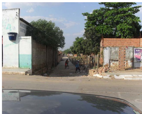
Foto 6: Canal 1 – construção em concreto.
