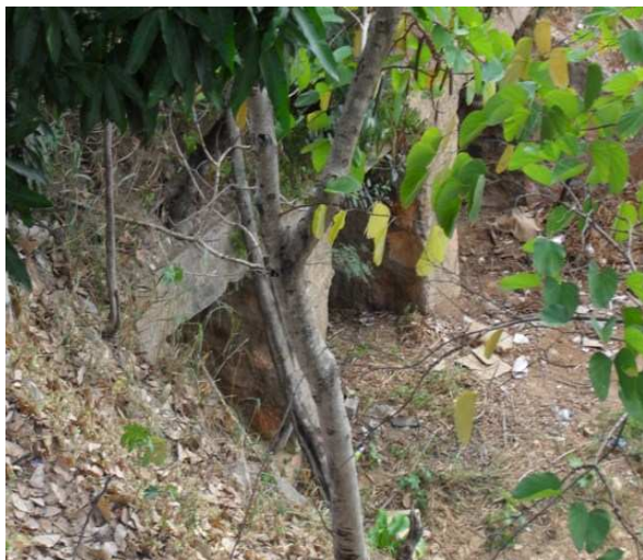
Foto 1: Bueiro em canal de macrodrenagem.
