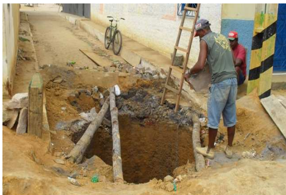
Foto 1: Construção de fossa comunitária pela Prefeitura – escavação.
