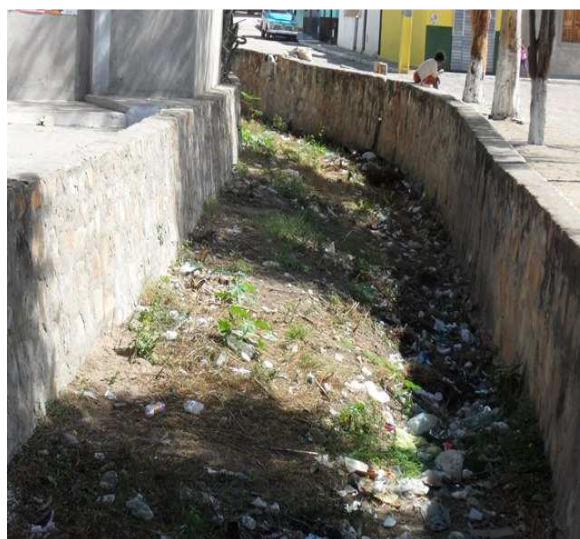
Foto 4: Canal de macrodrenagem.
