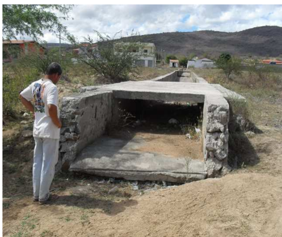
Foto 7: Fim da galeria de alvenaria da Rua Bahia.
