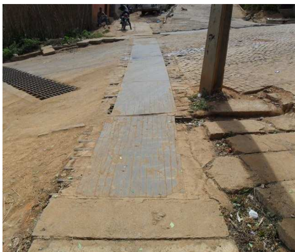
Foto 7: Canaleta de drenagem com grelha e rede de esgoto com tampa.
