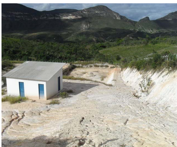
Foto 11: ETE 2 – abandonada – lagoa e DAFA
