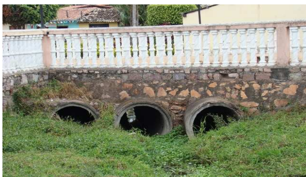
Foto 5: Ponto de estrangulamento 2 do canal 5 – passagem sob a Rua Santa Isabel.
