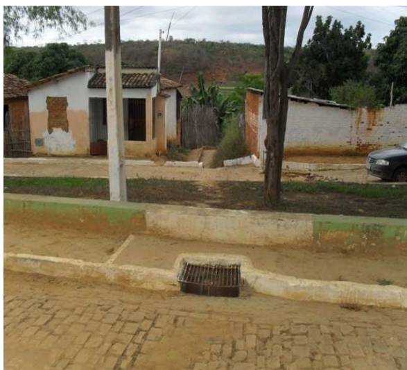
Foto 9: Elemento de microdrenagem – caixa com grelha.
