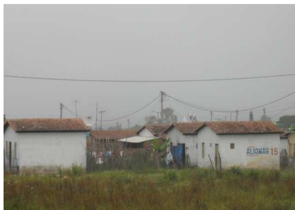
Foto 6: Conjunto residencial construído em terreno alagadiço, sem drenagem.
