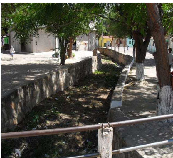
Foto 3: Canal de macrodrenagem.
