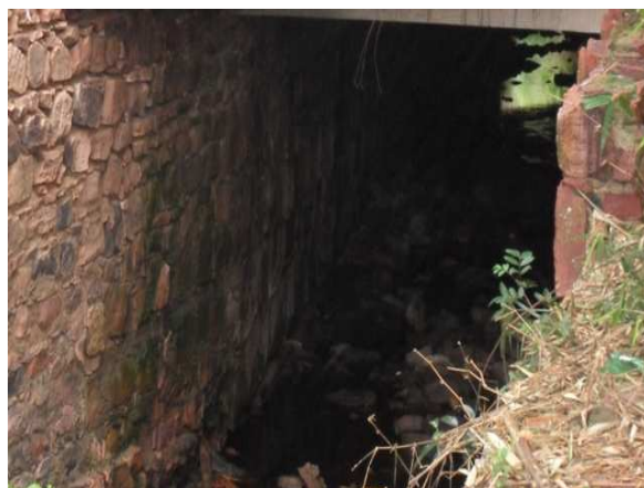
Foto 4: Canal de macrodrenagem dentro de lotes.
