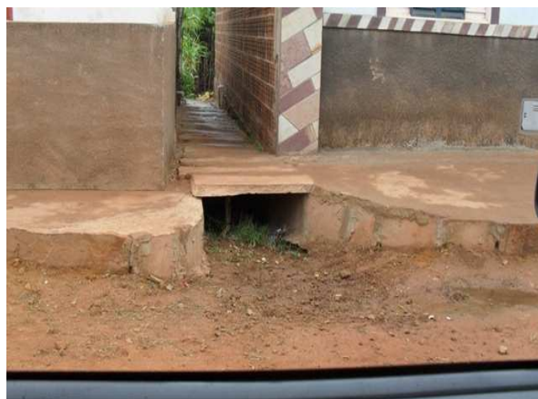
Foto 10: Galeria de drenagem entre lotes.
