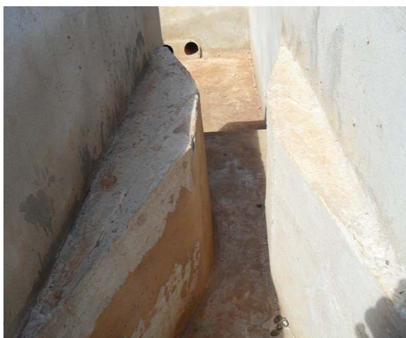
Foto 5: ETE - Calha Parshall sem uso.
