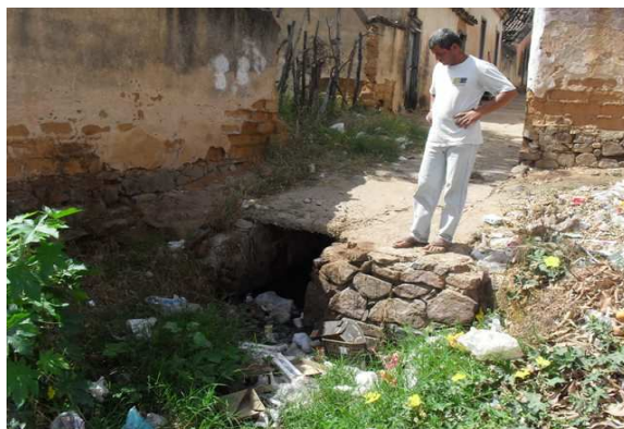
Foto 12: Ponto final da galeria de alvenaria de pedra (0,60 x 0,080)
