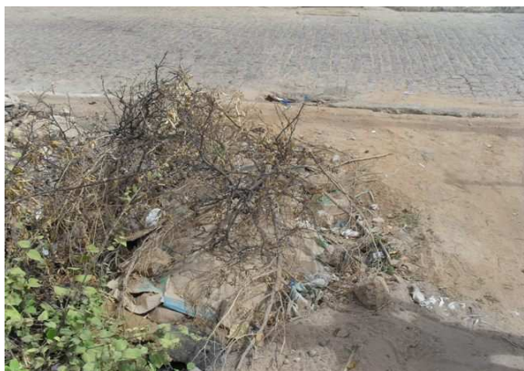
Foto 10: Galeria atravessando a Rua Antonio Carlos Magalhães – No seu início possui proteção feita de papelão, muito mau cheiro.
