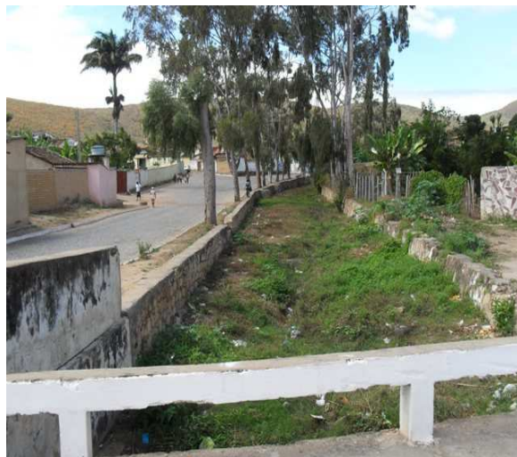
Foto 2: Canal de macrodrenagem.
