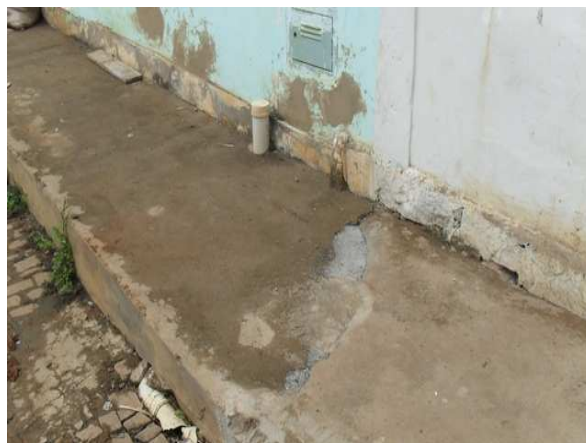
Foto 4: Fossa executada no passeio.
