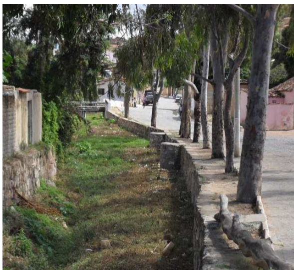
Foto 7: Canal de macrodrenagem – PVs do interceptor da EMBASA.
