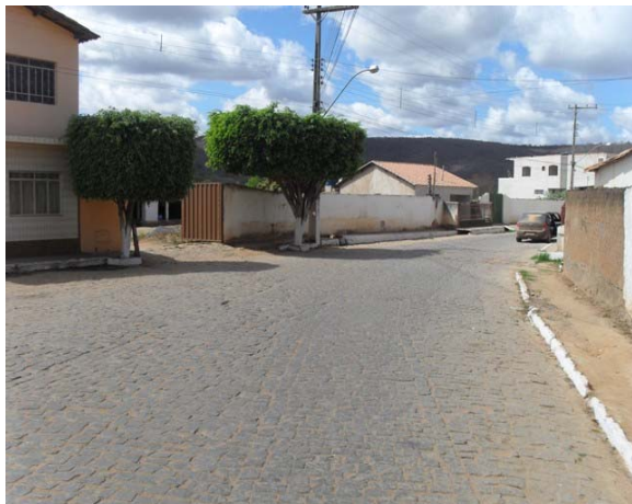
Foto 1: Área crítica 1 – Av. Moreira – em tempo de chuva a água já atingiu 1 m de altura invadindo as casas.
