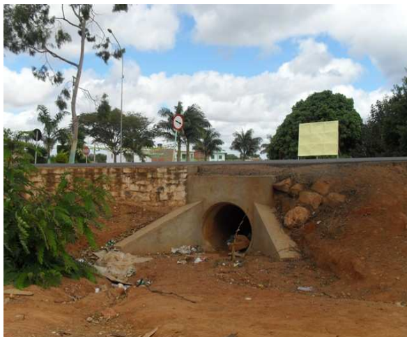
Foto 2: Bueiro sob a BR 122.
