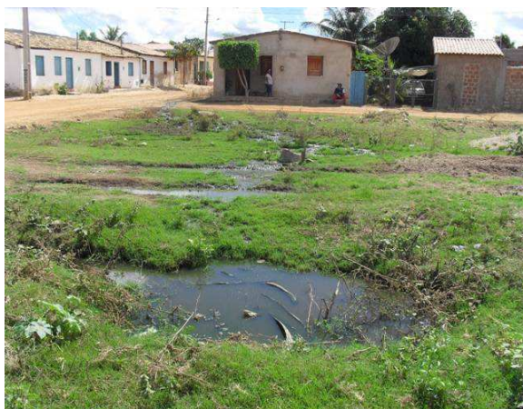
Foto 3: Ponto de lançamento de esgoto – Bairro do Campo.
