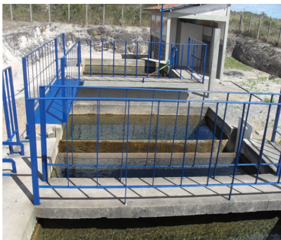
Foto 5: Vista da ETA
