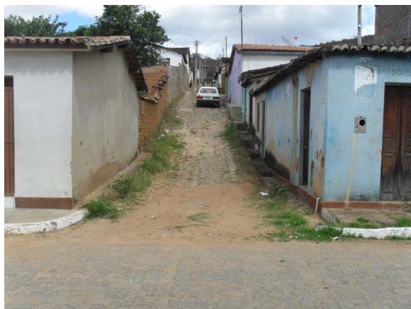
Foto 8: Área crítica 2 – Rua Dr. Lafaiete Coutinho – local de enxurrada .
