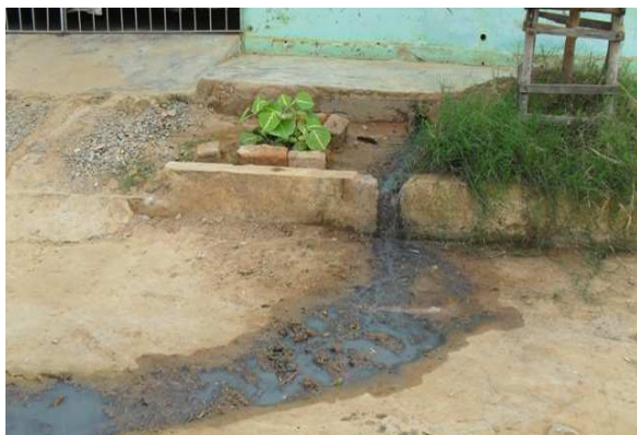
Foto 5: Esgoto secundário a céu aberto lançado em ruas sem pavimentação.
