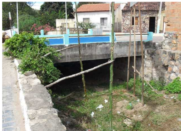
Foto 6: Detalhes do canal de macrodrenagem e bueiro.
