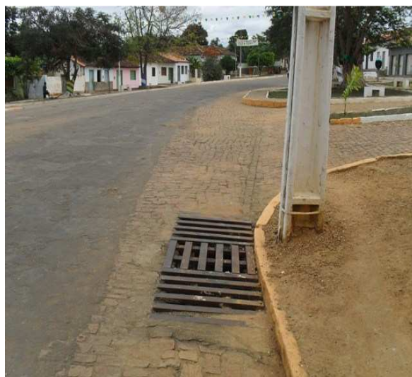
Foto 10: Elemento de microdrenagem – vista de caixa com grelha.
