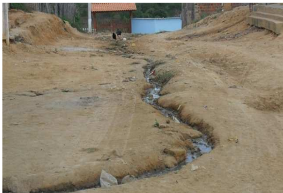
Foto 7: Esgoto secundário a céu aberto lançado em ruas sem pavimentação.
