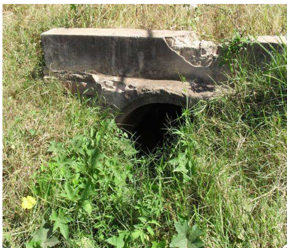
Foto 5: Estrutura obstruída.
