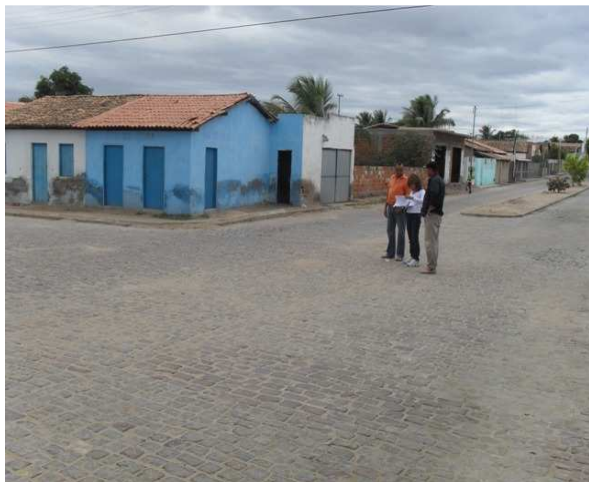
Foto 1: Rua Renato Almeida com Rua Sem Nome – 1ª área crítica.
