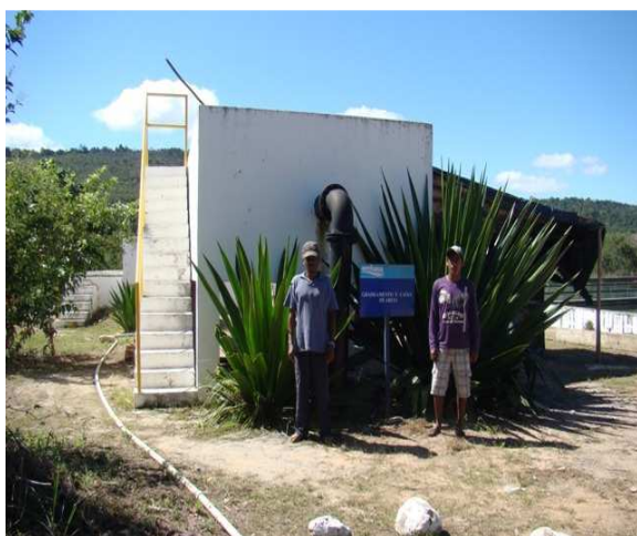
Foto 7: Gradeamento e caixa de areia
