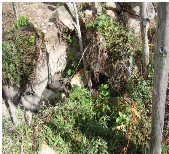
Foto 2: Rua Coronel José Xavier – saída de esgoto e drenagem
