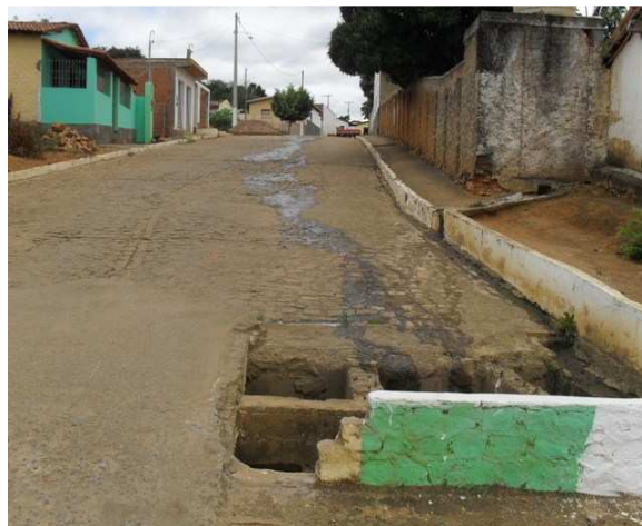
Foto 2: Caixa coletora de água pluvial – detalhes.
