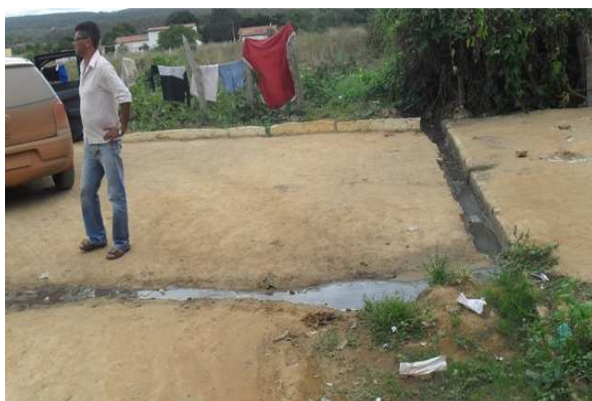
Foto 15: Vala de esgoto secundário em rua pavimentada.
