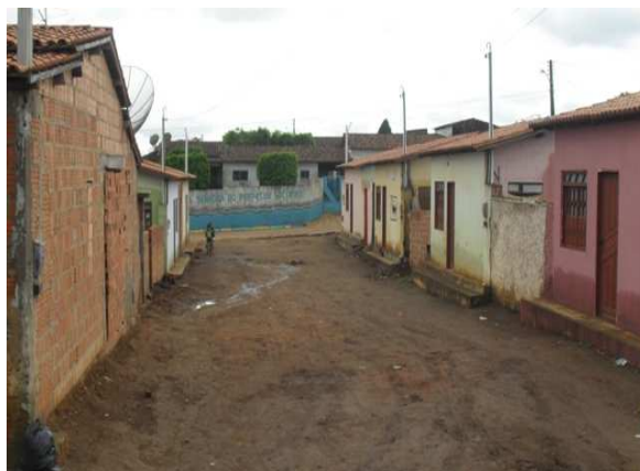
Foto 2: Esgoto a céu aberto.
