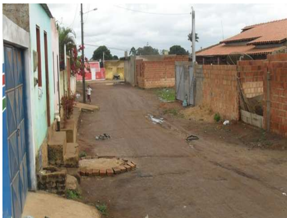
Foto 3: Fossa executada no leito da rua.
