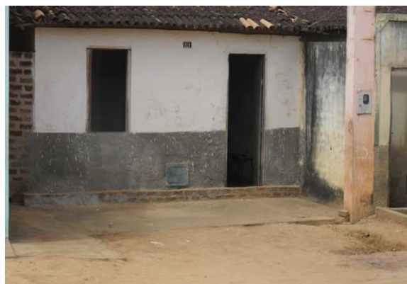
Foto 28: Proteção em casa contra alagamento.
