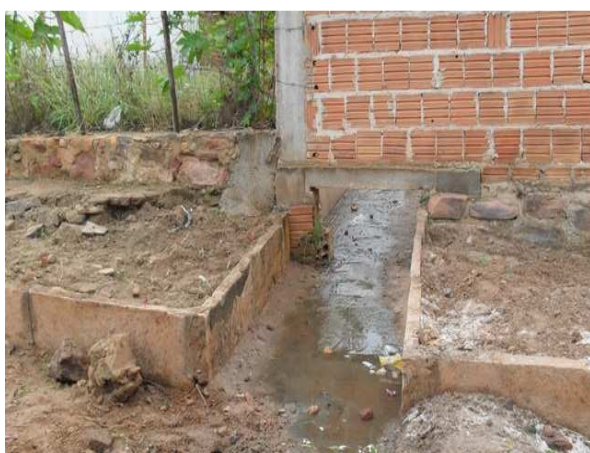
Foto 12: Passagem de águas pluviais por lote.
