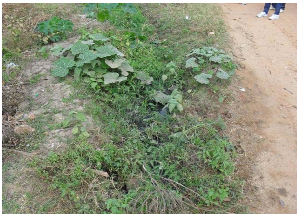
Foto 5: Ponto de lançamento de esgoto – Rua do Triângulo – canal natural para o pasto.
