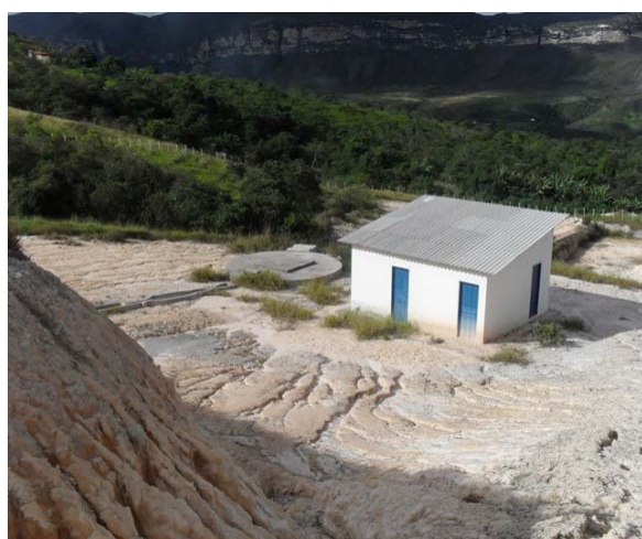
Foto 12: ETE 2 – abandonada – lagoa e DAFA
