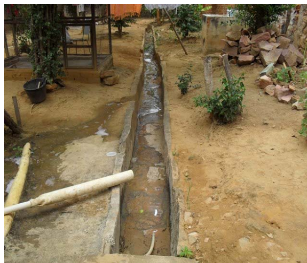
Foto 4: Galeria de drenagem recebendo esgoto secundário.
