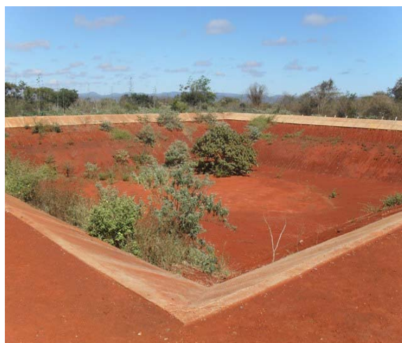
Foto 6 – ETE – lagoa anaeróbia.
