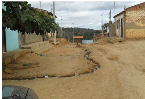
Foto 8: Esgoto secundário a céu aberto lançado em ruas sem pavimentação.
