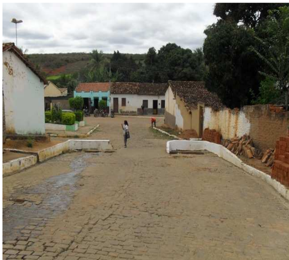
Foto 3: Vista da caixa coletora de água pluvial.
