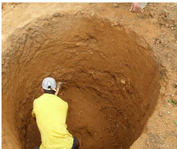
Foto 1: Construção de fossa para esgoto secundário.
