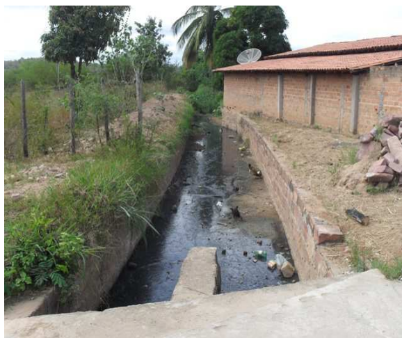
Foto 8: Galeria em alvenaria de pedra (2,60 x 1,00) – recebe esgoto.
