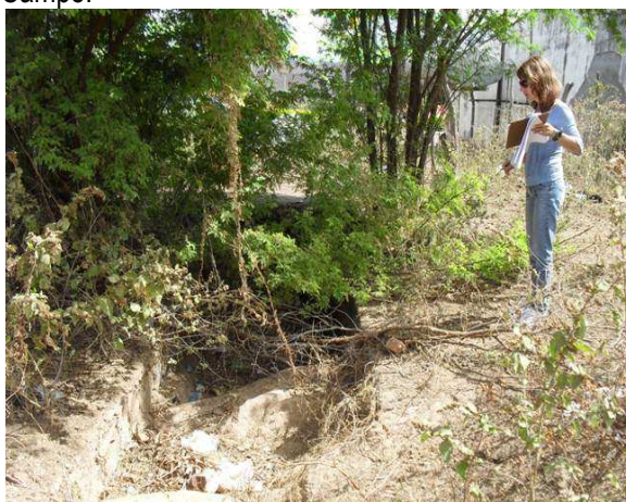
Foto 5: Final da galeria em alvenaria (1,00 x 0,60) - esgoto primário e secundário.
