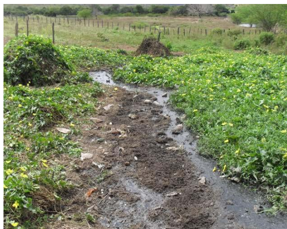
Foto 2: Esgoto lançado no pasto.
