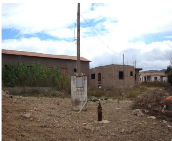
Foto 3: Poço de abastecimento.
