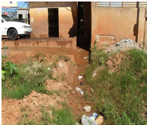
Foto 2: Drenagem do posto de lavagem de veículos – lançamento em direção da lagoa.
