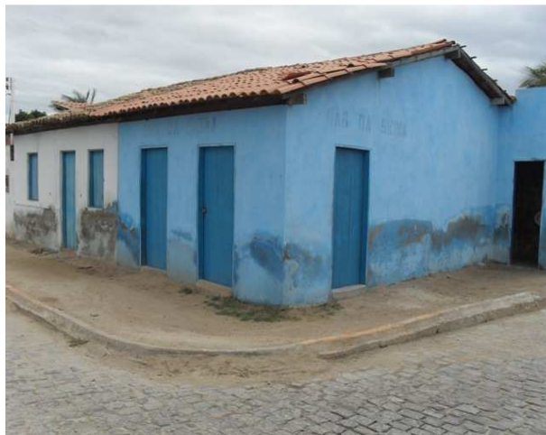
Foto 2: Rua Renato Almeida com Rua Sem Nome – 1ª área crítica.
