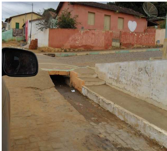
Foto 4: Elemento de microdrenagem – canaleta.
