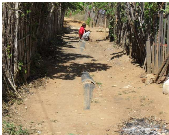
Foto 4: Tubulação de esgoto.
