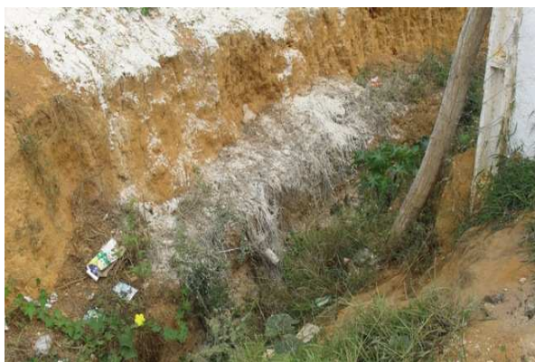
Foto 11: lançamento de esgoto em vala a céu aberto.
