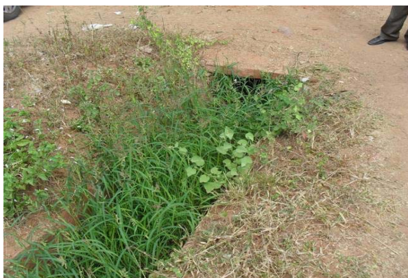
Foto 5: Ponto de lançamento de esgoto e águas pluviais – deságua no rio que sai ao lado da Igreja.
