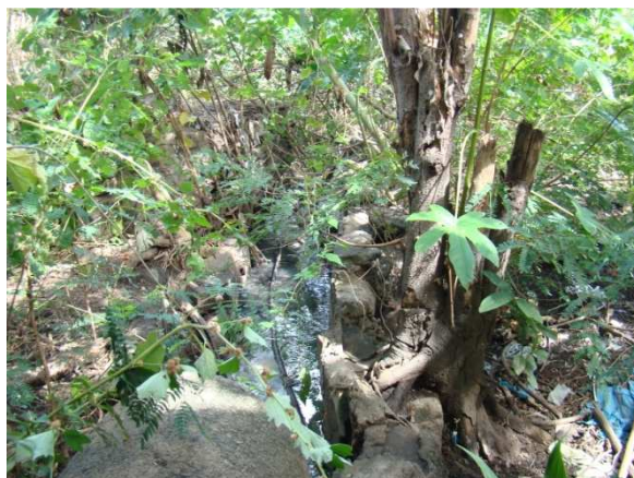
Foto 4: Rua da Boa Noite – saída de esgoto em rede mista
