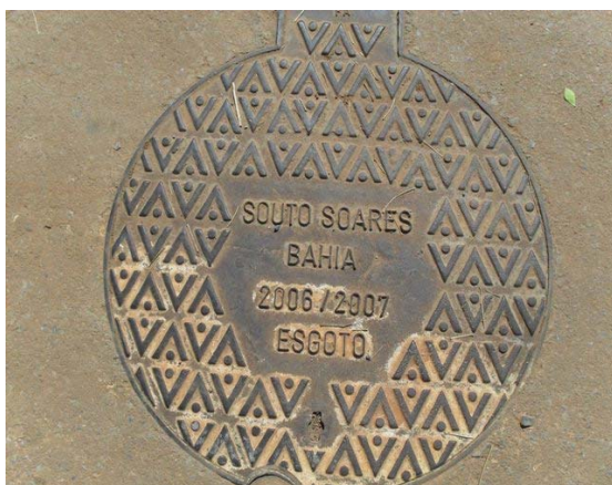
Foto 17 – Tampão de PV com identificação do ano da obra.
