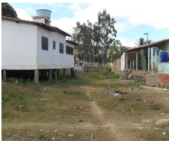
Foto 10: Edificações irregulares dentro da calha do canal.
