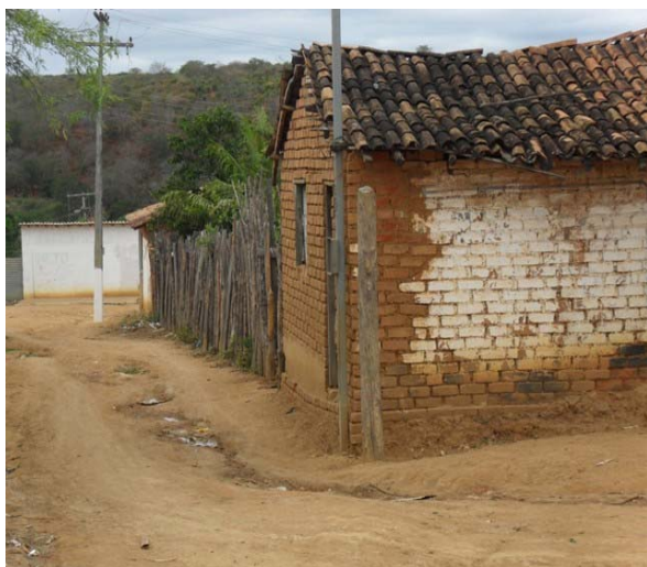
Foto 3: Esgoto secundário lançado a céu aberto.
