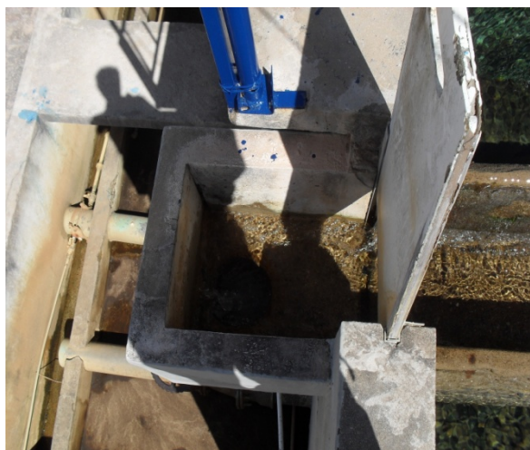
Foto 6: Vista da ETA
