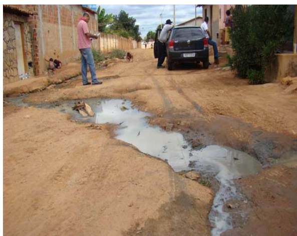
Foto 1: Esgoto secundário a céu aberto.
