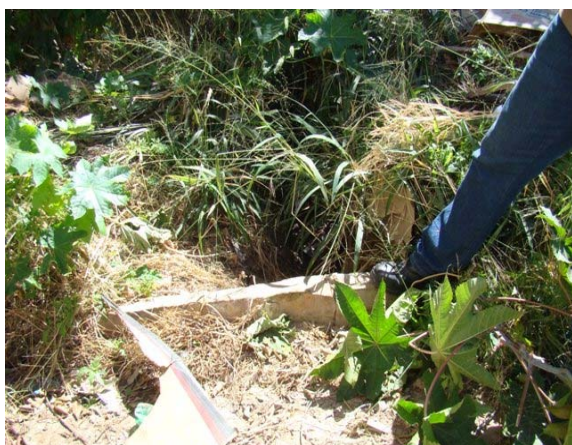
Foto 5: Rua Recanto Feliz – descarte de esgoto secundário.
