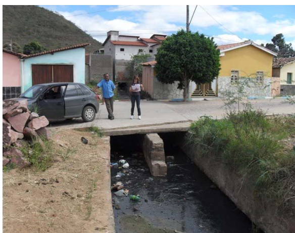
Foto 3: Galeria em alvenaria de pedra (2,60 x 1,00) – recebe esgoto.
