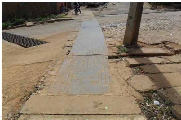
Foto 6: Canaleta de drenagem com grelha e rede de esgoto com tampa.
