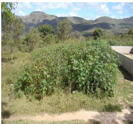
Foto 3: BA 148 – Km 93 – Bairro do Rosário – saída de esgoto misto.
