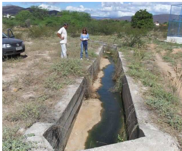
Foto 2: Fim da galeria de alvenaria da Rua Bahia.
