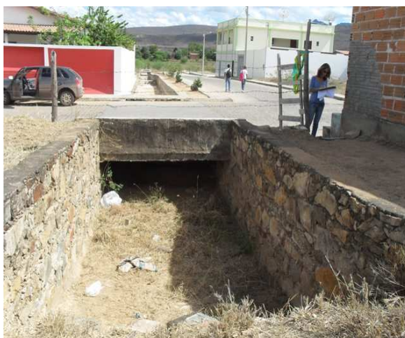
Foto 8: Início da galeria em alvenaria (1,00 x 0,60) - esgoto primário e secundário.
