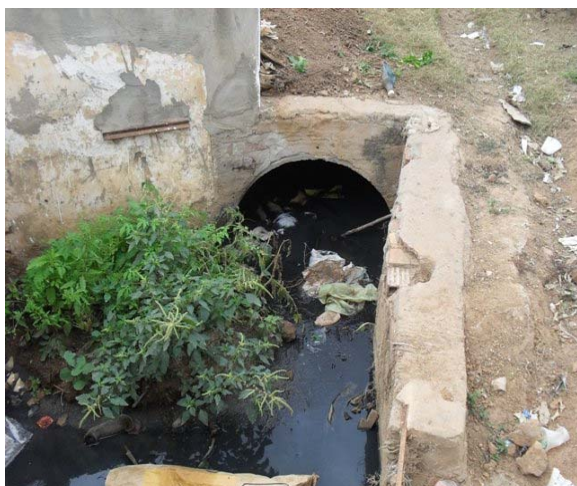
Foto 1: Ponto de lançamento de esgoto e água de chuva pela tubulação de Ø1000 – Praça Eucalipto.
