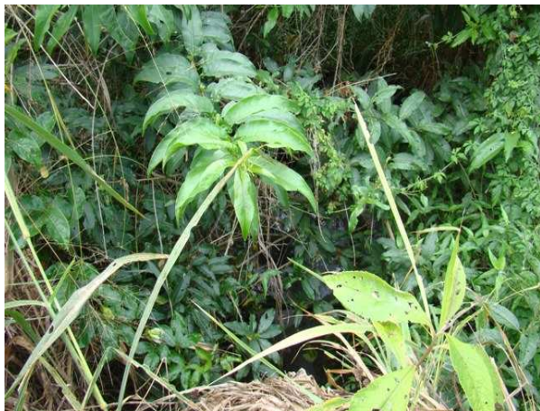
Foto 1 – Final da galeria de drenagem – coberta pela vegetação – Rua Duque de Caxias
