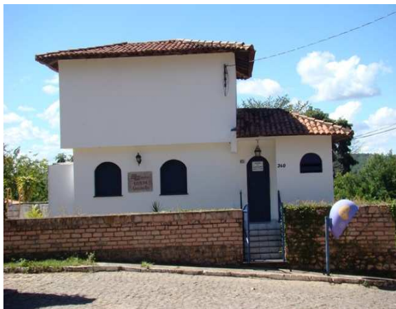
Foto5: ETA de Lençóis.
