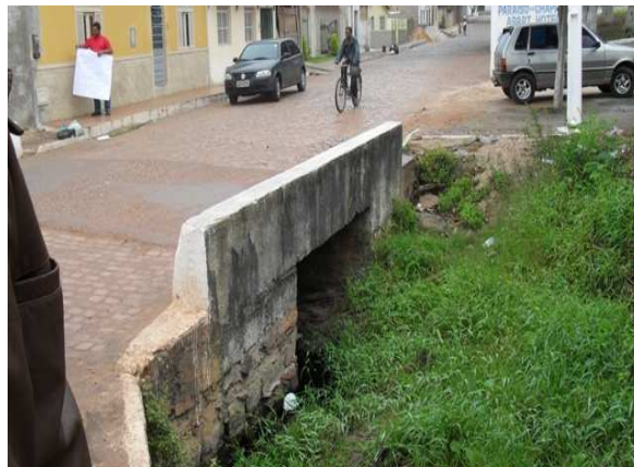
Foto 2: Bueiro sob leito de rua.
