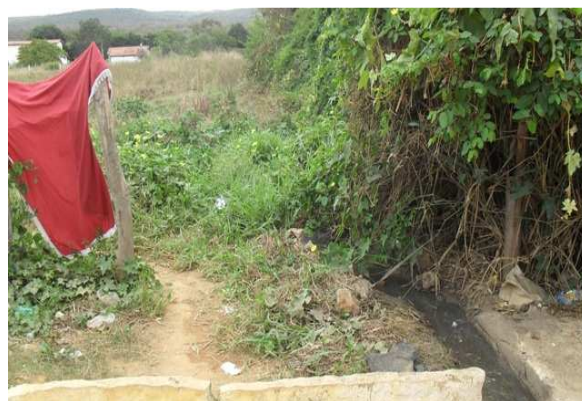
Foto 14: Transposição do esgoto secundário da vala para o terreno natural.
