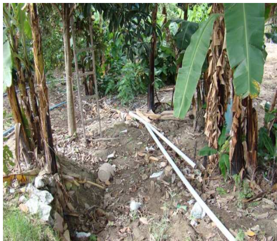
Foto 1: Quintal particular – saída de esgoto e drenagem.
