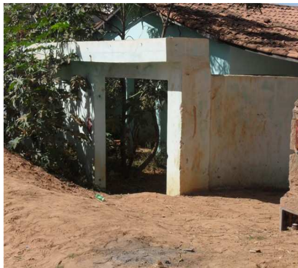
Foto 2: Casa sujeita a alagamento.
