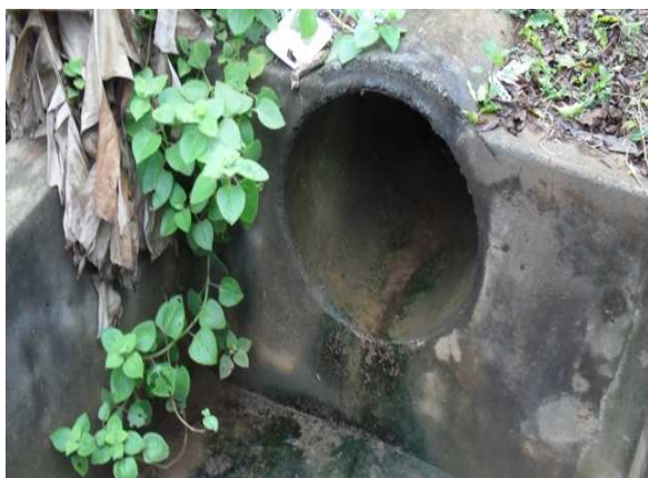
Foto 12: Interface – tubulação x canaleta de drenagem.
