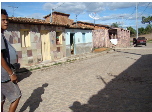
Foto 3: Rua do Cajedo – área crítica 2
