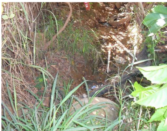
Foto 9: Lançamento de drenagem a céu aberto.
