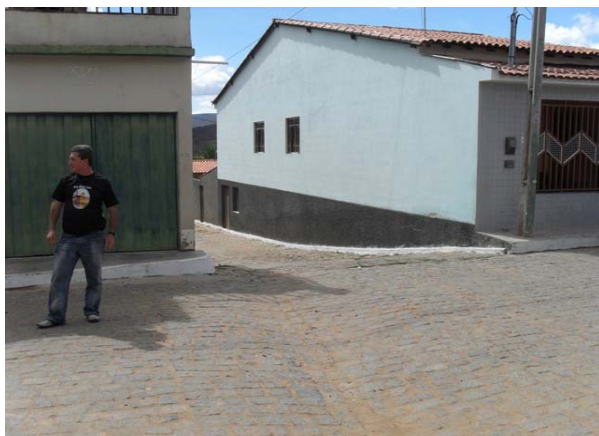
Foto 7: Área crítica 2 – Rua Dr. Lafaiete Coutinho – local de enxurrada .
