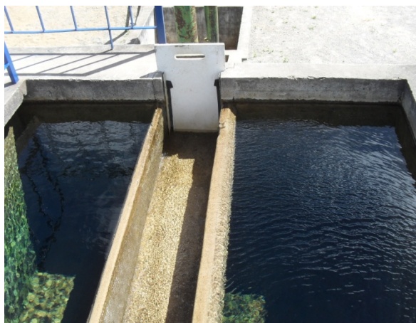
Foto 4: Vista da ETA
