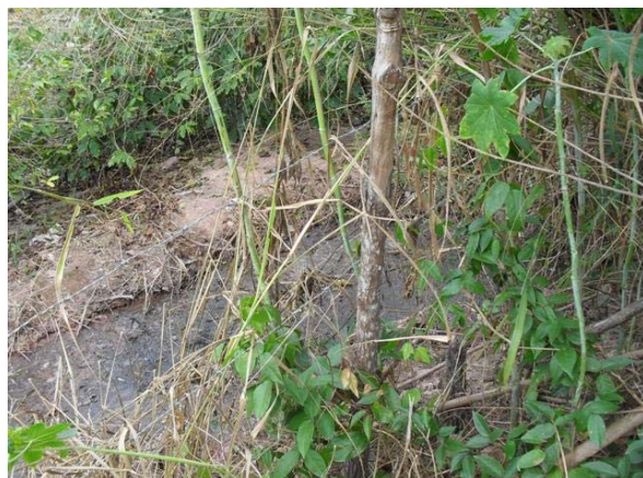
Foto 6: Ponto de lançamento de esgoto no pasto.
