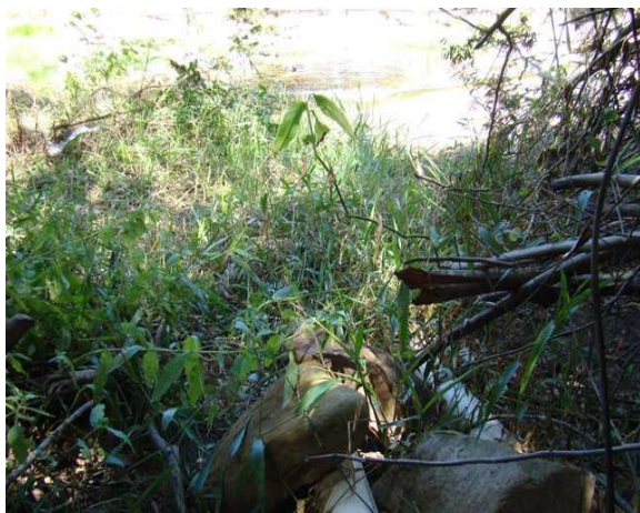
Foto 1: Rede de esgoto na caída do Rio lençóis
