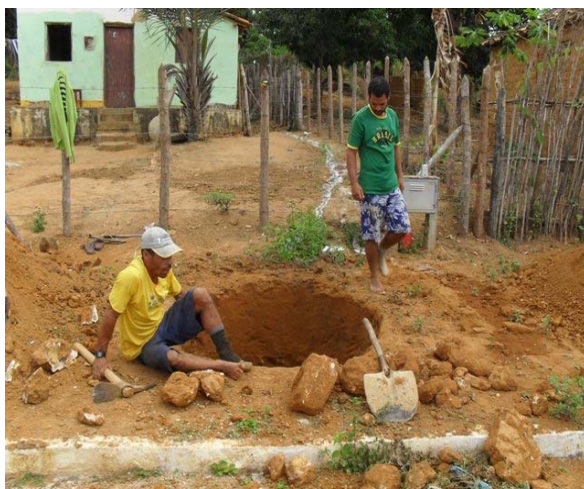
Foto 2: Construção de fossa para esgoto secundário.
