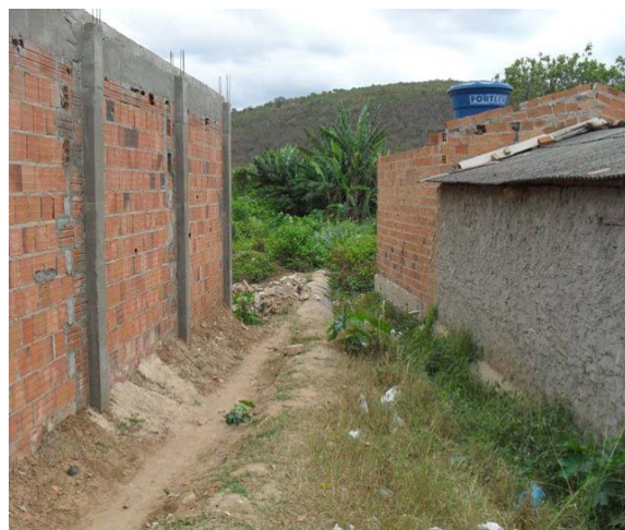
Foto 2: Ponto de lançamento de esgoto e água de chuva pela tubulação de Ø1000 – Praça Eucalipto.
