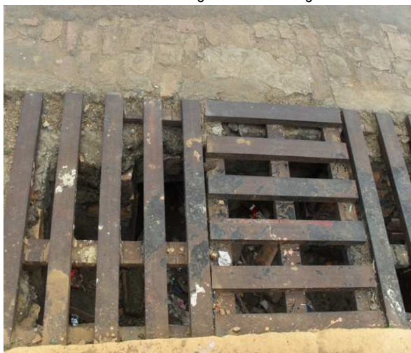
Foto 9: Elemento de microdrenagem – caixa com grelha.
