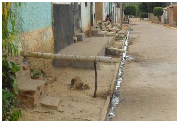
Foto 12: Lançamento de esgoto secundário a céu aberto.
