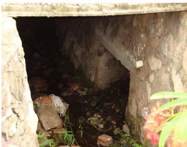
Foto 3: Canal de drenagem 6 – Rocinha com a BA-142
