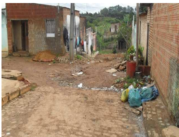
Foto 3: Descida de água superficial.
