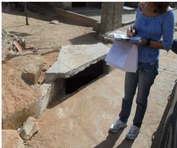
Foto 13: Ponto inicial da galeria de alvenaria de pedra (0,60 x 0,80)
