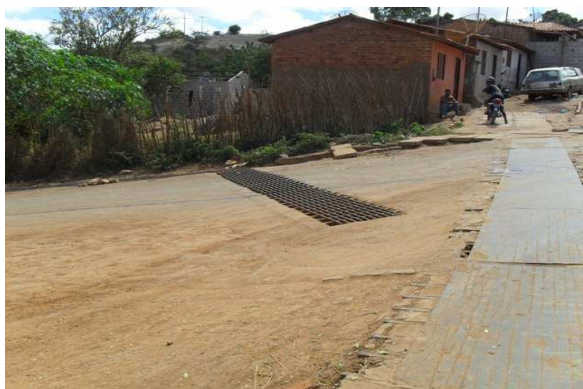
Foto 5: Canaleta de drenagem com grelha e rede de esgoto com tampa.
