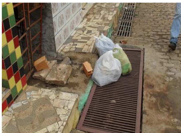
Foto 6: Elemento de microdrenagem com lixo.
