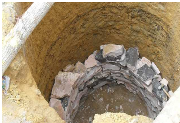
Foto 2: Construção de fossa comunitária pela Prefeitura – revestimento com pedra arrumada.
