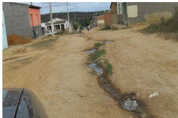
Foto 6: Esgoto secundário a céu aberto lançado em ruas sem pavimentação.
