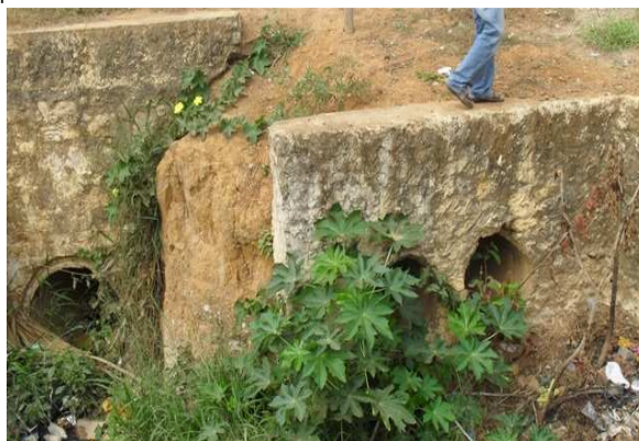
Foto 4: Bueiros de drenagem sob a rodovia.
