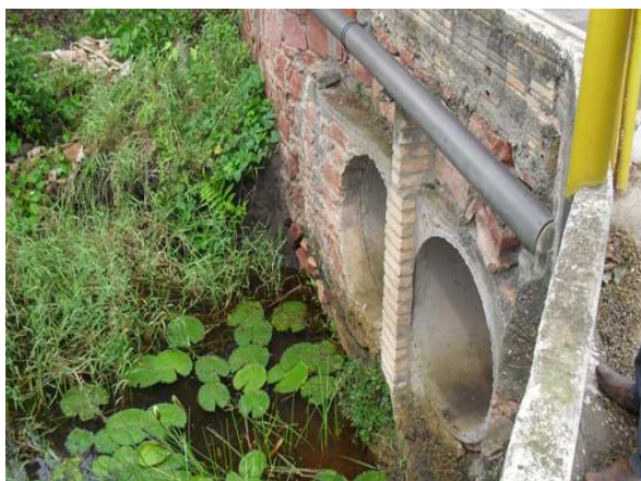
Foto 3: Bueiro sob pista.
