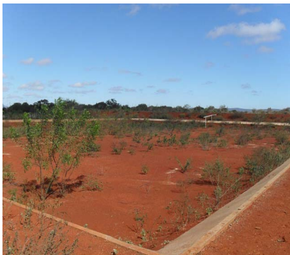
Foto 13 – ETE – vista geral.
