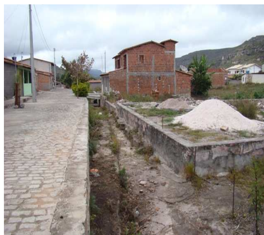
Foto 4: Canal 5 – trecho com calha natural
