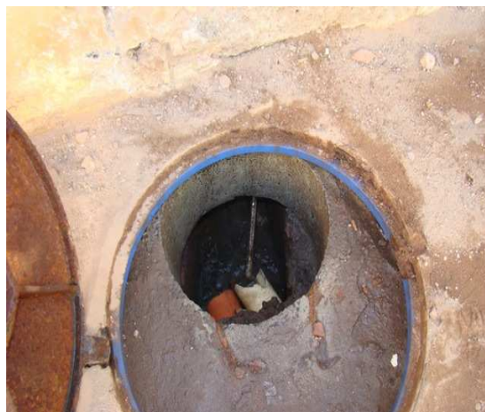
Foto 2: Coletor da galeria
