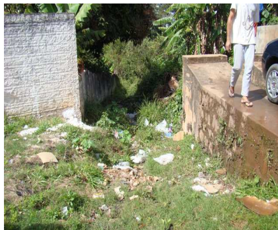
Foto 2: Rua Getúlio Vargas – lançamento de esgoto.
