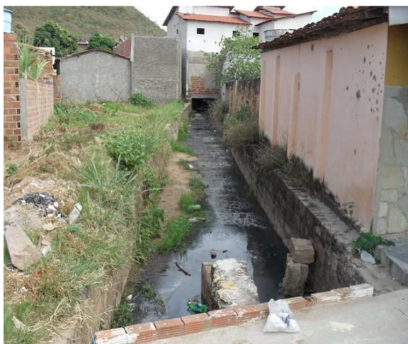
Foto 3: Galeria em alvenaria de pedra (2,60 x 1,00) – recebe esgoto.
