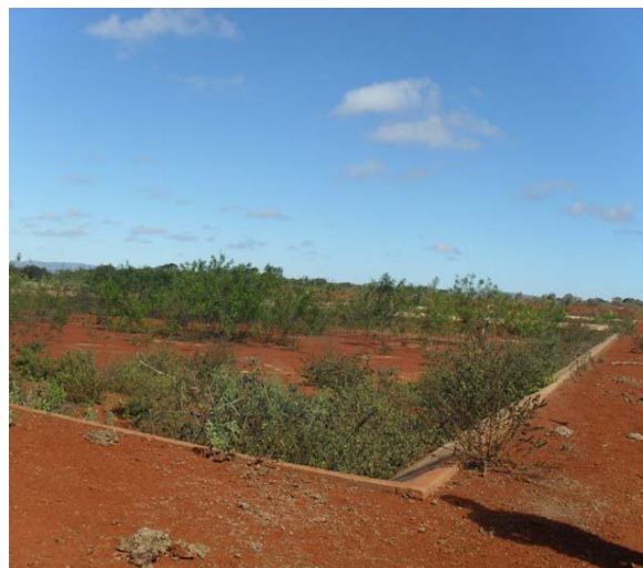
Foto 14: ETE – pronta em 2007 – não opera e mato toma conta.
