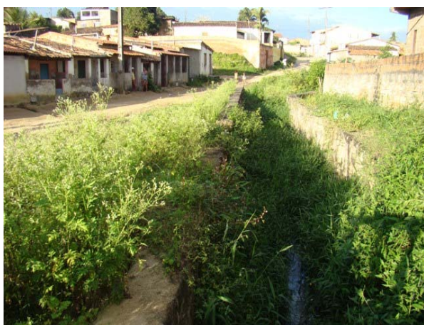
Foto 9: Macrodrenagem com esgoto – travessia da Av. Santana.
