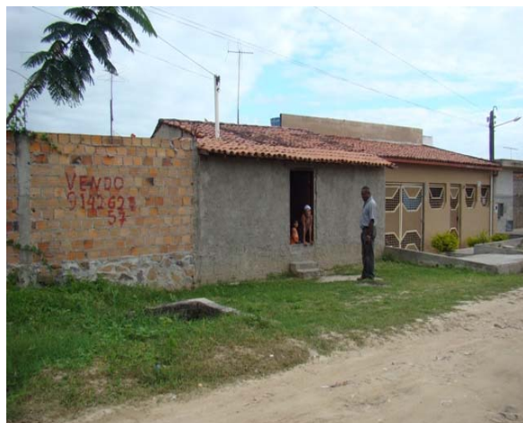
Foto 8: Área de inundação – 1ª Travessa Álvaro Augusto.
