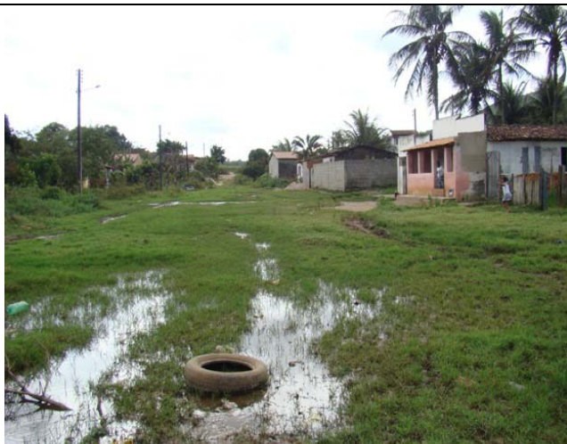
Foto 1: Área Crítica 1 – Rua Rui Barbosa – Bairro Recreio – Vila de Fátima.
