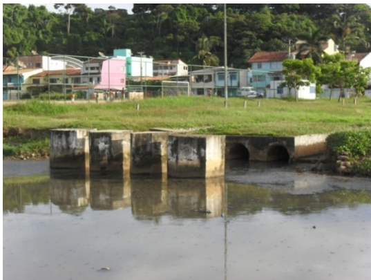
Foto 3: Descarga do Canal do Malhado (Av. Lindolfo Collor), conduzindo esgotos, no oceano (registro fotográfico F em planta).
