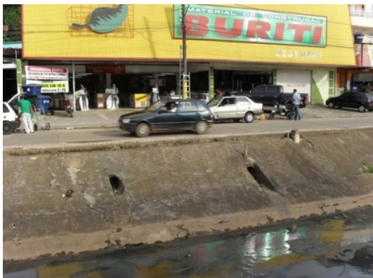
Foto 11: Bocas de chegada de galerias pluviais, conduzindo esgotos, no Canal do Malhado.
