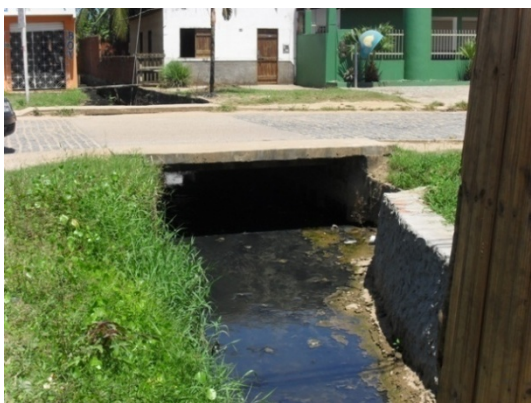
Foto 9: Canal conduzindo esgotos no setor Sul da cidade
