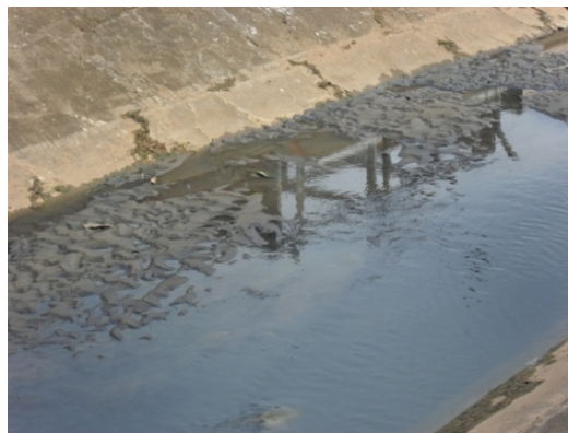
Foto 12: Assoreamento visível no leito do Canal do Malhado.
