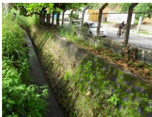
Foto 16: Canal de drenagem paralelo a Av. Petrobrás.
