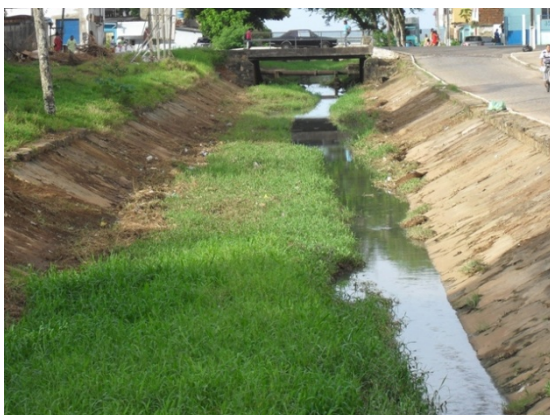
Foto 5: Canal do Malhado, destacando-se sinais de eutrofização em função do lançamento de contribuições sanitárias.
