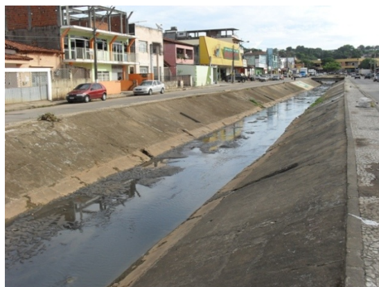
Foto 6: Canal do Malhado, visivelmente poluído e assoreado
