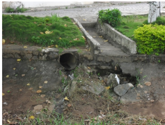
Foto 4: Dreno superficial e galeria pluvial convergentes ao Canal do Malhado.
