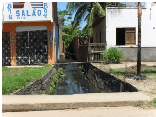
Foto 10: Canal conduzindo esgotos no setor Sul da cidade (registro fotográfico G em planta).
