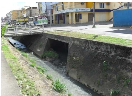
Foto 17: Descarga da galeria que seqüência o canal do Santo Antônio no canal do Lava-Pés, no centro da cidade. (Registro fotográfico C em planta)
