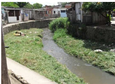
Foto 13: Legenda: Canal aberto de macrodrenagem, recebendo águas servidas das casas próximas, no setor urbano degradado denominado "Gogó da Ema".
