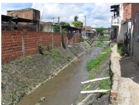
Foto 11: Legenda: Canal aberto de macrodrenagem, recebendo águas servidas das casas próximas, no setor urbano degradado denominado "Gogó da Ema".
