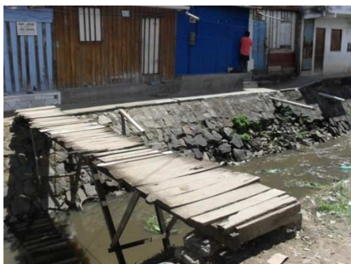
Foto 1: Canal de macrodrenagem no setor urbano degradado denominado "Gogó de Ema".
