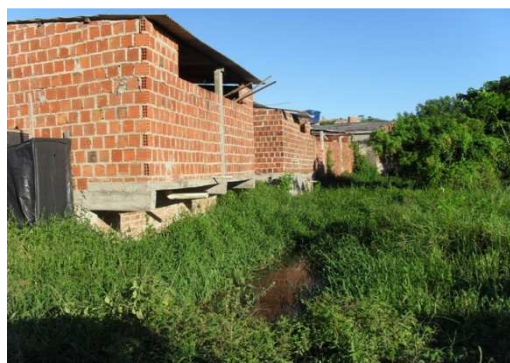
Foto 6: Canal a céu aberto, recebendo contribuições sanitárias, nas proximidades da Vila Anália.
