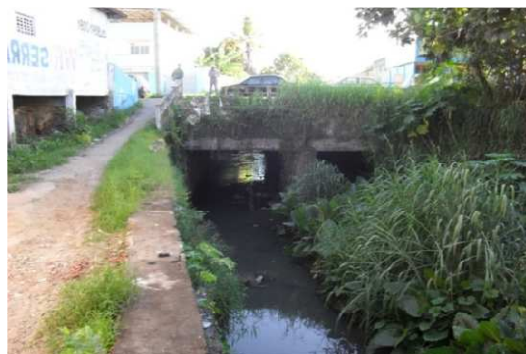
Foto 4: Canal aberto de macrodrenagem, conduzindo contribuições sanitárias, em área do bairro Novo Jaçanã.
