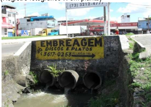
Foto 3: Início do canal aberto do Lava-Pés, em ponto próximo a estação rodoviária, recebendo galerias enterradas, conduzindo esgotos sanitários.
