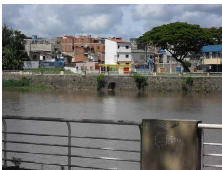
Foto 9: Boca de descarga de galeria de macrodrenagem no Rio Cachoeira.
