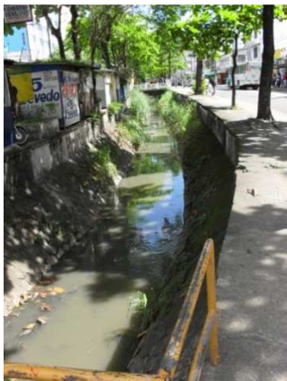
Foto 7: Canal do Lava-Pés, conduzindo esgotos, desenvolvendo-se no centro da cidade, na direção da descarga no Rio Cachoeira.
