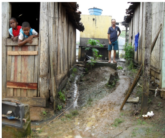
Foto 4: Esgoto a céu aberto escorrendo livremente por entre as casas. Rua Antônio S. Mucugê.
