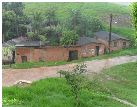
Foto 2: Rua da Serraria. Casas construídas abaixo do nível da rua encontram-se no caminho do escoamento natural. Área crítica por conta das chuvas de enxurrada.
