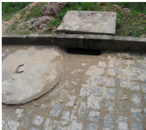
Foto 2: Dispositivos de drenagem. Rua projetada para implantação de sistema separador.
