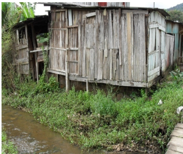
Foto 3: Ocupações informais às margens do rio Gandu.
