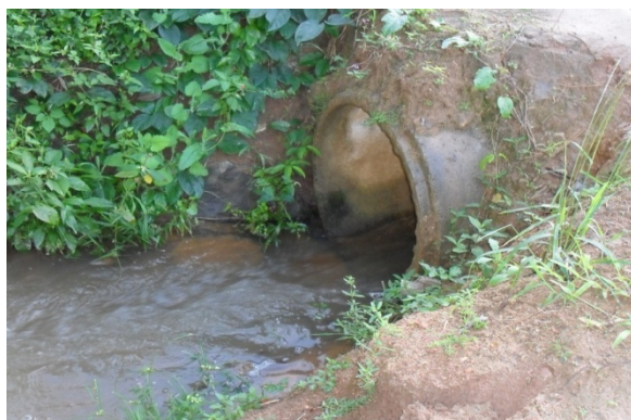
Foto 10: Ponto final do escoamento das águas pluviais e esgotos sanitários no perímetro urbano que seguem em direção ao Rio do Rolo.
