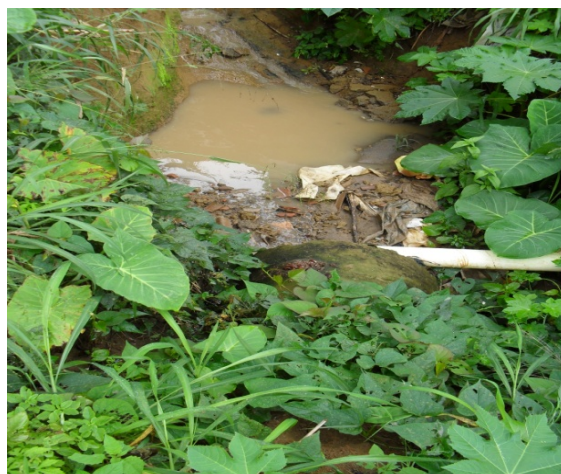
Foto 2: Lançamento de águas pluviais + esgotos livremente no terreno.
