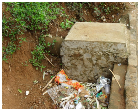
Foto 2: Caixa de passagem da rede coletora de esgoto
