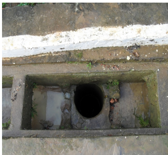
Foto 8: Dispositivo de coleta superficial de águas pluviais utilizado no bairro Colina Verde. (ponto alto)
