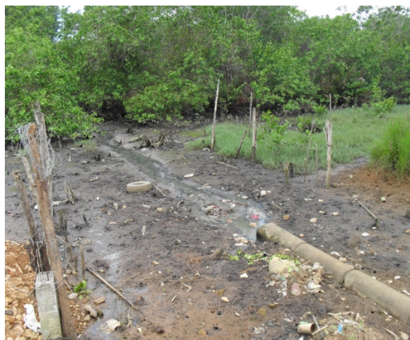
Foto 2: Esgoto a céu aberto.
