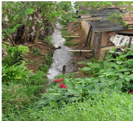
Foto 6: Lançamento difuso de esgotos sanitários no riacho. Rua São Carlos
