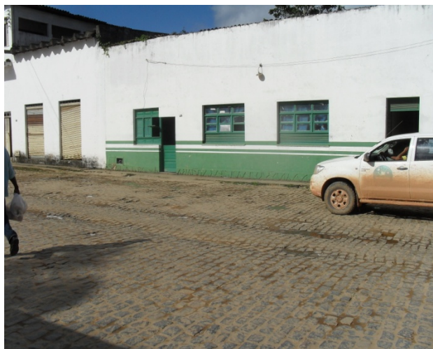
Foto 3: Praça Nair Lopes. Chuvas de enxurrada provocam alagamento e invade alguns imóveis, principalmente a escola.
