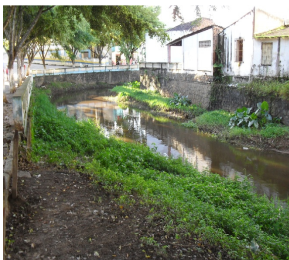
Foto 9: Trecho do rio Gandu com seção mista (leito natural+laterais revestidas em alvenaria de pedra). Rio bastante assoreado.
