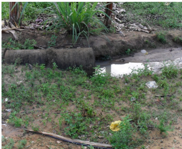
Foto 9: Lançamento de esgoto e águas pluviais do bairro Colina Verde.
