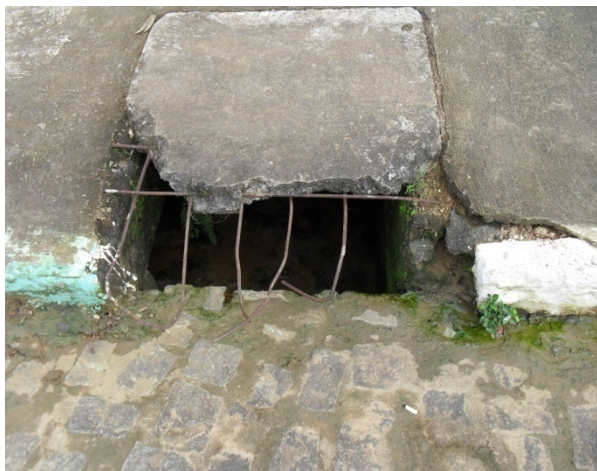
Foto 1: Boca de lobo com entrada na guia. Dispositivo utilizado no ponto baixo próximo a EMBASA. Bairro Centro.
