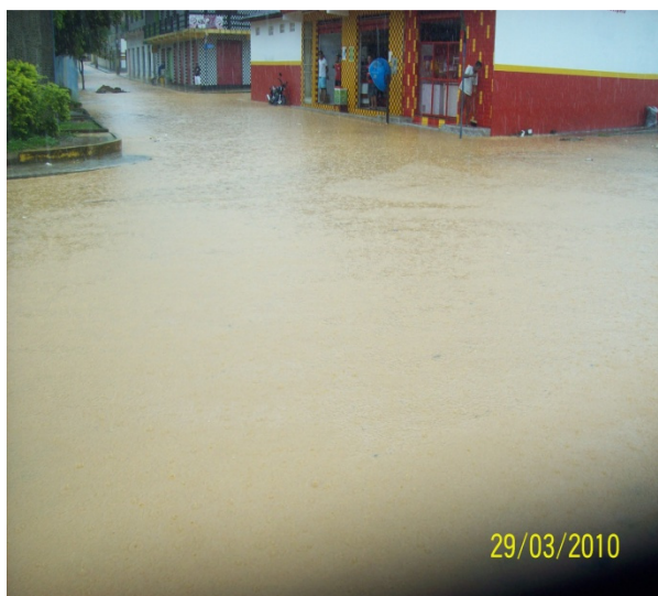
Foto 7: Alagamento na praça Eliseu Leal por conta da insuficiência da drenagem para coletar as águas das chuvas de enxurrada. Área crítica 1.
