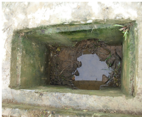
Foto 10: Dispositivo de coleta de drenagem superficial característico utilizado em diferentes áreas da sede municipal.
