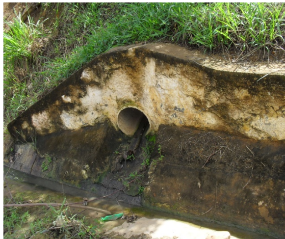
Foto 2: Ponto de lançamento de esgotos sanitários e águas pluviais no bairro Paulo Ribeiro.
