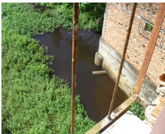
Foto 7: Lançamento afogado de esgoto sanitário e águas pluviais no Rio do Pau. Fundo do prédio da prefeitura.
