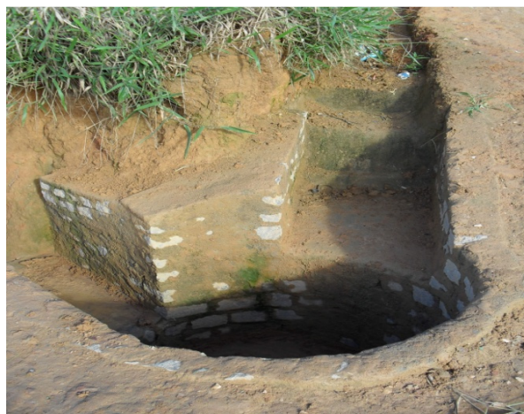
Foto 10: Solução de drenagem adotada para reduzir os efeitos da erosão por conta do escoamento superficial das águas pluviais.
