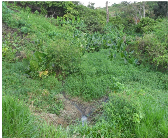
Foto 6: Esgotos sanitários lançados pelo fundo de alguns lotes nas áreas baixas próximas a ETE instalada.
