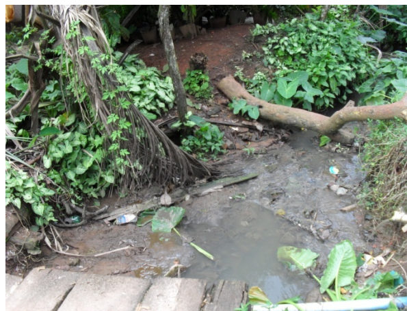
Foto 4: Esgoto a céu aberto
