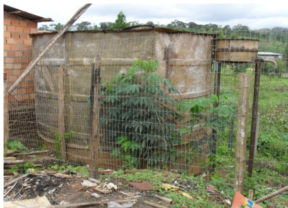
Foto 4: DAFA abandonado devido a falta de manutenção. Bairro Manoel Dantas Cardoso.
