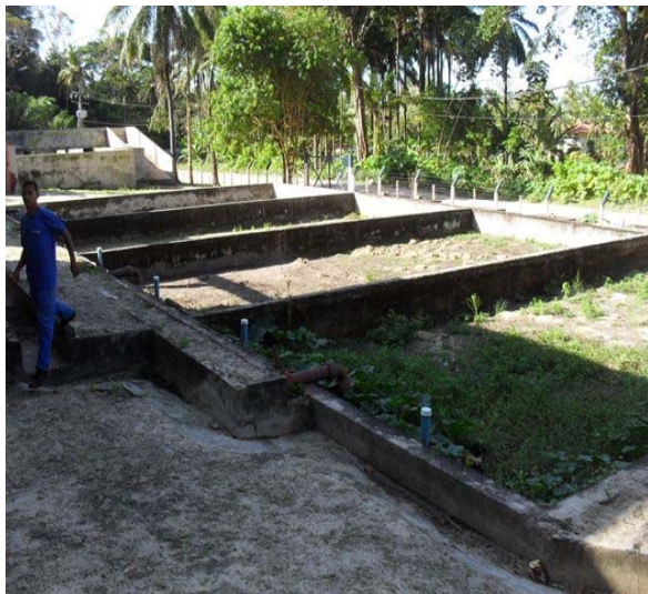
Foto 7: Leitos de secagem
