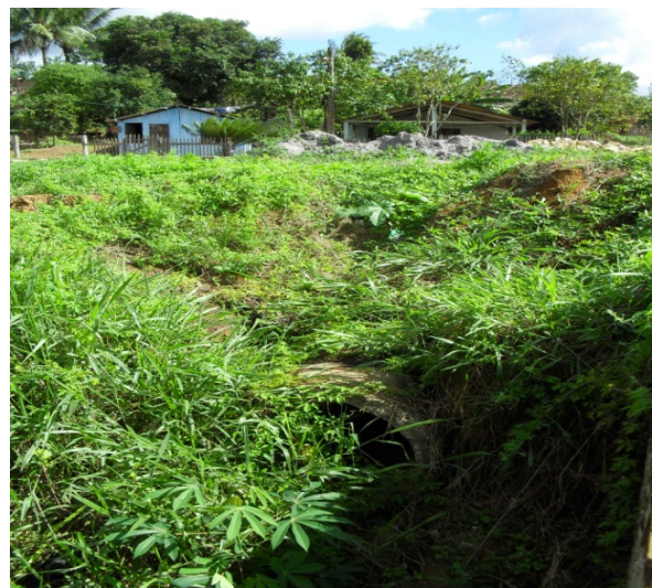
Foto 10: Ponto de lançamento de esgotos sanitários e águas pluviais da rede coletora do bairro Pôr do Sol.
