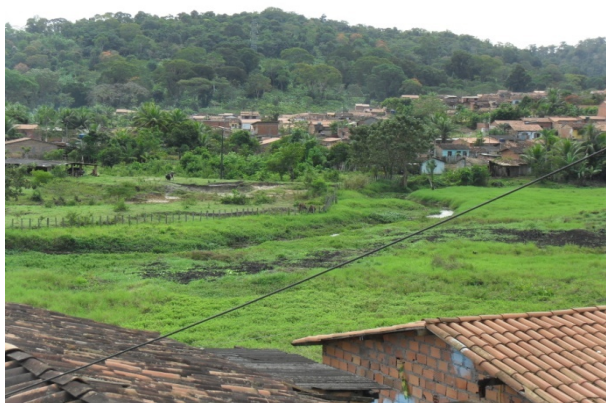
Foto 3: Vista do bairro Renovação II. Quase não tem infra-estrutura direito. Esgoto a céu aberto contaminou algumas nascentes
