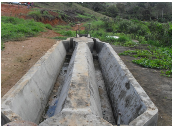
Foto 3: Caixa de areia da ETE. Estrutura em bom estado de conservação, porém nunca esteve em funcionamento.
