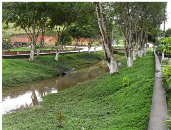
Foto 6: Canal de seção mista. Trecho do canal paralelo a 1ª Travessa da Ruy Barbosa. Mesmo com o aumento das dimensões do canal a rua é constitui uma área crítica por conta da inundação do rio do Peixe.
