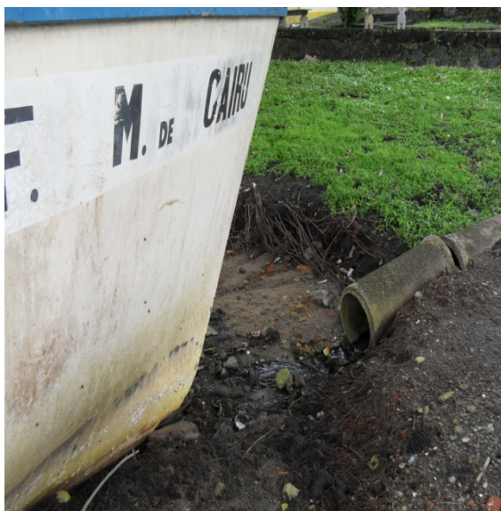
Foto 1: Ponto de lançamento da rede de drenagem com contribuição de esgotos
