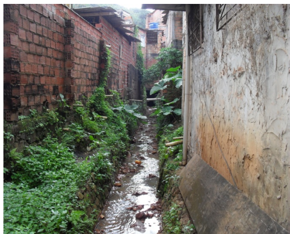
Foto 6: Lançamento difuso de esgoto em canal de macrodrenagem
