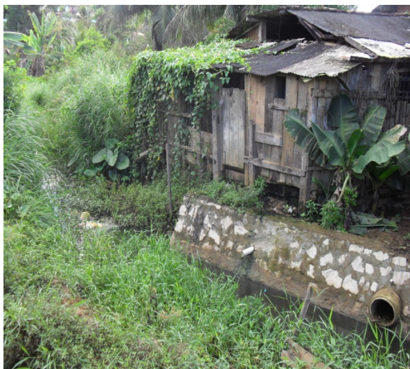
Foto 9: Ponto de lançamento de esgotos sanitários e águas pluviais no final da 2ª etapa do canal de macro drenagem revestido em alvenaria de pedra.
