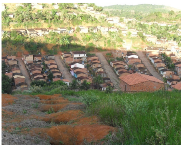
Foto 3: Vista das ruas que contribuem para o escoamento superficial da Rua São Roque.
