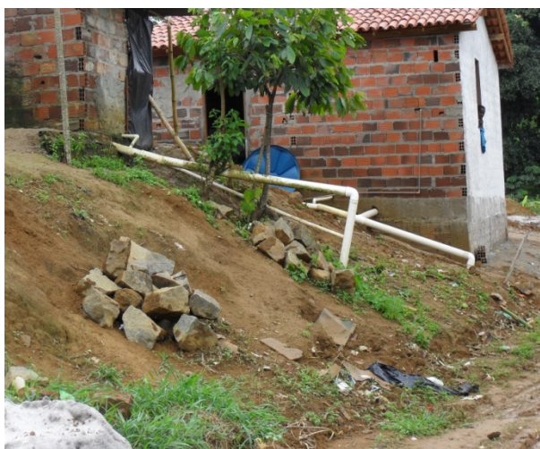
Foto 3: Tipo de instalação sanitária freqüente nas ruas não pavimentadas.
