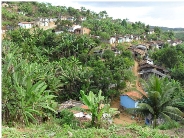
Foto 3: Encosta recoberta por bananeiras que recebem os esgotos sanitários diretamente das residências do Bairro Zacarias Borges.
