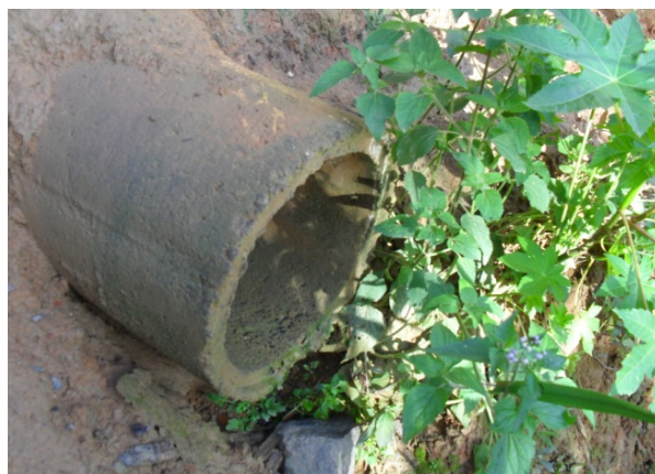
Foto 12: Ponto de lançamento de águas pluviais no fundo das residências.
