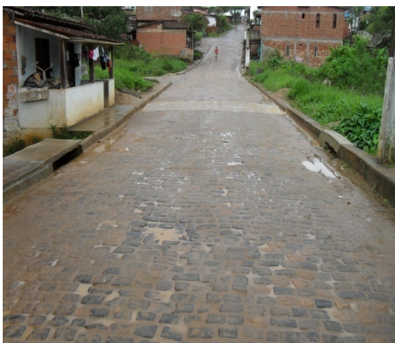
Foto 11: Dispositivos de drenagem da Rua Rui Barbosa.
