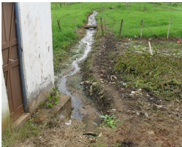
Foto 3: Ponto de lançamento de esgotos sanitários e águas pluviais em terreno particular escorrendo a céu aberto em um longo trecho.
