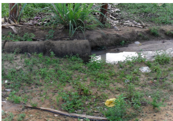
Foto 9: Lançamento de esgoto e águas pluviais do bairro Colina Verde.
