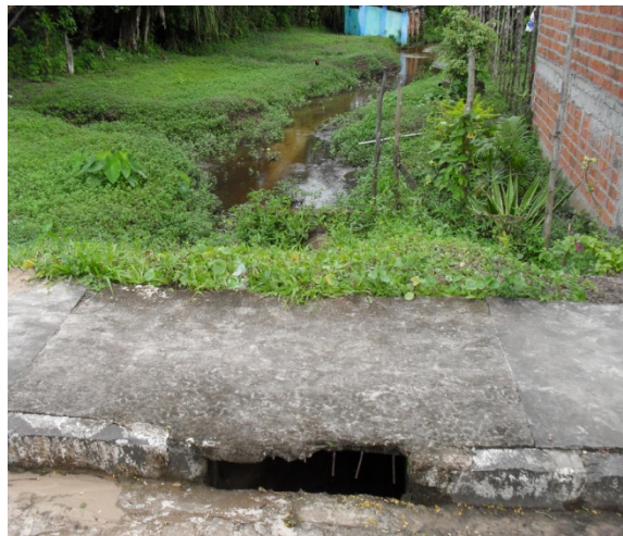
Foto 2: Boca-de-lobo que leva a canal natural com contribuição de esgotos
