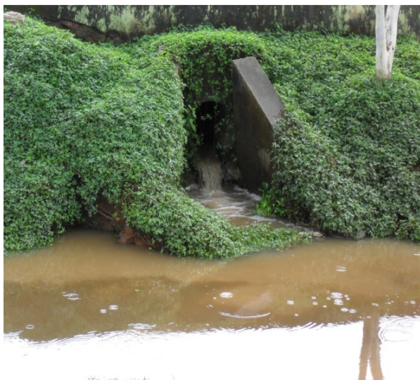
Foto 7: Bueiro de travessia que conecta uma área de charco, que recebe contribuições de esgotos sanitários de maneira difusa, no Rio do Peixe.
