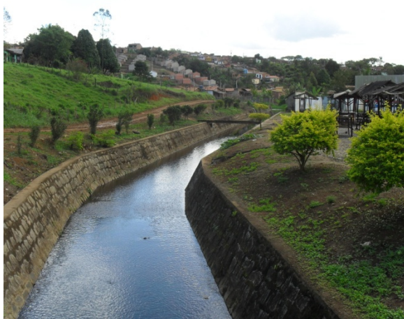
Foto 5: Canal de macro drenagem revestido em alvenaria de pedra. 2 etapas de 3 já foram concluídas. Rio Tabocas.
