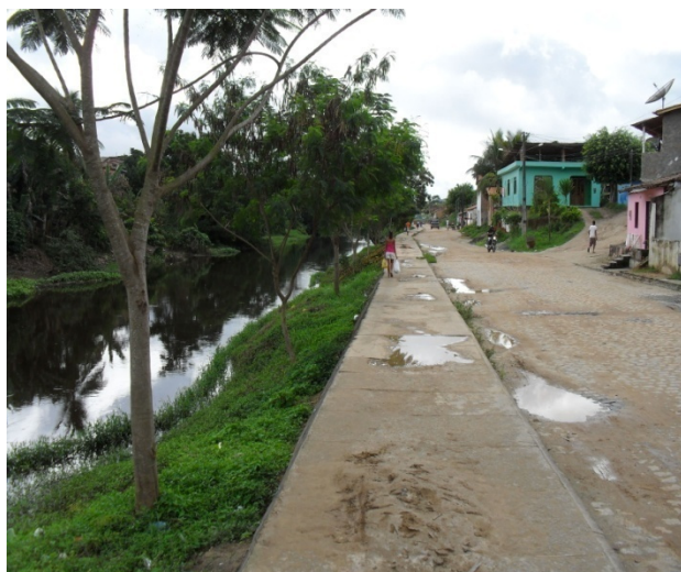
Foto 1: Rua Beira Rio. Cheia do Rio das Almas provoca inundação na rua e a água invade algumas residências.
