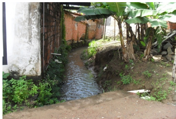
Foto 6: Canal natural comprimido por casas, convergindo para o Rio Una
