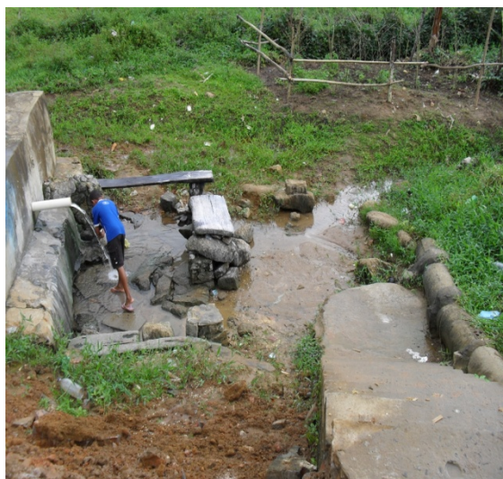
Foto 12: Lançamento de esgoto e águas pluviais próximo ao chafariz utilizado pela população para diversos fins.
