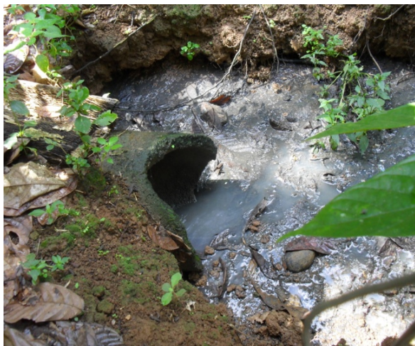
Foto 1: Ponto de lançamento de esgotos sanitários no fundo de terreno particular. Rede coletora do Centro.
