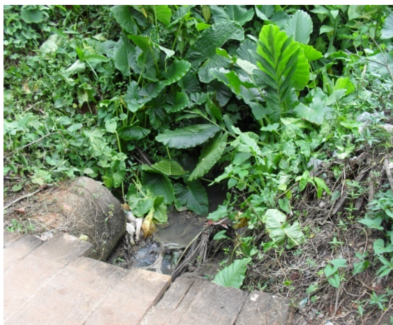
Foto 3: Esgoto a céu aberto
