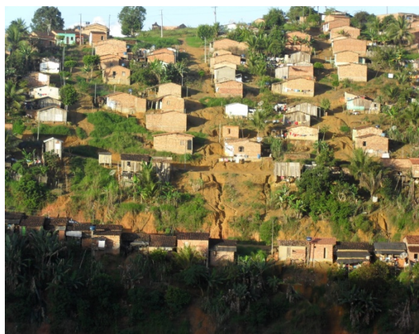
Foto 4: Vista do Bairro José Teles. Águas de chuva escoam pelo terreno causando erosões e desmoronamento do solo.
