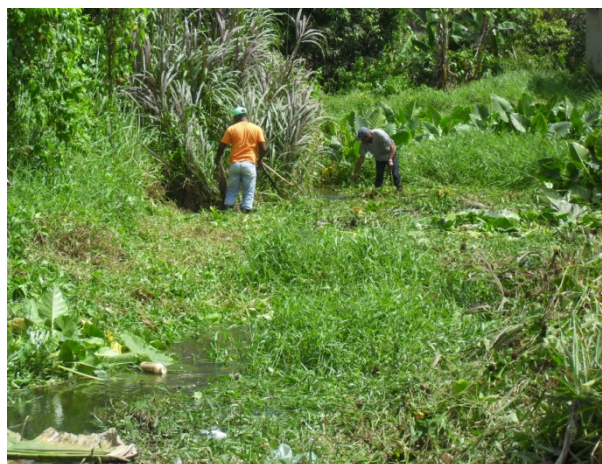
Foto 4: Homens removendo plantas as margens do rio para melhorar as condições do escoamento.
