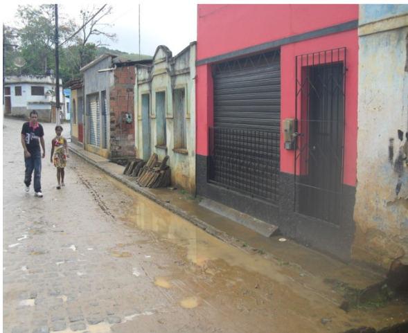
Foto 9: Rua Getúlio Vargas. Rua sem dispositivos de drenagem que recebe contribuição e águas pluviais de outras ruas e alagando e invadindo algumas casas. Área crítica por conta das chuvas de enxurradas.
