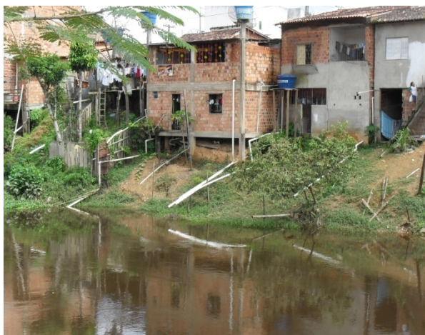
Foto 1: Lançamento difuso de esgotos sanitários no Rio das Almas.
