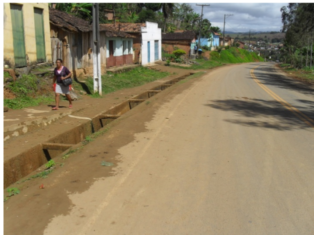
Foto 2: Valeta que coleta águas pluviais. Situada as margens da rodovia para Gandu.
