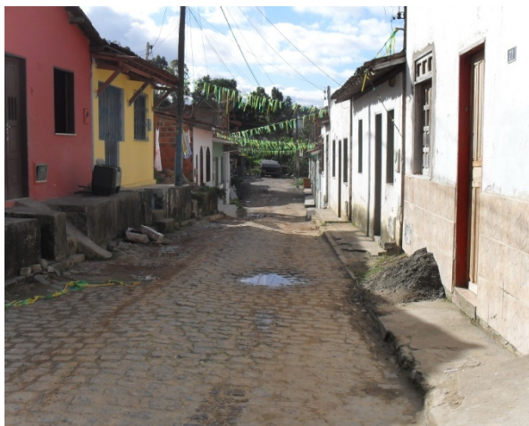
Foto 5: Rua Maria Carvalho. Área crítica por conta de inundação ribeirinha causada pelo Riacho da Cruz.
