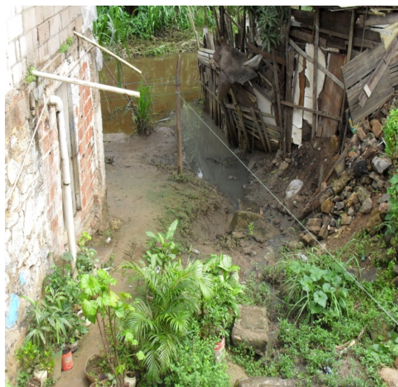
Foto 8: Esgotos sanitários e águas pluviais escorrendo pelo terreno e alcançando o rio.
