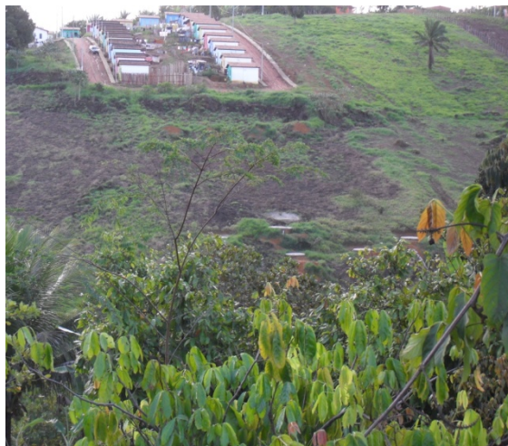
Foto 10: Sistema de fossas sépticas seguidas de sumidouros do Loteamento Nova Aurora.
