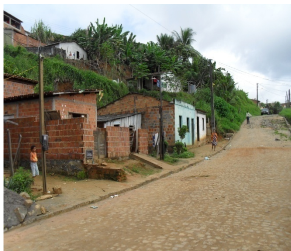
Foto 8: Rua D. Pedro II. Problemas de alagamento devido à insuficiência dos dispositivos de drenagem na ocorrência de chuvas constantes.
