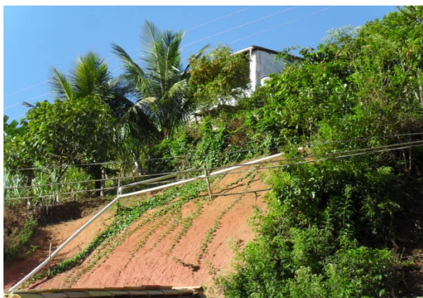
Foto 5: Prefeitura interligou esgotos sanitários de algumas residências para reduzir a quantidade de lançamentos nas encostas e minimizar os processos de erosão.
