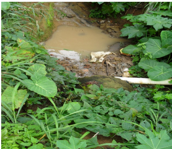
Foto 1: Lançamento de águas pluviais e esgotos sanitários livremente no terreno.
