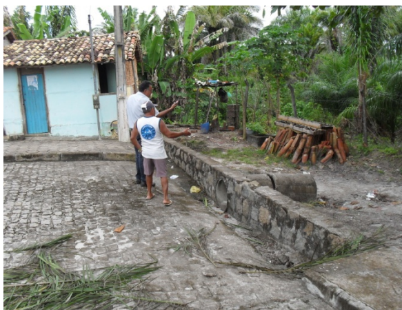
Foto 3: Final da rua Santo Antônio. Ponto de lançamento de águas pluviais
