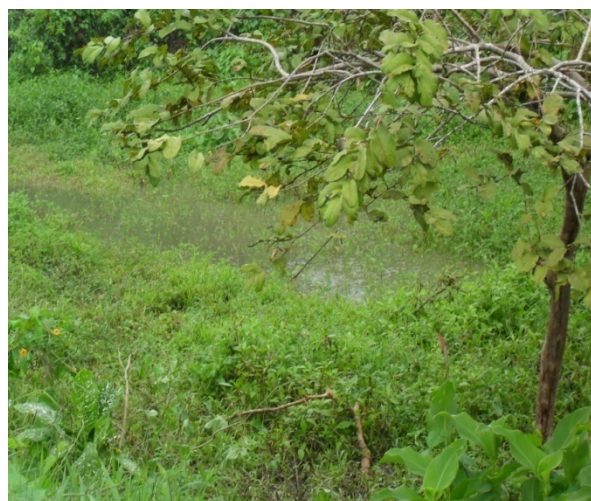
Foto 12: Canal construído sem revestimento. Iniciado na Rua Rui Barbosa e finalizado na ETE abandonada.
