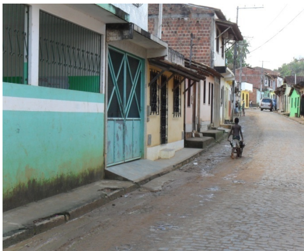
Foto 7: Rua Tancredo Neves. Área crítica por conta das chuvas de enxurrada.
