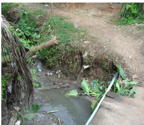
Foto 5: Esgoto a céu aberto
