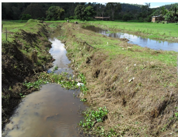
Foto 3: Canal construído paralelamente ao leito natural do rio Gandu para amortização dos efeitos de cheia do rio Gandu.
