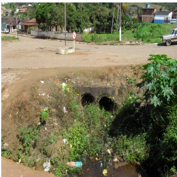
Foto 7: Bueiro de travessia que conecta o rio Tabocas ao rio Jatobá
