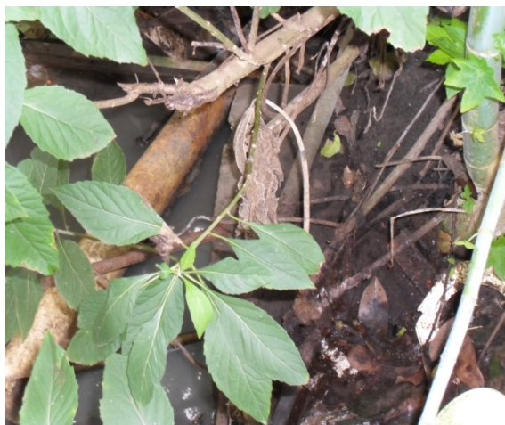
Foto 4: Ponto de lançamento de esgotos sanitários e águas pluviais no fundo de lote. Rua Geraldo Domingos dos Santos.
