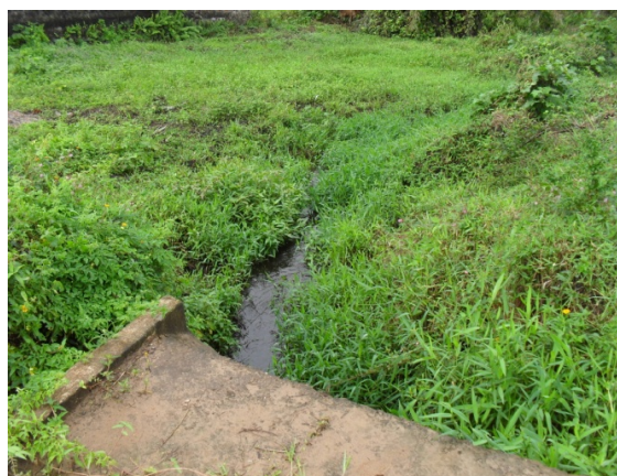
Foto 12: Canal bairro Novo Horizonte.
