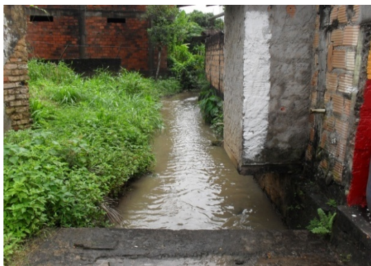
Foto 5: Canal Rua José Malta
