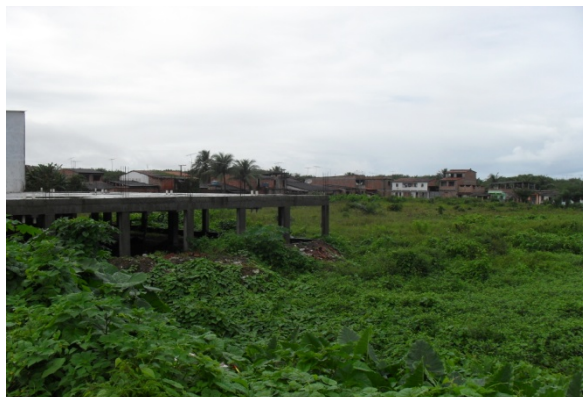
Foto 2: Área baixa desocupada nas laterais da avenida ACM.
