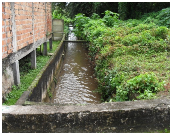
Foto 8: Canal de parede e fundo de concreto, com casas e em margens e as vezes por cima também.
