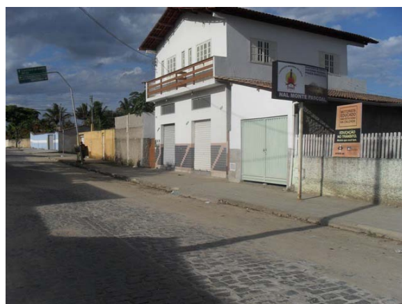
Foto 12: Área Crítica 6 – Rua Seabra – área de alagamento.
