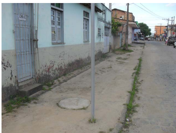
Foto 9: Área Crítica 5 – Rua Frei Geraldo – área de alagamento.
