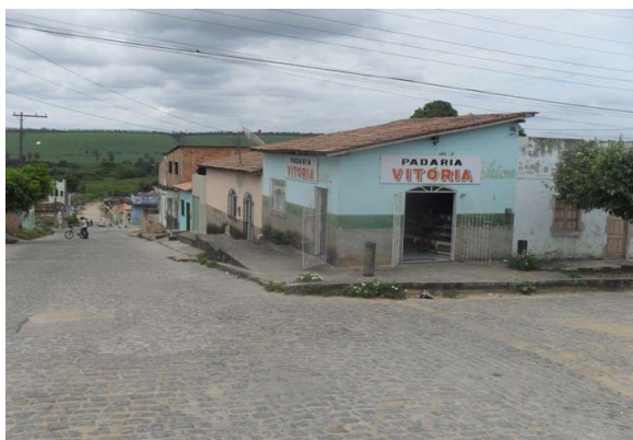
Foto 17: Área Crítica 10 – Rua Almirante Tamandaré – Rua Campo Alegre – área de enxurrada.
