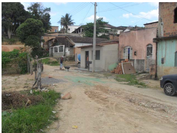
Foto 7: Área Crítica 2 – Rua da Aurora – área de alagamento.
