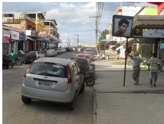
Foto 14: Área Crítica 8 – Rua José de Anchieta – área de alagamento.
