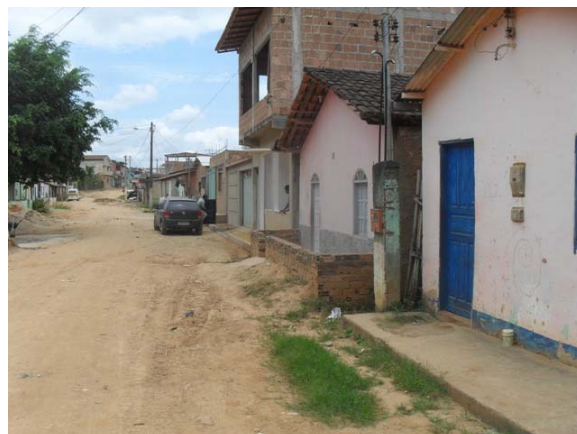
Foto 26: Área Crítica 15 – Rua Visconde do Rio Branco – área de inundação Ribeirinha.
