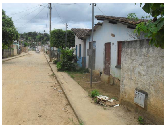
Foto 28: Área Crítica 17 – Rua Alcobaça – área de alagamento.
