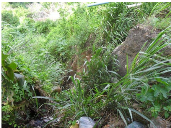
Foto 13: Área Crítica 7 – Rua presidente Kennedy – área de erosão.
