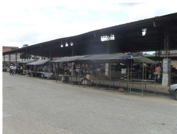
Foto 24: Área Crítica 14 – Praça do Mercado Municipal – área de alagamento.
