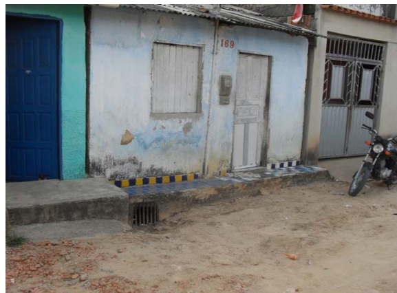
Foto 6: Área Crítica 2 – Rua Santo André com a Rua Clemente Souza – área de enxurrada.
