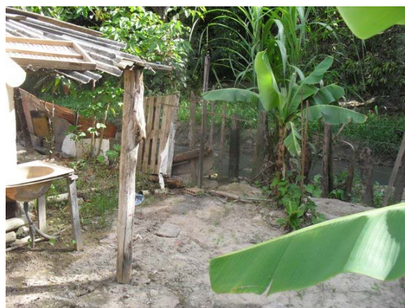
Foto 4: Área Crítica 1 – Rua Luis Viana Filho – área de inundação.
