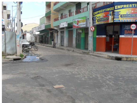
Foto 8: Área Crítica 3 – Rua Massanori Nagão – área de alagamento.
