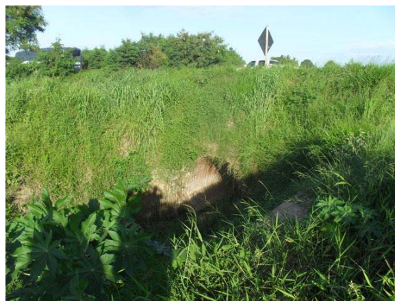
Foto 2: Bueiro da travessia da BR-101 do Canal da Rua José Linhares.
