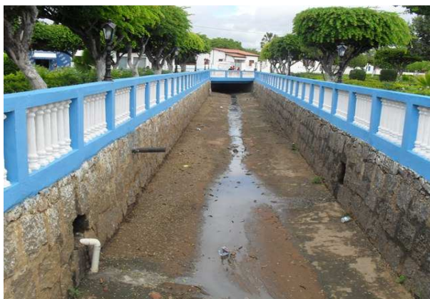
Foto 3: Canal aberto de alvenaria de pedra. Com escoamento das águas pluviais para o Riacho Casa Forte.
