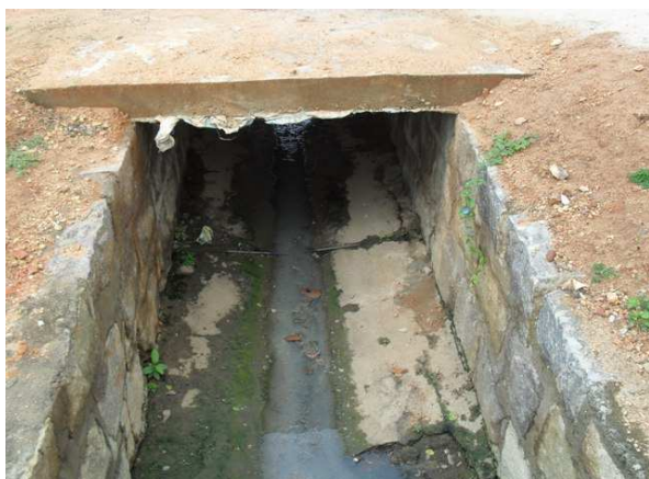
Foto 5: Trecho do canal aberto. Esgoto secundário.
