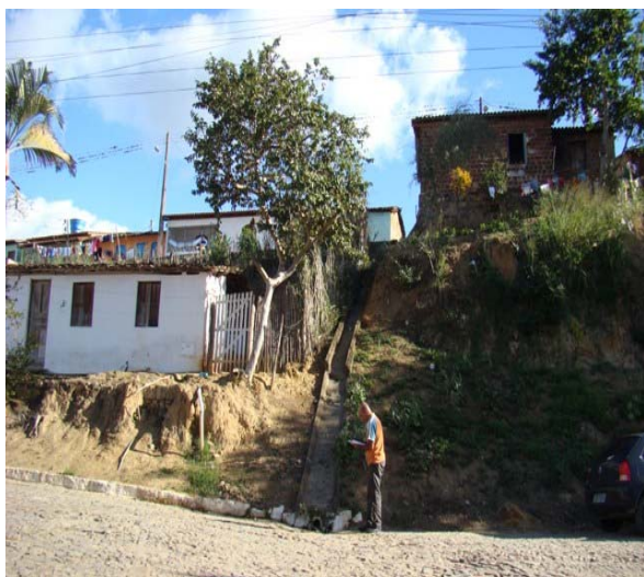
Foto 3: Rua Emídio Ramos – drenagem do Alto das Pombas.
