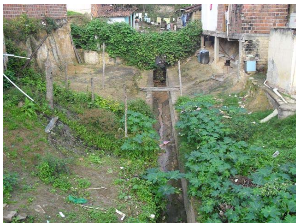
Foto 3: Drenagem dentro de lotes
