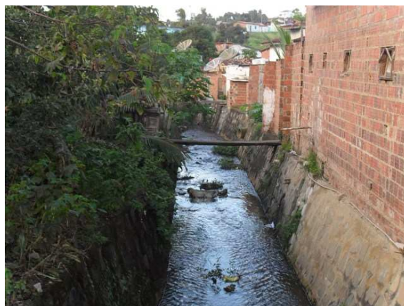
Foto 10: Rio Casca – conduto de esgoto e águas pluviais e construções irregulares.
