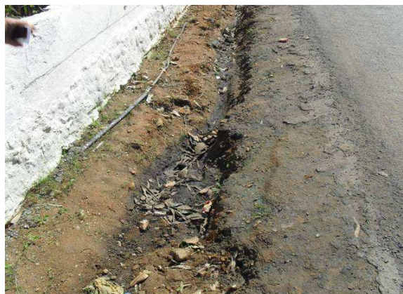
Foto 2: Ponto de lançamento de esgoto. Av. Sabatino Di Girolamo.
