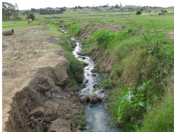
Foto 2: Canal de esgoto secundário
