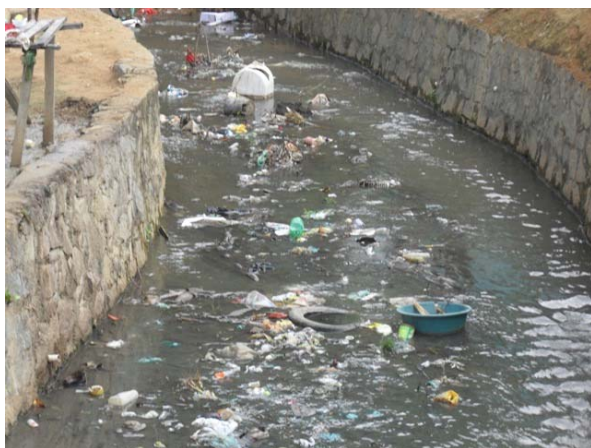
Foto 7: Final do trecho canalizado - montante
