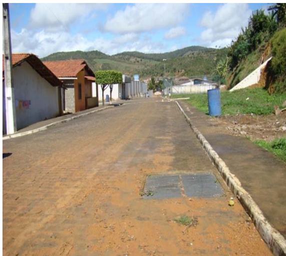
Foto 1: Estrada para o Alto das Pombas – início da rede de drenagem – ao lado das casas populares.
