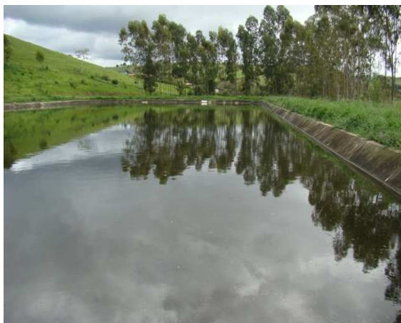
Foto 1: ETE – Lagoa Facultativa.
