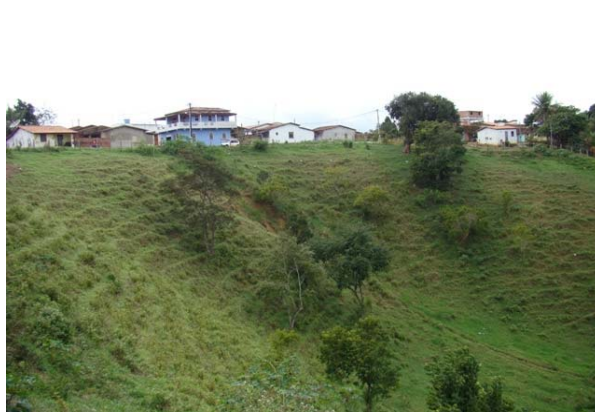
Foto 6: Saída de drenagem da Rua Leonidia Pereira dos Santos com erosão acentuada no talude.
