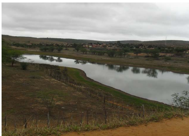
Foto 1: Tanque da Nação. Corpo receptor de águas pluviais e esgoto.
