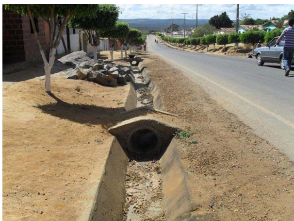
Foto 9: Canal aberto ao longo da rodovia que vai para Maracais.
