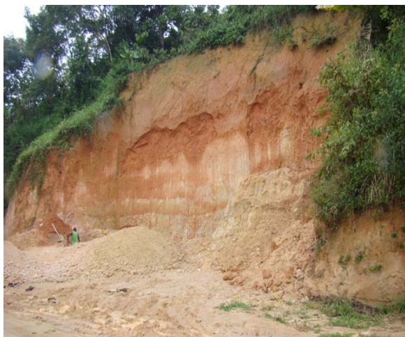
Foto 3: Retirada irregular de material de Talude – Av. Getúlio Vargas.
