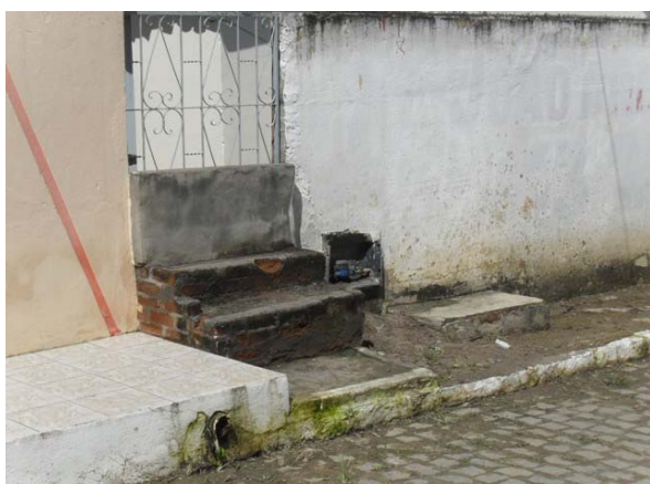
Foto 5: Rua Manoel Cerqueira, escoamento de água usada pela residência com proteção para evitar alagamento da residência.
