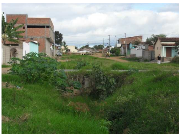
Foto 3: Canal conduzindo águas pluviais e esgoto secundário
