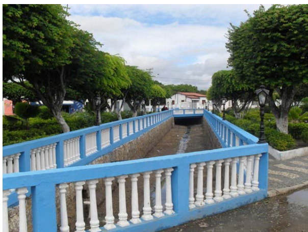
Foto 7: Canal aberto, escoamento das águas pluviais próximo da Associação Beneficente Santa Terezinha.
