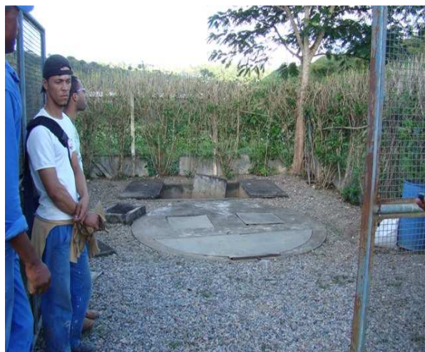
Foto 4: Estação Elevatória – Rua Clementino Santos.
