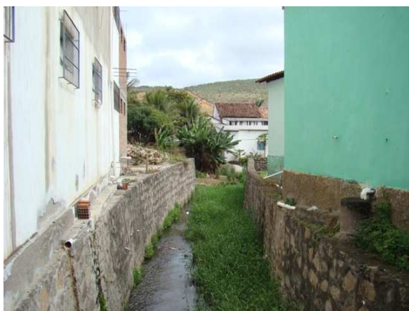
Foto 3: Lançamento direto de esgoto no Rio Baetinga – Rua Baetinga de Baixo.
