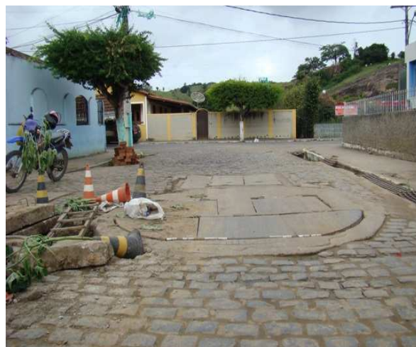
Foto 4: Estação Elevatória 1 – Loteamento Santo Antônio.
