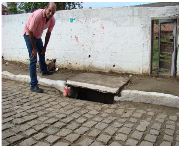
Foto 7: Boca de lobo – Rua Góes Calmon.
