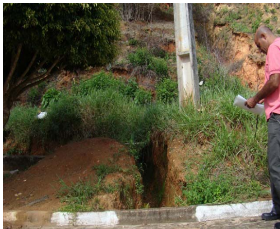
Foto 2: Início da rede de drenagem, nos fundos da 2ª Travessa São Roque de diâmetro 1000mm – obra em execução.
