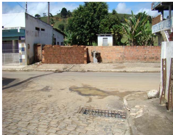
Foto 2: Caixa de coleta da rede iniciada na Rua João Martins.
