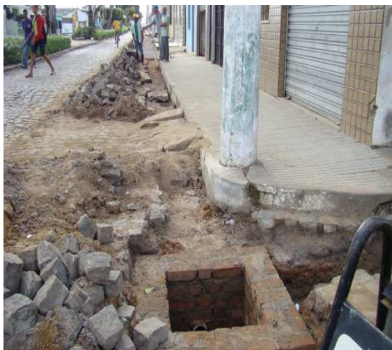
Foto 1: Obras de esgoto – Av. Antonio Carlos Magalhães com a Travessa São Roque.
