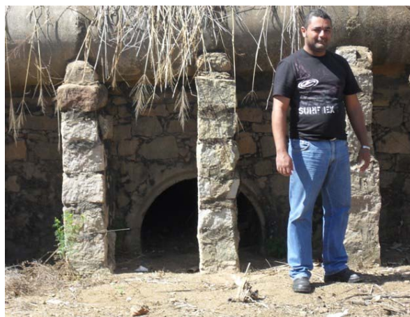
Foto10: Bueiro sob a rodovia que vai para Maracais
