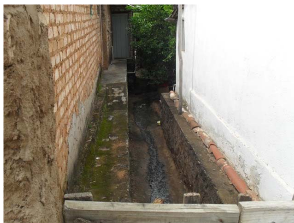
Foto 4: Drenagem entre lotes
