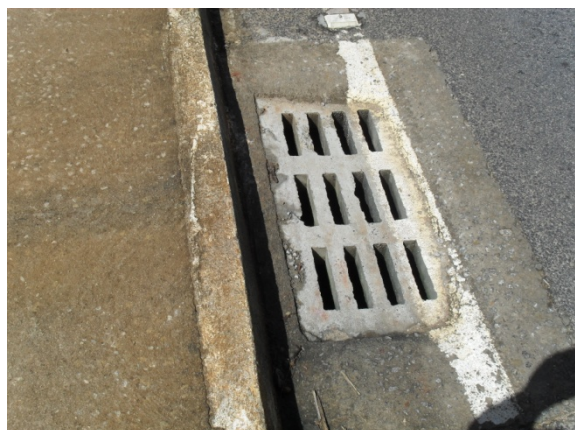
Foto 2: Caixa de chegada com grelha de concreto, próximo da BA-026.
