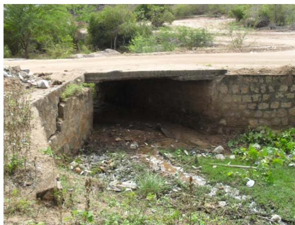
Foto 8: Riacho Bom Jardim – bueiro.
