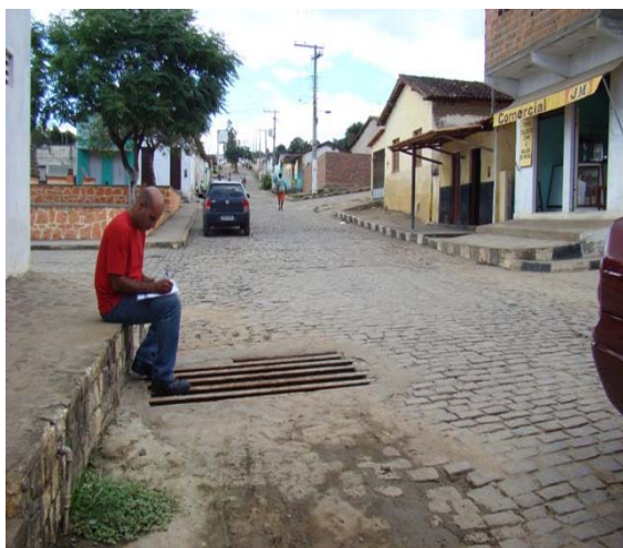
Foto 3: Drenagem – Rua Antonio Emilio dos Reis.
