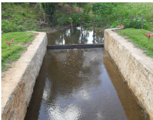
Foto 3: Detalhe da barragem do Riacho Jaguari, canal aberto de pedras de alvenaria. 4,00X1,50 m
