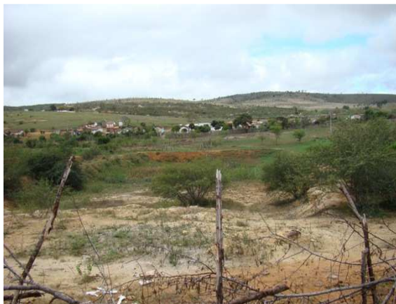
Foto 7: Obra de construção da ETE (inacabada)
