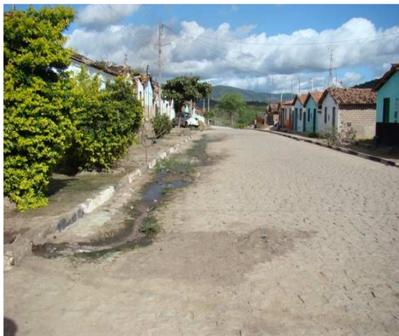
Foto 7: Esgoto a céu aberto na Rua Francisco Leal Sales.
