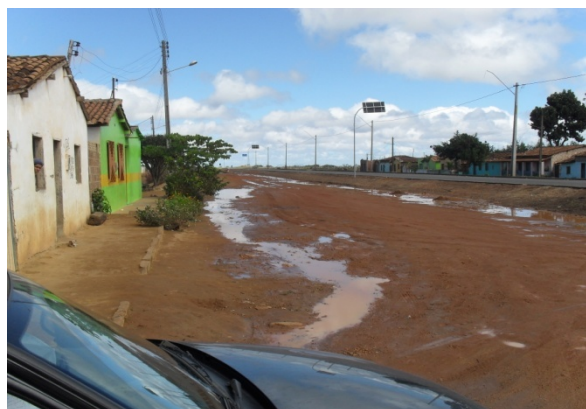
Foto 6: Área de alagamento próxima das casas populares ao da BA-026.
