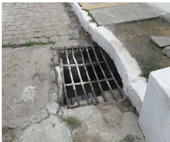
Foto 8: Rua Irmã Dulce. Sistema de micro-drenagem com grelha horizontal.
