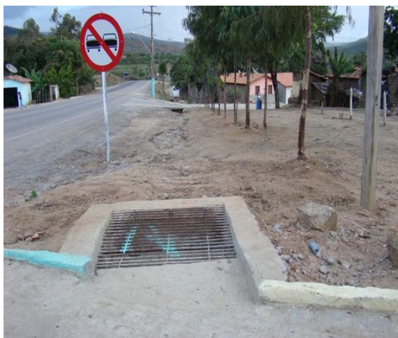
Foto 3: Rede de drenagem, paralela a BA-120 – iniciada na Rua Alcides José de Souza.
