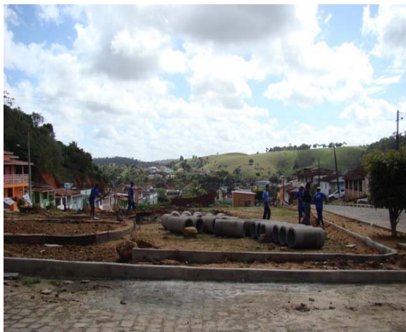
Foto 1: Início da rede de drenagem de diâmetro 400mm – obra em execução.
