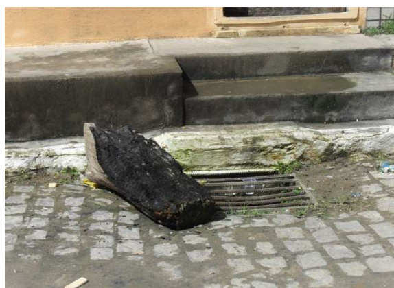
Foto 6: Caixa com grelha. Próximo do Mercado.
