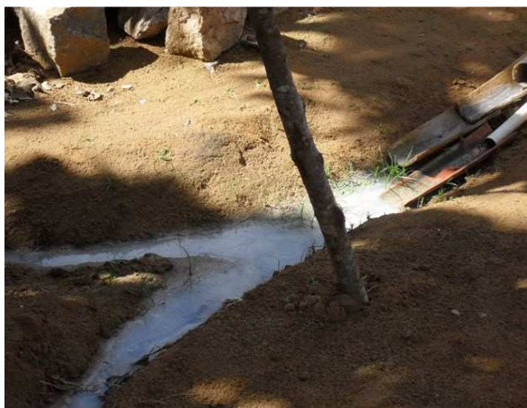
Foto 1: Lançamento de esgoto difuso.
