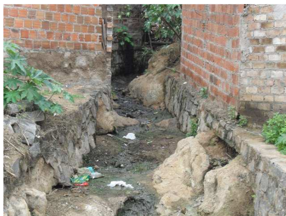
Foto 4: Canal Santa Luzia com drenagem e esgoto.
