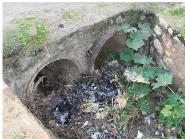
Foto 2: Bueiro – aspecto geral
