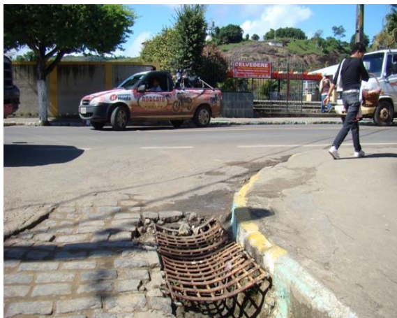
Foto 1: Caixa coletora com grelha na Rua João Martins.
