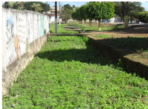
Foto 2: Canal aberto de alvenaria. Av. Aurélio Assis de Oliveira.
