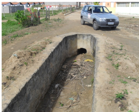
Foto 8: Canal aberto de alvenaria, ponto de chegada do escoamento das águas.
