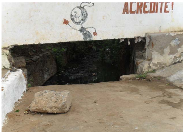
Foto 9: Ponto de chegada das águas pluviais com escoamento para o Açude Municipal.
