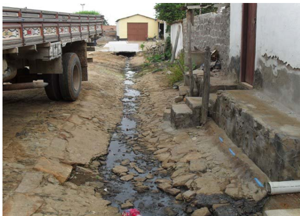
Foto 7: Canal aberto de alvenaria ponto de escoamento das pluviais.
