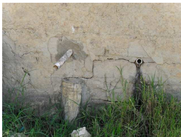
Foto 6: Lançamento de esgoto primário na rua.
