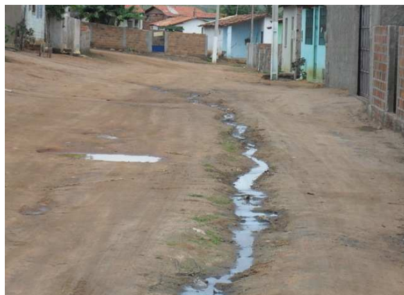
Foto 2: Esgoto a céu aberto, próximo de residências. Loteamento Santo Antonio.
