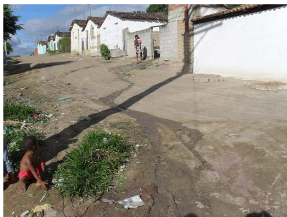
Foto 4: Esgoto a céu aberto.
