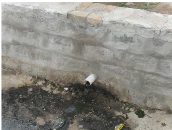
Foto 11: Av. Irmã Dulce, lançamento a céu aberto.
