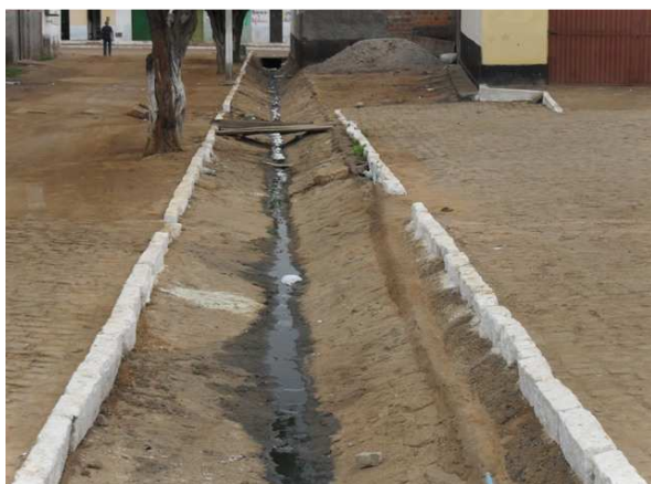
Foto 5: Canal aberto de alvenaria, próximo da Rua Lomanto Junior.
