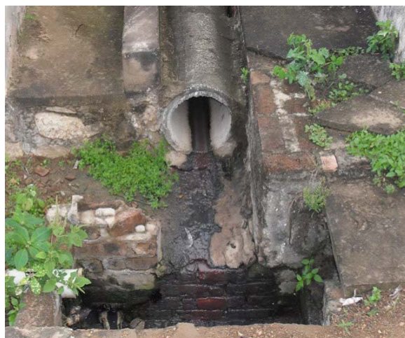
Foto 12: Ponto de lançamento de esgoto próximo da BA-116. Caixa de chegada.
