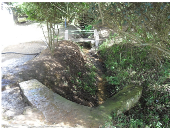
Foto 1: Canal aberto, ponto de chegada das águas pluviais que vem das casas populares.
