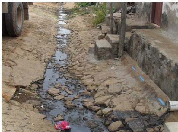
Foto 1: Canal aberto de alvenaria de pedras - início próximo da prefeitura com esgoto lançado pelas residências. (Canal do tanque da nação).
