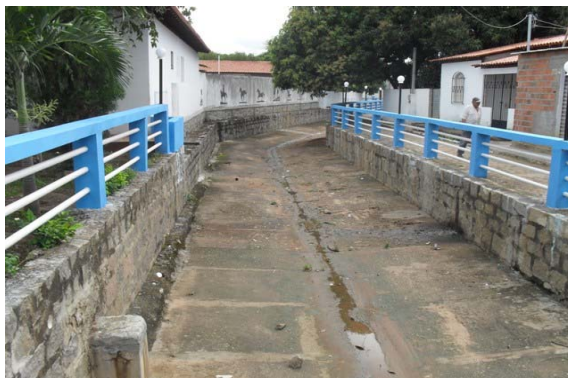
Foto 6: Canal aberto de alvenaria e concreto, passa por toda extensão da cidade e desemboca no Riacho Forte.
