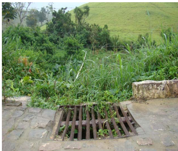
Foto 4: Lançamento de drenagem mista em pasto na Rua São Jorge diâmetro de 600 mm.
