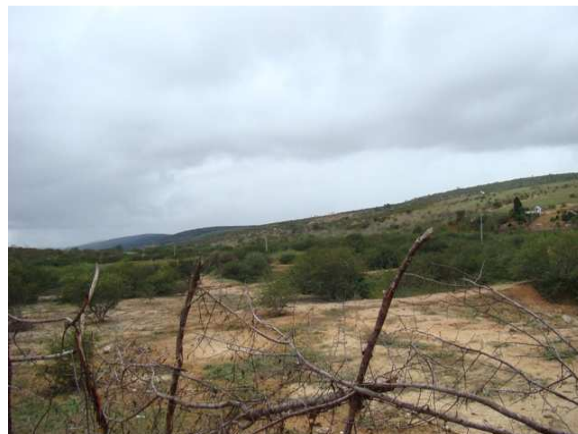
Foto 8: Obra de construção da ETE (inacabada)
