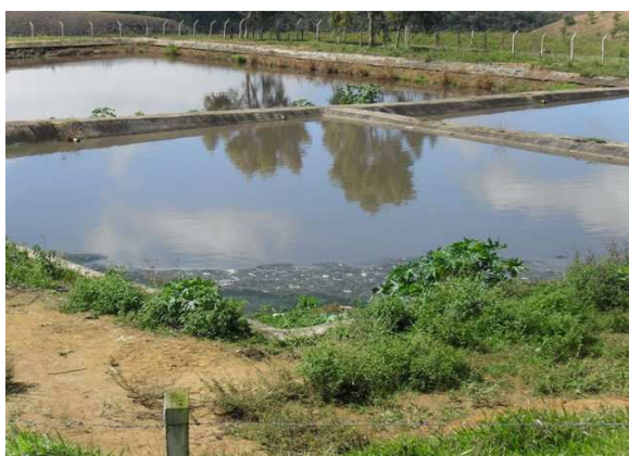
Foto 5: Detalha das lagoas: anaeróbica, maturação e facultativa.
