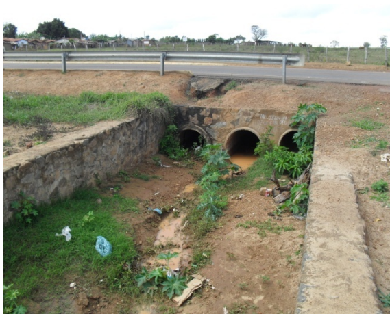
Foto 3: Bueiro localizado na BA-026
