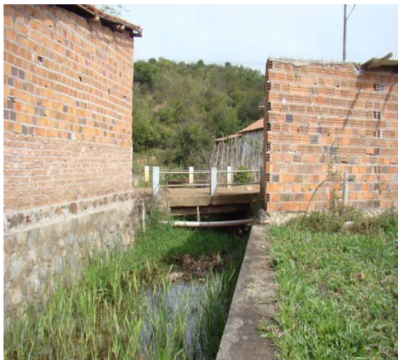
Foto 1: Início do Canal de Macrodrenagem na Rua Manoel Vitorino, no Bairro Baetinga de Cima.
