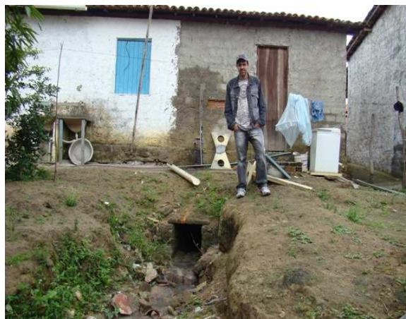
Foto 2: Saída de drenagem com esgoto da Rua Leonidia Pereira dos Santos.
