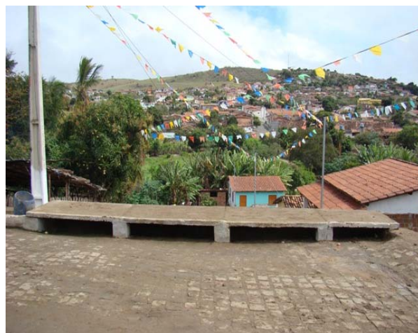
Foto 4: Bairro Manoel Dutra – sequência da galeria para o Rio Brejões.
