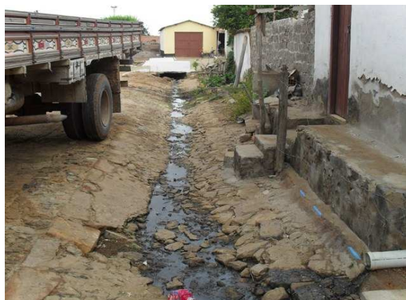
Foto 2: Canal de alvenaria de pedras conhecido como canal do tanque da nação.
