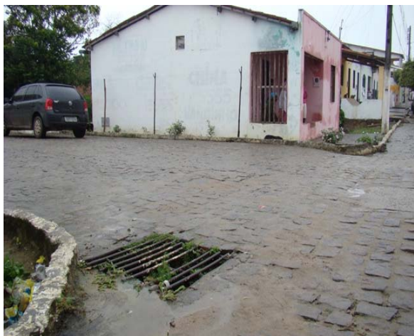
Foto 5: Estrutura de microdrenagem no final da Travessa Augusto Vieira.
