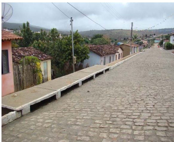
Foto 3: Bairro Manoel Dutra – início da galeria para o Rio Brejões.
