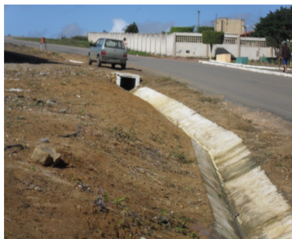
Foto 4: Canal aberto de alvenaria, próximo do Centro Educacional Álvaro Vasconcelos.
