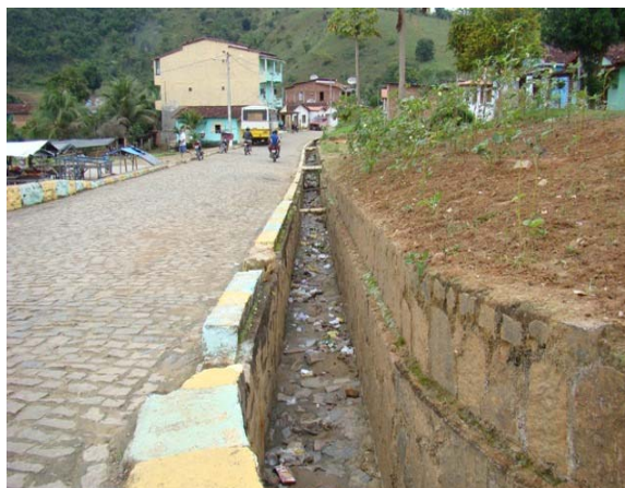
Foto 2: Rua Projetada "A" - valeta de drenagem - no início da estrada da Pindoba, ao lado da Feira e o Mercado Municipal.
