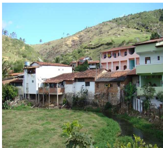
Foto 4: Lançamento de esgoto direto no Rio Jiquiriçá.
