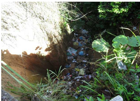
Foto 1: Ponto de lançamento de esgoto secundário, próximo da Av. João Durval.
