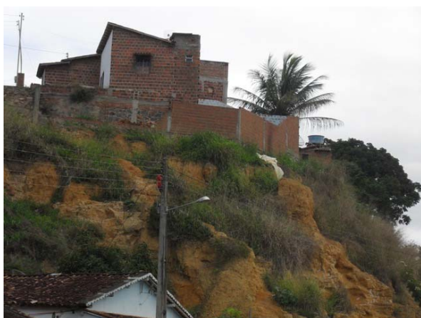
Foto 5: Encosta com risco de desabamento e erosão acentuada
