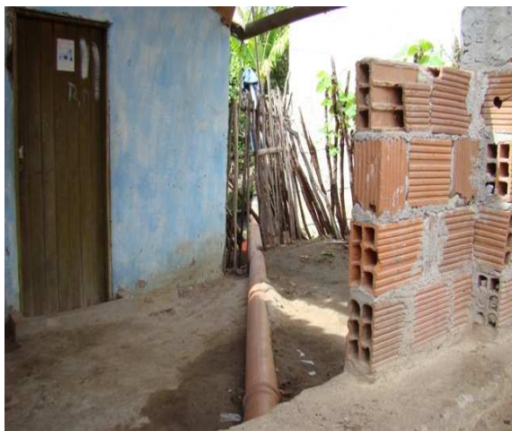
Foto 1: Rede de esgoto aparente.
