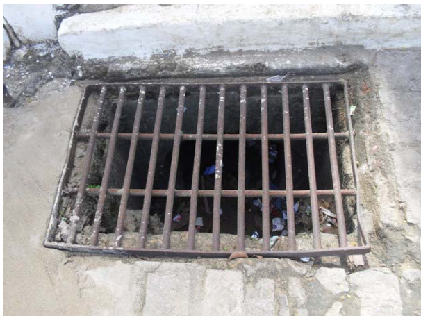
Foto 1: Rua Moreira Alves, sistema de micro-drenagem grelha horizontal
