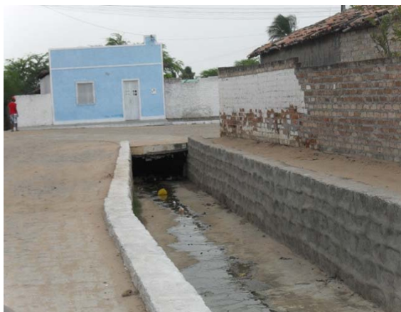
Foto 11: Trecho do canal de alvenaria e início do canal fechado.
