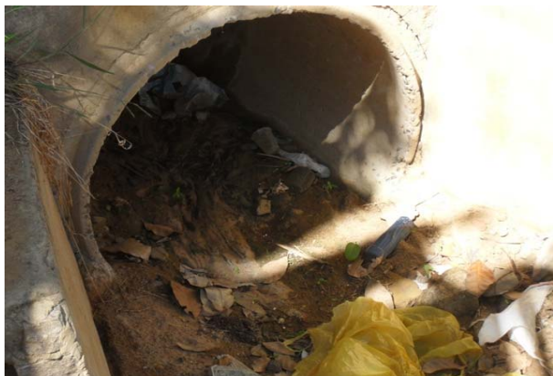
Foto 5: Manilha de diâmetro 800 mm do canal aberto que vem da Praça Rui Barbosa.
