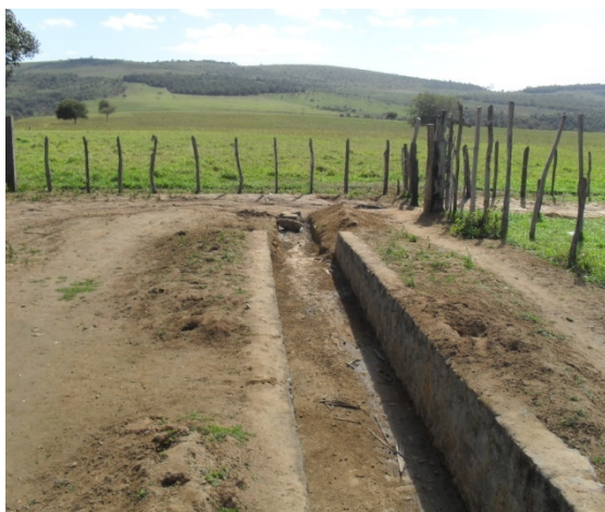
Foto 7: Sistema de macro drenagem. Canal aberto para escoamento de
