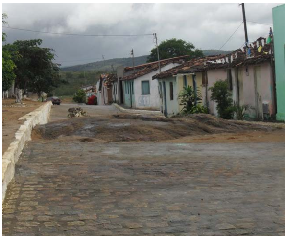
Foto 1: Área de alagamento, final da rua pavimentada.
