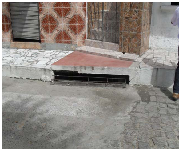
Foto 7: Boca de Lobo - Av. Irmã Dulce.
