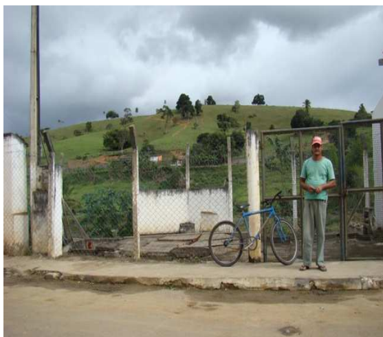
Foto 3: Estação Elevatória 2 – Praça Lomanto Junior.
