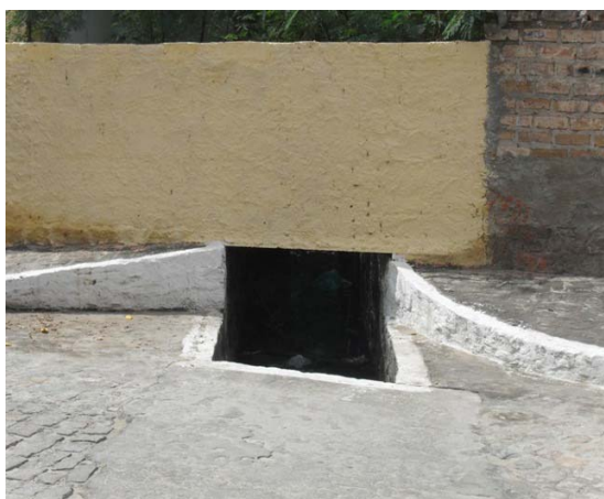
Foto 5: Praça do Comercio. Início do canal fechado. Sistema de macro-drenagem. Praça Rui Barbosa.
