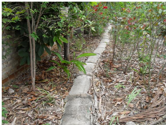
Foto 8: Canal fechado com tubulação de Ø500, desemboca na lagoa da várzea. (Sai do Centro).
