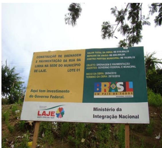
Foto 3: Placa da obra de drenagem da Rua da Linha.
