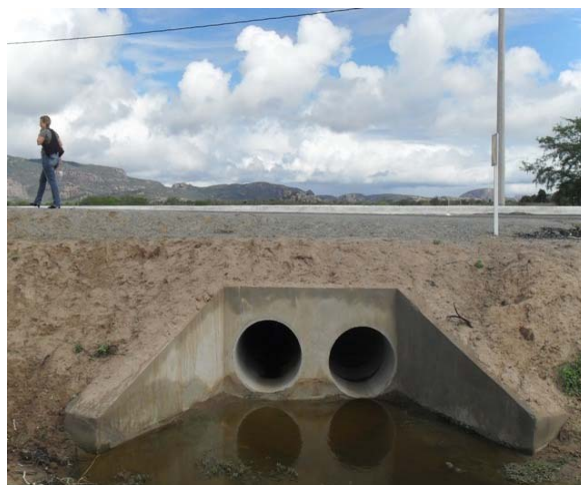
Foto 2: Bueiro sob a BR-116
