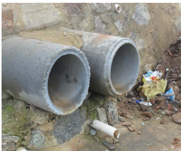
Foto 9: Sistema de macro-drenagem com 2 manilhas de Ø100mm.
