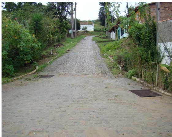
Foto 1: Estrutura de microdrenagem no final da Rua Manoel Rufino com travessia para a Av. Getúlio Vargas e lançamento no Rio Ronco (manilha diâmetro 400 mm).
