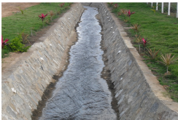
Foto 5: Canal aberto de pedras de alvenaria, que leva água para o Riacho Jaguari.
