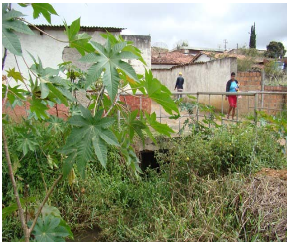
Foto 1: Saída da rede mista com diâmetro de 1.000mm – Beco do Campo – Rio Brejões.
