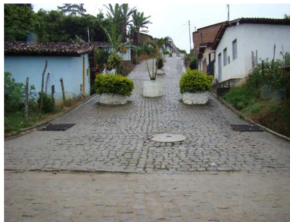
Foto 2: Esgoto a céu aberto com descarte na rede de drenagem.
