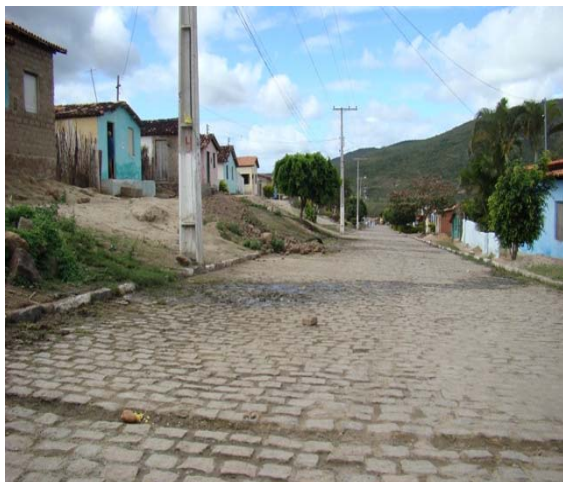
Foto 1: Início da galeria de águas pluviais em frente à Av. Itabuna.
