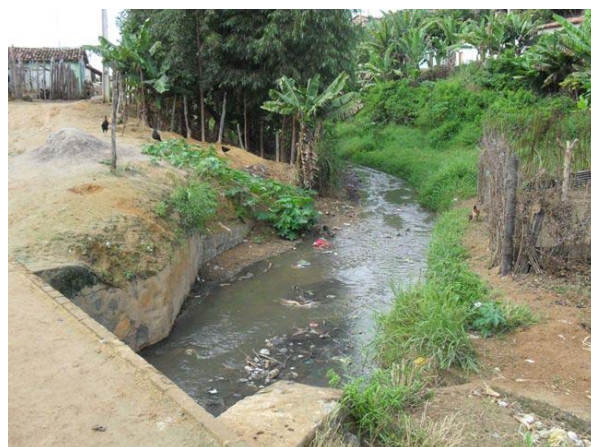
Foto 6: Final do trecho canalizado - jusante
