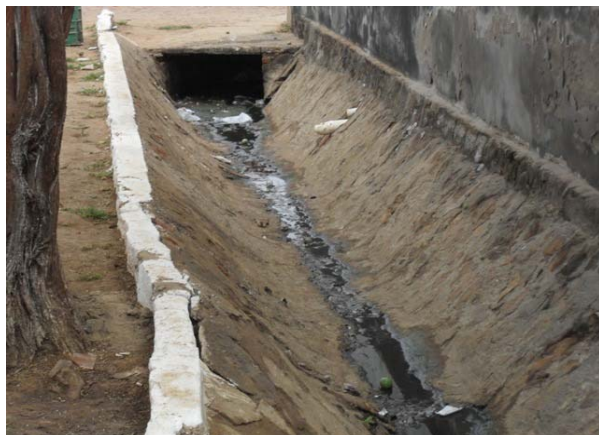
Foto 8: Canal aberto de alvenaria. Ponto de escoamento das águas pluviais. Próximo da Praça da Bandeira.
