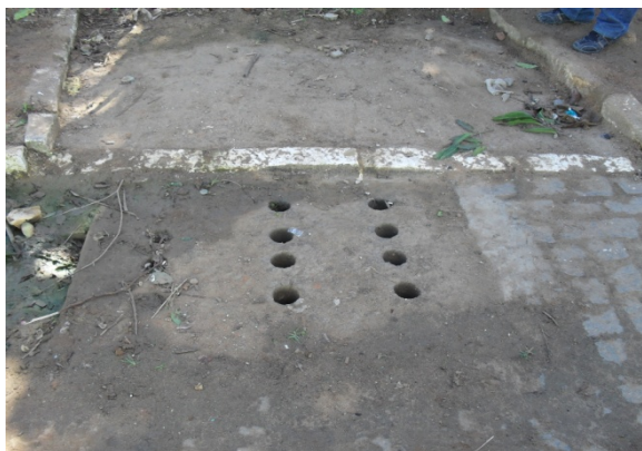
Foto 5: Drenagem com grelha de concreto, próxima da Av. Aurélio Assis de Oliveira.
