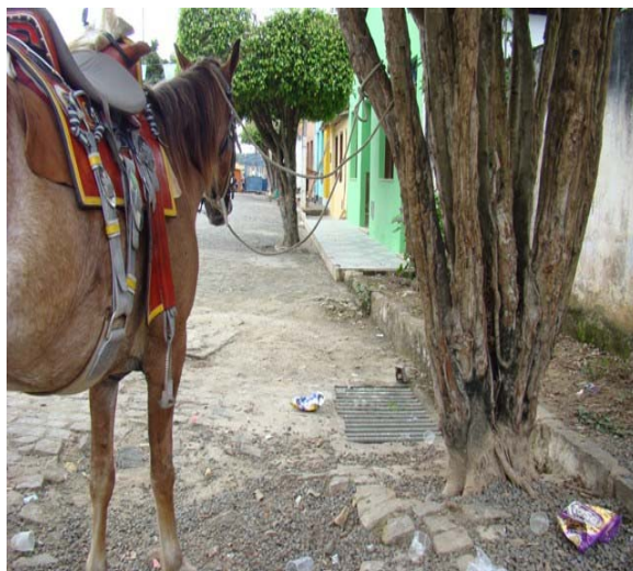
Foto 10: Início de rede de drenagem – Rua da Estação (Cesta do Povo)
