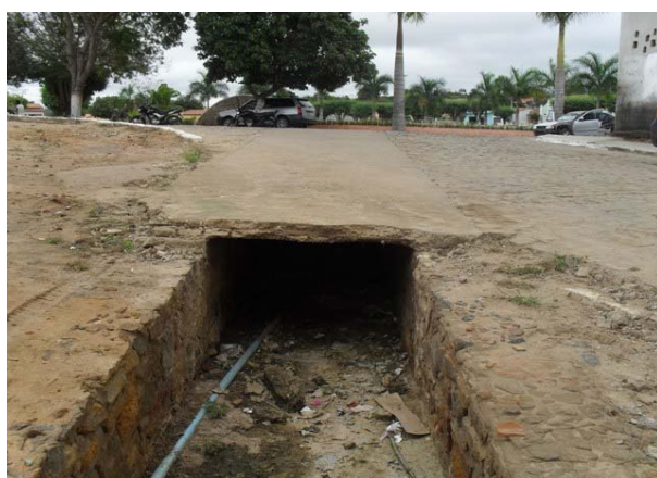
Foto 6: Canal da nação ponto de escoamento, próximo da prefeitura.
