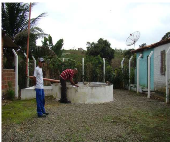
Foto 3: Estação Elevatória “E” – elevatória de recalque para ETE.
