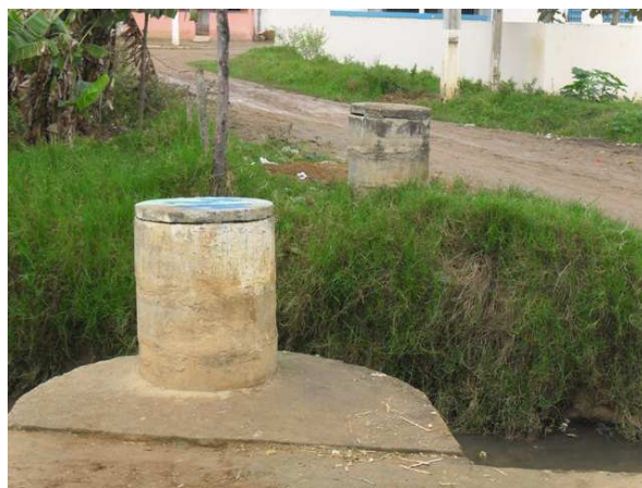
Foto 8: PV'S da EMBASA construídos dentro do canal.
