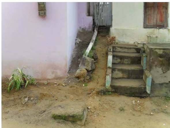
Foto 1: Lançamento de esgoto secundário a céu aberto.
