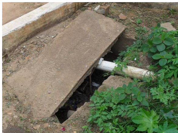
Foto 10: Caixa de chegada com lançamento de esgoto pela tubulação.
