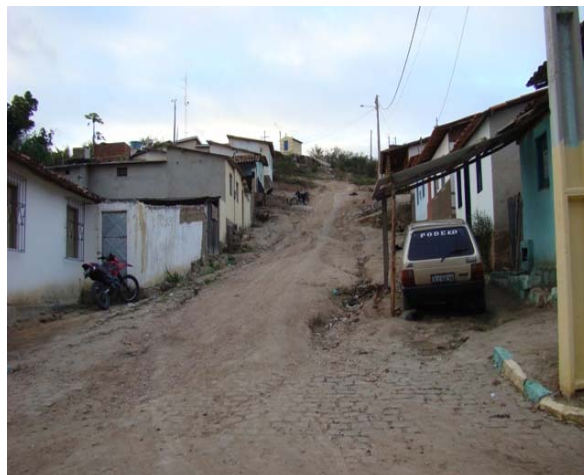
Foto 2: Erosão na Rua do Cruzeiro ocasionada pelas chuvas.
