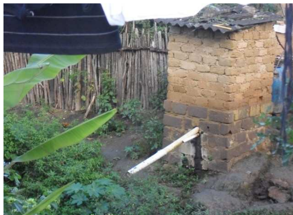
Foto 6: Lançamento direto de esgoto a céu aberto
