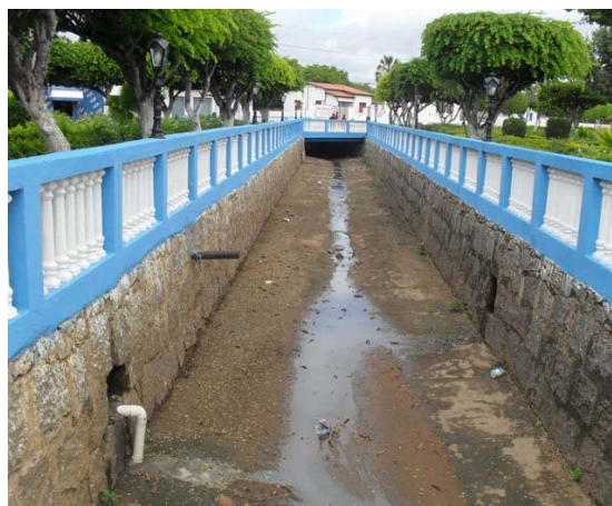
Foto 8: Canal aberto de alvenaria com lançamento difuso ao longo do canal. Próximo da Associação Beneficente Santa Terezinha.
