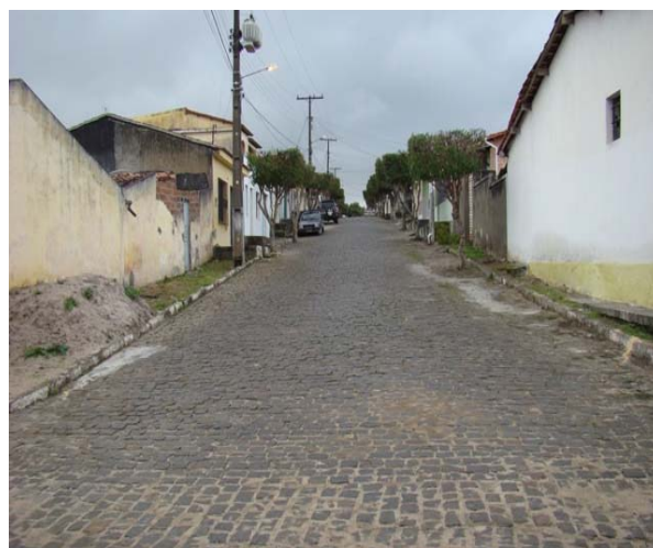
Foto 4: Rua Otávio Ribeiro – Bairro São José – corresponde a Área Crítica 2.
