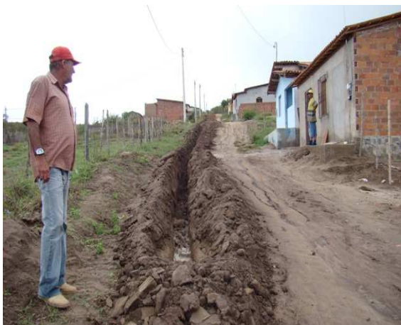
Foto 1: Implantação da rede de esgoto - Bairro Morada Bela – junto ao Estádio Municipal.
