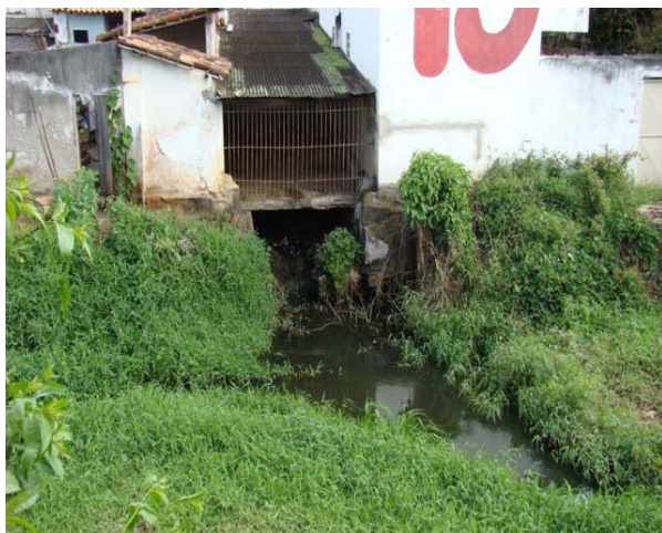
Foto 3: Final da rede de macrodrenagem – lado oeste do Rio Casca.
