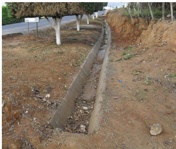
Foto 6: Canaleta próxima da BA-116
