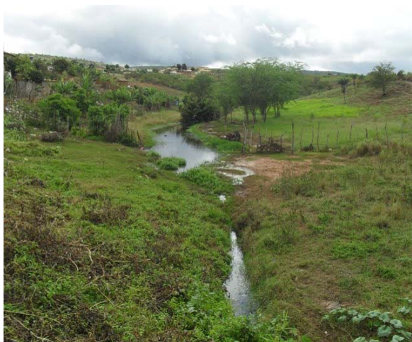
Foto 3: Ponto de lançamento de águas pluviais. Esgoto a céu aberto e lançamento que vem da Rua Damião Oliveira.
