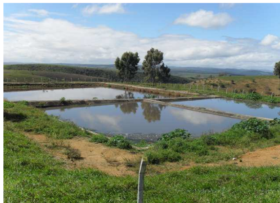
Foto 4: Vista das lagoas: anaeróbica, maturação e facultativa.
