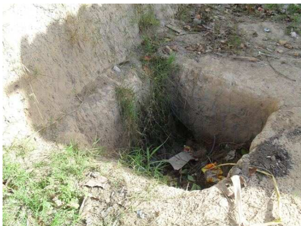
Foto 1: Abertura de fossa no passeio.
