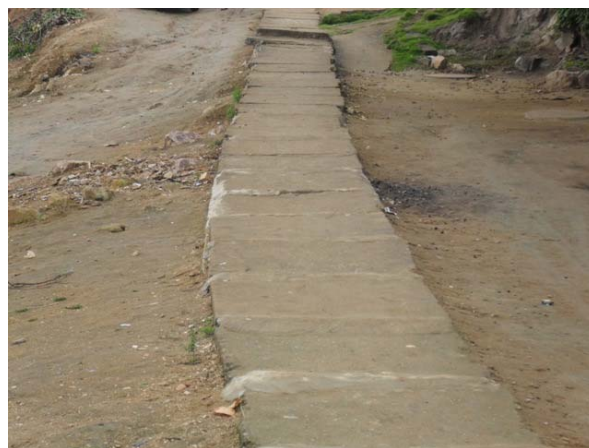
Foto 8: Galeria de drenagem
