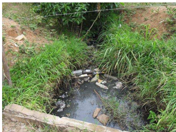
Foto 8: Ponto de lançamento de esgoto próximo da BA-026
