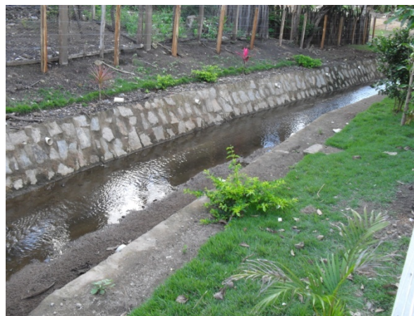
Foto 8: Canal aberto de alvenaria de pedras, lançamento de águas pluviais e esgoto secundário escoamento para o Riacho da Floresta.
