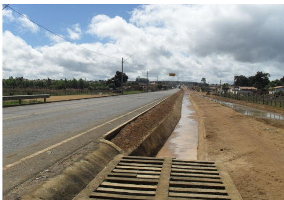
Foto 5: Canal aberto ponto de chegada das águas pluviais. Caixa de chegada com grelha horizontal.
