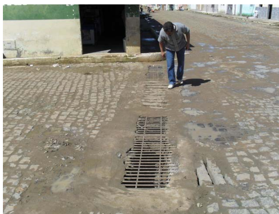
Foto 4: Canaleta com grelha horizontal contínua, Rua Adolfo Elias.
