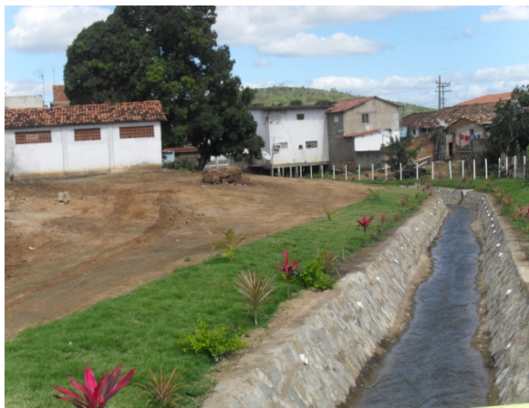
Foto 1: Canal aberto de alvenaria de pedras. Escoamento de águas.
