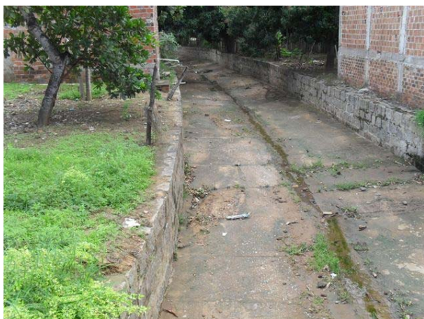
Foto 3: Canal aberto de alvenaria, escoamento de águas pluviais para o Riacho Casa Forte.
