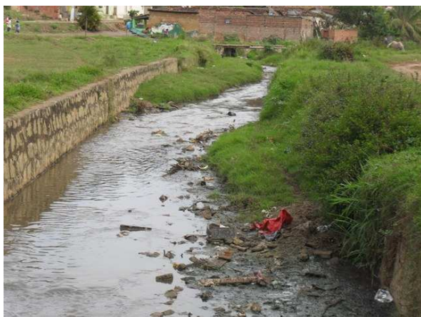
Foto 3: Rio Casca – conduto de esgoto e águas pluviais – vegetação.
