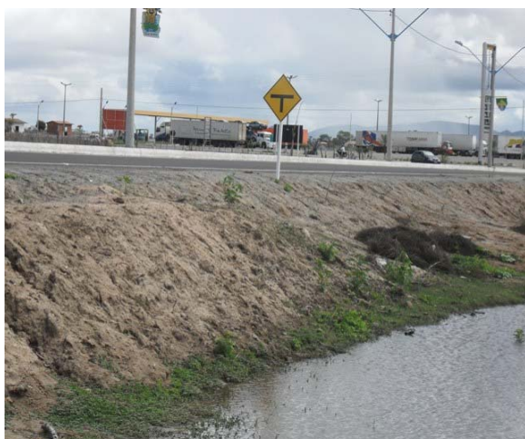
Foto 3: Canal aberto próximo do posto de gasolina - BR-116
