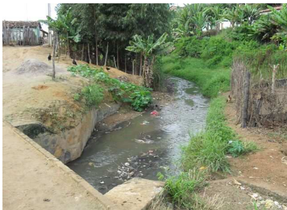
Foto 5: Final do trecho revestido do Rio Casca
