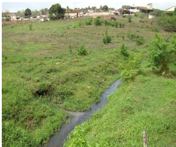
Foto 4: Saída de esgoto Ø200 – Rua Orlando Goulart Trinchão no Rio Brejões.
