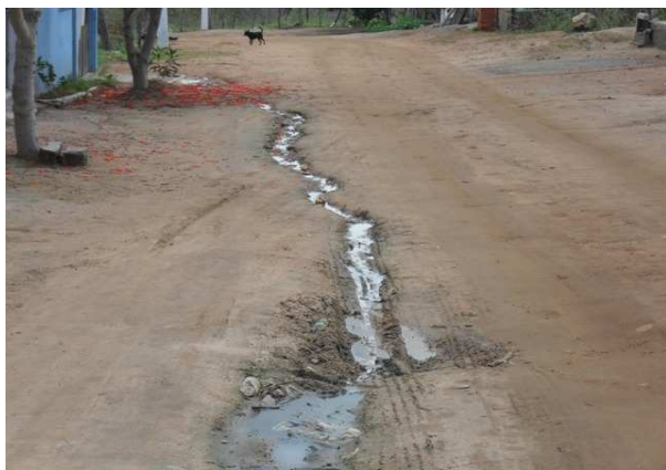
Foto 1: Esgoto a céu aberto, Loteamento Santo Antonio.
