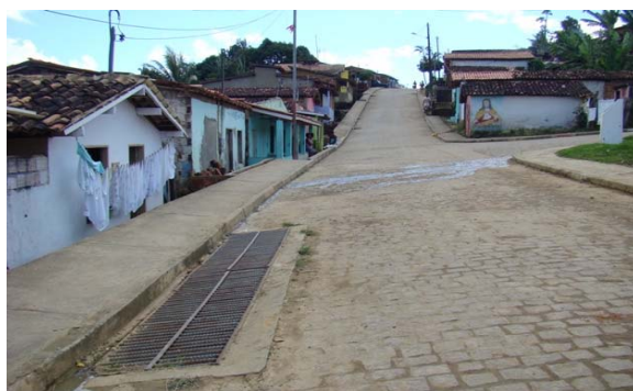
Foto 6: Drenagem iniciada na 1ª Travessa São Miguel das Matas.
