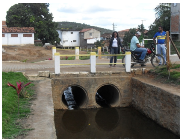
Foto 4: Canal de alvenaria de pedras. Sob. A rodovia com duas manilhas de diâmetro 500 mm.
