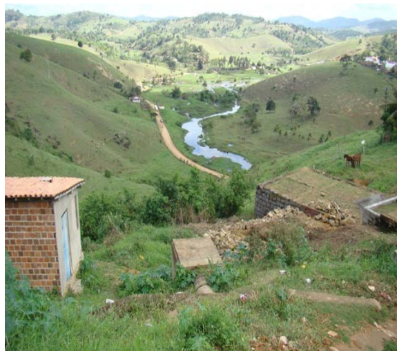
Foto 8: Descarte de drenagem em pasto. Diâmetro de 600mm na Rua Manoel João da Rocha.
