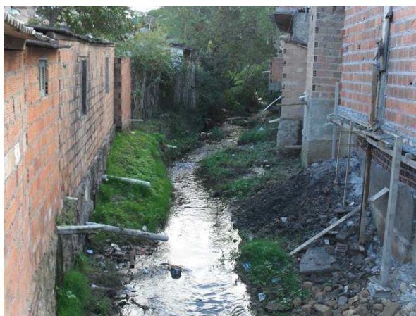
Foto 11: Rio Casca – lançamento direto de esgoto
