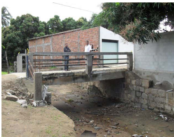
Foto 4: Canal aberto sub a ponte de ligação da rua próxima da ferrovia.
