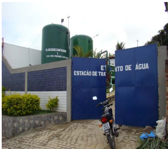
Foto 9: ETA – Rua do Filtro.
