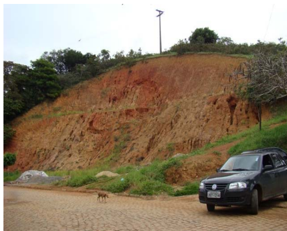
Foto 6: Erosão – Praça Antonio Carlos Magalhães.
