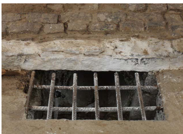
Foto 5: Sistema de micro-drenagem com grelha horizontal. Caixa de passagem do sistema de águas pluviais, vai para o canal do tanque da nação
