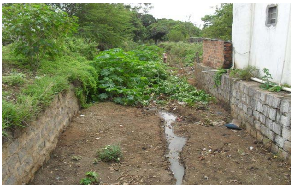
Foto 5: Canal aberto de alvenaria próximo da Rua do Cemitério.
