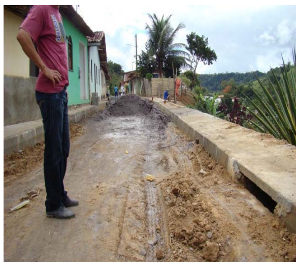
Foto 4: Obra de pavimentação e drenagem da Rua da Linha – Bairro Calabá.
