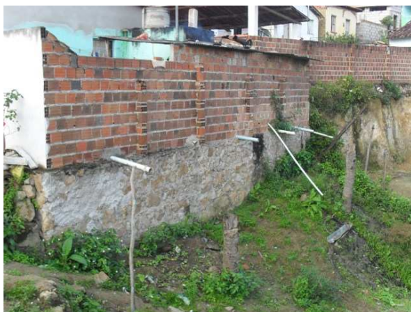
Foto 7: Lançamento direto de esgoto no Rio Casca
