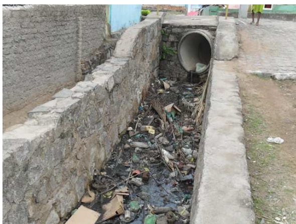
Foto 9: Esgoto em canal de drenagem
