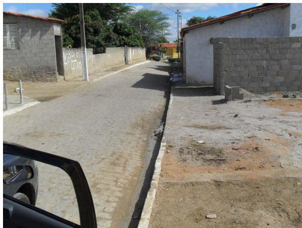
Foto 2: Rua Moreira Alves, área de alagamento.
