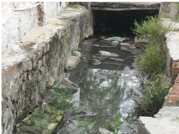
Foto 7: Canal aberto de alvenaria, próximo da Praça Beira Mar e Rua da Lagoa (Águas pluviais e esgoto).
