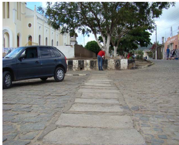
Foto 2: Praça Jovenal Montana, final da galeria de Águas Pluviais.
