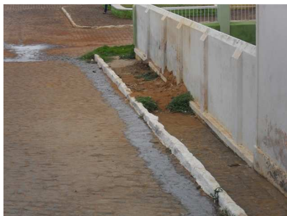
Foto 6: Lançamento de esgoto a céu aberto, próximo da Praça da Bandeira.
