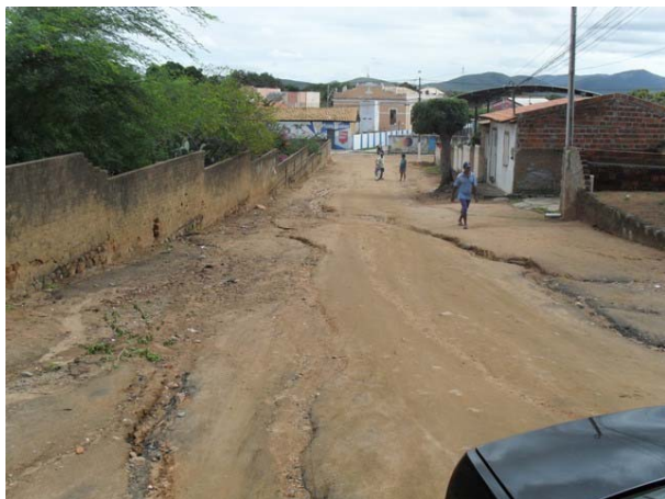
Foto 1: Área de erosão, rua não pavimentada com escoamento de águas pluviais
