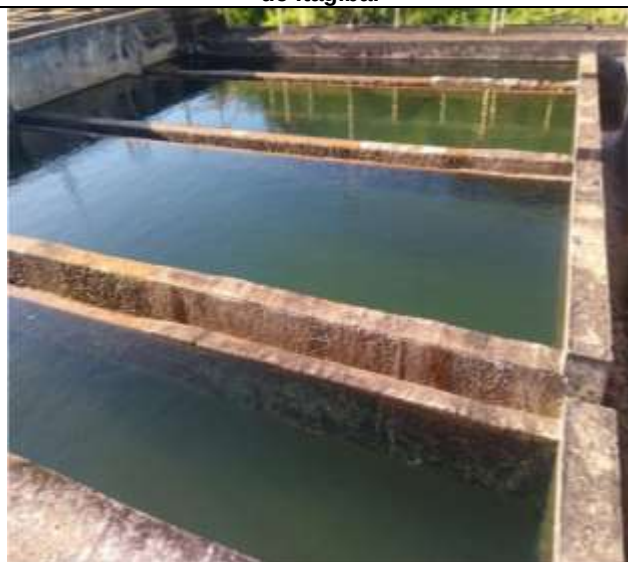
Figura 4.30 – Decantador pertencente ao SAA Sede de Itagibá.
