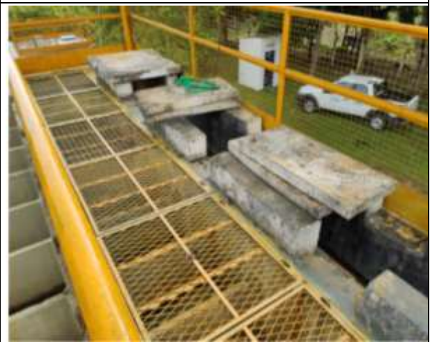
Figura 4.24 – Floccodecantadores e filtros pertencentes ao SAA Sede de Elísio Medrado.
