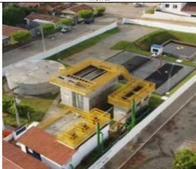
Figura 4.30 – Decantador pertencente ao SAA Sede de Itagibá.
