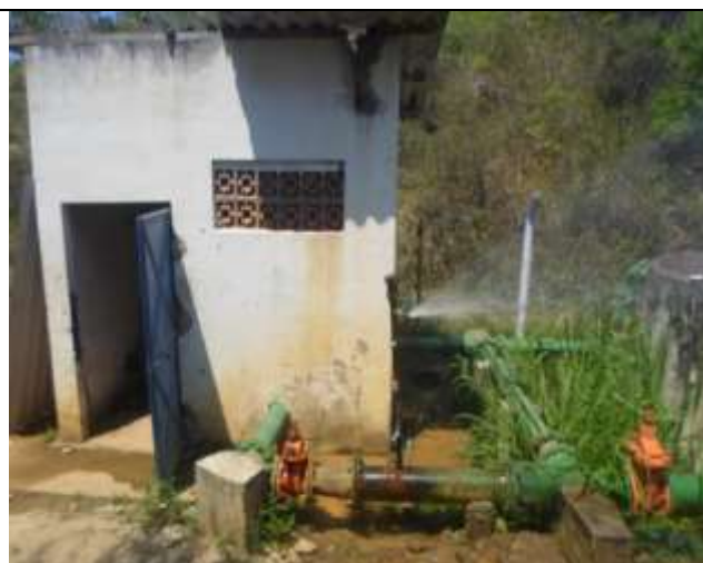
Figura 4.15 – EEAB SAA Manoel Vitorino Sede.
