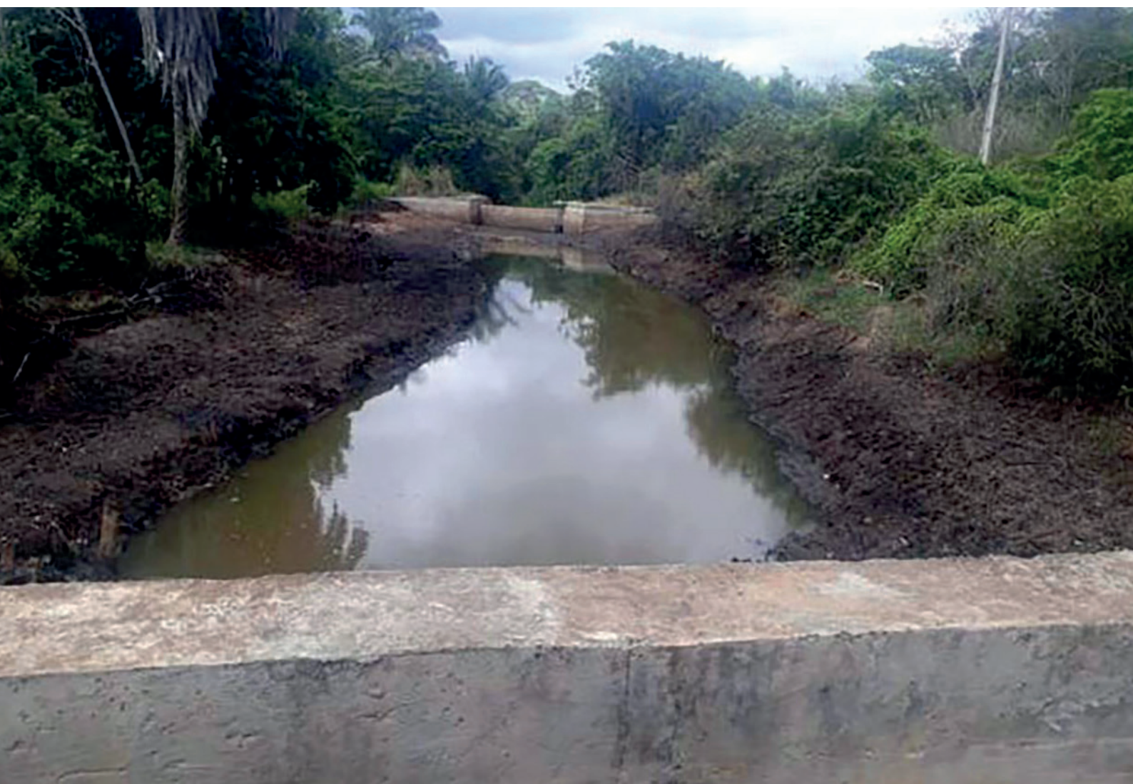
Estado da captação do SAA de Lajedinho no rio Utinga (21-10-2021) Erosão na ombreira direita da barragem existente.
