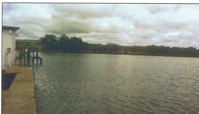
Figura 40 – Detalhe da captação no lago da barragem do Rio Utinga Fonte: Associação dos Irrigantes da Bacia do Rio Utinga
