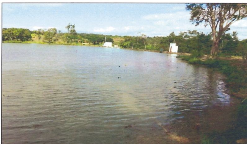
Figura 38 – Lago da barragem de nível da nascente do Rio Utinga Fonte: Associação dos Irrigantes da Bacia do Rio Utinga
