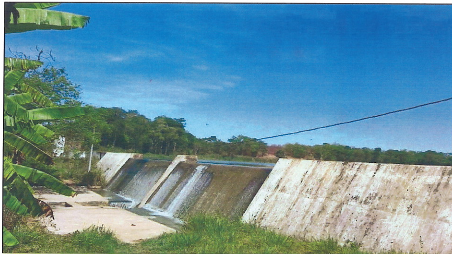
Figura 37 – Barragem do Rio Utinga
