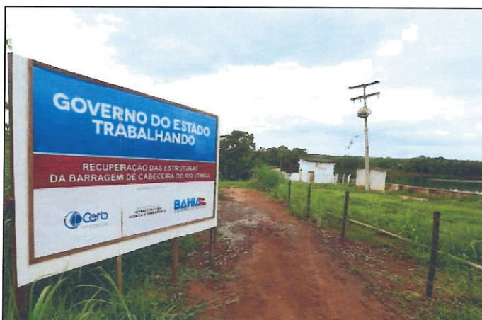
Figura 27 – Indicação de obra na barragem do Rio Utinga Fonte: SECOM (2020)
