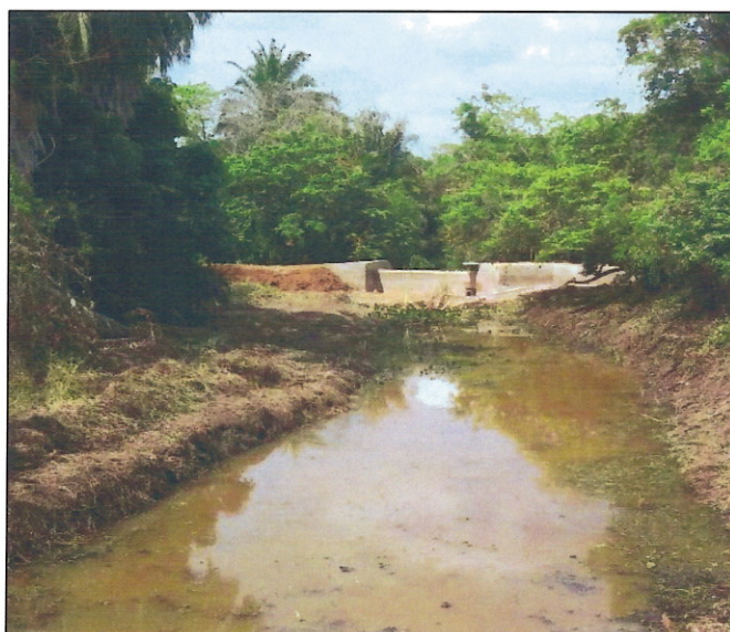
Figura 41 – Barragem de nível do Rio Utinga – Captação da Embasa para abastecimento de Lajedinho
