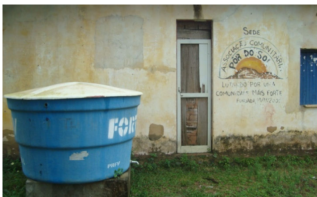
Figura 4.28 - Reservatório de 2.000 L, Loteamento Por do Sol
