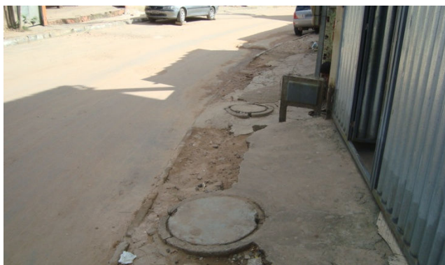
Figura 4.47 - Caixa de Passagem, Jardim Campo Verde
