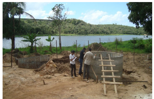
Figura 4.58 - Estação Elevatória de Esgoto (EE-4), em Instalação, Nova Esperança, às Margens da Represa Ipitanga 3
