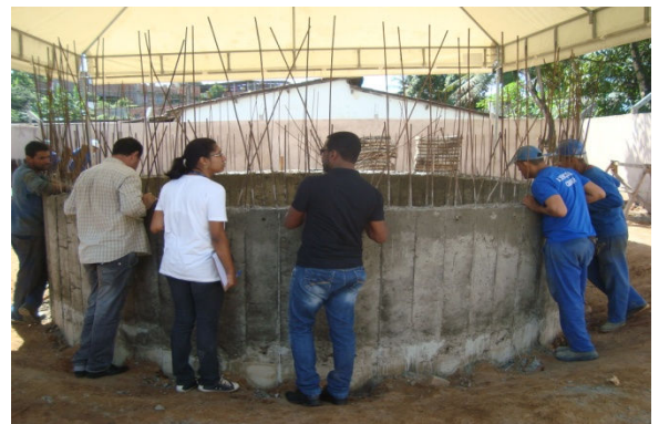
Figura 4.56 - Estação Elevatória de Esgoto (EE-2), em Instalação, Jardim Campo Verde
