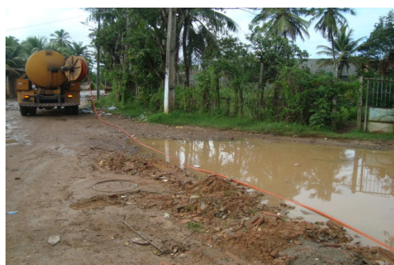
Figura 4.68 - Equipamento da Embasa, Desobstruindo Rede de Esgoto, Comunidade do Bosque Ipitanga
