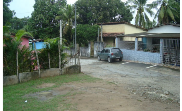
Figura 4.33 - Vista Parcial da Localidade Pedreira Aratu
