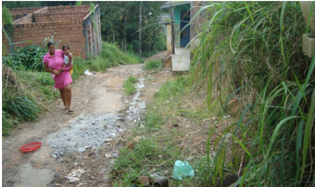
Figura 4.61 - Esgoto a Céu Aberto – Nova Esperança
