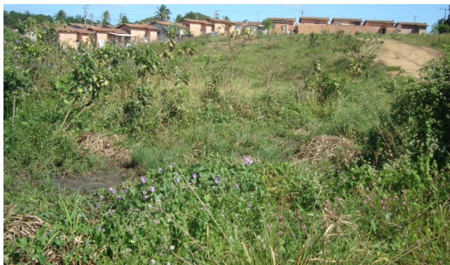
Figura 4.55 - Outra Fossa Séptica que Recebe o esgoto Coletado do CH Jardim Campo Verde, Praticamente Soterrada
