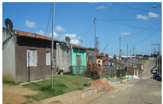
Figura 4.7 - CH Jardim Campo Verde, Presença de Hidrômetros, Habitações sem Reservatórios de Água
