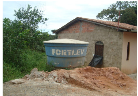
Figura 4.39 - Reservatório de 2.000 L (RAD 2), Comunidade Pedreira Carangi
