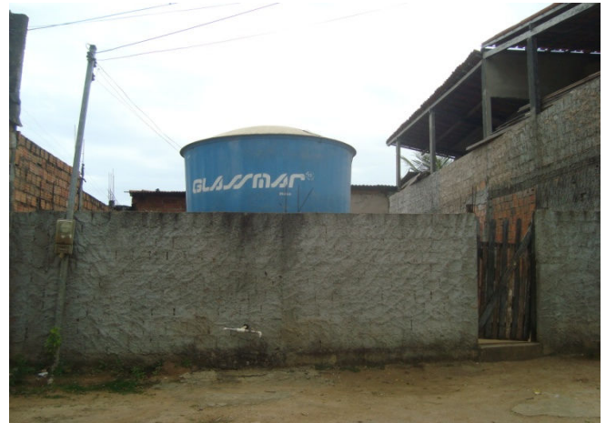
Figura 4.21 - Reservatório de 10.000 L, instalado pela Comunidade
