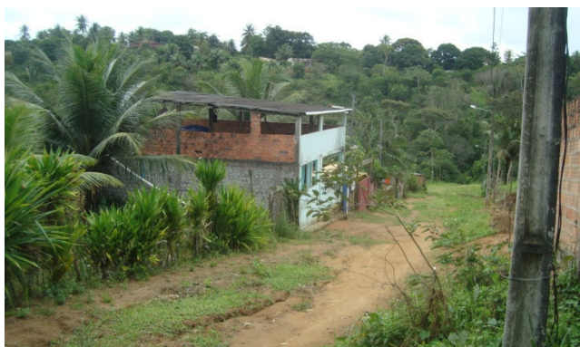
Figura 4.30 - Vista Parcial do Loteamento Por do Sol
