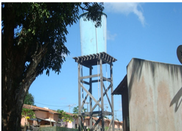
Figura 4.8 - Reservatório Elevado (RED), Atualmente Desativado, CH Jardim Campo Verde
