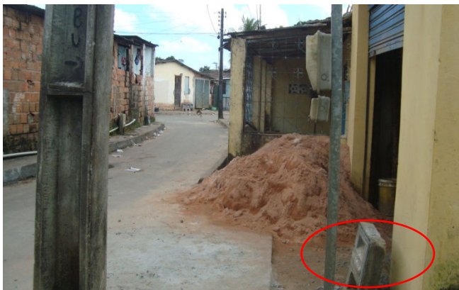
Figura 4.3 - Localidade Cepel – Hidrômetros (Detalhe em Vermelho)
