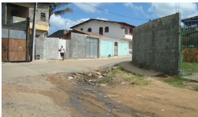
Figura 4.65 - Esgoto a Céu Aberto, Loteamento Ceasa
