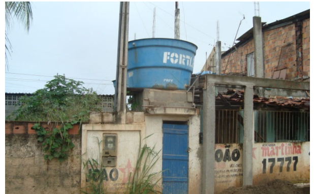
Figura 4.41 - Reservatório de 2.000 L, Localidade de Biribeira
