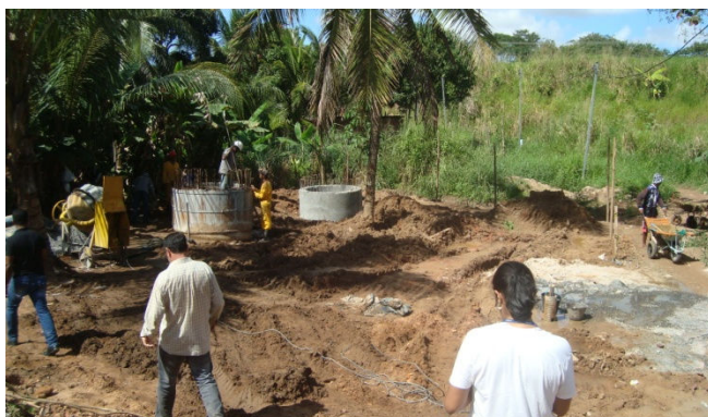
Figura 4.57 - Estação Elevatória de Esgoto (EE-3), em Instalação, Nova Esperança
