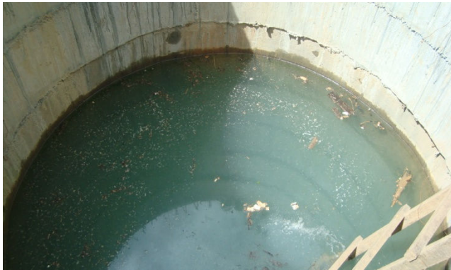
Figura 4.59 - Estação Elevatória de Esgoto (EE-4), em Instalação, Nova Esperança, às Margens da Represa Ipitanga 3
