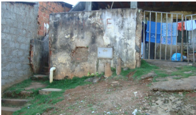
Figura 4.18 - Instalação de Hidrômetros em Algumas Casas
