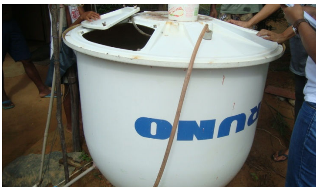
Figura 4.26 - Reservatório (Reutilização de Reservatório que Armazenava Produto Químico) que Armazena Água Captada em Poço
