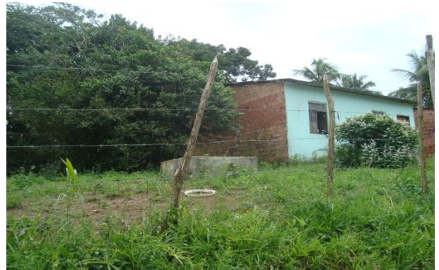
Figura 4.45 - Base do Reservatório de 2.000 L – Comunidade de Barragem
