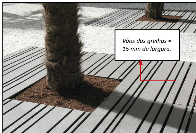
Figura 38 – Exemplo de grelha nivelada ao piso adjacente
