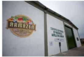
Figura 5 Centro de Distribuição da AP/CD
