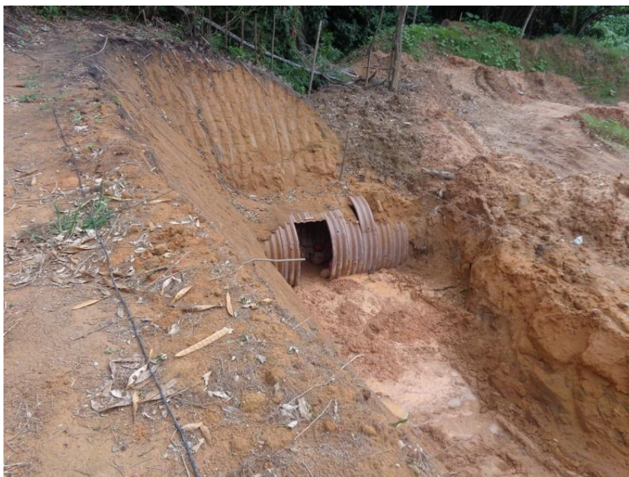
SAÍDA 03 – Terreno Natural – Curso de Água Natural. Bueiro BSTM \varnothing=2,0\text{m} sendo implantado no local de deságue.
