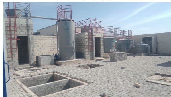
Vista da ETE
