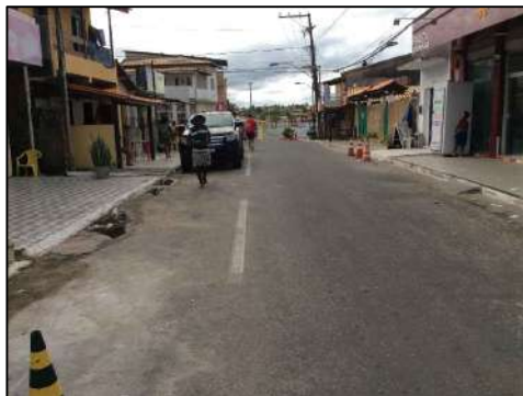
Foto 07 - Calçadas existentes na R. Direta de Jauá, trecho paralelo à R. Praia dos Artistas.
