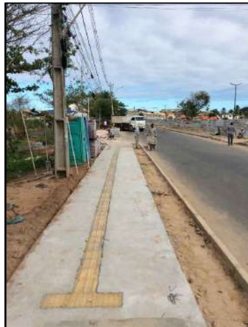
Foto 03 - Calçada sendo executada para obra entregue em out./2022.
