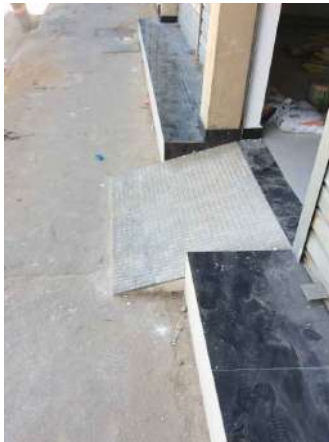
Foto 02- Interferência de acessos aos comércios na faixa livre da calçada.
