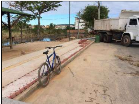
Foto 01 - Calçadas sendo executada para obra que foi entregue em out./2022.
