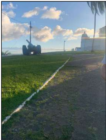
Foto 03 - Piso existente no entorno do Forte de Monte Serrat que dá acesso à calçada que leva à Praia de Boa Viagem..
