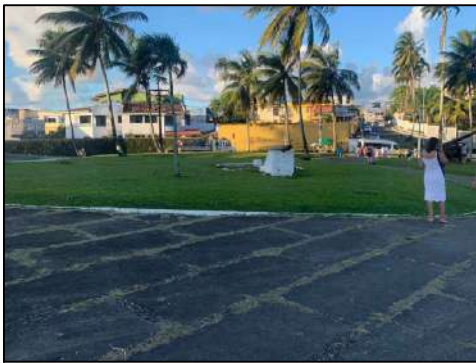
Foto 02 - Piso existente no entorno do Forte de Monte Serrat a ser mantido com intervenção na limpeza e possíveis reparos em placas quebradas ou fissuradas.
