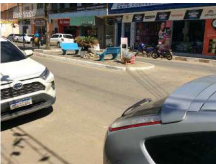
Foto 08- Falta de sinalizações horizontais.
