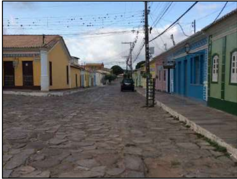
Foto 06 - Calçamento existente nas ruas do cento de io de Contas, que deveá ser mantido e recuperado quando necessário.
