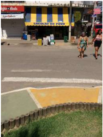
Foto 01- Elementos para acessibilidade mal instalados.
