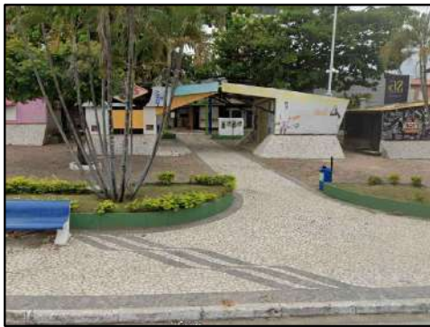
Foto 03 - Calçamento da Praça do Trabalhador a ser mantida.
