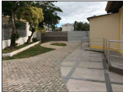
Foto 10 - Praça do Papagaio com reformada na obra entregue em out./2022.
