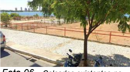
Foto 06 - Calçadas existentes na Av. Carmela Dutra, na altura do acesso ao monumento Nêgo D'água.
