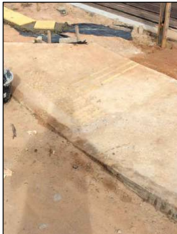
Foto 02 - Rebaixamento de calçada sendo executado para obra entregue em out./2022.
