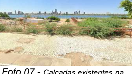
Foto 07 - Calçadas existentes na Av. Carmela Dutra, na altura do acesso ao monumento Nêgo D'água.
