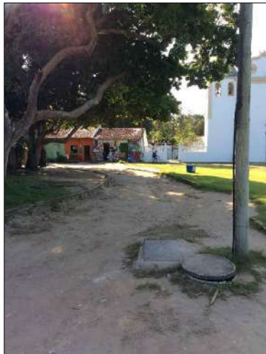
Foto 06 - Vista do passeio com interferência de postes e caixas de inspeção.
