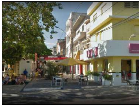
Foto 01 - Calçada existente a ser mantida, sendo refeito os rebaixamentos de calçada para adequar à NBR-9050.
