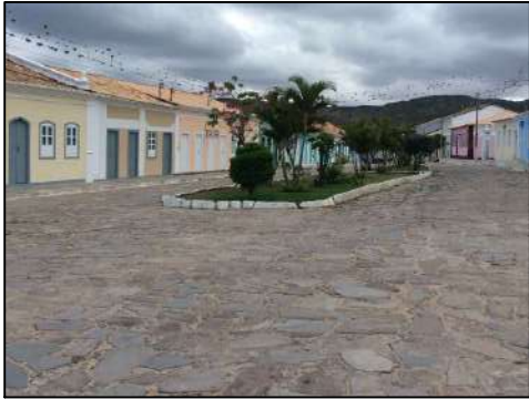
Foto 05 - Canteiro central existente na Av. Barão de Macaúbas a ser mantido.
