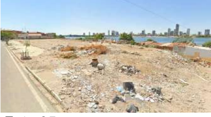
Foto 05 - Calçadas existentes na Av. Carmela Dutra, na altura do acesso ao monumento Nêgo D'água.
