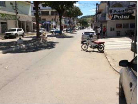
Foto 05- Falta de sinalizações horizontais.
