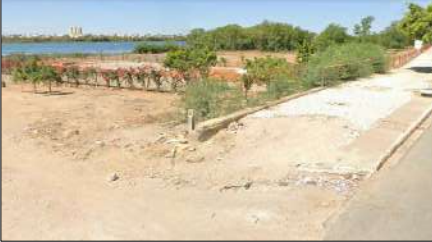
Foto 04 - Calçadas existentes na Av. Carmela Dutra, na altura do acesso ao monumento Nêgo D'água.
