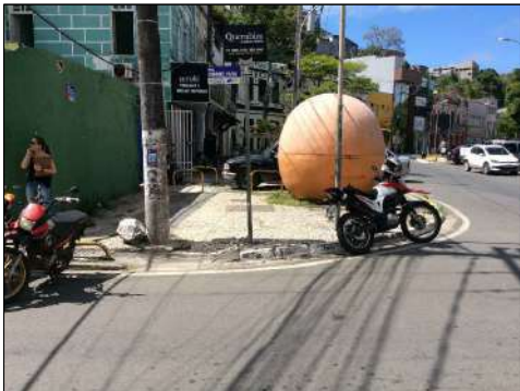
Foto 03 - Barraca existente entre a Rua Cel. Paiva e a Av. Dois de Julho, que deverá ser deslocada para permitir rebaixamentos de meio-fio necessários à acessibilidade (ver detalhe-Zona 01).
