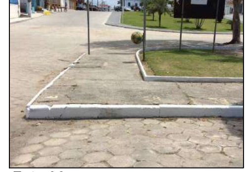
Foto 06 - Canteiros e estacionamento existentes a serem mantidos e calçadas a serem refeitas.
