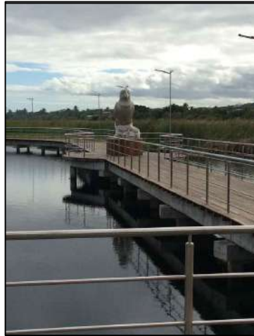
Foto 11 - Pier executado em reforma entregue em out./2022.
