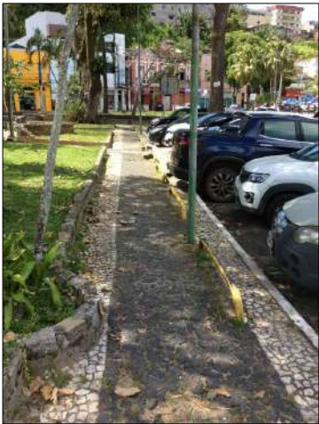
Foto 09 - Calçadas de uma das "ilhas" da Av. Dois de Julho. Necessidade de restauração, possibilitando a acessibilidade.
