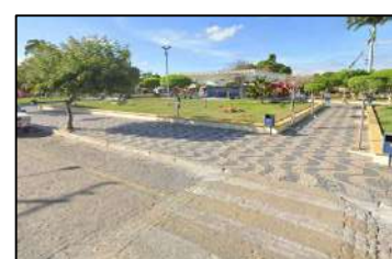
Foto 04 - Faixa de travessia de pedestre existente sem pintura adequada e pavimentação deteriorada.
