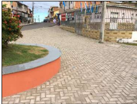
Foto 09 - Praça do Papagaio com reformada na obra entregue em out./2022.
