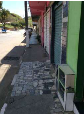
Foto 04- Invasão de equipamentos de uso privado nas calçadas.
