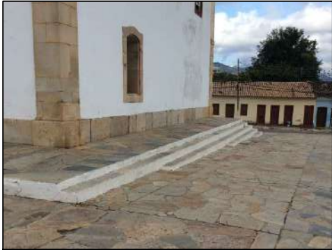
Foto 03 - Desnível existente no entorno do Forum. Entrada acessível pela Praça da Matriz Maestro Esau Pinto.
