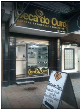
Foto 02 - Desnível entre o calçamento e as lojas.
