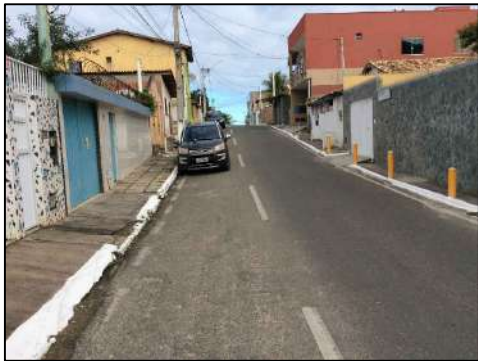
Foto 04 - Rua e calçadas estreitas da R. Praia dos Artistas, impossibilitando a adequação sem desapropriação de parte dos lotes da via.
