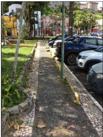
Foto 06 - Calçadas de uma das "ilhas" da Av. Dois de Julho. Necessidade de restauração, possibilitando a acessibilidade.
