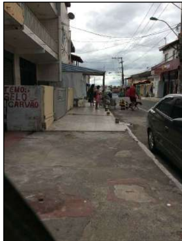
Foto 06 - Calçadas existentes na R. Direta de Jauá, trecho paralelo à R. Praia dos Artistas.
