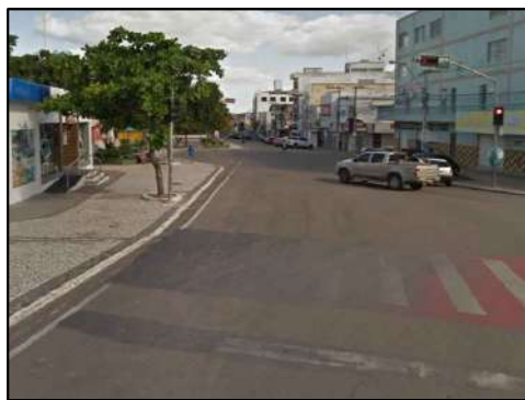
Foto 05 - Faixas de travessia de pedestres existentes a serem repintadas.
