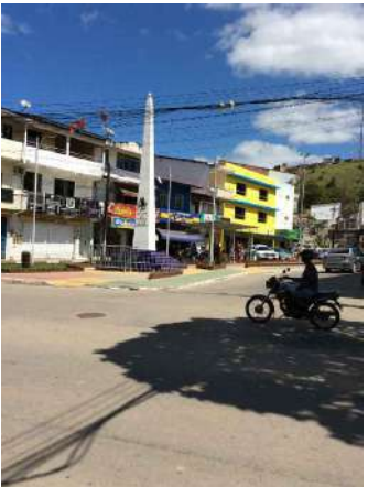
Foto 02- Falta de faixa para travessia de pedestres.
